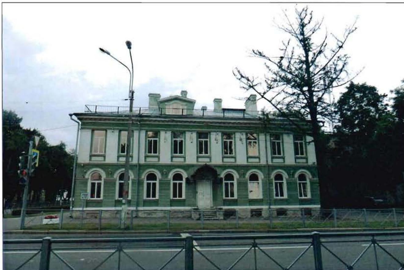
3. Восточный фасад. Общий вид.
