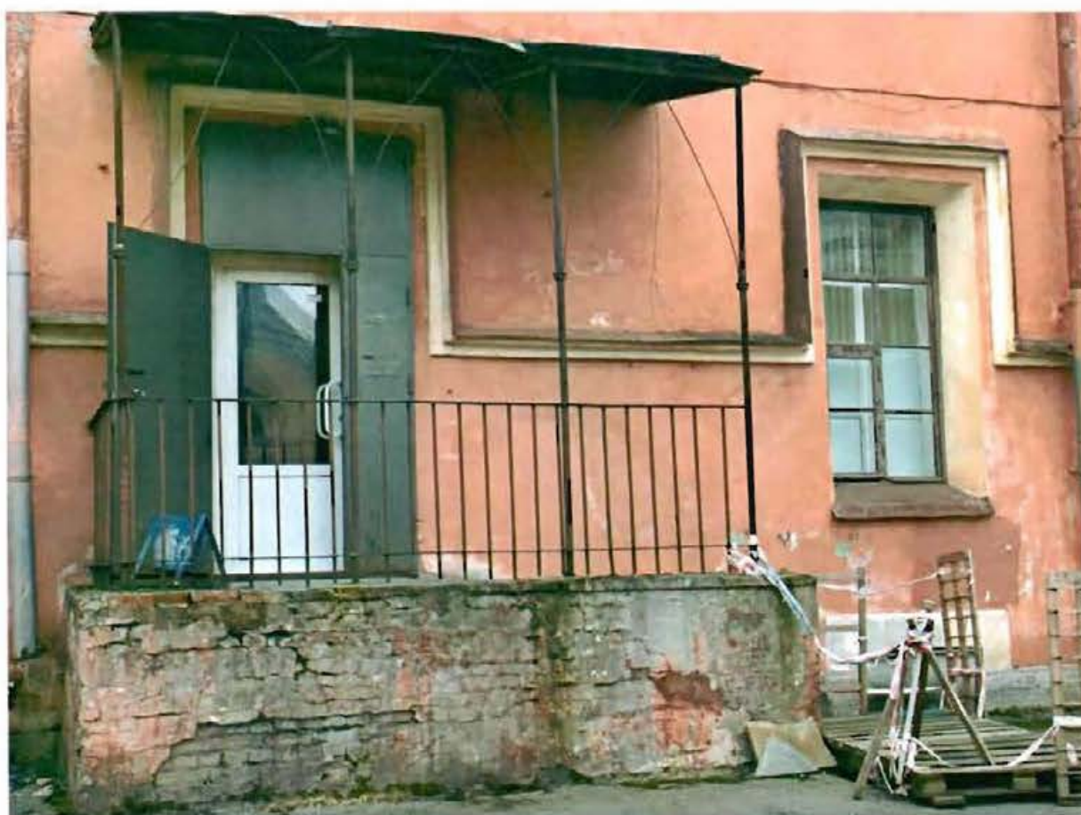
4. Крыльцо дворового фасада.
