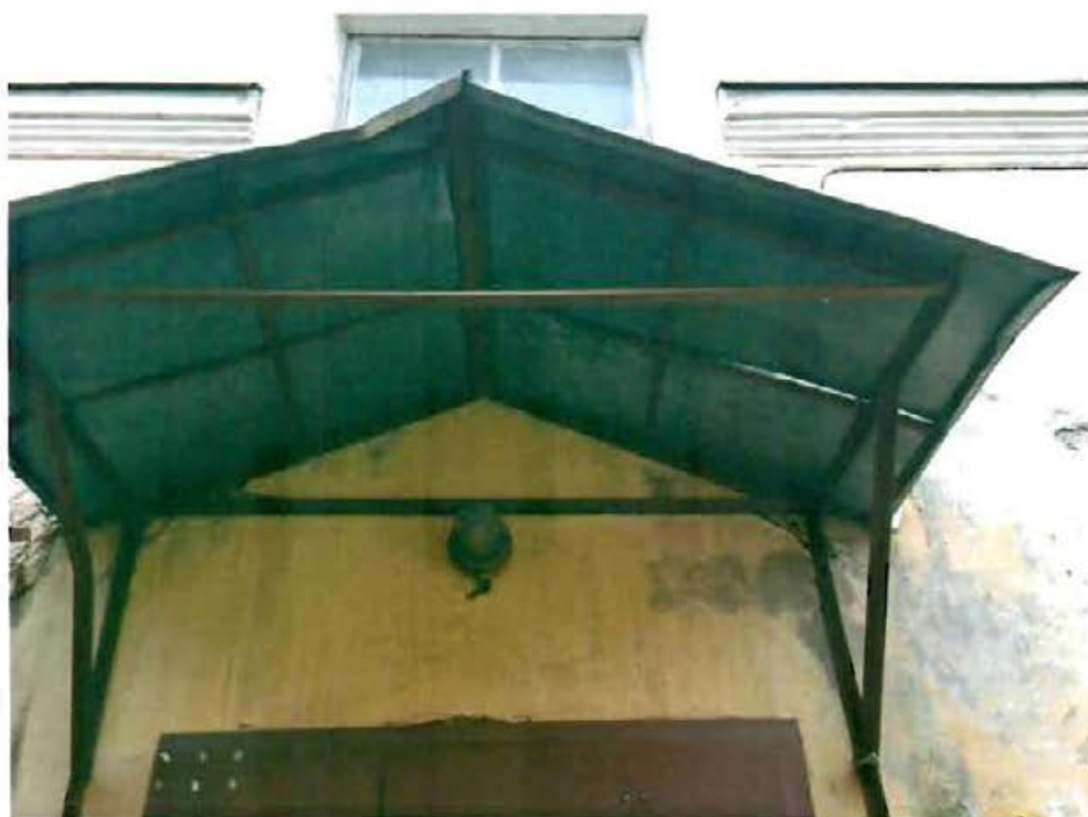
17. Козырек над дверным заполнением западного фасада.
