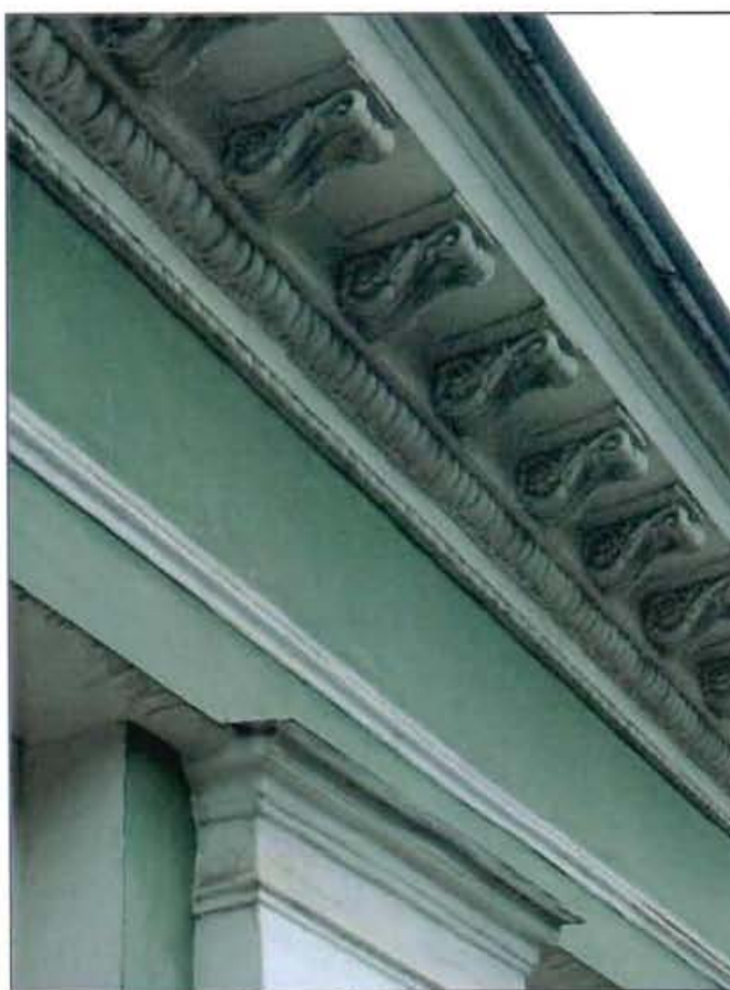
6. Западный фасад. Фрагмент. Венчающий карниз.
