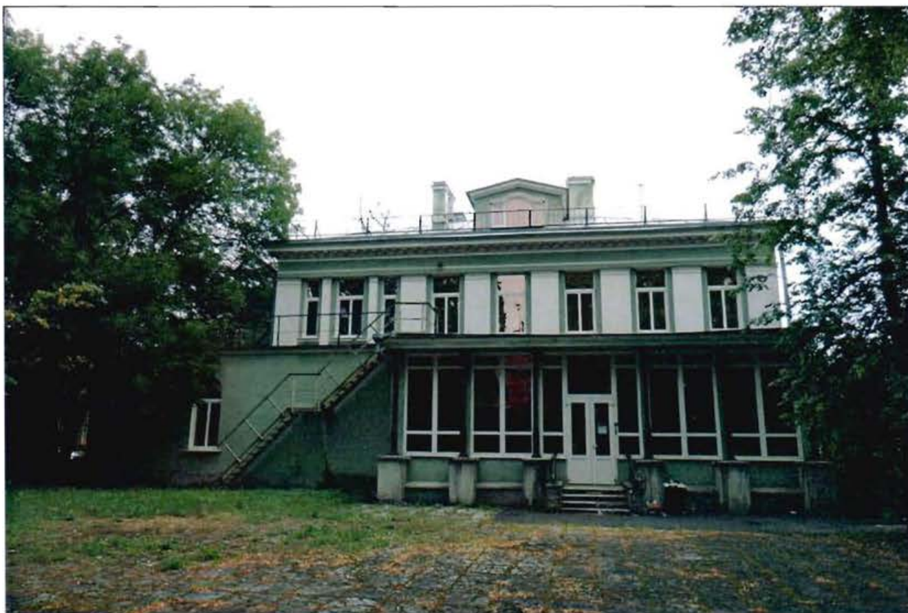
4. Западный фасад. Общий вид.
