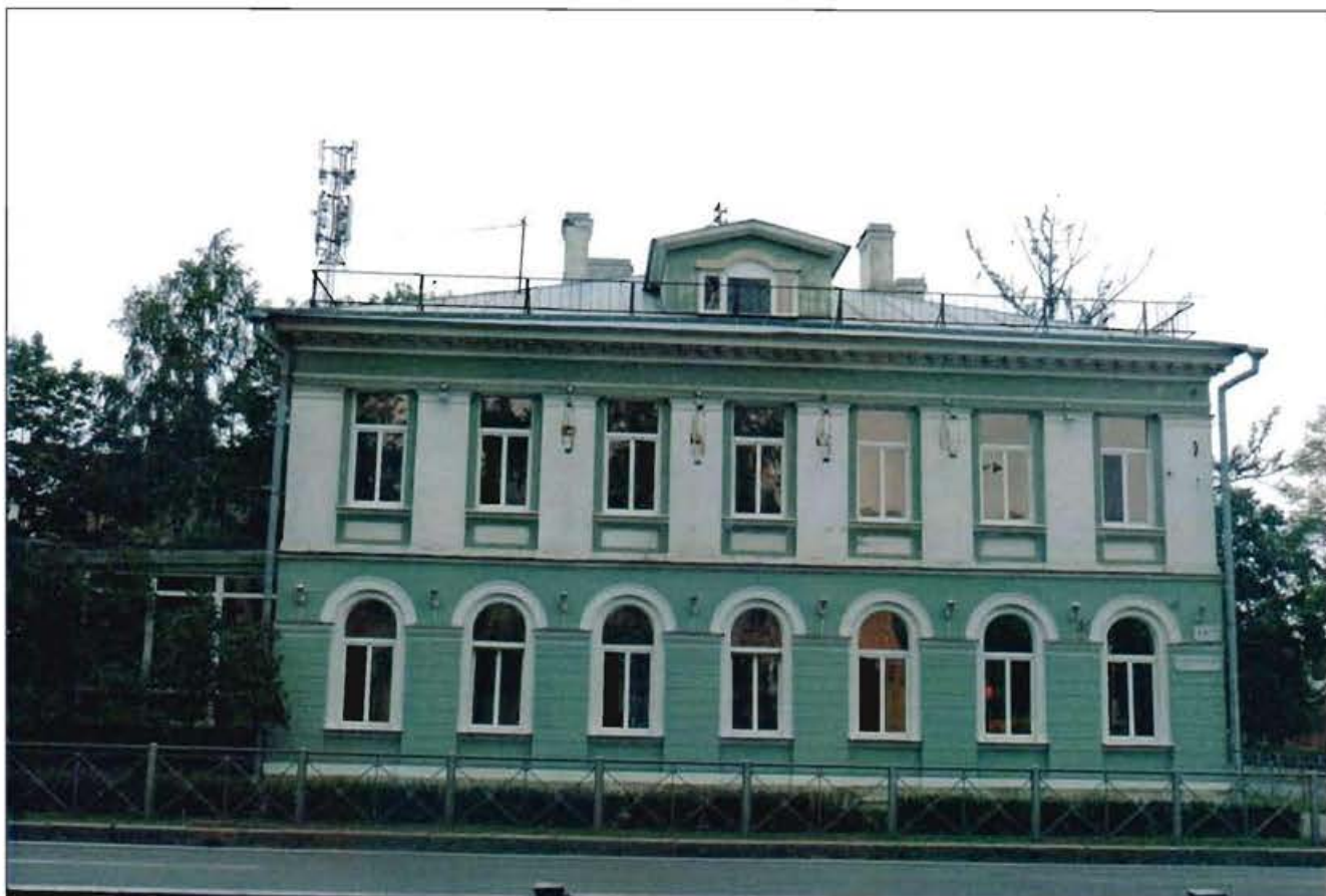
2. Южный фасад. Общий вид.
