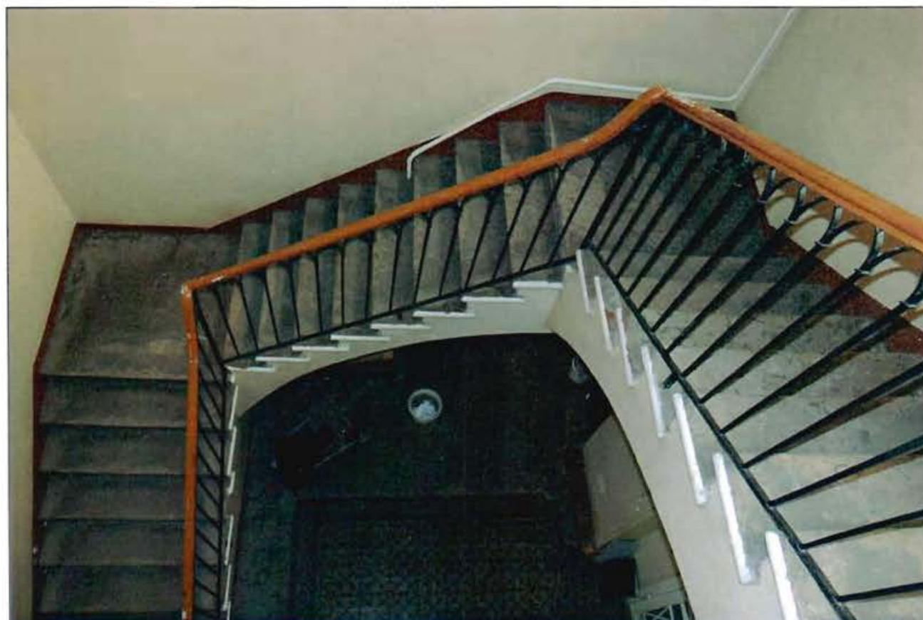
8. Интерьер. Фрагмент. Главная лестница.
