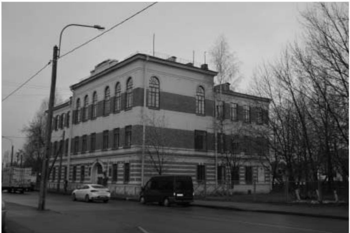
Фото № 1. Вид с юго-востока со Школьной улицы. 11.2021
