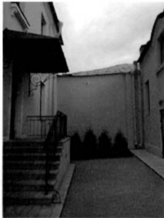
5. Крыльцо (со стороны северного фасада).
