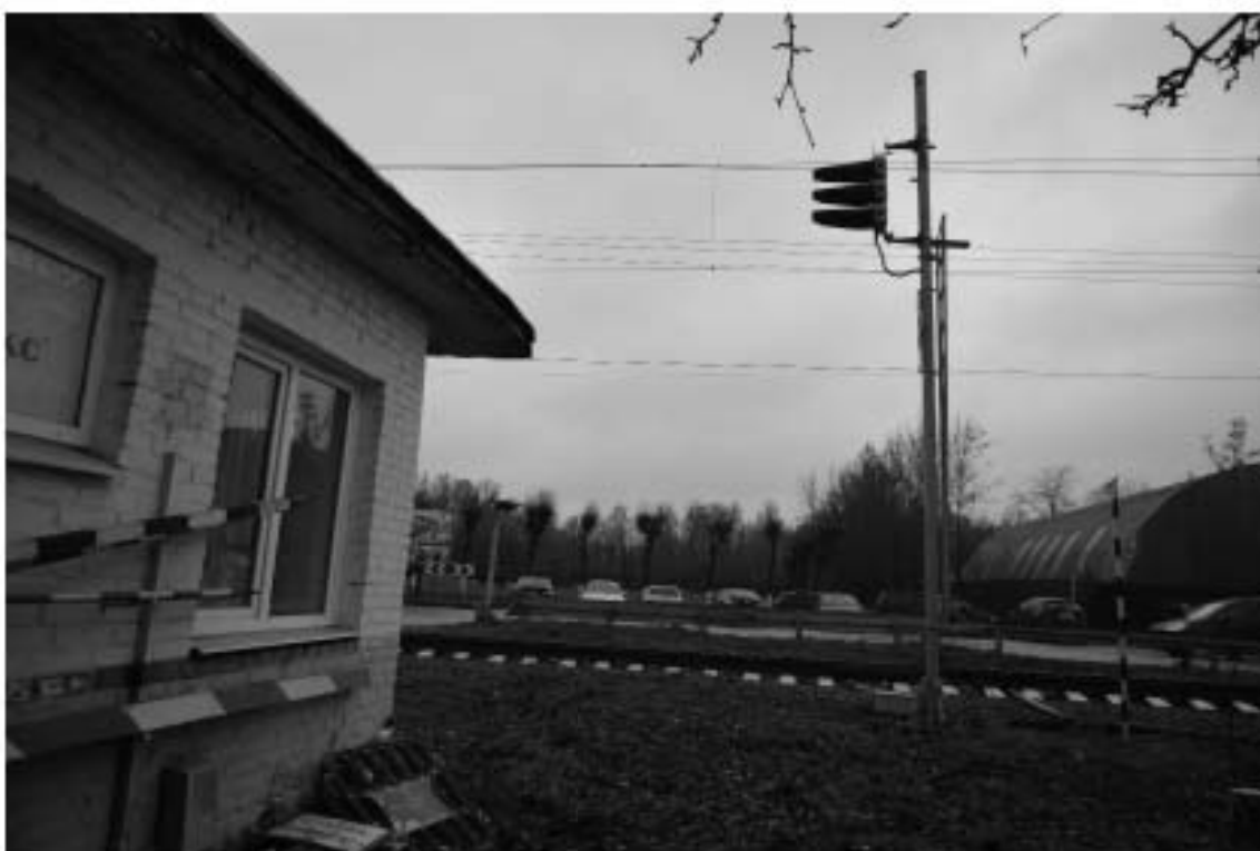
Фото № 2. Вид с юго-востока через ж/д пути. 11.2021
