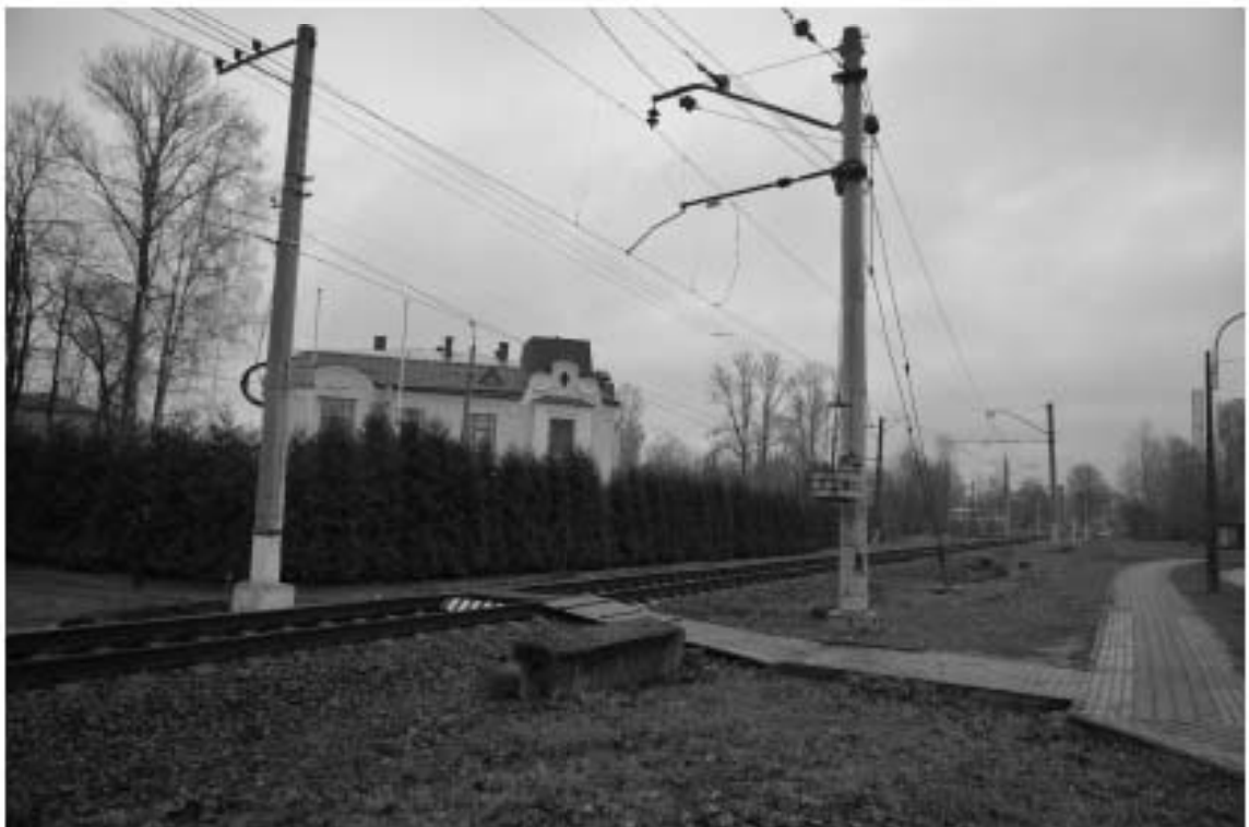
Фото № 4. Вид на здание с юго-востока через ж/д пути. 11.2021
