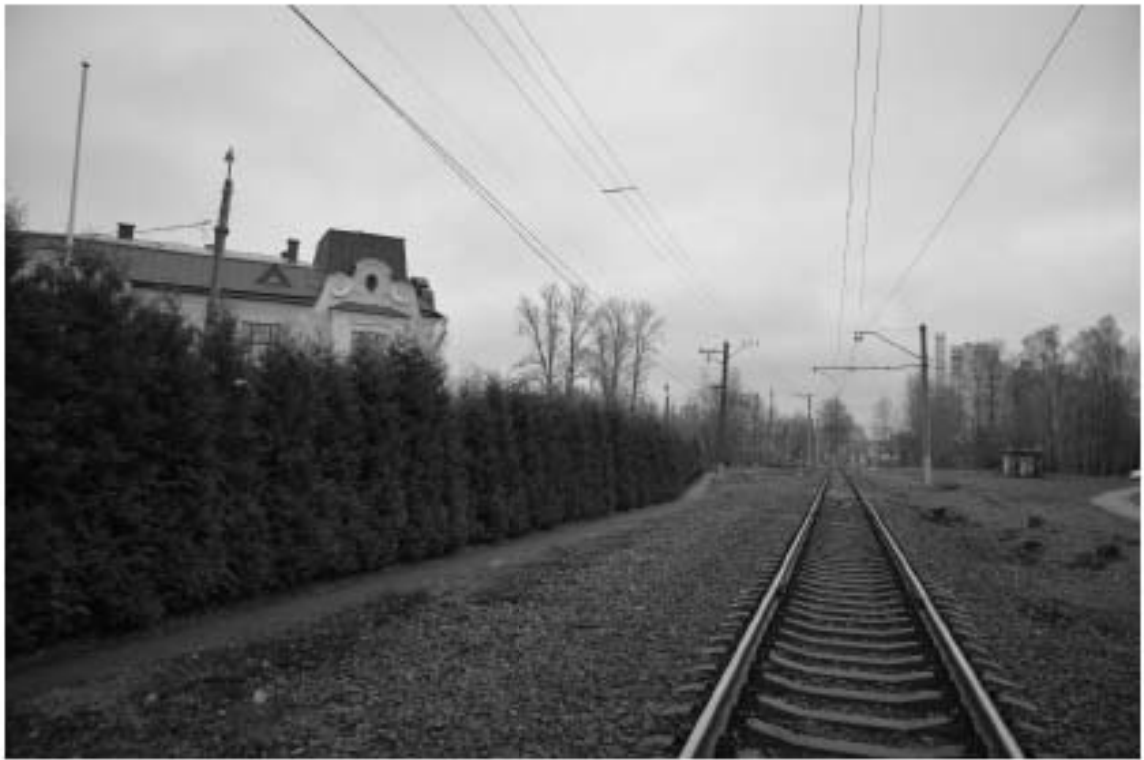
Фото № 5. Вид на здание с юго-востока с ж/д путей. 11.2021
