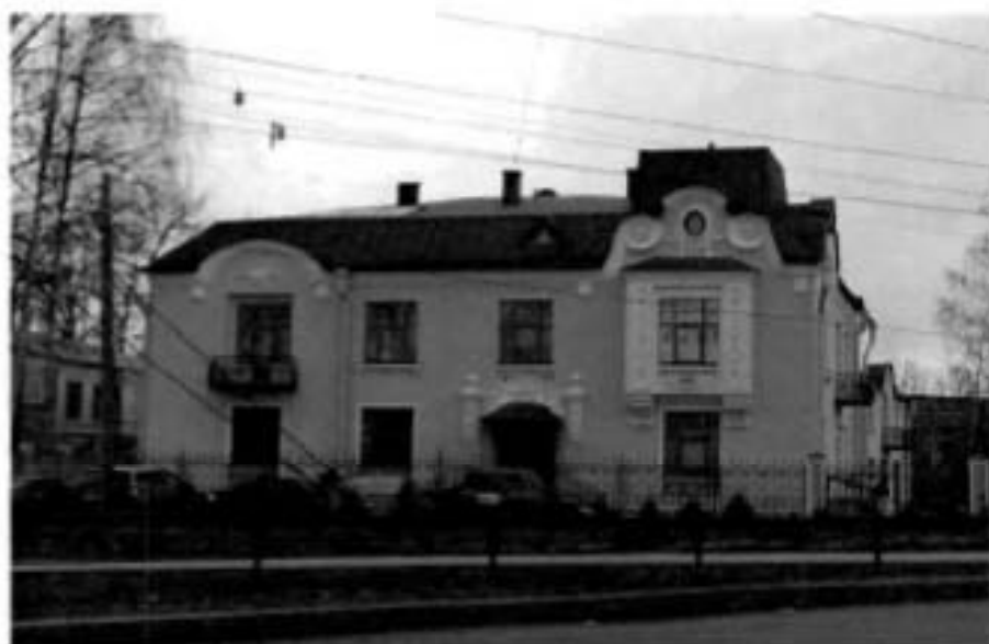
1. Общий вид (южный лицевой фасад).
