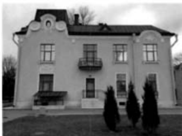
2. Общий вид (восточный фасад).
