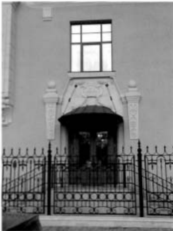
4. Оформление дверного проема со стороны южного фасада.
