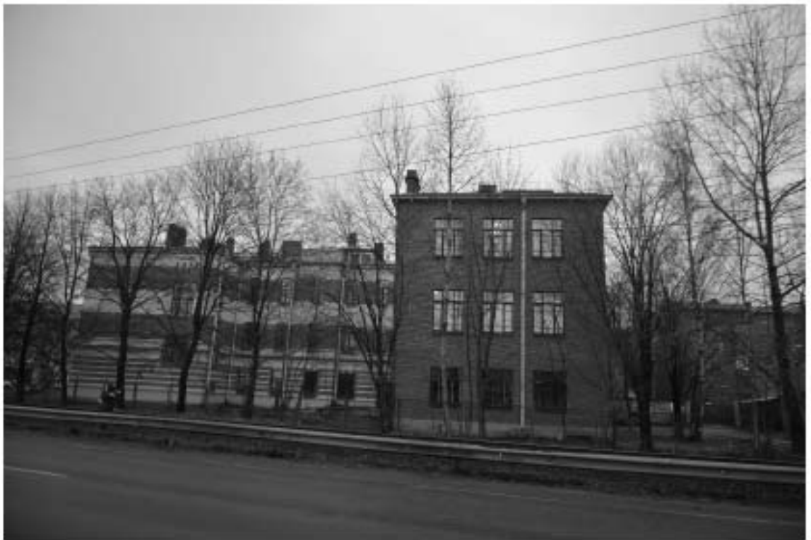
Фото № 3. Вид с севера через ж/д пути. 11.2021
