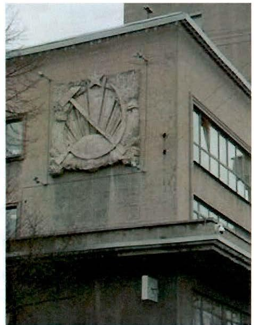
13. Угловая башня. Барельеф.
