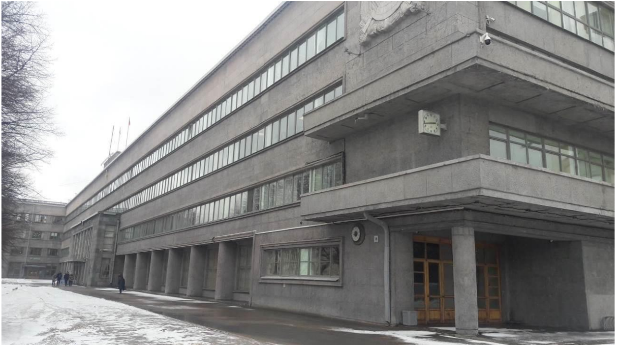
3. Райсовет Кировский, 1930-1935 гг., арх. Троцкий Н.А. Вид со стороны ул. Швецова. Штиглиц М.С. 01.03.2022 г.
