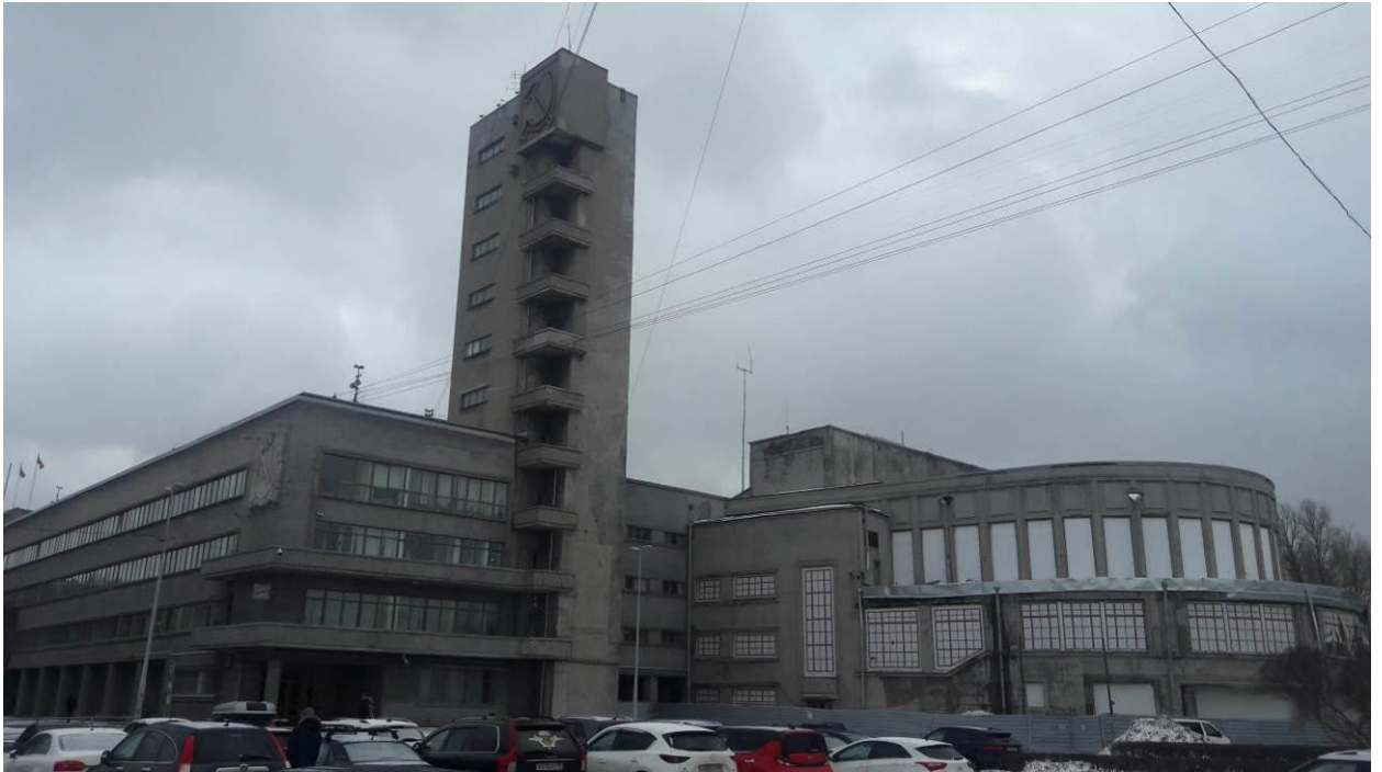
1. Райсовет Кировский, 1930-1935 гг., арх. Троцкий Н.А. Вид со стороны пр. Стачек. Штиглиц М.С. 01.03.2022 г.
