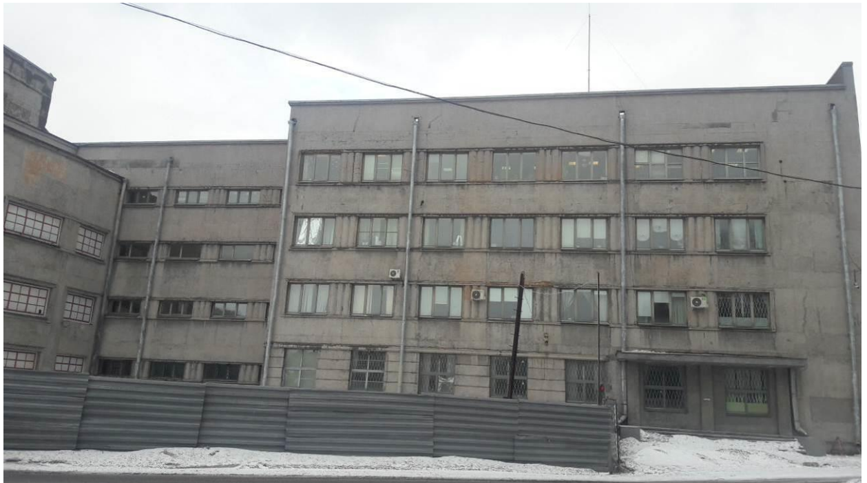
6. Райсовет Кировский, 1930-1935 гг., арх. Троцкий Н.А. Вид со стороны пр. Стачек. Штиглиц М.С. 01.03.2022 г.
