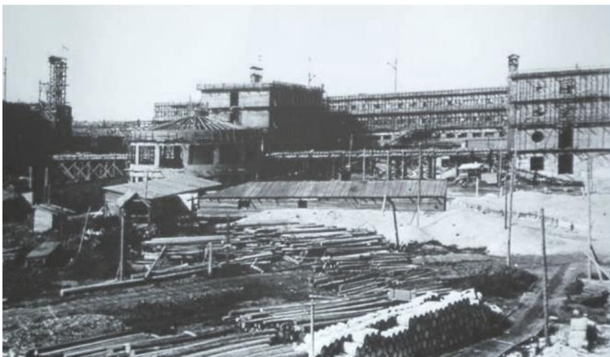
5. Строительство Кировского райсовета. Фото из фондов библиотеки им. Шолохова. 1930-е гг.
