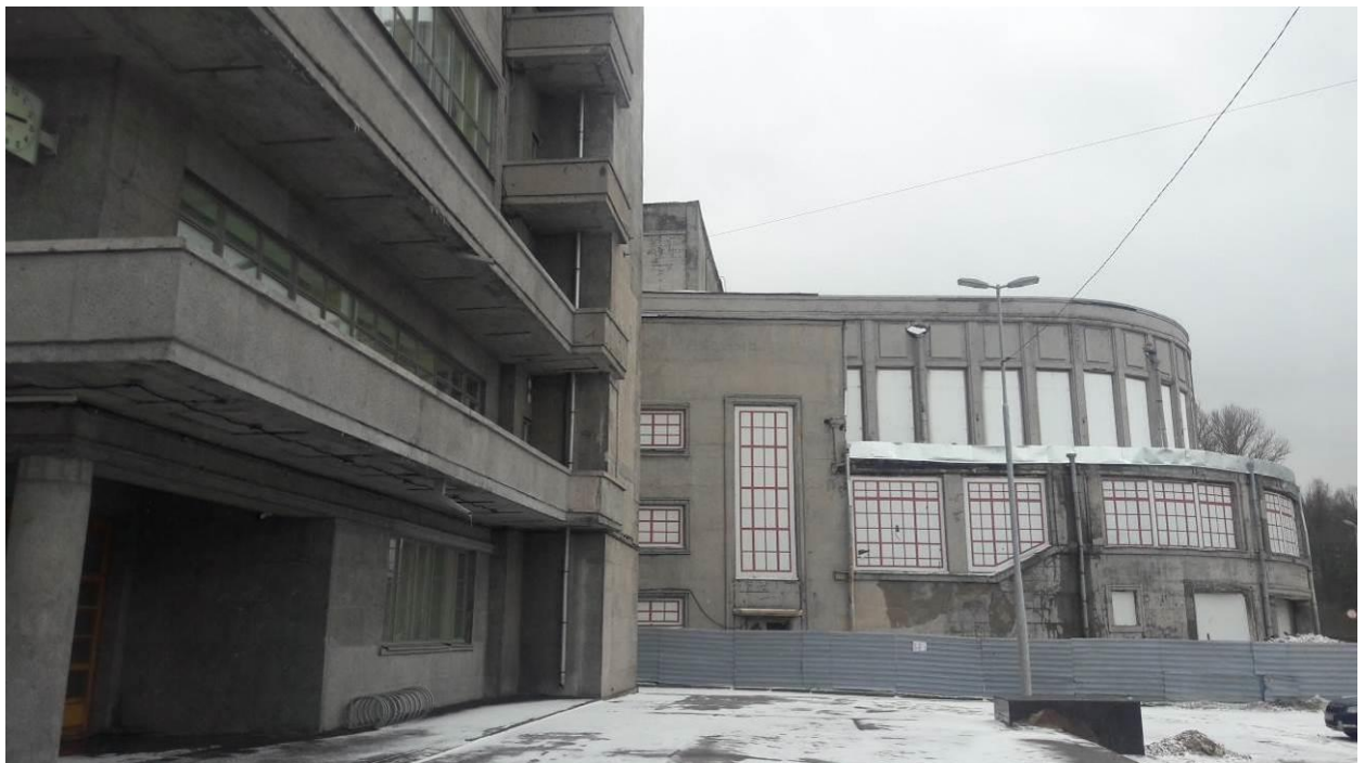
4. Райсовет Кировский, 1930-1935 гг., арх. Троцкий Н.А. Вид на бывший кинотеатр «Прогресс». Штиглиц М.С. 01.03.2022 г.
