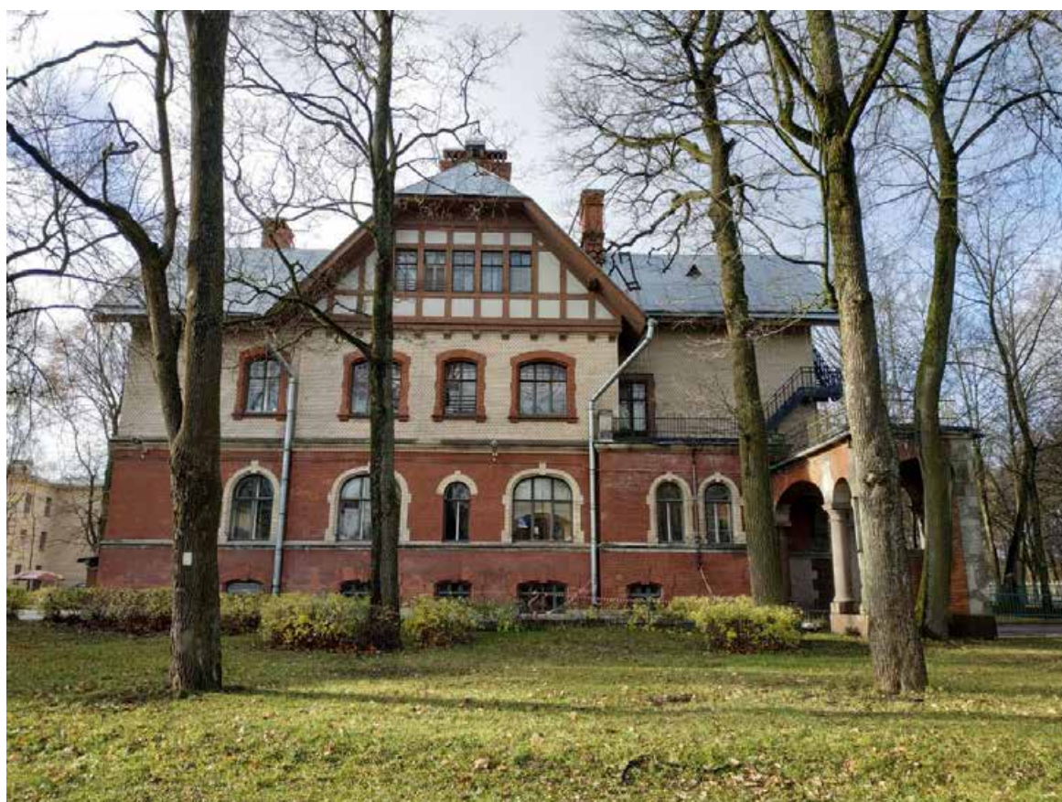
Фото 4. Дом Гудовича В.В. Вид на восточный фасад.
