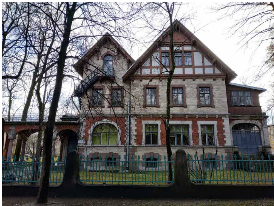
Фото 3. Дом Гудовича В.В. Вид на северный фасад.
