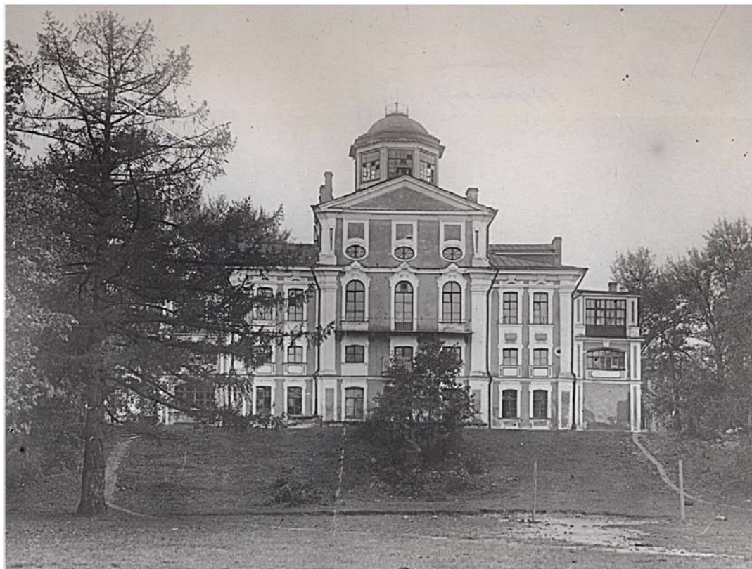
5. Новознаменский Главный дом. Главный фасад. Архив КГИОП. Пам. арх. № 274.
