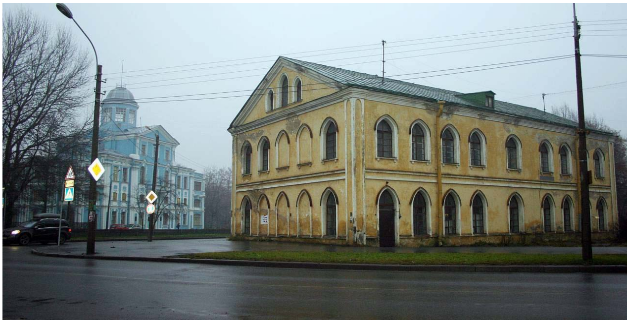
12. Общий вид территории бывшей усадьбы. Фото 2010 г. Архив ЗАО «Собор».
