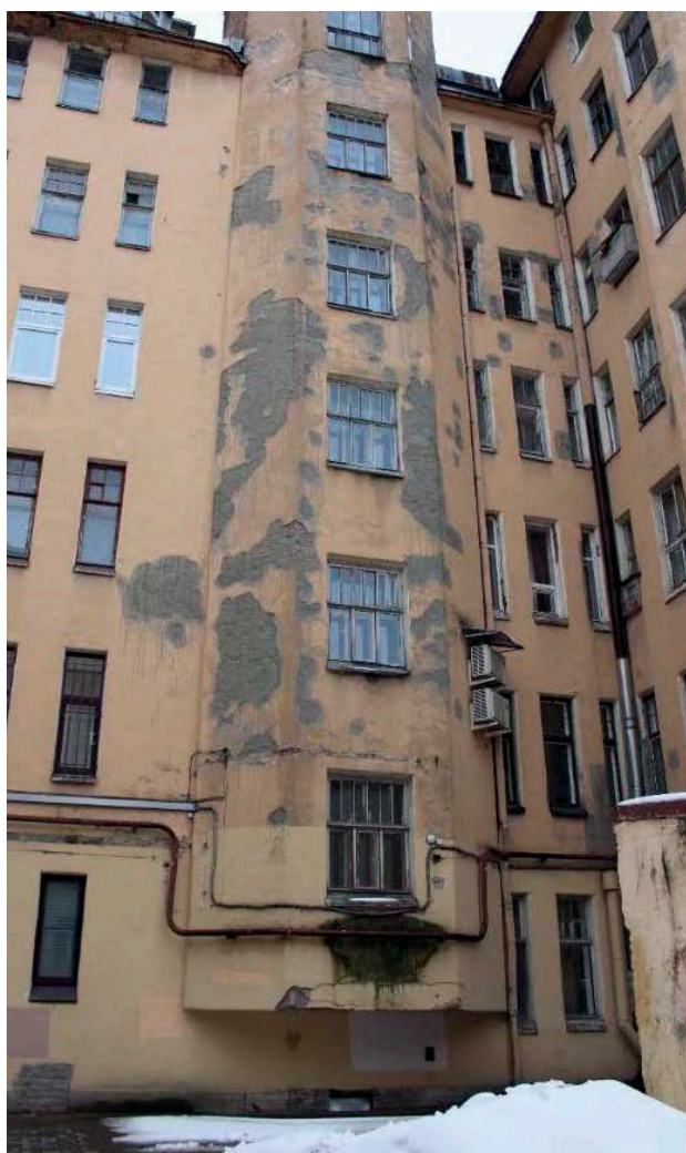
11. Выявленный объект культурного наследия «Дом А.В. Барсовой», по адресу: г. Санкт-Петербург, Заячий пер., д. 6/18, лит. А (Дегтярный пер., 18; Заячий пер., 6). Фрагмент дворового фасада. Дата съемки: 01.03.2022г.
