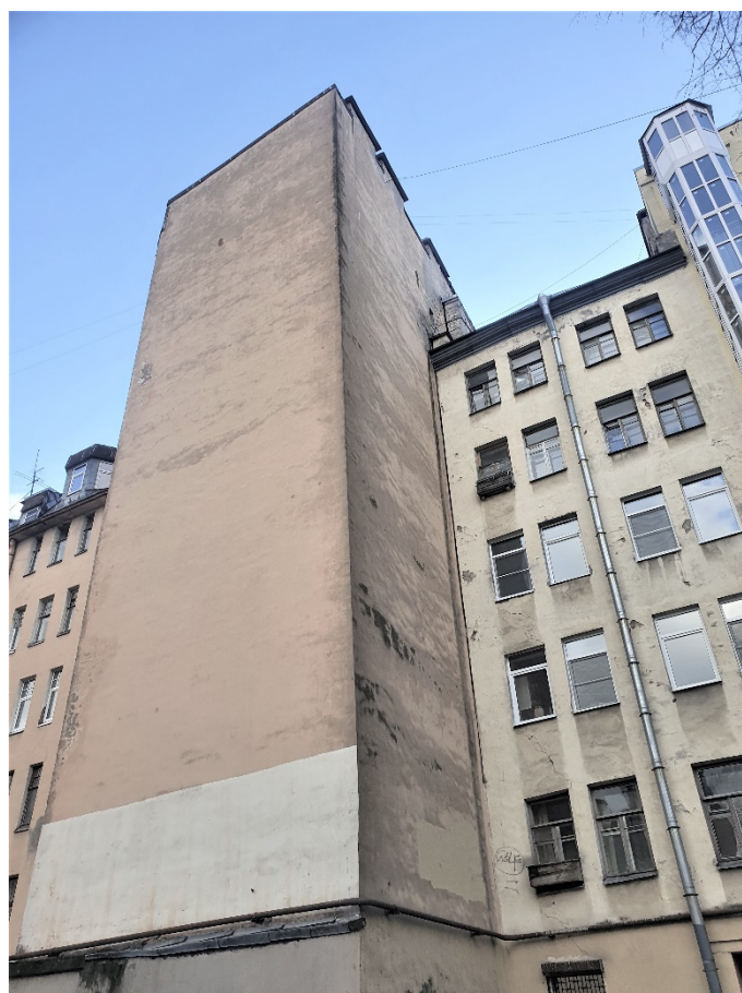
7. Выявленный объект культурного наследия «Дом А.В. Барсовой», по адресу: г. Санкт-Петербург, Заячий пер., д. 6/18, лит. А (Дегтярный пер., 18; Заячий пер., 6). Фрагмент дворового фасада. Дата съемки: 01.03.2022г.
