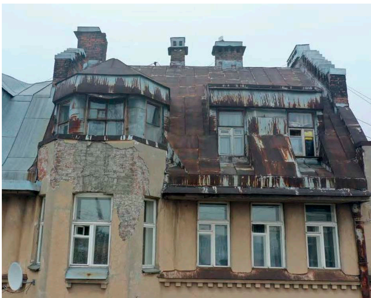
15. Выявленный объект культурного наследия «Дом А.В. Барсовой», по адресу: г. Санкт-Петербург, Заячий пер., д. 6/18, лит. А (Дегтярный пер., 18; Заячий пер., 6). Фрагмент крыши. Дата съемки: 01.03.2022г.
