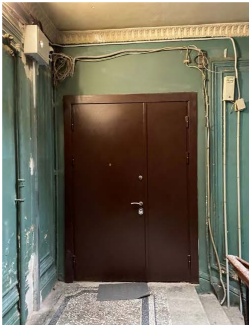
3. Входные дверные заполнения квартиры №25 в уровне 5-го этажа выявленного объекта культурного наследия «Дом С.Д. Шереметева», расположенного по адресу: г. Санкт-Петербург, Литейный проспект, дом 51, литера А. 22.12.2021.
