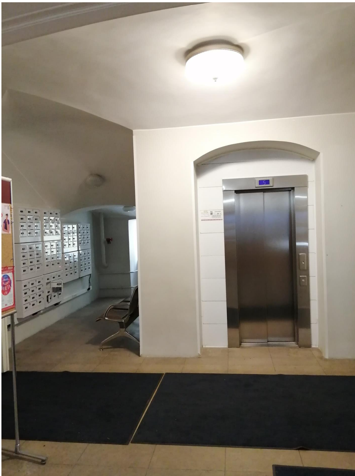
Фото 6. Объект культурного наследия федерального значения «Дирекция императорских театров», расположенный по адресу: Санкт-Петербург, Зодчего Росси ул., 2 Островского пл., 6 Ломоносова пл., 4, в составе объекта культурного наследия федерального значения «Ансамбль улицы Зодчего Росси». Площадка первого этажа лестницы ЛК 14.
