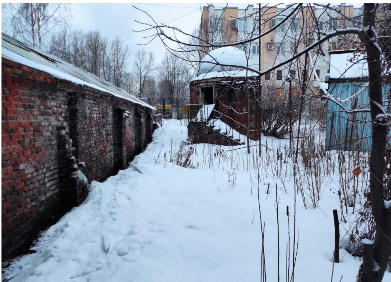
10. Сооружение павильона для астрономических наблюдений и ограда территории объекта культурного наследия федерального значения «Сад ботанический. Вид от здания, расположенного по адресу: г. Санкт-Петербург, Университетская наб., д.7-9-11, литера Т. 01.02.2022
