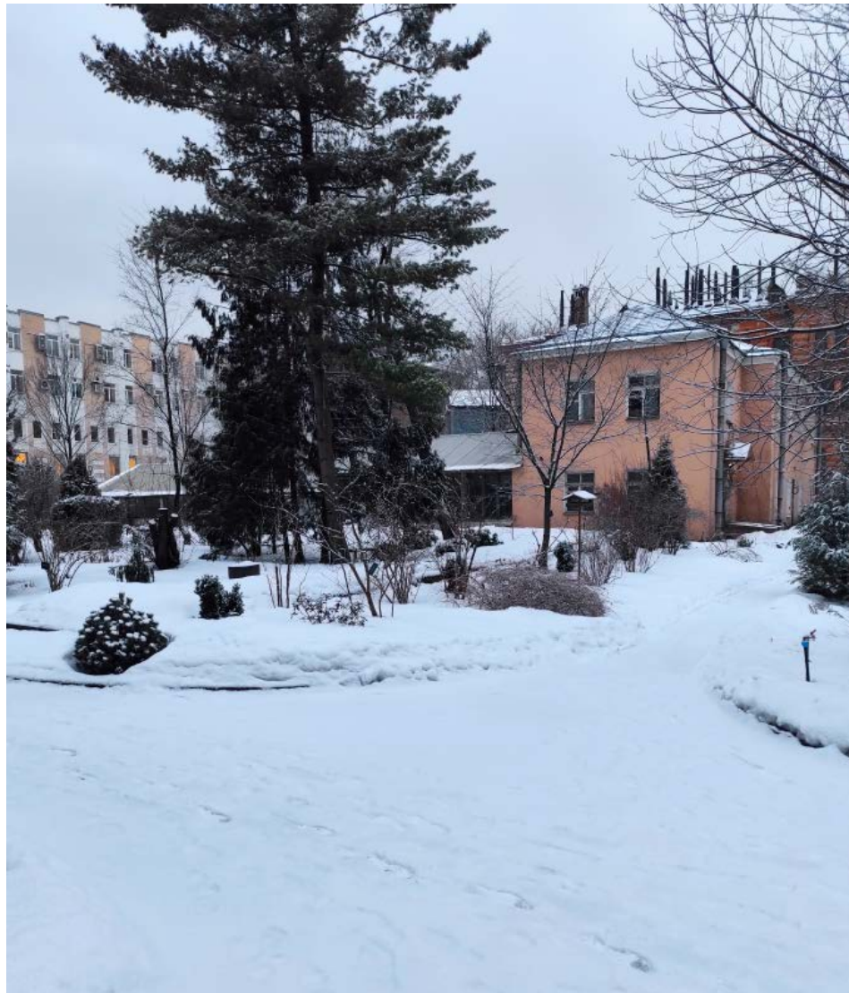
2. Вид на здание, расположенное по адресу: г. Санкт-Петербург, Университетская наб., д.7-9-11, литера Т, и территорию объекта культурного наследия федерального значения «Сад ботанический» с востока. 01.02.2022
