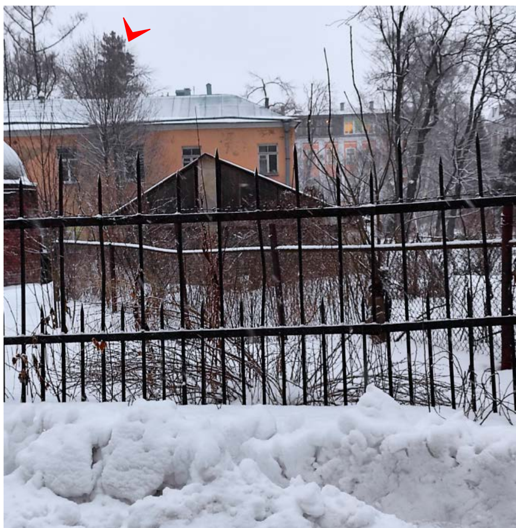
1. Вид на здание, расположенное по адресу: г. Санкт-Петербург, Университетская наб., д.7-9-11, литера Т, и территорию объекта культурного наследия федерального значения «Сад ботанический» с юго-запада. 01.02.2022
