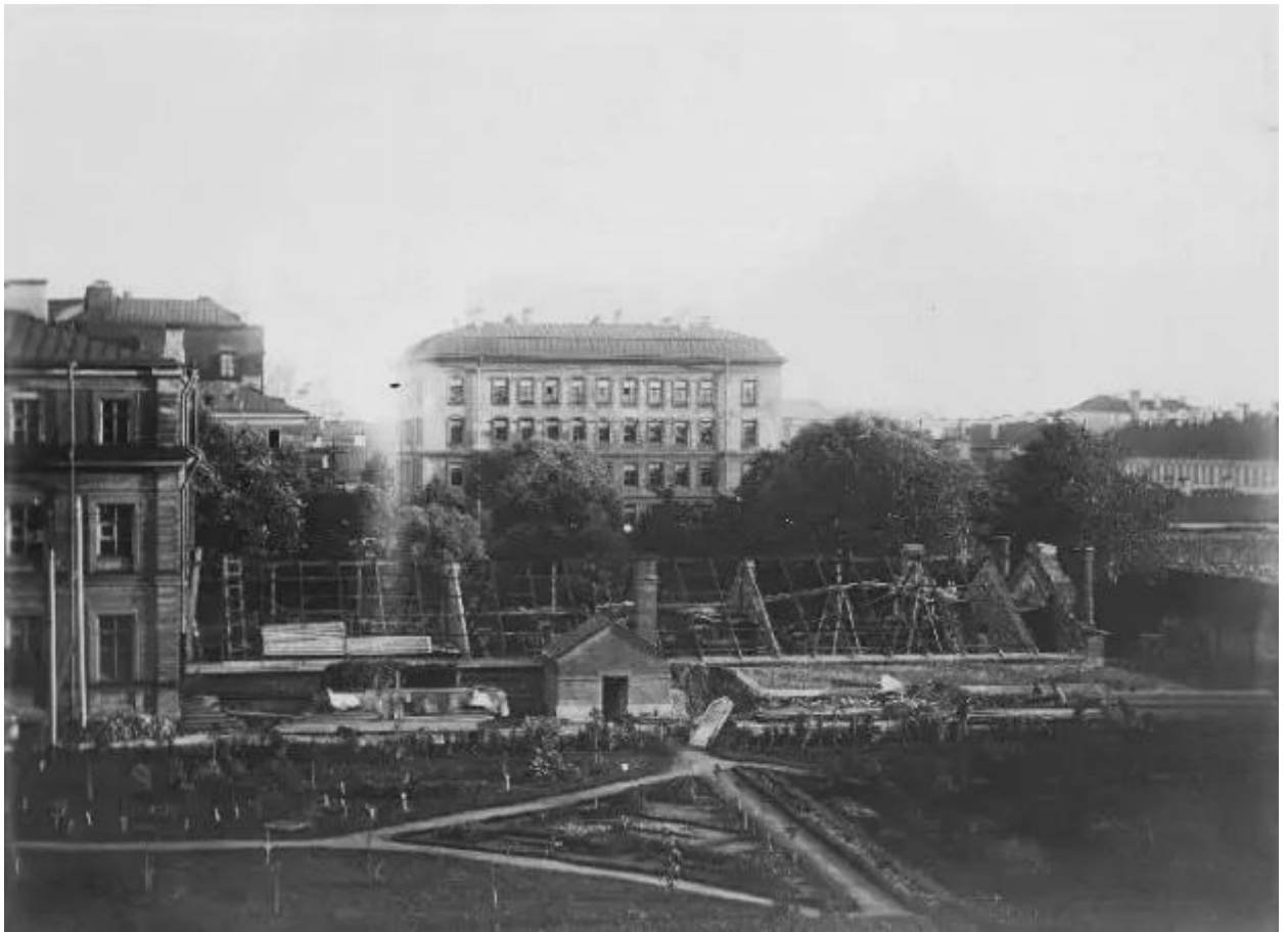
3. Строящаяся оранжерея университетского Ботанического сада. 1894 -1896// ЦГАКФФД СПб Шифр: Ар 252191
