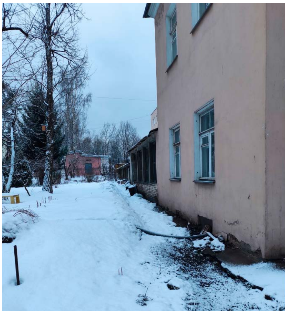
4. Юго-восточный фасад здания, расположенного по адресу: г. Санкт-Петербург, Университетская наб., д.7-9-11, литера Т, и территорию объекта культурного наследия федерального значения «Сад ботанический». 01.02.2022
