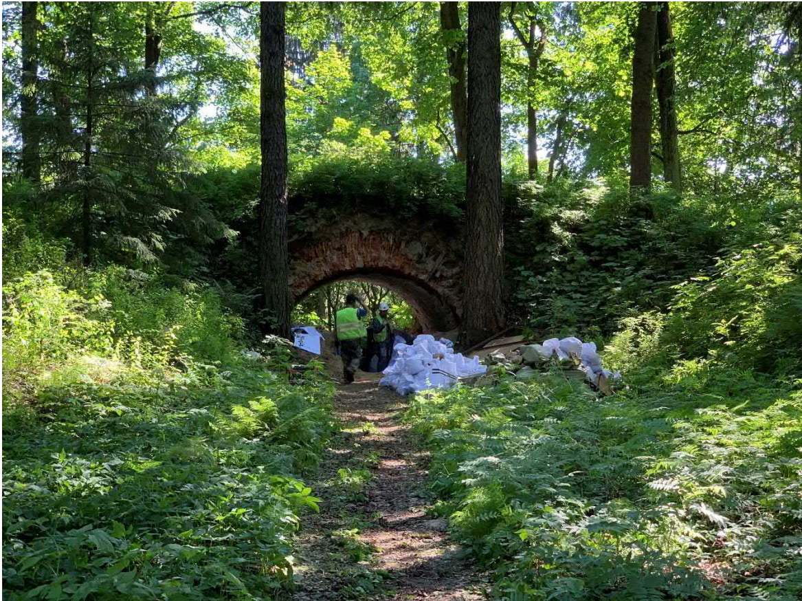
Фото 1. Туфовая арка. Северный вход
