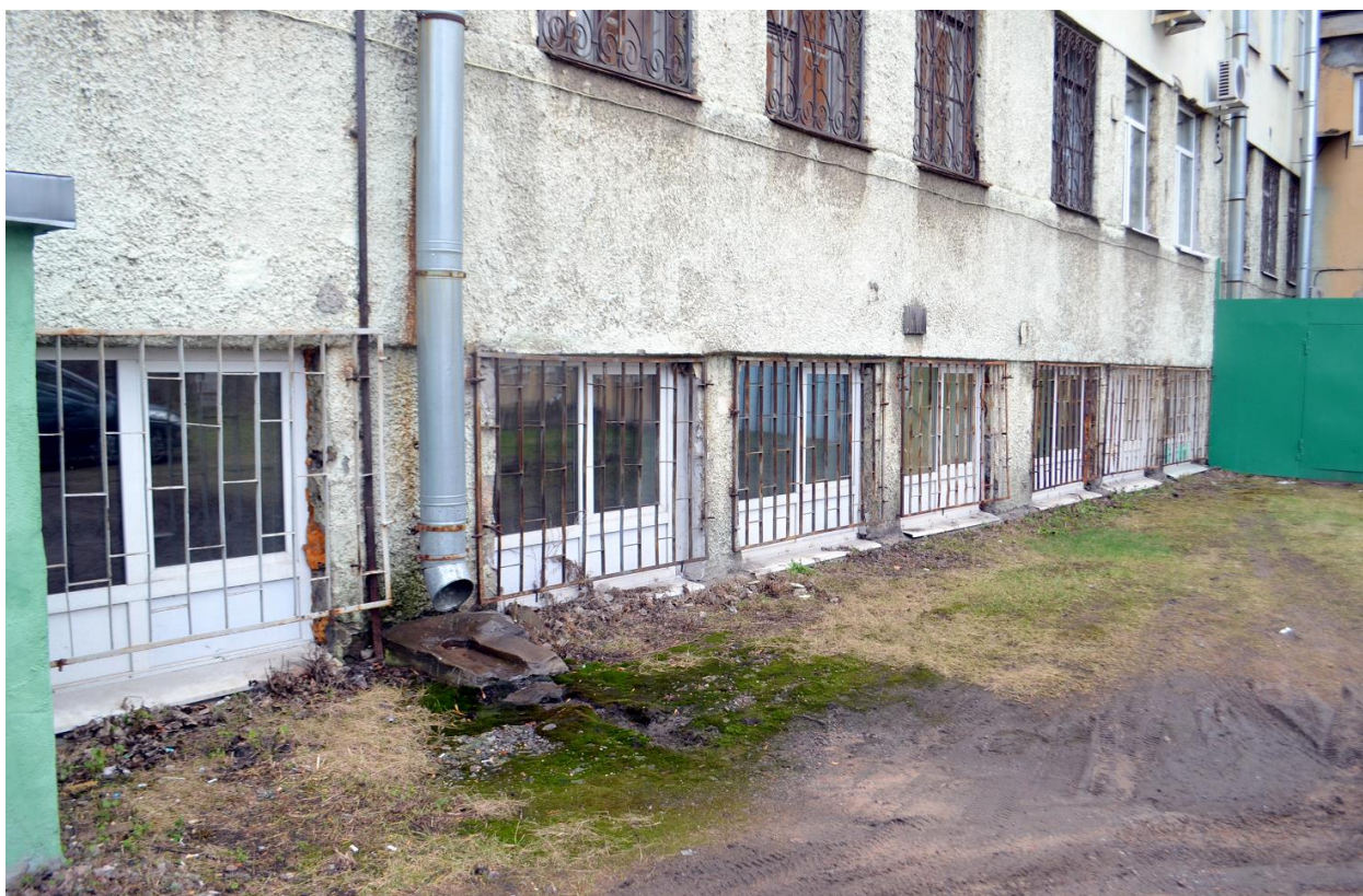
Фото 12. Выявленный ОКН «Здание школы», расположенного по адресу: г. Санкт-Петербург, Балтийская улица, дом 35, литера А (Балтийская ул., 35). Западный фасад. Фрагмент. Съёмка 17.02.2020 г.
