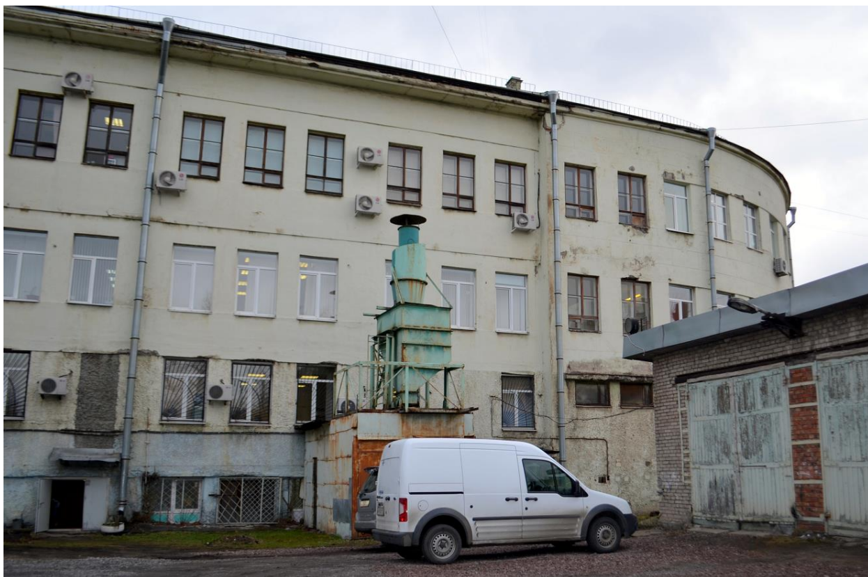
Фото 19. Выявленный ОКН «Здание школы», расположенного по адресу: г. Санкт-Петербург, Балтийская улица, дом 35, литера А (Балтийская ул., 35). Западный фасад. Фрагмент. Съёмка 17.02.2020 г.
