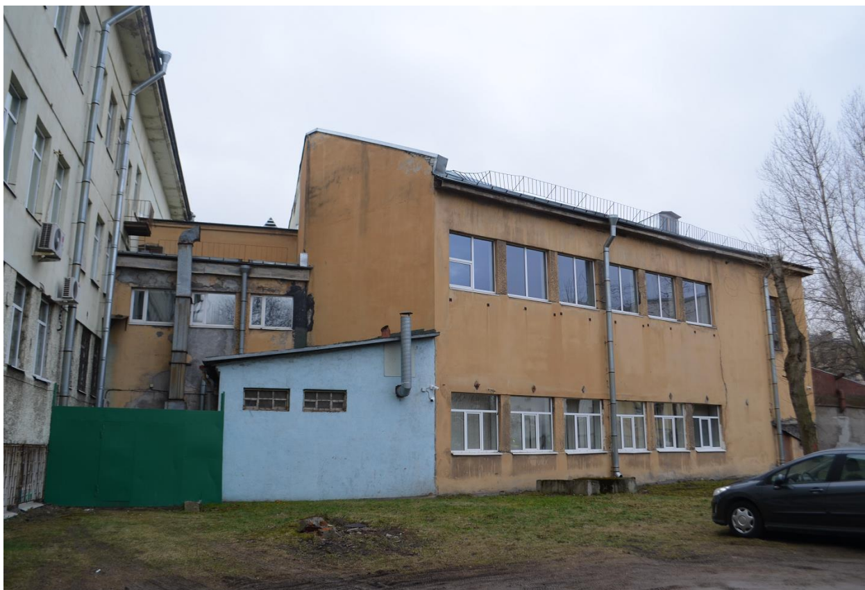
Фото 13. Выявленный ОКН «Здание школы», расположенного по адресу: г. Санкт-Петербург, Балтийская улица, дом 35, литера А (Балтийская ул., 35). Северный фасад. Фрагмент. Съёмка 17.02.2020 г.
