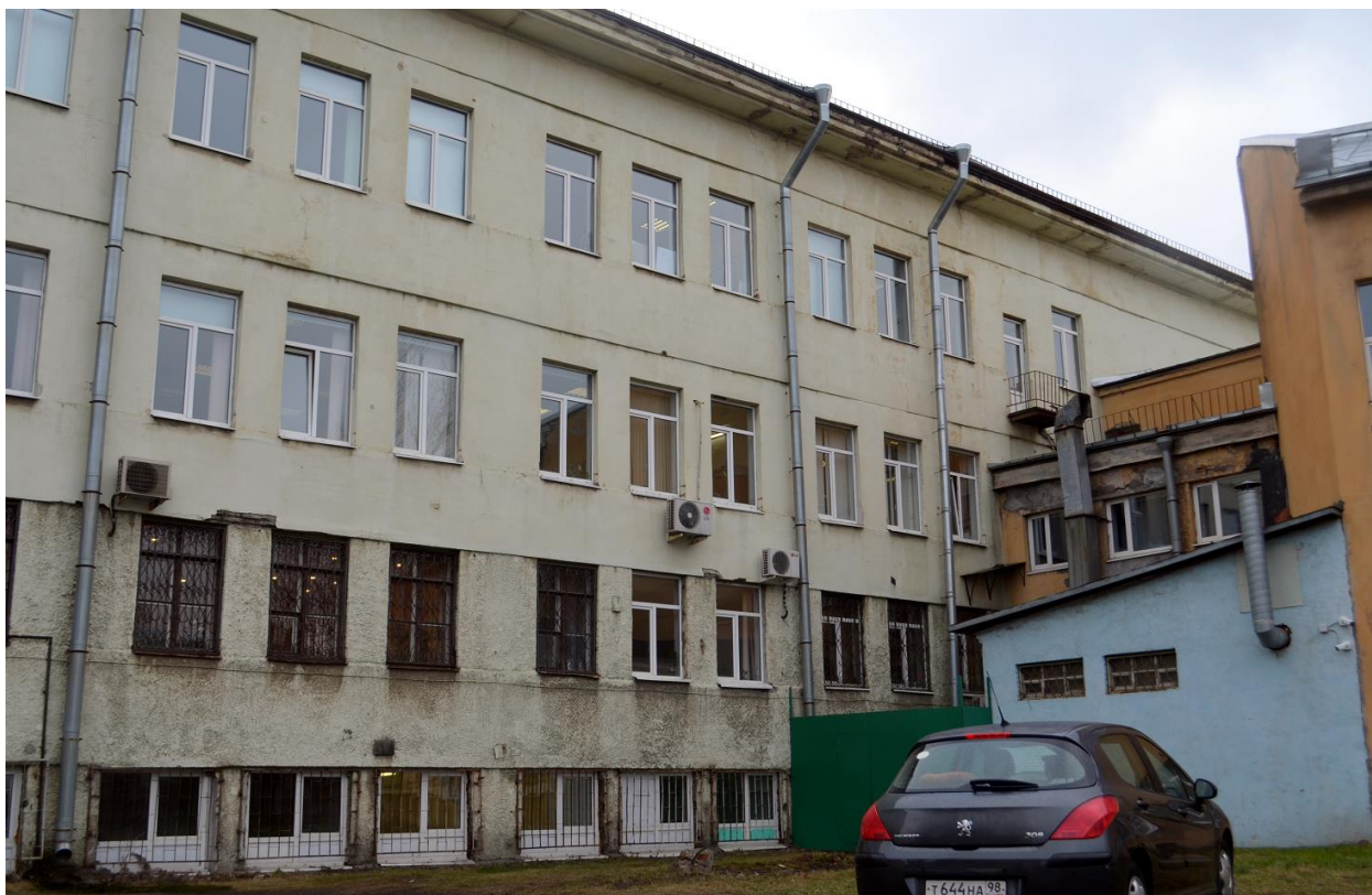
Фото 11. Выявленный ОКН «Здание школы», расположенного по адресу: г. Санкт-Петербург, Балтийская улица, дом 35, литера А (Балтийская ул., 35). Западный фасад. Фрагмент. Съёмка 17.02.2020 г.
