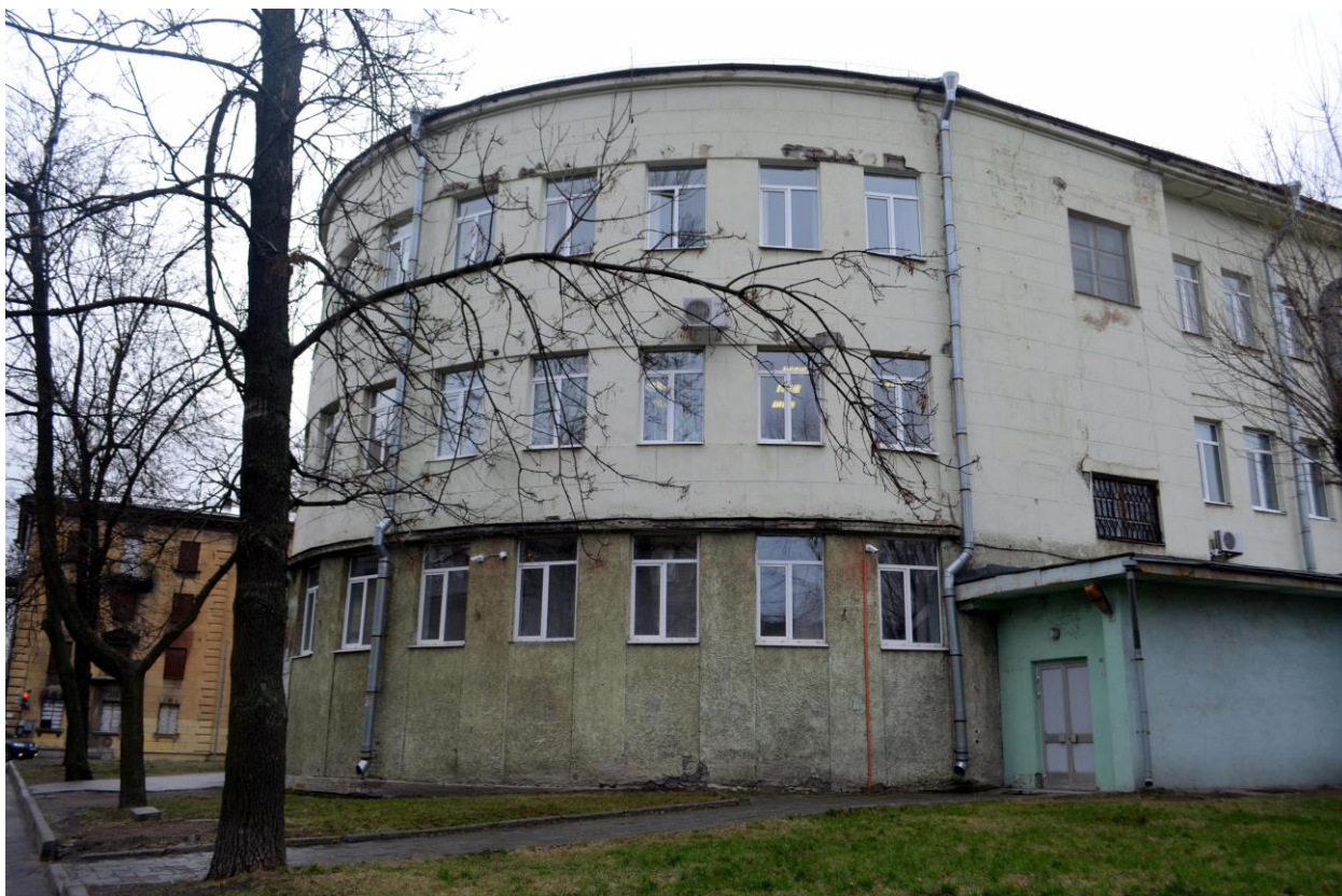
Фото 09. Выявленный ОКН «Здание школы», расположенного по адресу: г. Санкт-Петербург, Балтийская улица, дом 35, литера А (Балтийская ул., 35). Западный фасад. Фрагмент. Съёмка 17.02.2020 г.
