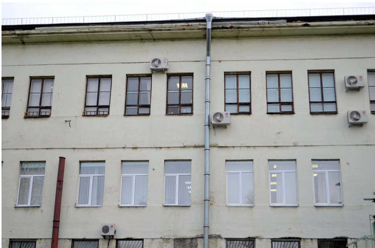
Фото 21. Выявленный ОКН «Здание школы», расположенного по адресу: г. Санкт-Петербург, Балтийская улица, дом 35, литера А (Балтийская ул., 35). Западный фасад. Фрагмент. Съёмка 17.02.2020 г.
