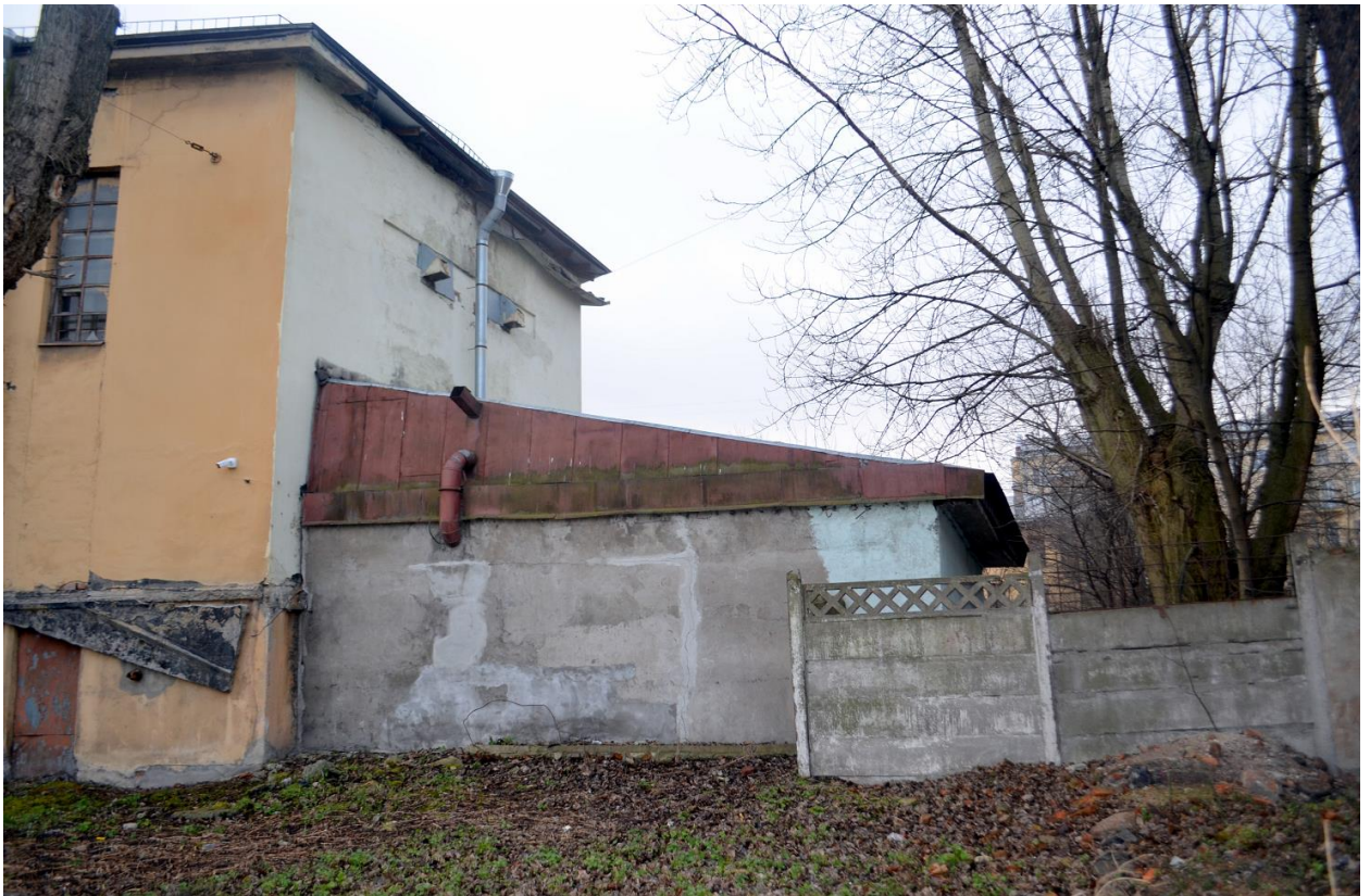
Фото 14. Выявленный ОКН «Здание школы», расположенного по адресу: г. Санкт-Петербург, Балтийская улица, дом 35, литера А (Балтийская ул., 35). Северный фасад. Фрагмент. Съёмка 17.02.2020 г.
