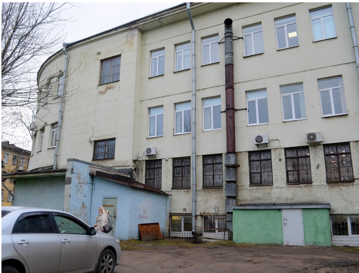
Фото 10. Выявленный ОКН «Здание школы», расположенного по адресу: г. Санкт-Петербург, Балтийская улица, дом 35, литера А (Балтийская ул., 35). Западный фасад. Фрагмент. Съёмка 17.02.2020 г.
