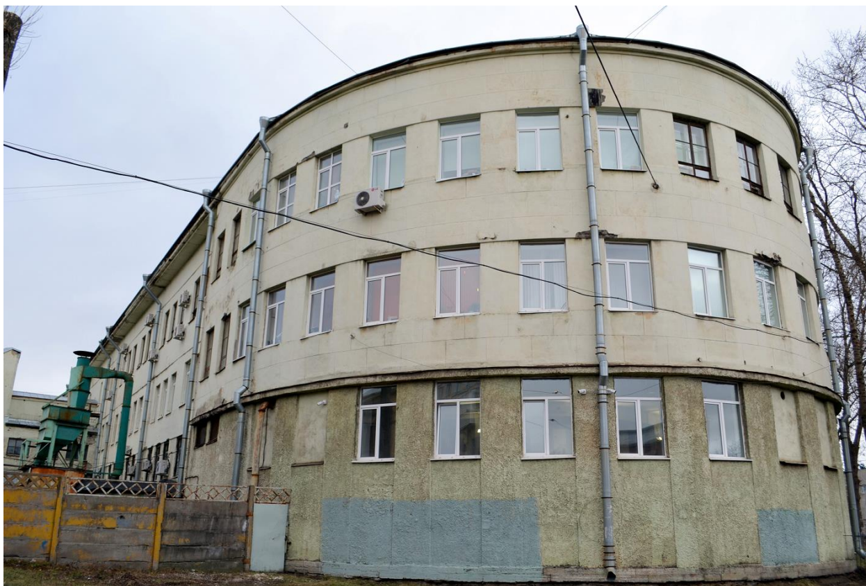
Фото 18. Выявленный ОКН «Здание школы», расположенного по адресу: г. Санкт-Петербург, Балтийская улица, дом 35, литера А (Балтийская ул., 35). Западный фасад. Фрагмент. Съёмка 17.02.2020 г.
