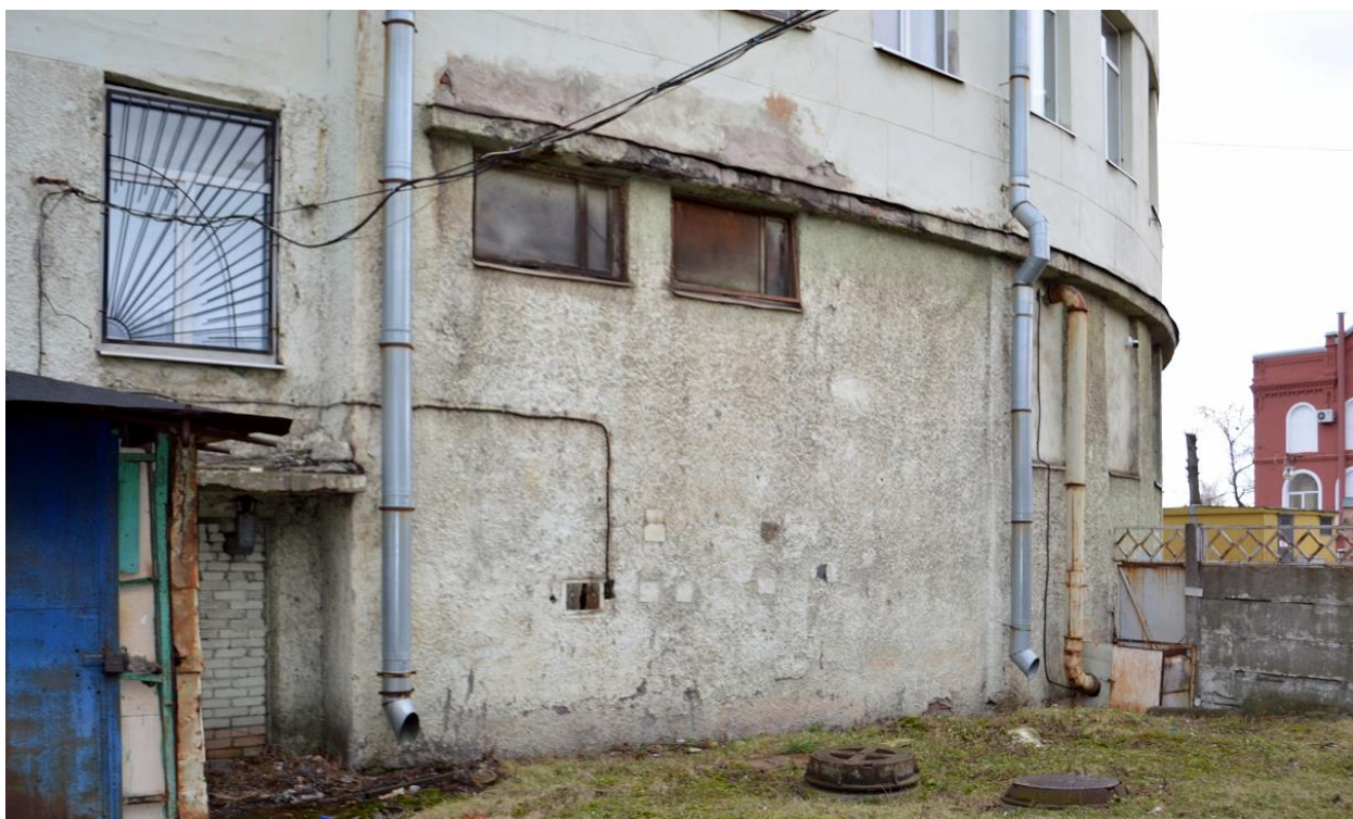
Фото 20. Выявленный ОКН «Здание школы», расположенного по адресу: г. Санкт-Петербург, Балтийская улица, дом 35, литера А (Балтийская ул., 35). Западный фасад. Фрагмент. Съёмка 17.02.2020 г.
