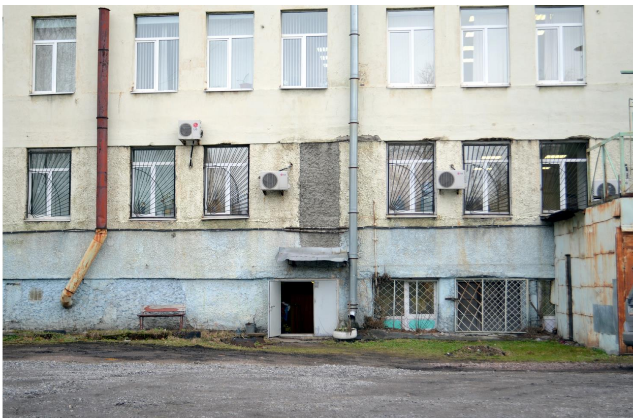
Фото 22. Выявленный ОКН «Здание школы», расположенного по адресу: г. Санкт-Петербург, Балтийская улица, дом 35, литера А (Балтийская ул., 35). Западный фасад. Фрагмент. Съёмка 17.02.2020 г.
