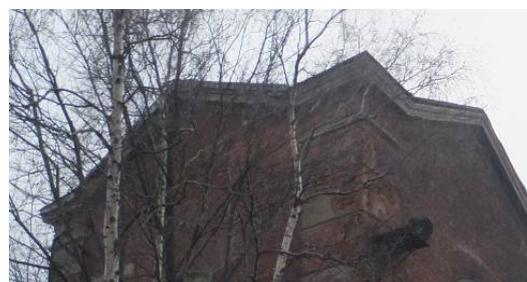
профилированный карниз в завершении основания дымовой трубы.
