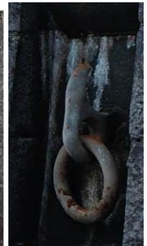
исторические швартовочные кольца на устоях восточной части камеры дока – местоположение, габариты, материал (металл).
