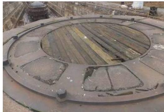
исторические конструкции шлюза и затвора – блоки из гранита (облицовка шлюза и порога затвора), металл (материал затвора);
