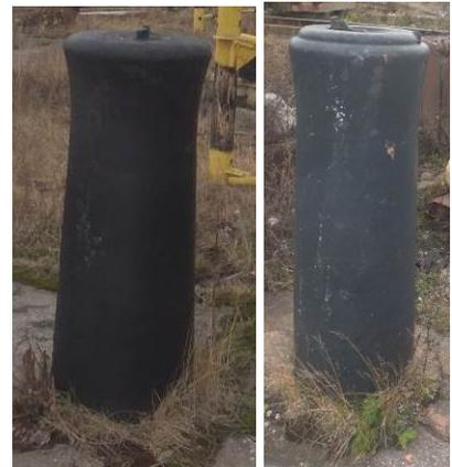
исторический материал гидротехнических механизмов, кабестанов, кнехтов, на берме вдоль камеры дока, на краю и устоях ворот-местоположение, материал (металл);
