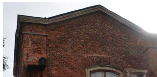
треугольные фронтоны в завершении северного объема, оформленные профилированными ступенчатыми штукатурными карнизами;
