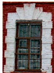
оформление дверных и оконных проемов в центре ризалитов – горизонтальный руст, подоконные доски простого профиля, замковые камни над дверными проемами;
