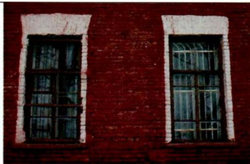
оформление оконных проемов первого этажа ризалитов (по 3,4,6,7,13,14,18,19,21,22 осям) – кирпичный руст, трехчастные замковые камни, подоконные доски простого профиля;
