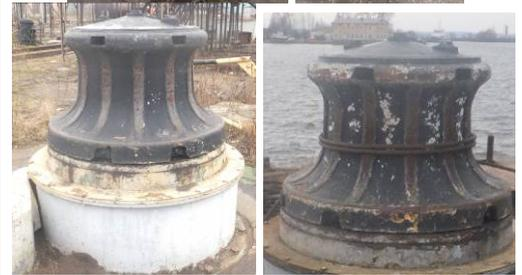
исторические швартовочные кольца на и устоях южной части камеры дока – местоположение, габариты, материал (металл).
