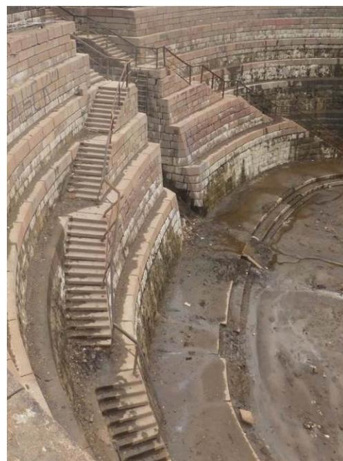
исторический материал облицовки шлюза и затвора – блоки из гранита (облицовка шлюза и порога затвора), металл (материал затвора);
