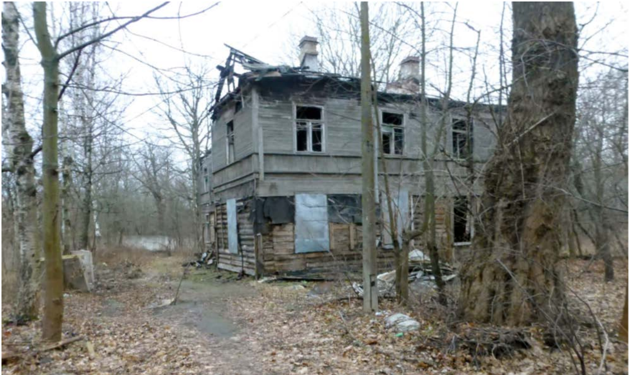
20. 2012 г. Дом №4 по Собственному пр. Вид восточного фасада со стороны проезда, ведущего от Рубинштейнской ул. Фото после пожара.
