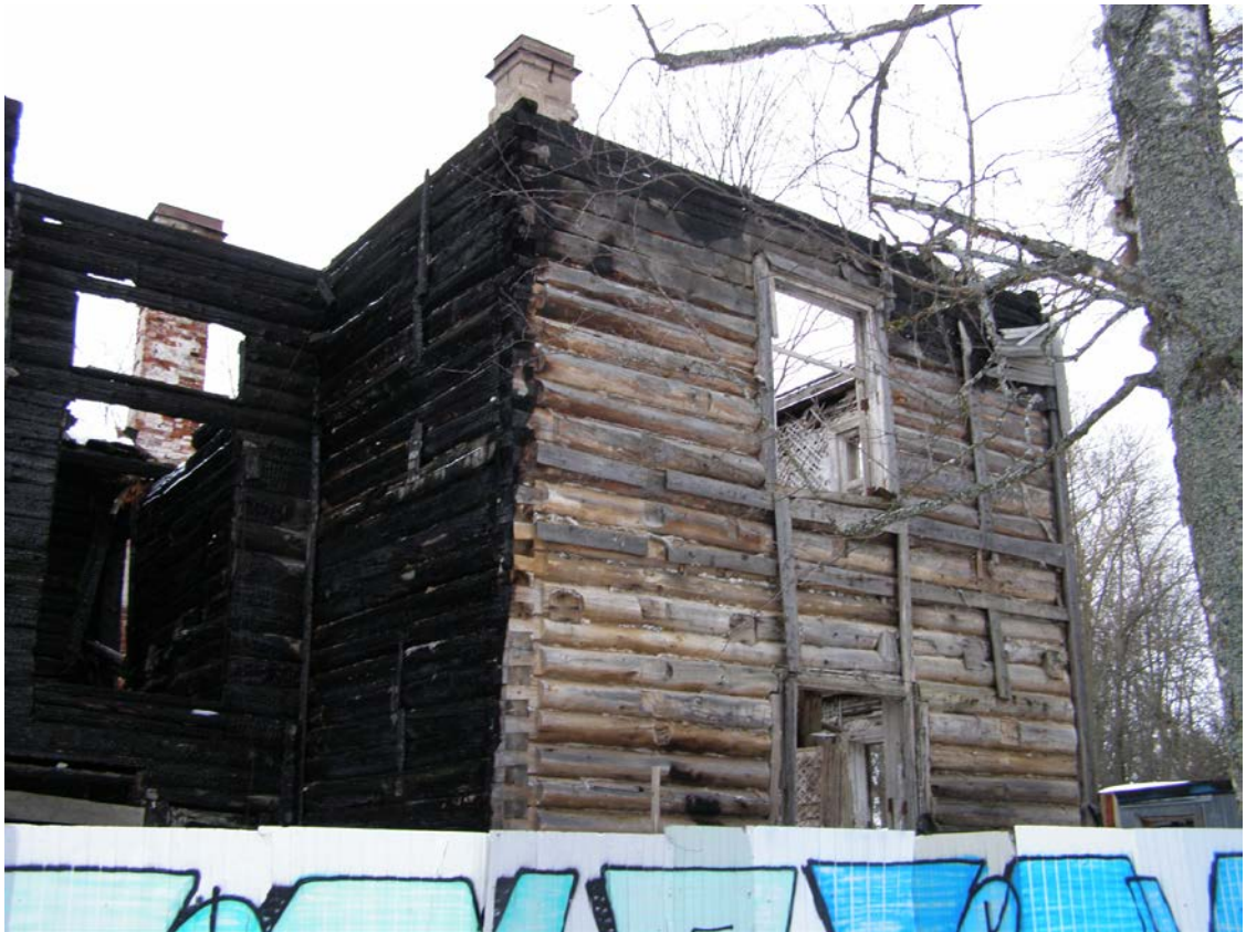
15. Объект культурного наследия регионального значения «Усадьба Ю.И. Жерар-де-Суконтон (главный дом с территорией)», (Санкт-Петербург, г. Петергоф, Собственный пр., д. 4, литера А.). Главный дом, фрагмент южного фасада.
