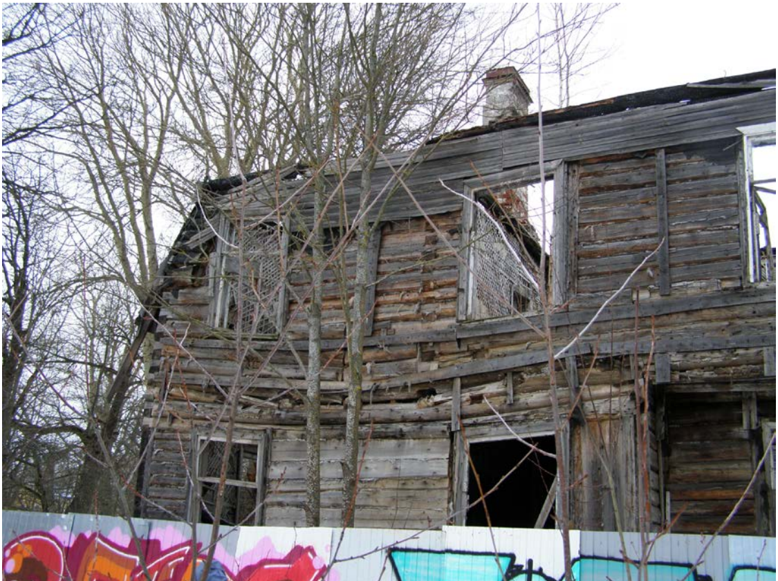
17. Объект культурного наследия регионального значения «Усадьба Ю.И. Жерар-де-Суконтон (главный дом с территорией)», (Санкт-Петербург, г. Петергоф, Собственный пр., д. 4, литера А.). Главный дом, фрагмент южного фасада.
