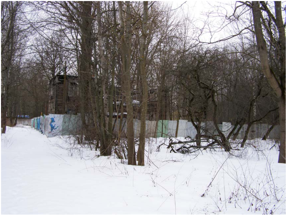
5. Объект культурного наследия регионального значения «Усадьба Ю.И. Жерар-де-Суконтон (главный дом с территорией)», (Санкт-Петербург, г. Петергоф, Собственный пр., д. 4, литера А.). Вид территории объекта.
