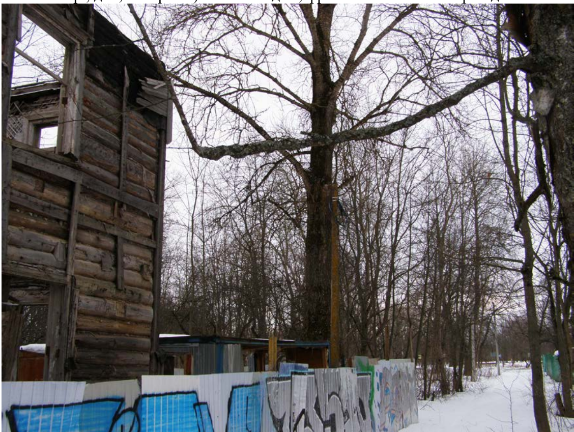
14. Объект культурного наследия регионального значения «Усадьба Ю.И. Жерар-де-Суконтон (главный дом с территорией)», (Санкт-Петербург, г. Петергоф, Собственный пр., д. 4, литера А.). Главный дом, фрагмент южного фасада.
