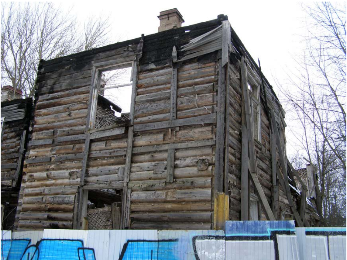
12. Объект культурного наследия регионального значения «Усадьба Ю.И. Жерар-де-Суконтон (главный дом с территорией)», (Санкт-Петербург, г. Петергоф, Собственный пр., д. 4, литера А.). Главный дом, фрагмент южного фасада.
