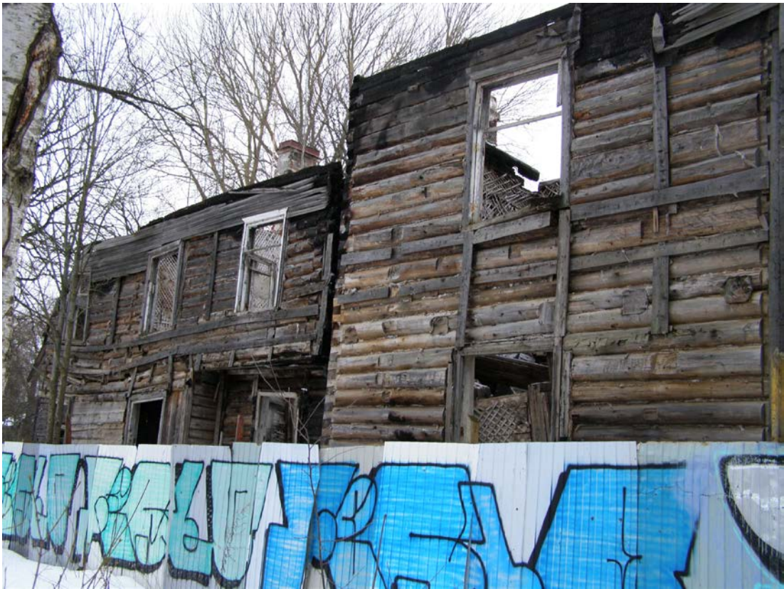
11. Объект культурного наследия регионального значения «Усадьба Ю.И. Жерар-де-Суконтон (главный дом с территорией)», (Санкт-Петербург, г. Петергоф, Собственный пр., д. 4, литера А.). Главный дом, южный фасад.
