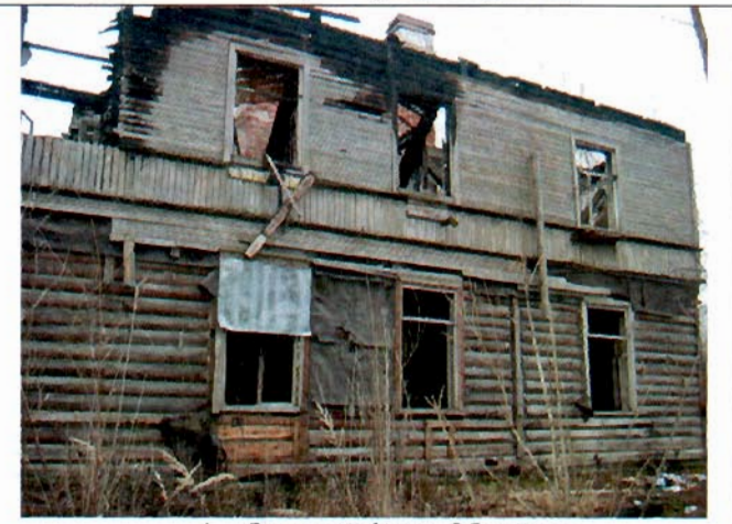
4. Западный фасад. Общий вид.
