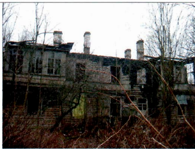
2. Северный фасад. Общий вид.
