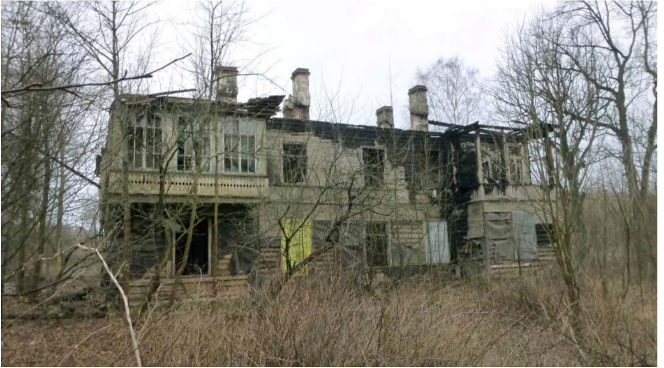
21. 2012 г. Дом №4 по Собственному пр. Вид северного фасада. Фото после пожара.
