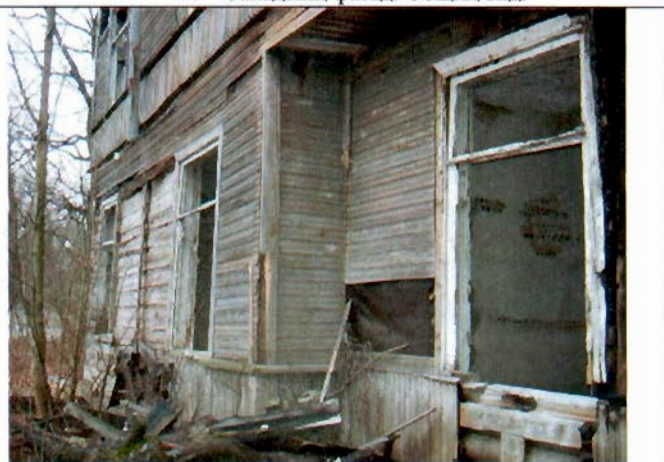
6. Южный фасад. Фрагмент.
