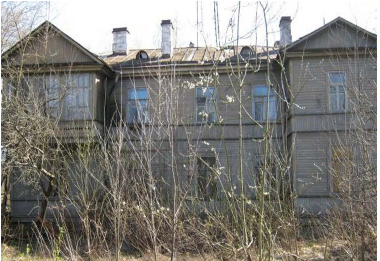
19. 2010 г. Дом №4 по Собственному проспекту. Северный фасад. Фото до пожара.
