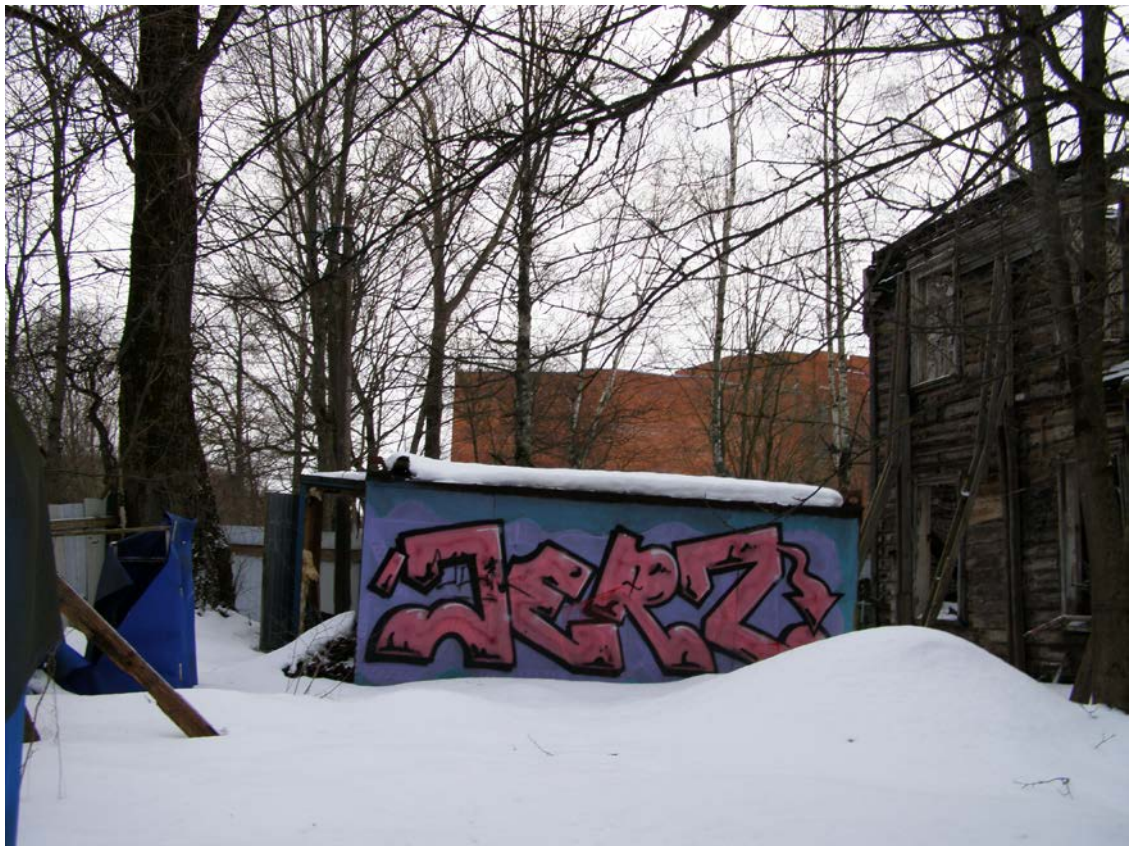
30. Объект культурного наследия регионального значения «Усадьба Ю.И. Жерар-де-Суконтон (главный дом с территорией)», (Санкт-Петербург, г. Петергоф, Собственный пр., д. 4, литера А.). Главный дом, фрагмент восточного фасада.
