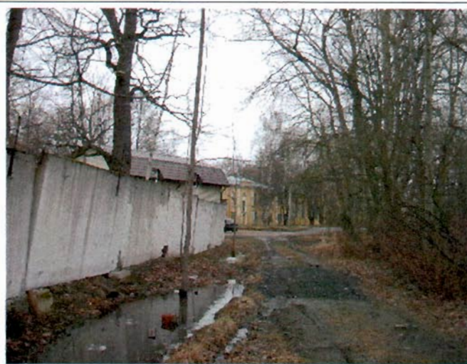
14. Ограждение территории в северо-западной части.
