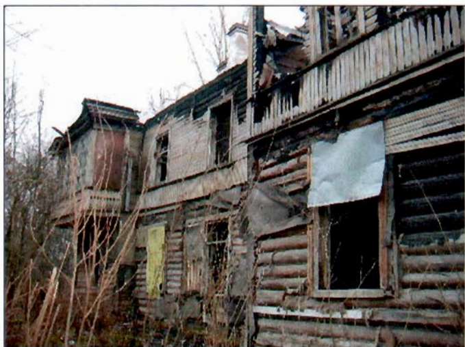
1. Северный фасад. Общий вид.
