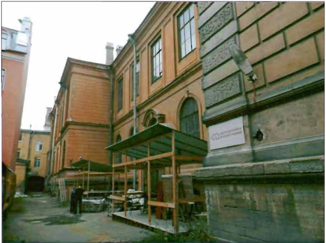
6. Южный дворовый фасад. Общий вид.
