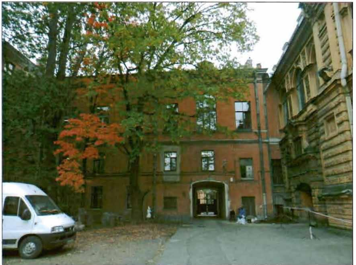
31. Восточный дворовый фасад. Общий вид.
