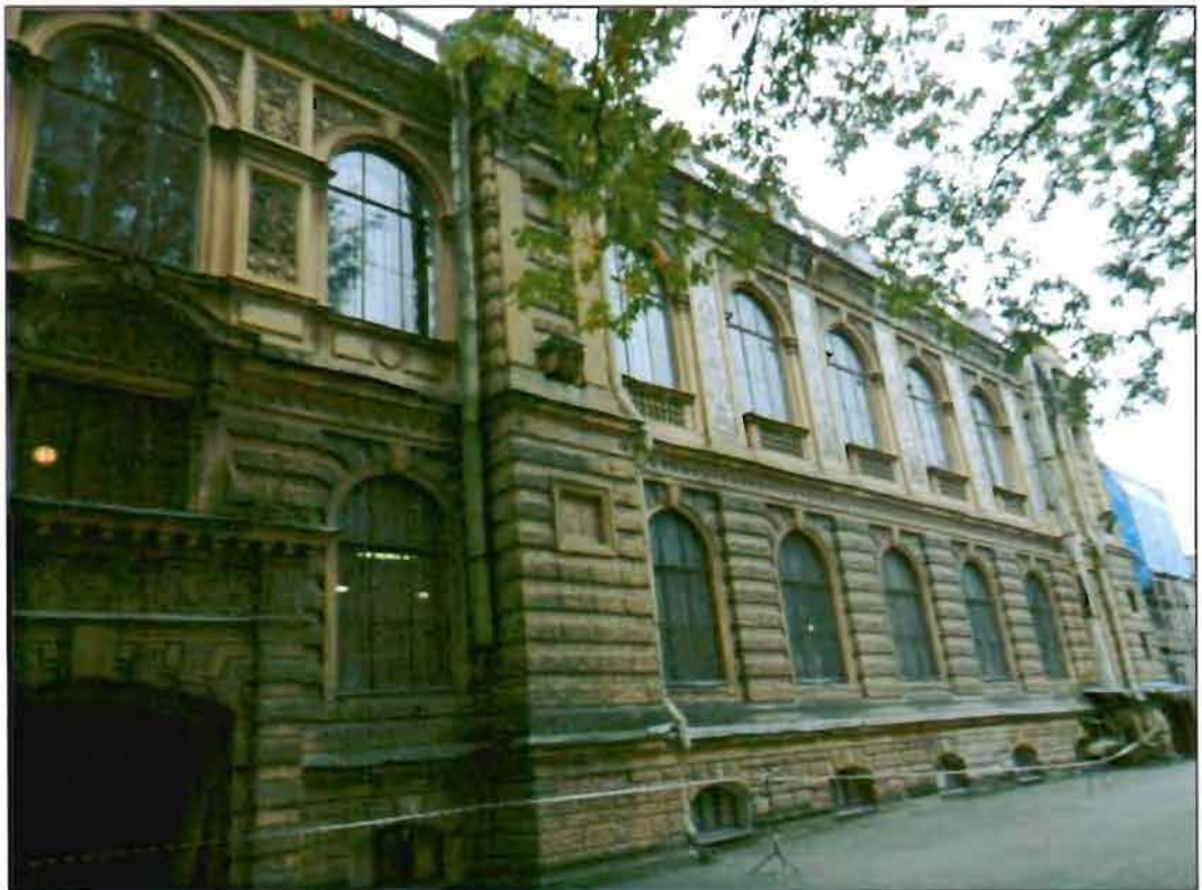
7. Северный дворовый фасад. Общий вид.
