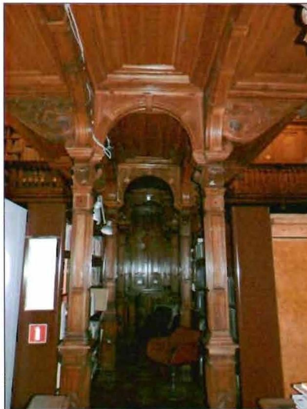
39. Помещение № 1-Н (271). Деревянные колонны.
