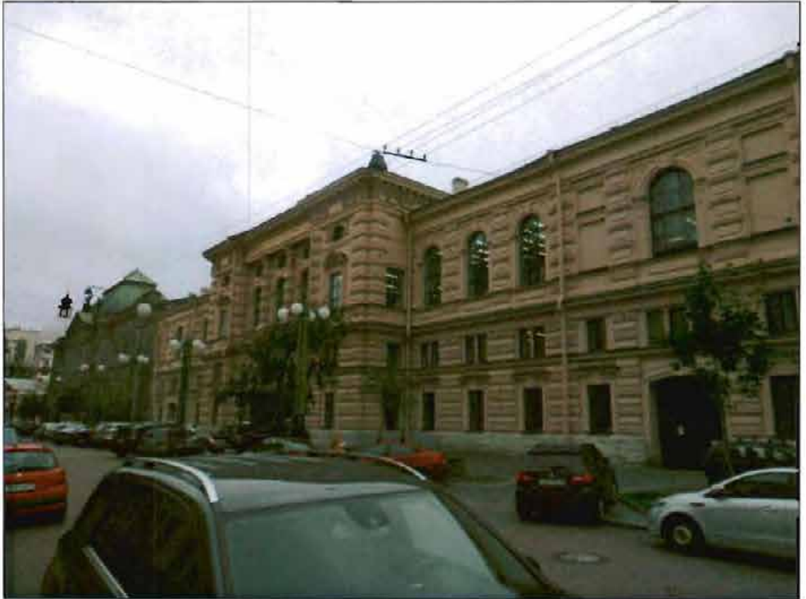
28. Лицевой фасад. Общий вид.
