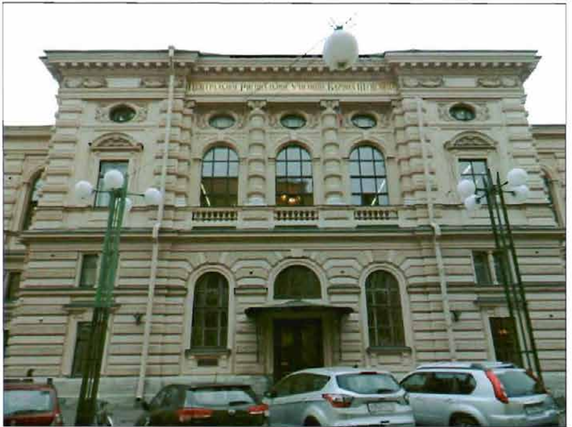
29. Лицевой фасад. Центральный ризалит.
