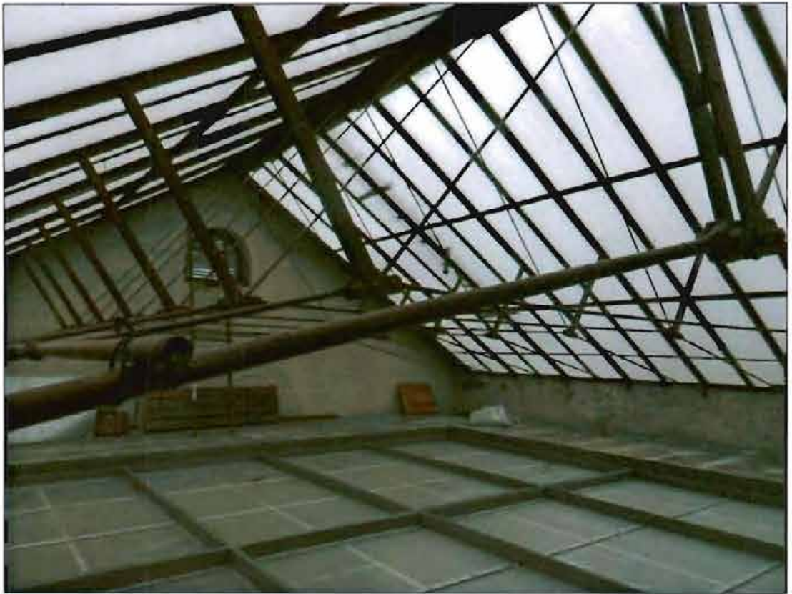
36. Металлические фермы над световым фонарем парадной лестницы.
