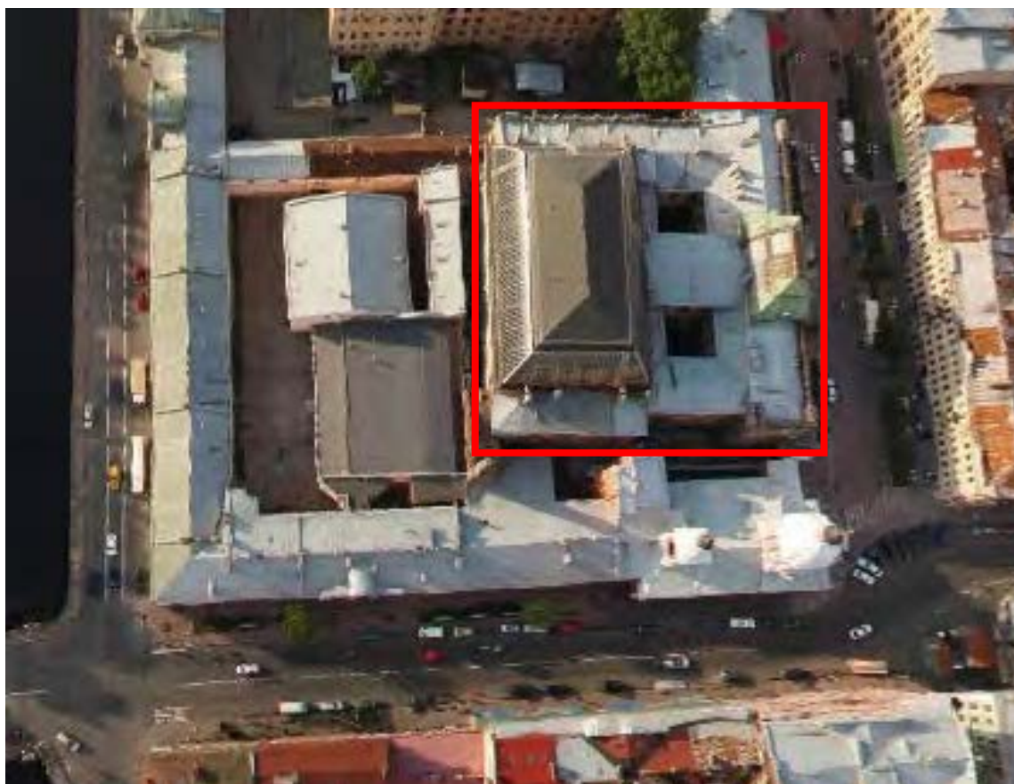
Фото 1. Объект культурного наследия федерального значения "Центральное училище технического рисования и музей Штиглица А.Л" по адресу: Санкт-Петербург, Соляной пер., д. 13-15, лит. А. Кровля и медный купол здания Музея
