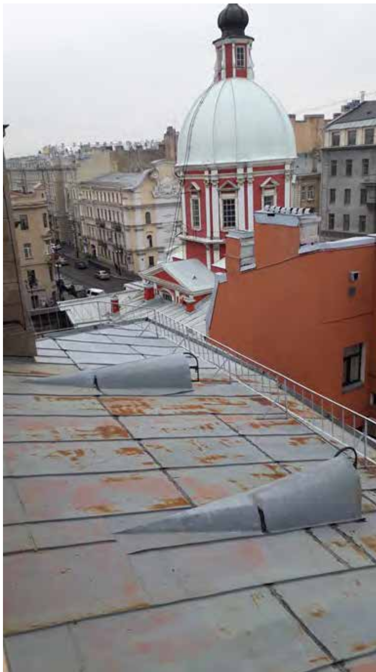
Фото 12. Объект культурного наследия федерального значения "Центральное училище технического рисования и музей Штиглица А.Л" по адресу: Санкт-Петербург, Соляной пер., д. 13-15, лит. А. Кровля и медный купол здания Музея
