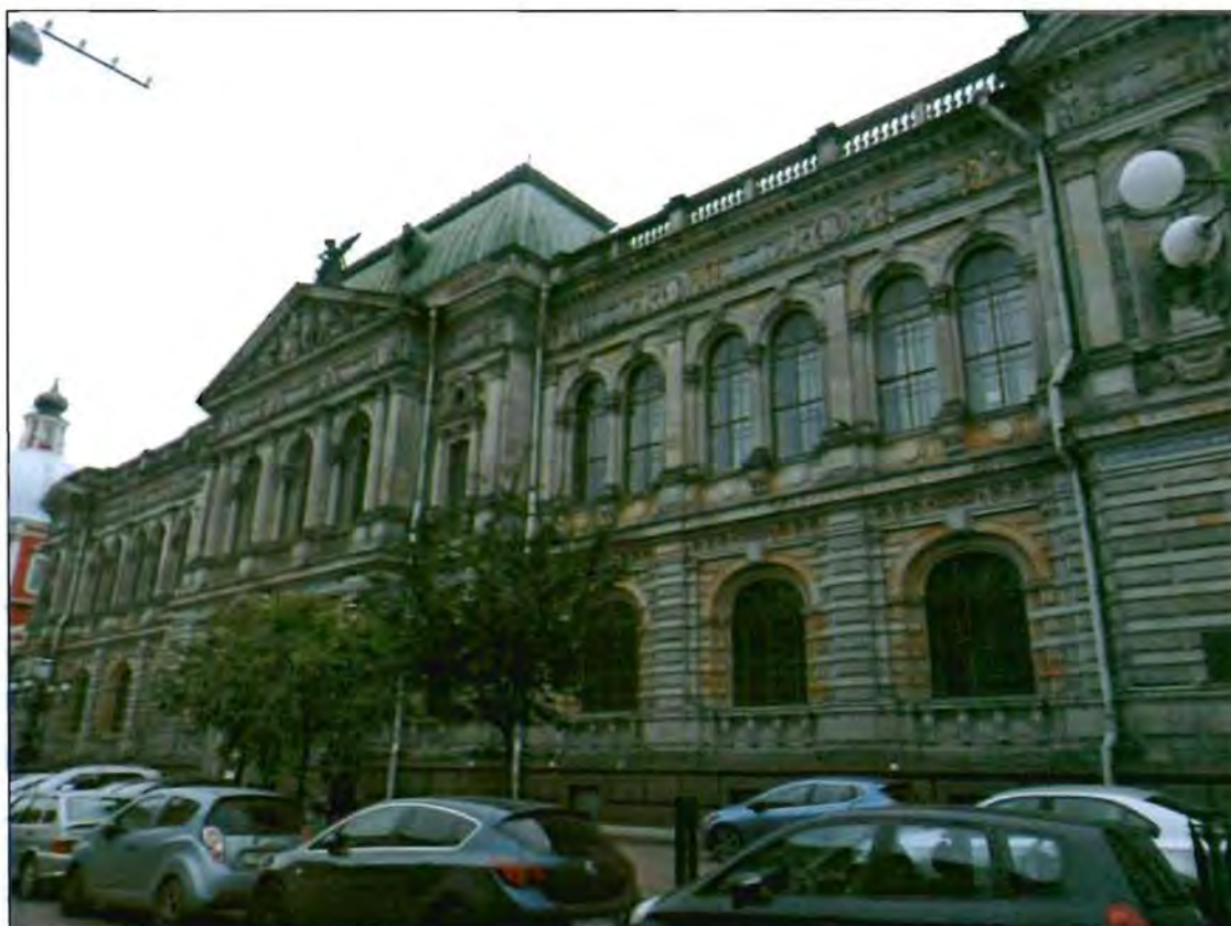
1. Общий вид с северо-востока.
