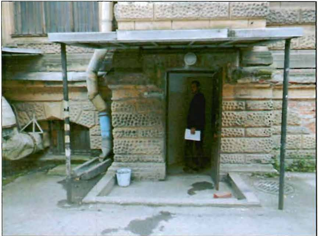
9. Северный дворовый фасад. Фрагмент.
