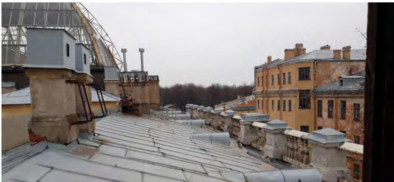
Фото 9. Объект культурного наследия федерального значения "Центральное училище технического рисования и музей Штиглица А.Л" по адресу: Санкт-Петербург, Соляной пер., д. 13-15, лит. А. Кровля и медный купол здания Музея
