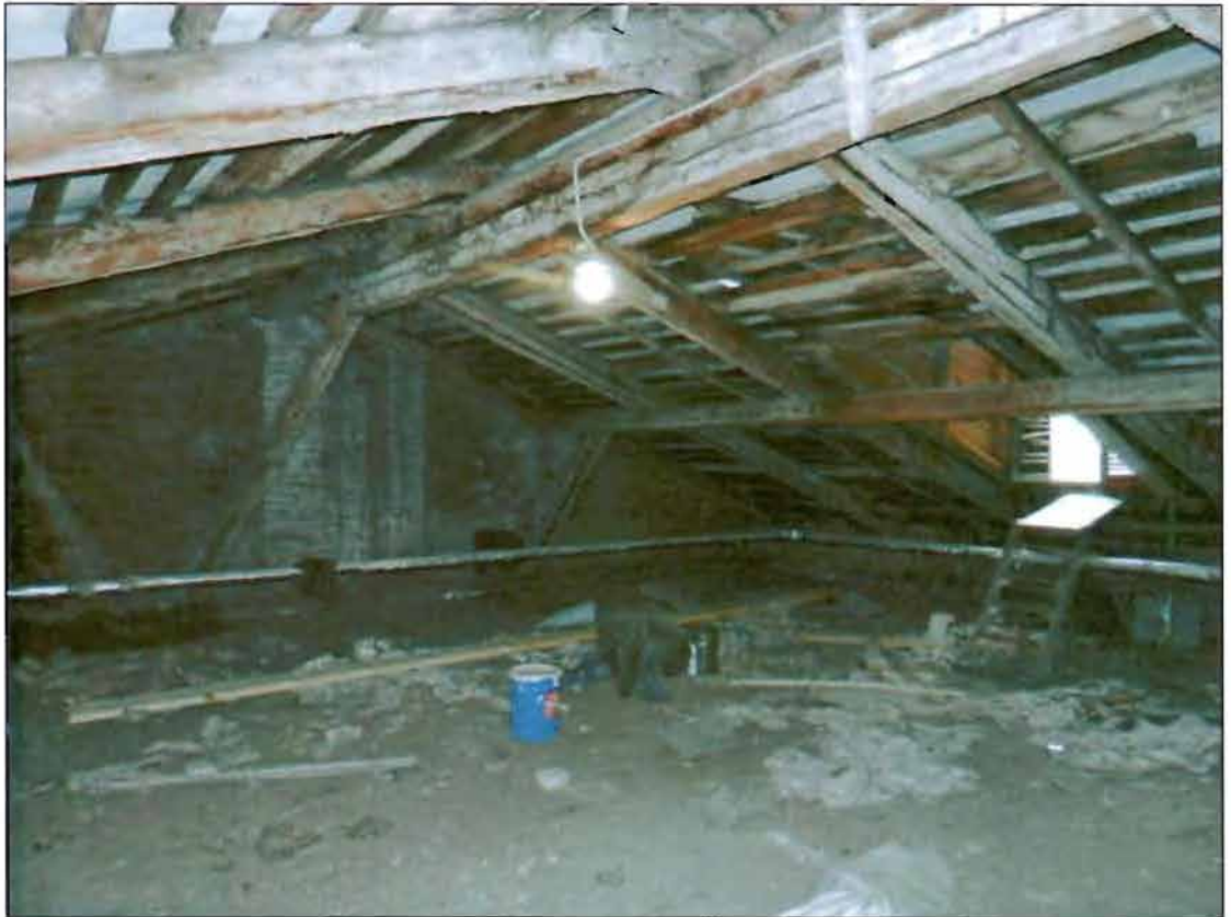
35. Стропильная система. Общий вид.
