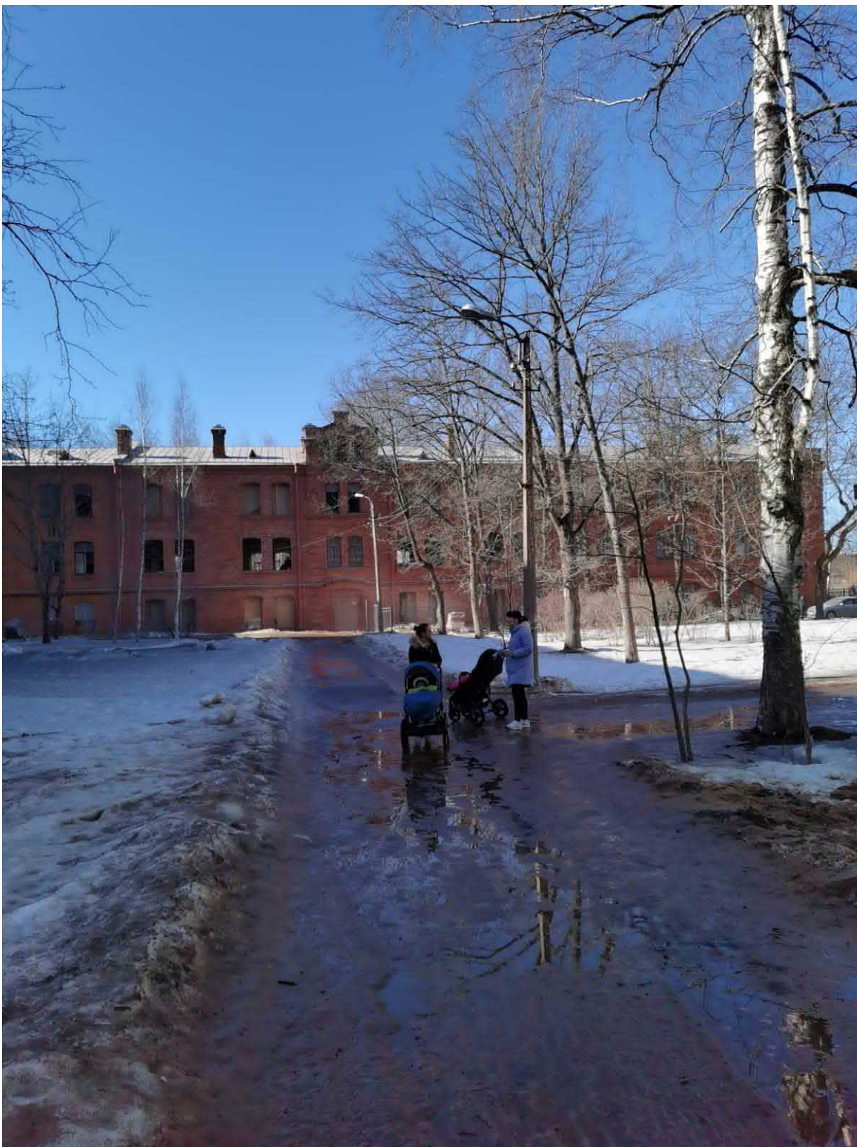
Фото 16. Здание ОКН по адресу по ул. Юты Бондаровской д.21. Юго-восточный фасад
