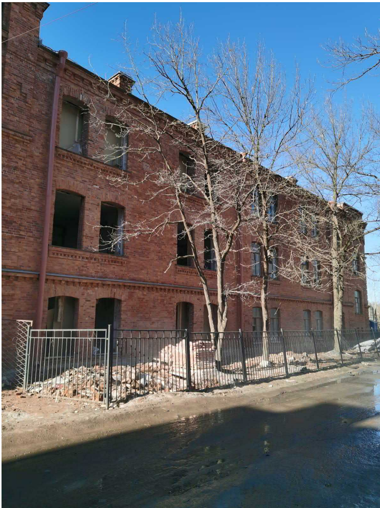
Фото 18. Здание ОКН по адресу по ул. Юты Бондаровской д.21. Юго-восточный фасад
