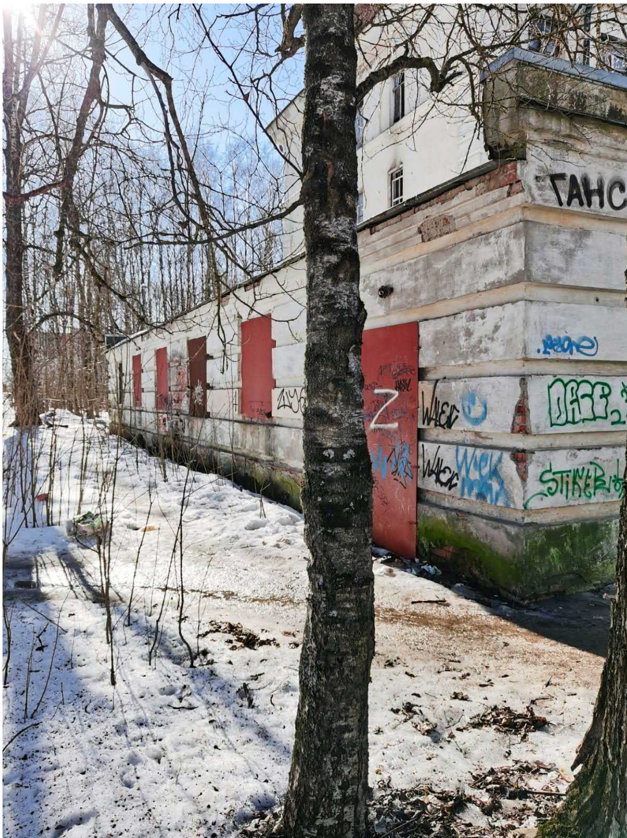
Фото 7. Здание по адресу по ул. Юты Бондаровской д.13, к.1, пристройка. Юго-восточный фасад
