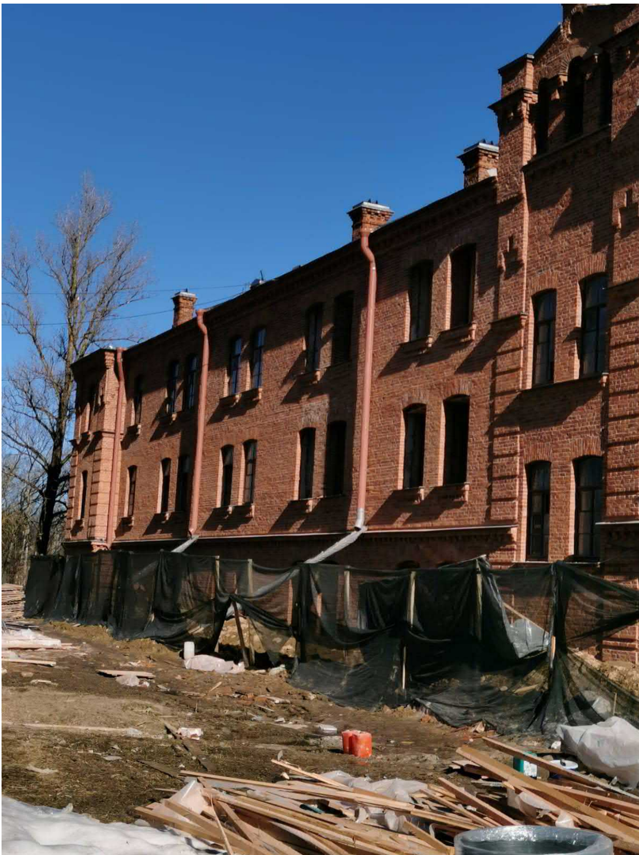
Фото 20. Здание ОКН по адресу по ул. Юты Бондаровской д.21. Северо-западный фасад
