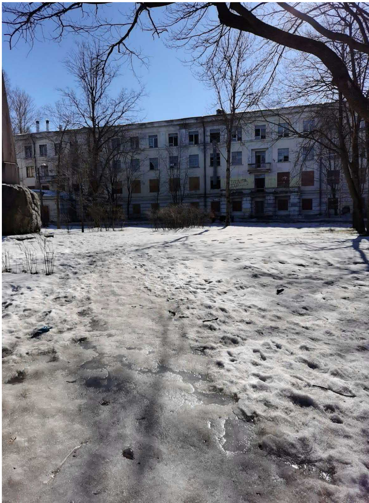
Фото 1. Здание по адресу ул. Юты Бондаровской, д.13, к.1. Северный фасад
