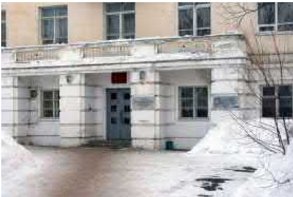
Фото 23. Главный вход в здание. 2016г. www.urban3p.ru
