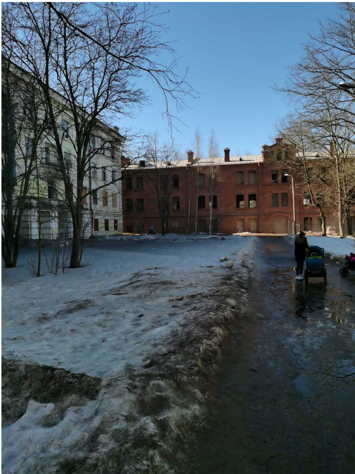
Фото 2. Здание по адресу по ул. Юты Бондаровской д.13, к.1. Северный фасад
