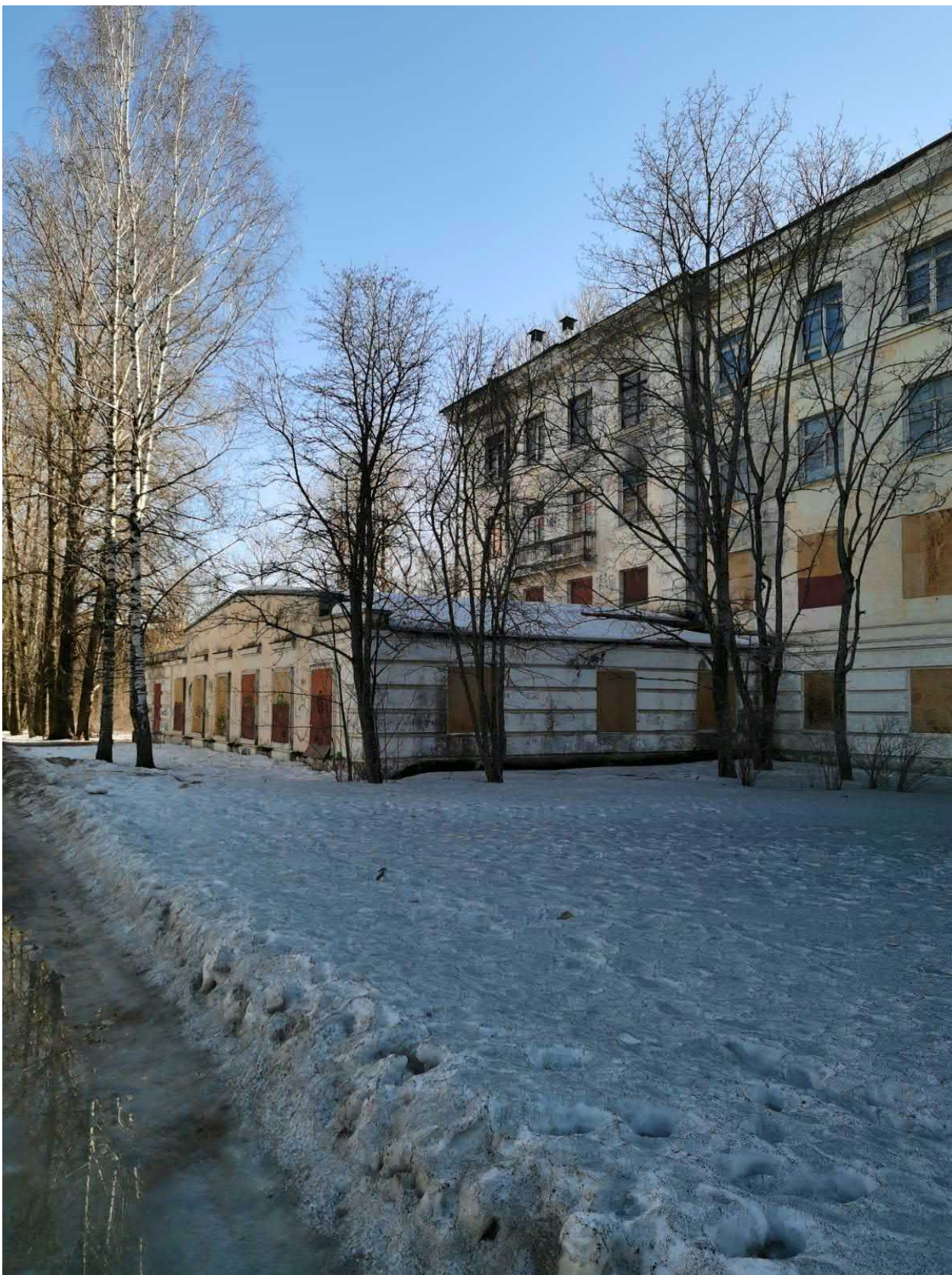
Фото 6. Здание по адресу по ул. Юты Бондаровской д.13, к.1, пристройка. Северный фасад
