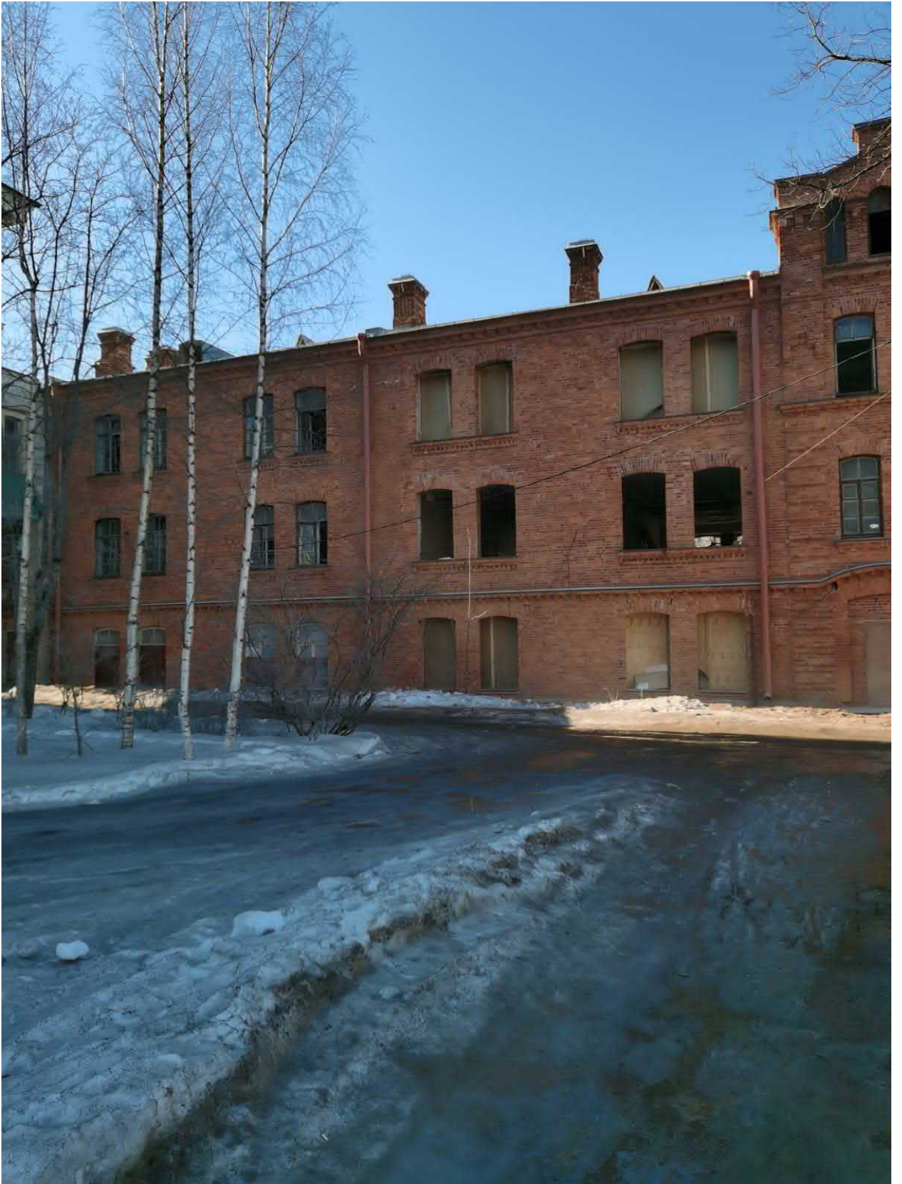
Фото 17. Здание ОКН по адресу по ул. Юты Бондаровской д.21. Юго-восточный фасад
