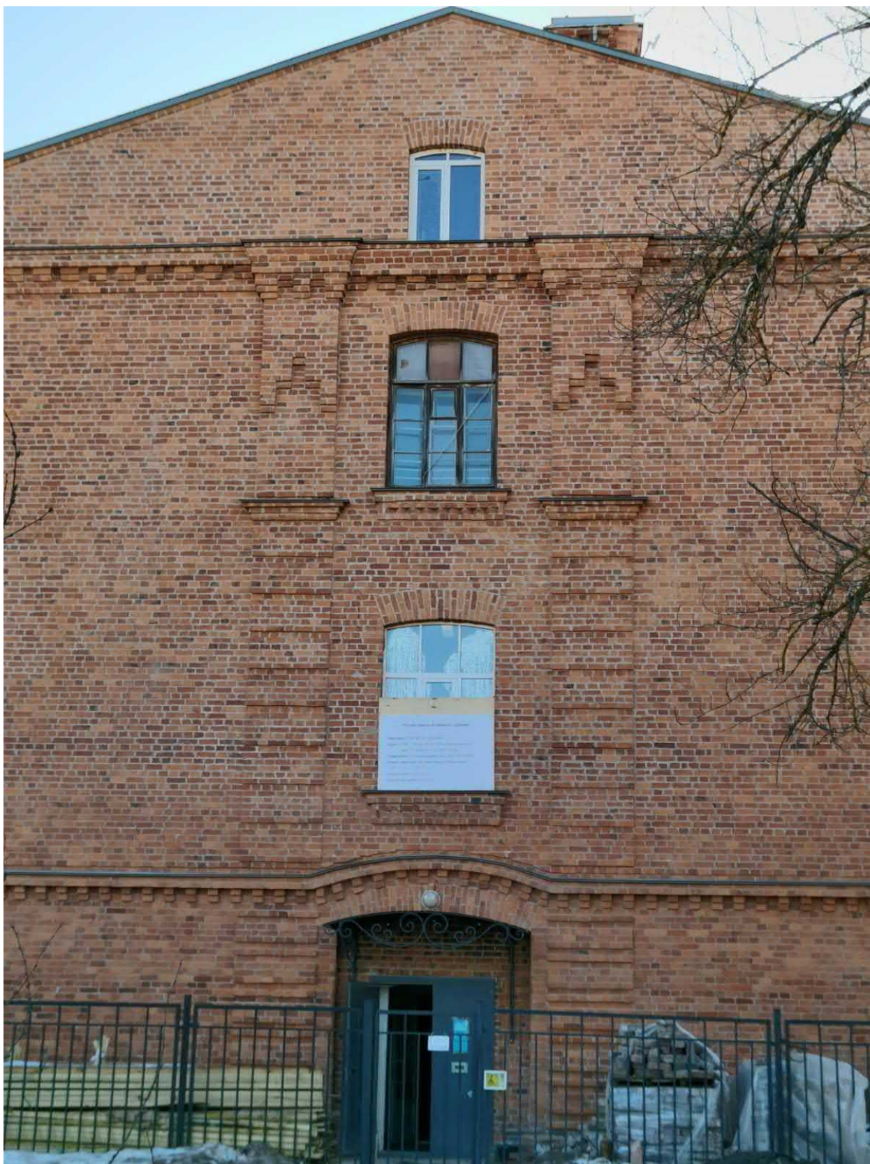
Фото 21. Здание ОКН по адресу по ул. Юты Бондаровской д.21. Южный фасад
