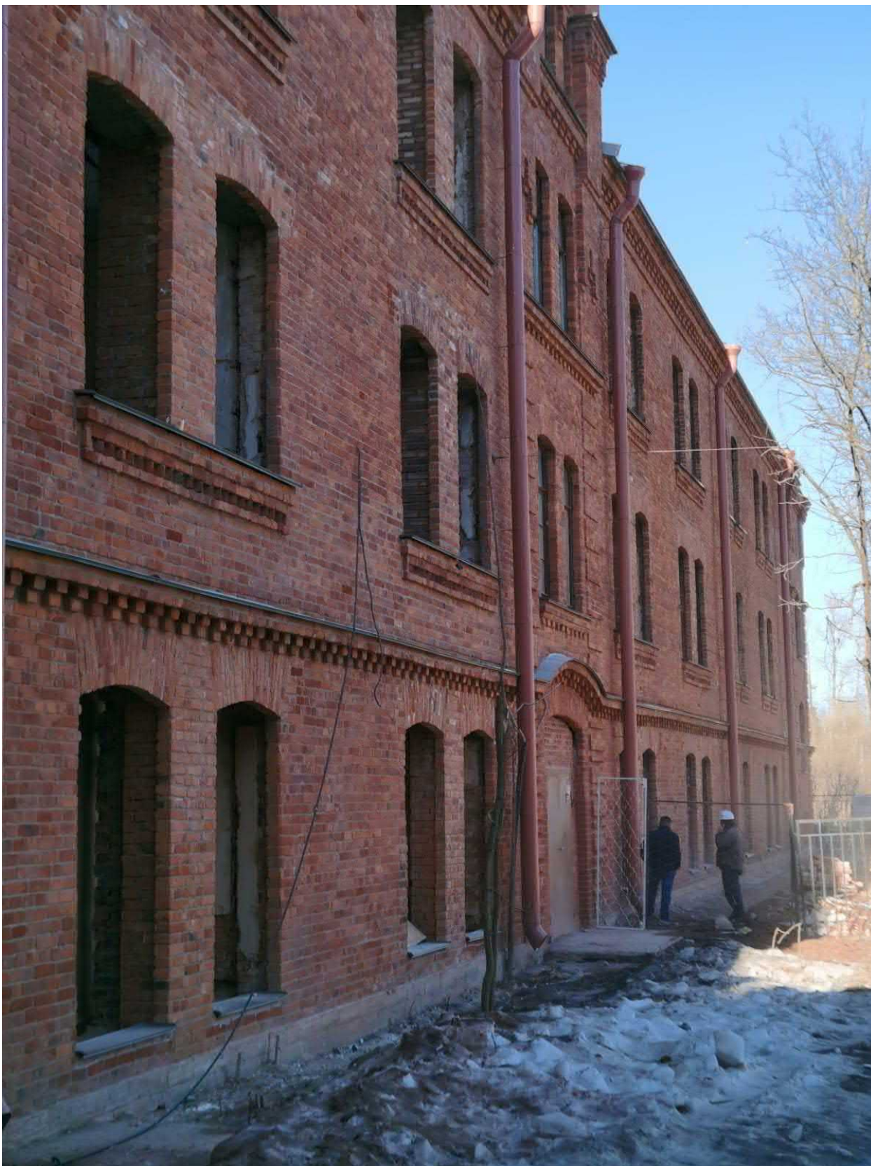
Фото 15. Здание ОКН по адресу по ул. Юты Бондаровской д.21. Юго-восточный фасад
