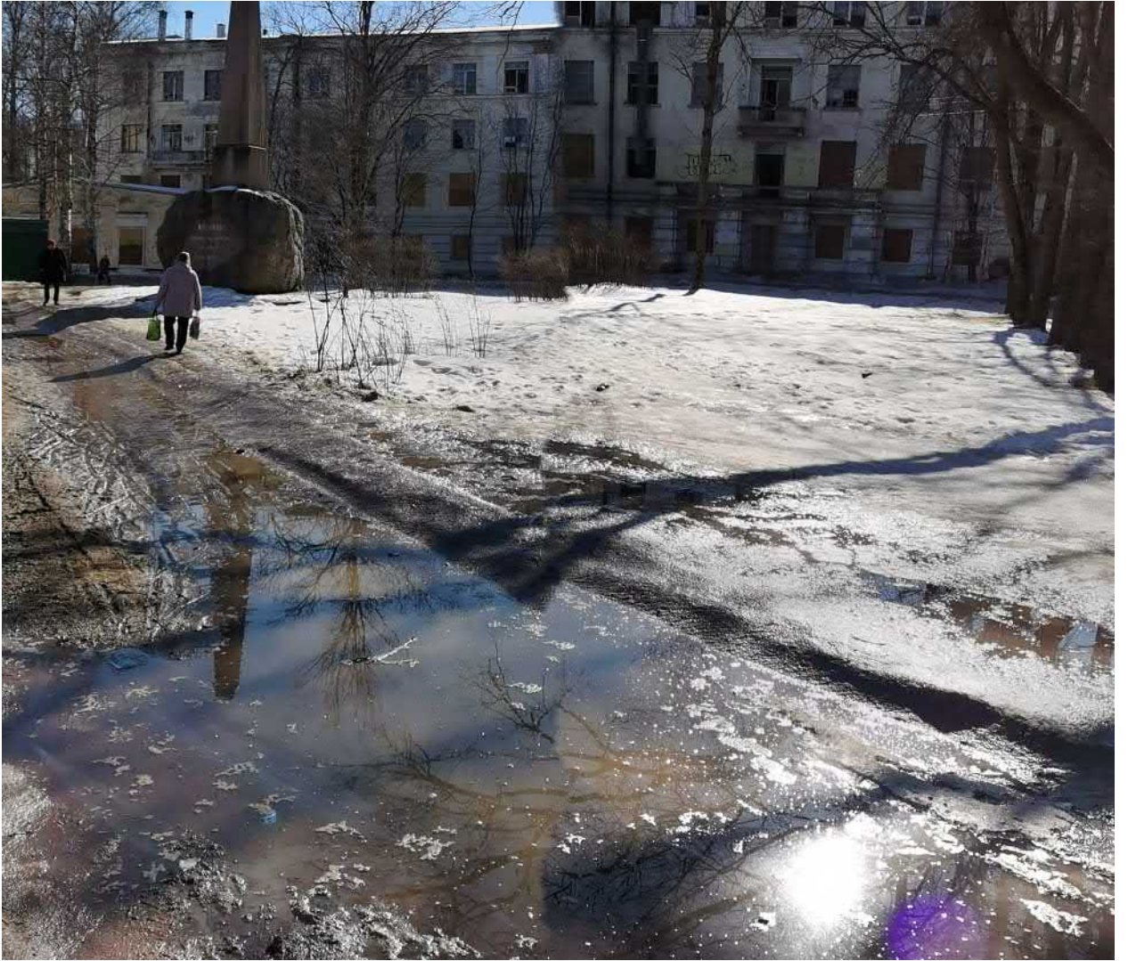
Фото 3. Здание по адресу по ул. Юты Бондаровской д.13, к.1. Северный фасад
