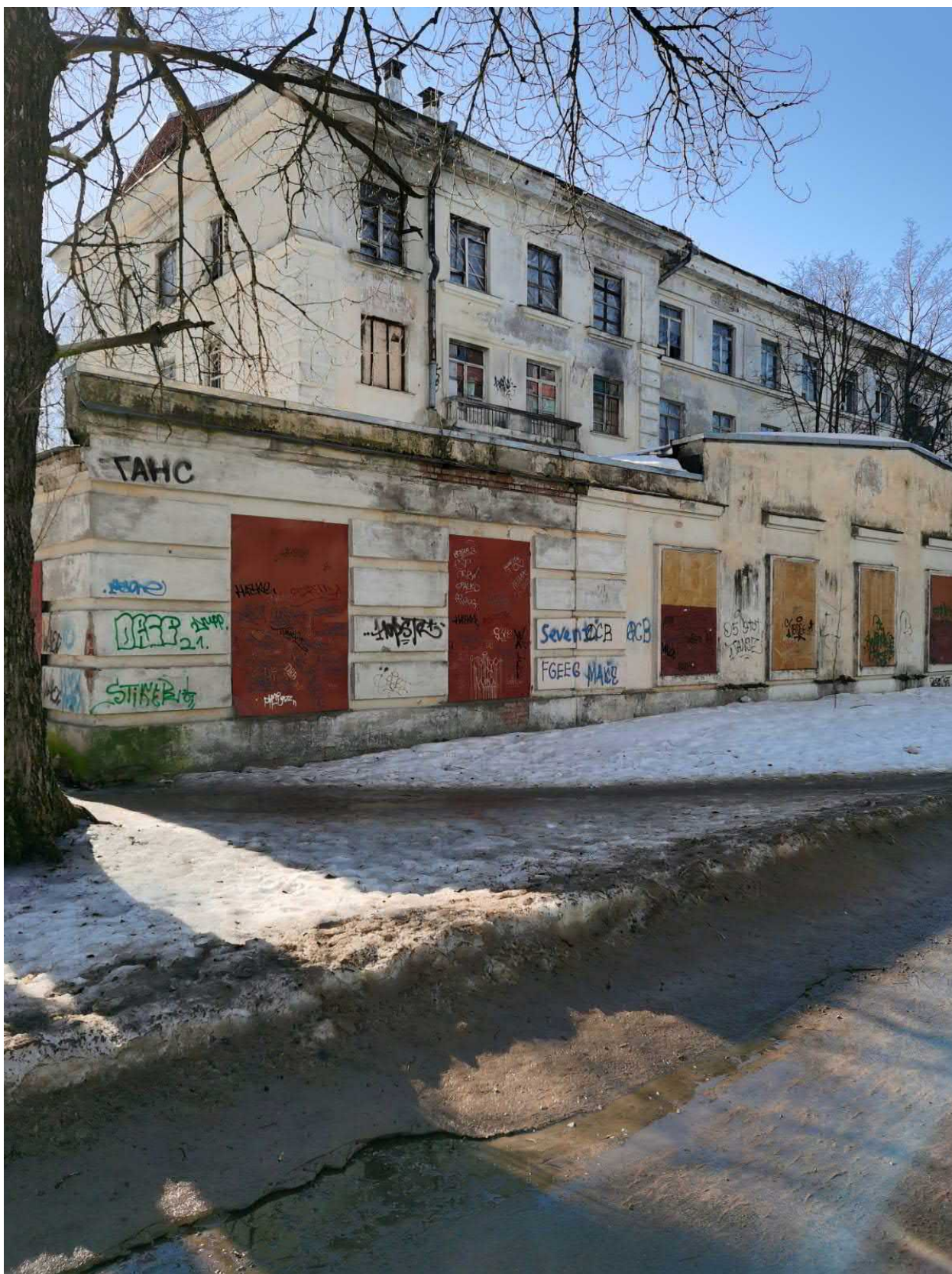
Фото 5. Здание по адресу по ул. Юты Бондаровской д.13, к.1, пристройка. Северный фасад
