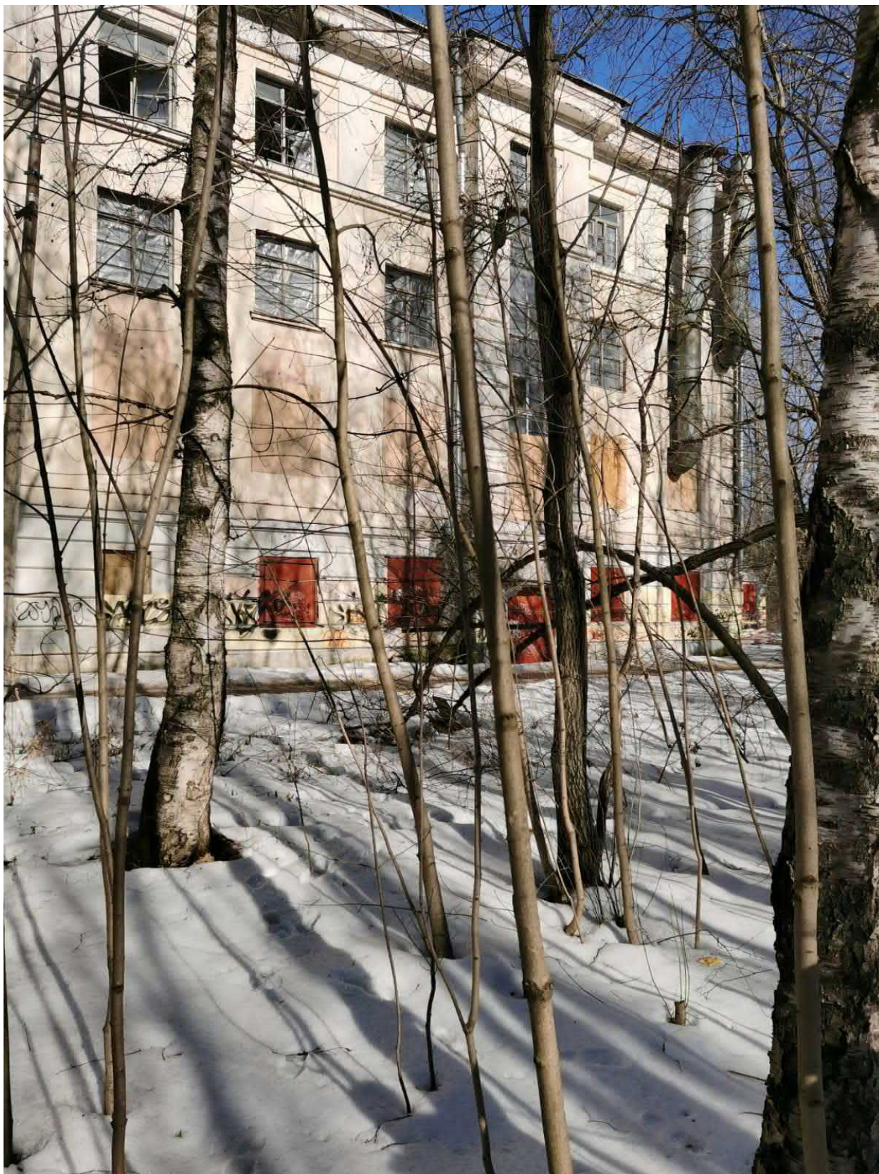
Фото 9. Здание по адресу по ул. Юты Бондаровской д.13, к.1. Южный фасад
