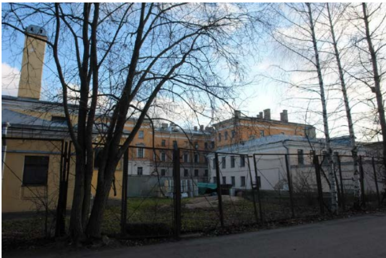
10. Дворовый фасады объекта культурного наследия регионального значения «Главное здание», расположенного по адресу: г. Санкт-Петербург, наб. Обводного канала, д. 7, лит. Г, входящего в состав объекта культурного наследия регионального значения «Духовная академия». 23.11.2020.
