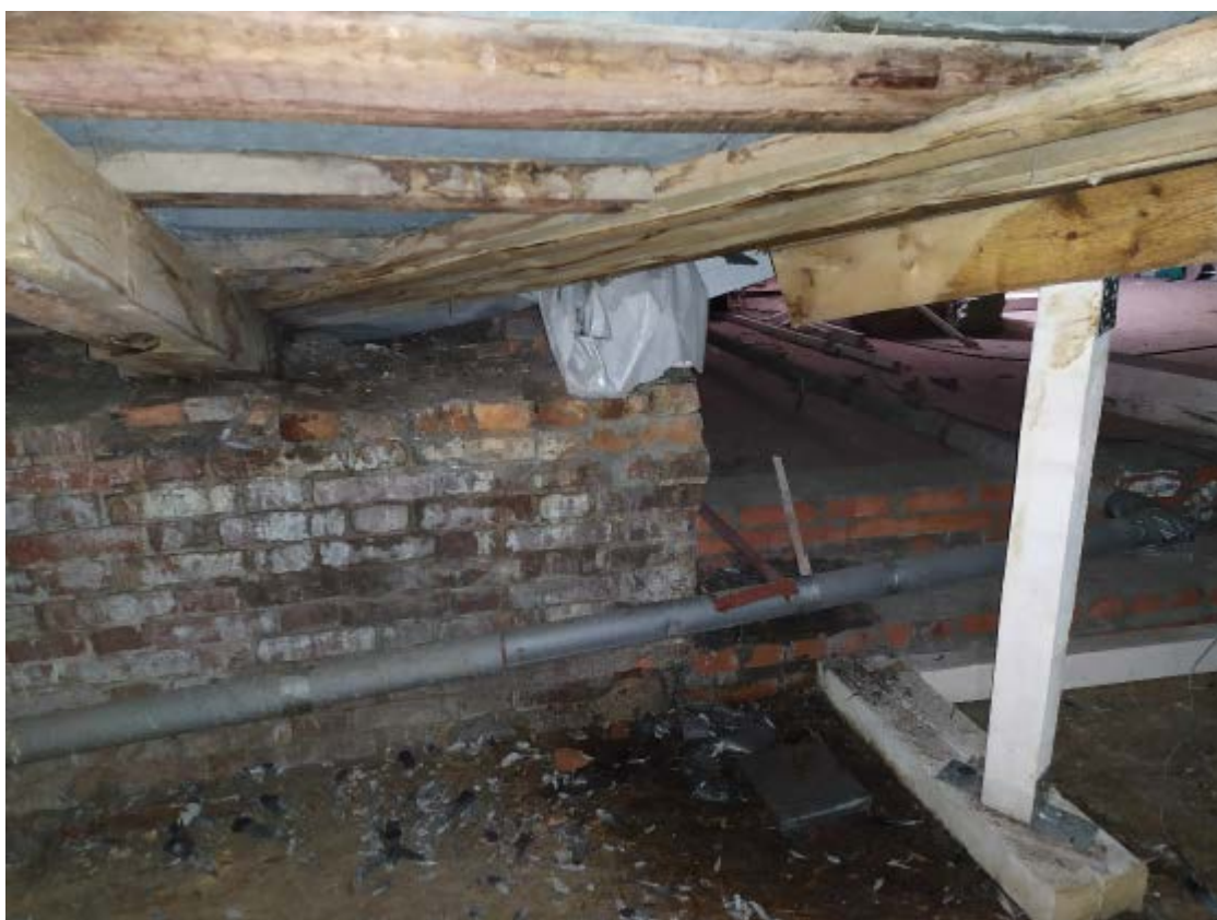
11. Стропильная система крыши объекта культурного наследия регионального значения «Главное здание», расположенного по адресу: г. Санкт-Петербург, наб. Обводного канала, д. 7, лит. Г, входящего в состав объекта культурного наследия регионального значения «Духовная академия». 23.11.2020.
