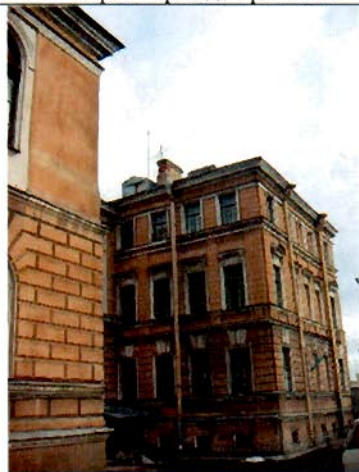
11. Западный фасад. Фрагмент.
