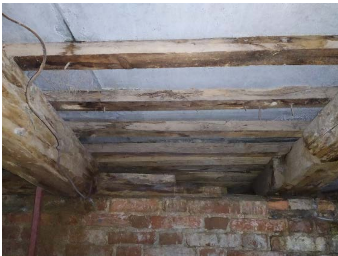
13. Стропильная система с утраченным мауэрлатом крыши объекта культурного наследия регионального значения «Главное здание», расположенного по адресу: г. Санкт-Петербург, наб. Обводного канала, д. 7, лит. Г, входящего в состав объекта культурного наследия регионального значения «Духовная академия». 23.11.2020.
