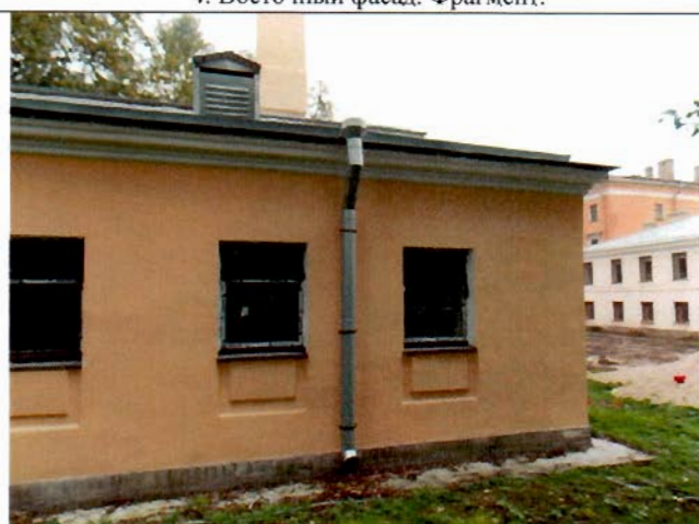
6. Западный фасад. Фрагмент.
