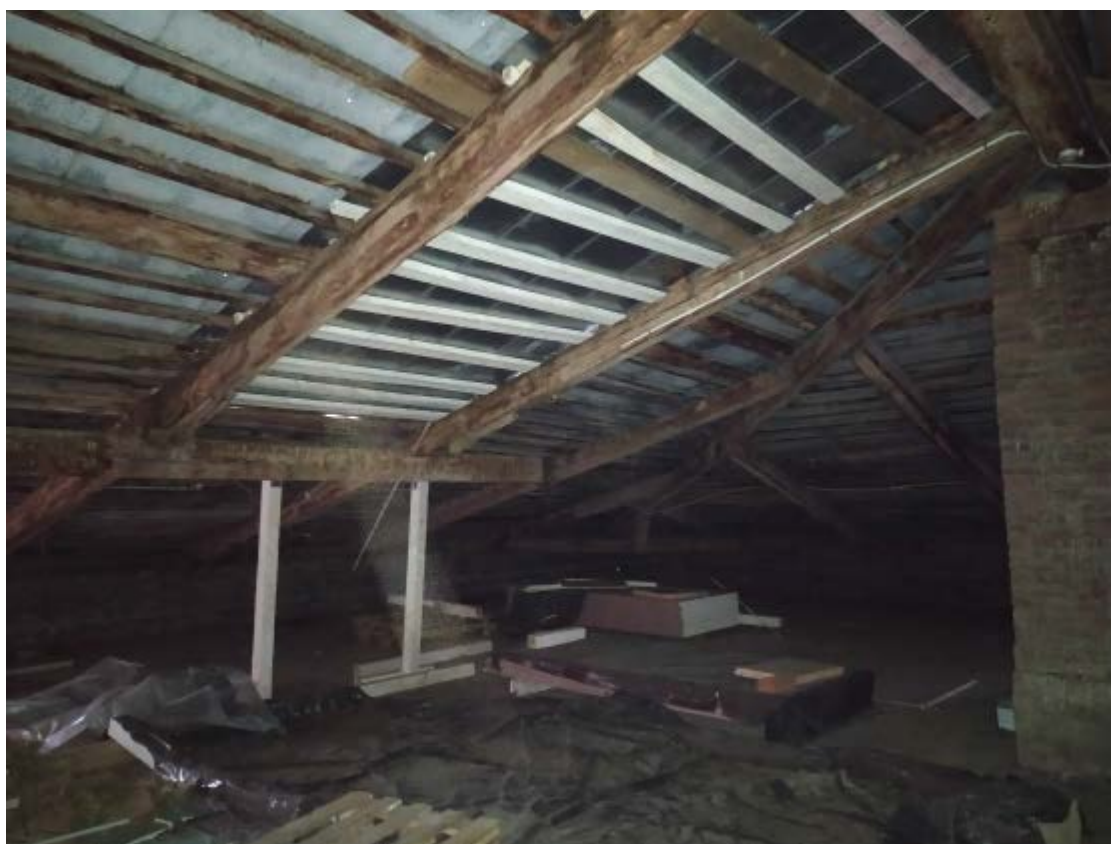
17. Стропильная система крыши объекта культурного наследия регионального значения «Главное здание», расположенного по адресу: г. Санкт-Петербург, наб. Обводного канала, д. 7, лит. Г, входящего в состав объекта культурного наследия регионального значения «Духовная академия». 23.11.2020.
