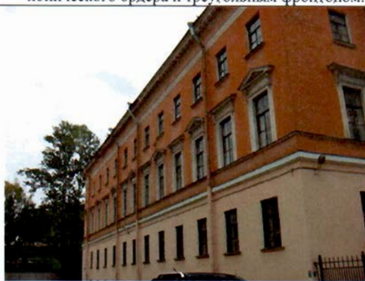
6. Северный фасад. Общий вид.
