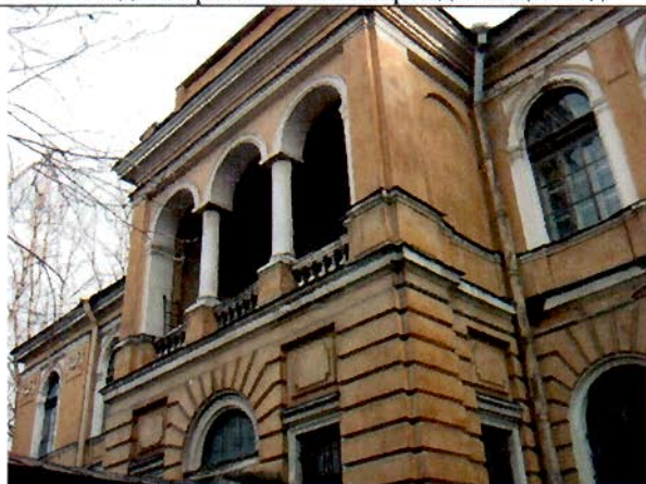
9. Северный фасад. Фрагмент.
