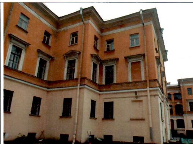
12. Дворовые фасады северного флигеля.
