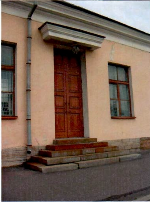
7. Дверное заполнение. Южный фасад.
