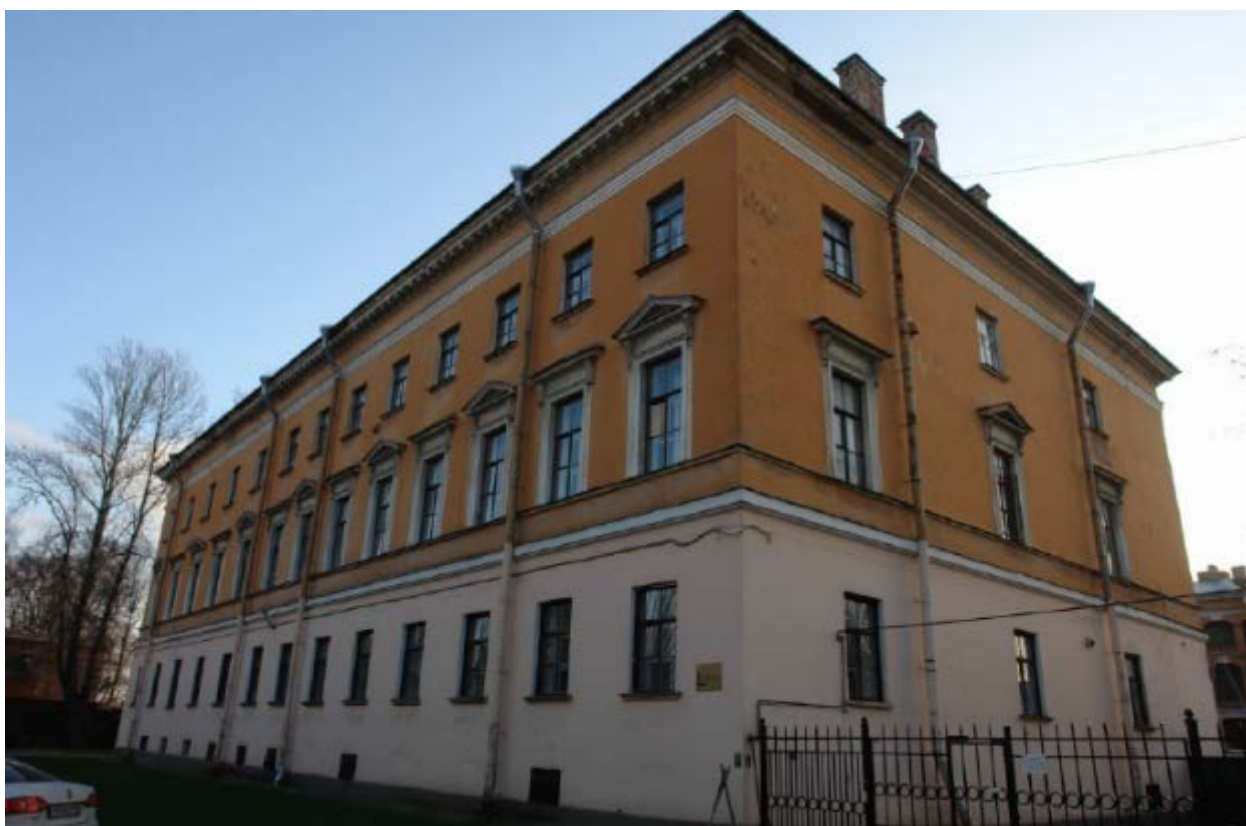
7. Западный фасад объекта культурного наследия регионального значения «Главное здание», расположенного по адресу: г. Санкт-Петербург, наб. Обводного канала, д. 7, лит. Г, входящего в состав объекта культурного наследия регионального значения «Духовная академия». 23.11.2020.
