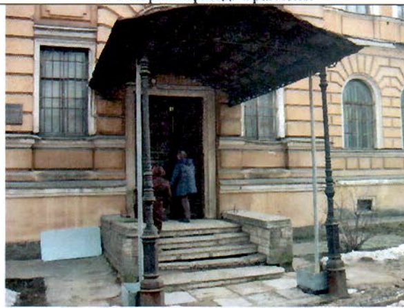
10. Входная группа северного фасада. Общий вид.
