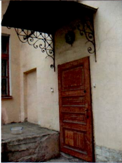
3. Дверной проем восточного фасада.
