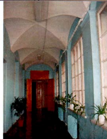
27. Коридор в уровне 2-го этажа. Общий вид.
