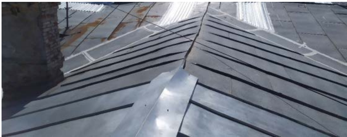
28. Кровля в осях 9-12/А-К объекта культурного наследия регионального значения «Главное здание», расположенного по адресу: г. Санкт-Петербург, наб. Обводного канала, д. 7, лит. Г, входящего в состав объекта культурного наследия регионального значения «Духовная академия». 23.11.2020.
