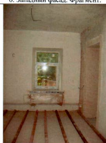
8. Помещение 1-го этажа. Общий вид.
