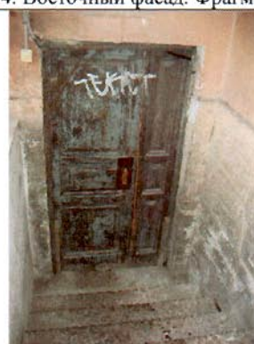
6. Входной проем восточного фасада. Общий вид.
