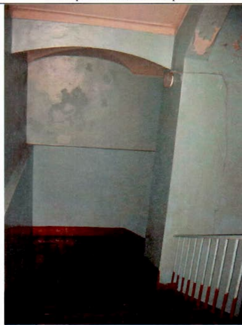
39. Лестница в южном крыле. Фрагмент.
