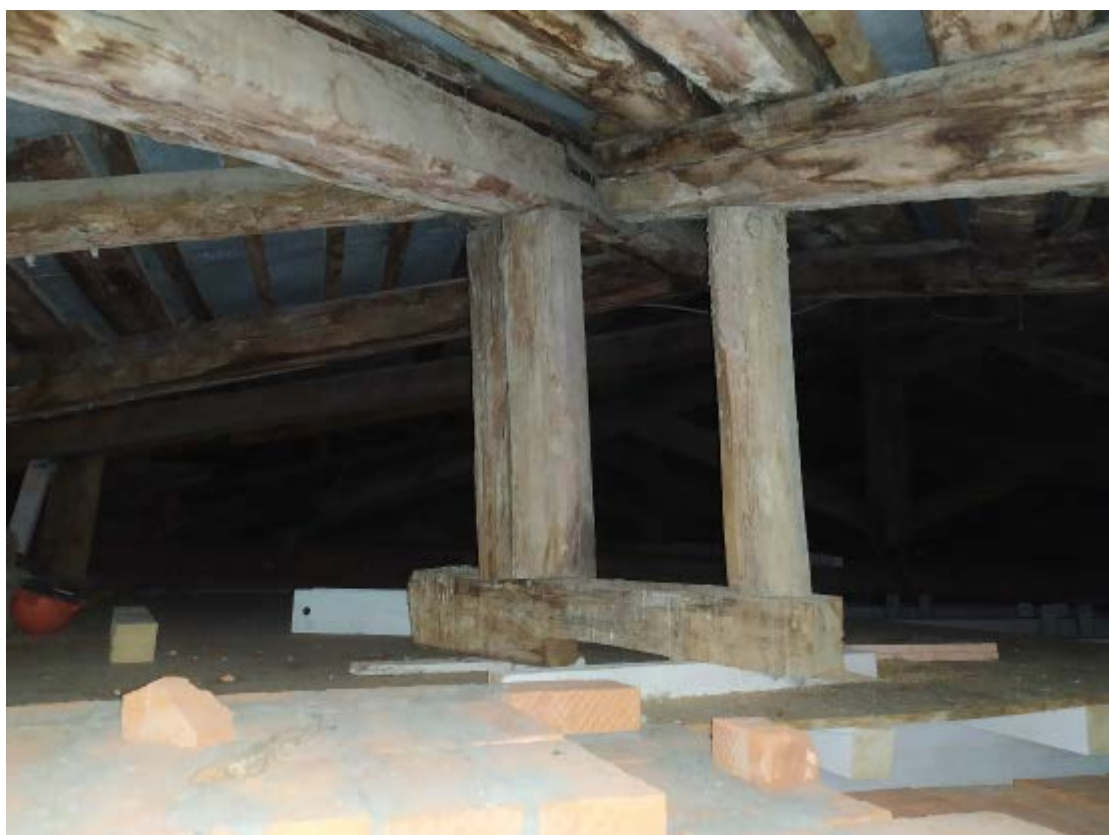
14. Стропильная система крыши объекта культурного наследия регионального значения «Главное здание», расположенного по адресу: г. Санкт-Петербург, наб. Обводного канала, д. 7, лит. Г, входящего в состав объекта культурного наследия регионального значения «Духовная академия». 23.11.2020.
