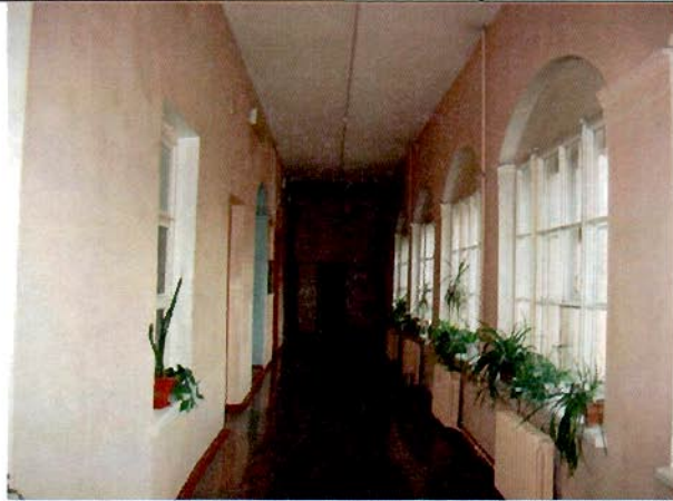
26. Коридор в уровне 3-го этажа. Общий вид.
