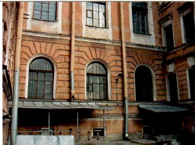
12. Западный фасад. Фрагмент.
