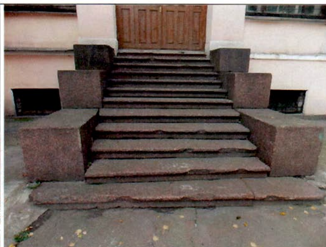
13. Дворовые фасады. Крыльца.
