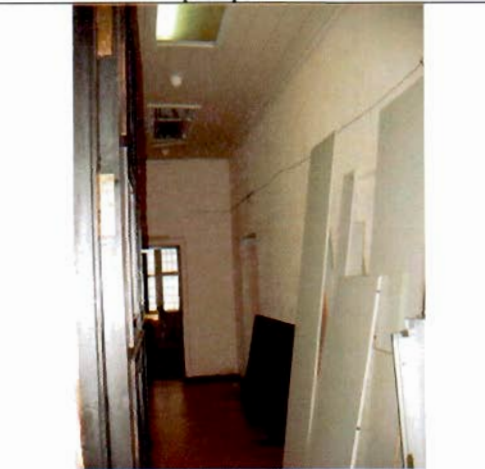
11. Коридор 1-го этажа. Общий вид.
