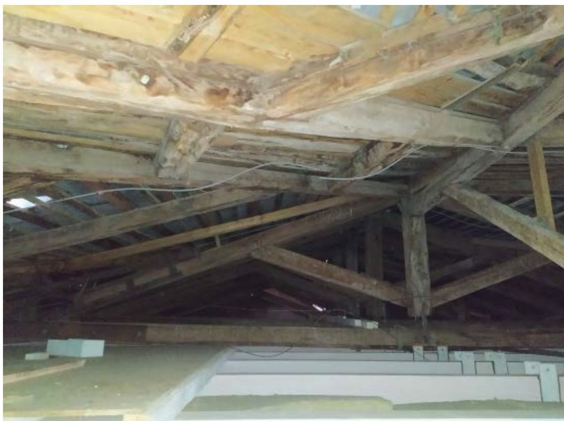
12. Стропильная система крыши объекта культурного наследия регионального значения «Главное здание», расположенного по адресу: г. Санкт-Петербург, наб. Обводного канала, д. 7, лит. Г, входящего в состав объекта культурного наследия регионального значения «Духовная академия». 23.11.2020.
