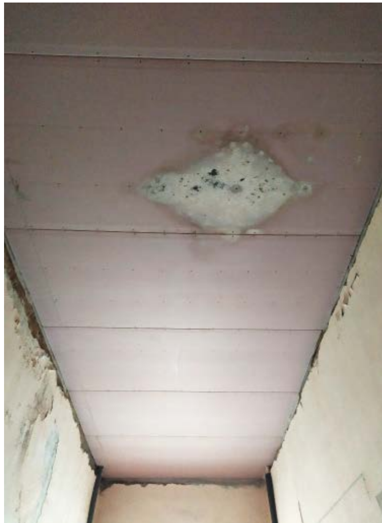
26. Чердачное перекрытие в осях 11-12/А-Г объекта культурного наследия регионального значения «Главное здание», расположенного по адресу: г. Санкт-Петербург, наб. Обводного канала, д. 7, лит. Г, входящего в состав объекта культурного наследия регионального значения «Духовная академия». 23.11.2020.
