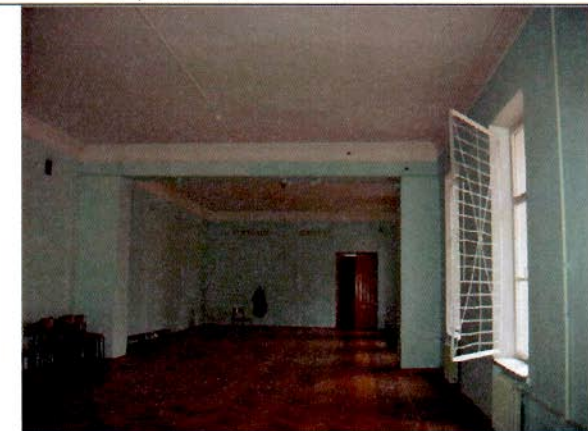
28. Помещение 2-го этажа. Общий вид.
