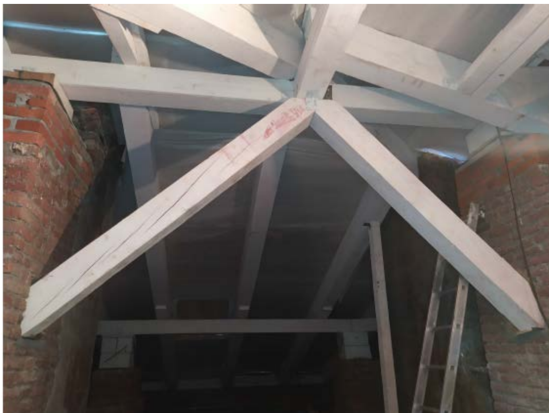
19. Стропильная система крыши объекта культурного наследия регионального значения «Главное здание», расположенного по адресу: г. Санкт-Петербург, наб. Обводного канала, д. 7, лит. Г, входящего в состав объекта культурного наследия регионального значения «Духовная академия». 23.11.2020.
