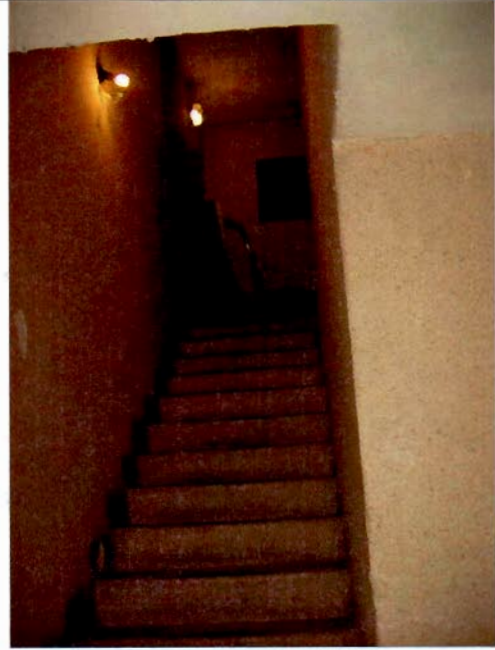
10. Лестница. Общий вид.
