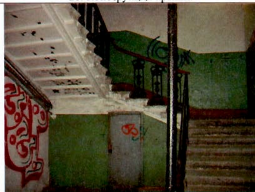
28. Лестница в южной части здания. Общий вид.
