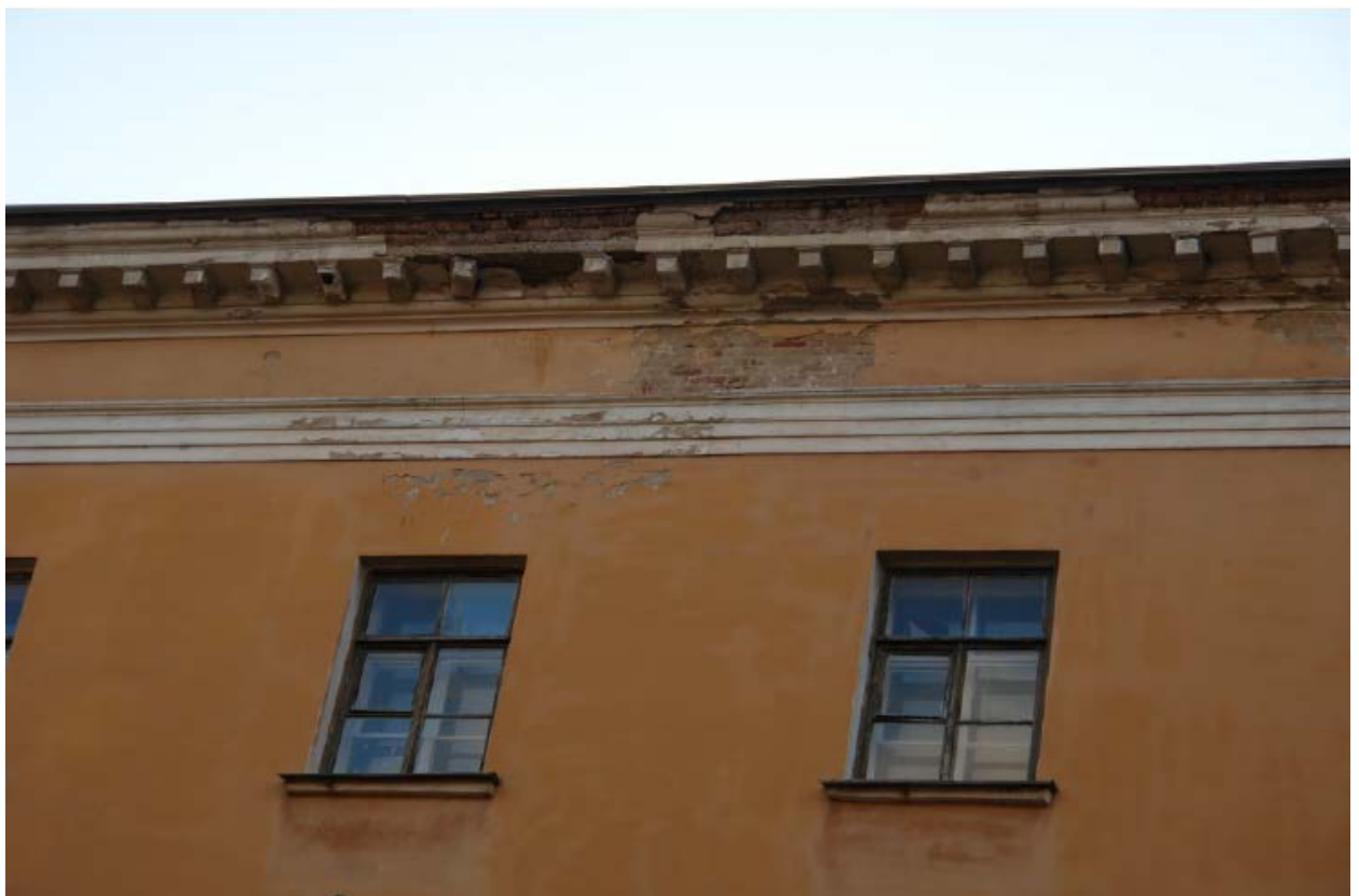
6. Карнизный свес северного торцевого фасада объекта культурного наследия регионального значения «Главное здание», расположенного по адресу: г. Санкт-Петербург, наб. Обводного канала, д. 7, лит. Г, входящего в состав объекта культурного наследия регионального значения «Духовная академия». Фрагмент. 23.11.2020.
