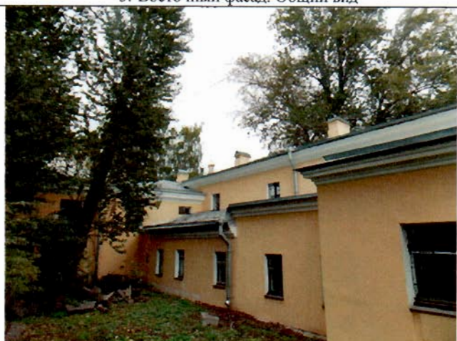
5. Западный фасад. Общий вид.
