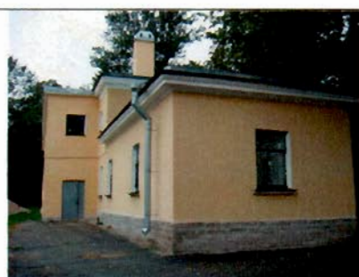
2. Южный фасад. Фрагмент.
