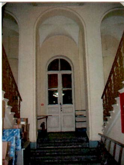
21. Помещение 1-го этажа. Фрагмент.
