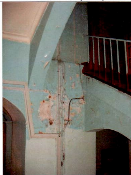
41. Лестница в южном крыле. Фрагмент.
