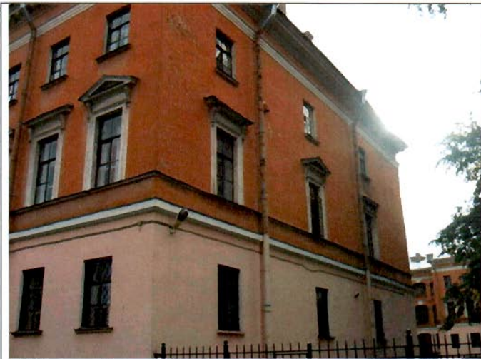
8. Западный торцевой фасад северного флигеля. Общий вид.
