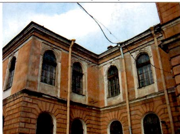
13. Западный фасад. Фрагмент.
