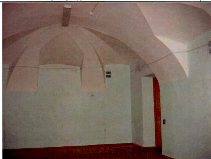
16. Помещения 1-го этажа. Общий вид.
