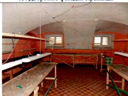
15. Помещение в уровне подвала. Общий вид.
