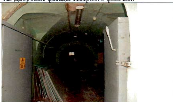
14. Коридор в уровне подвала. Общий вид.
