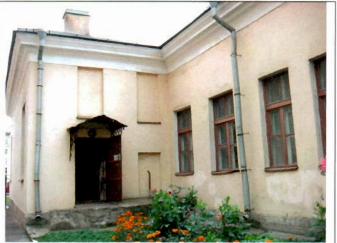
2. Фрагмент восточного фасада.
