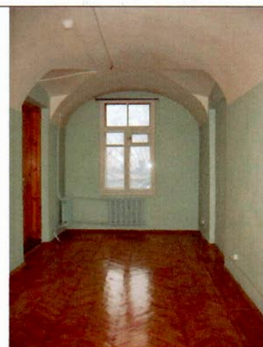
35. Коридор 1-го этажа.
