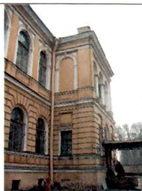
8. Северный фасад. Фрагмент.
