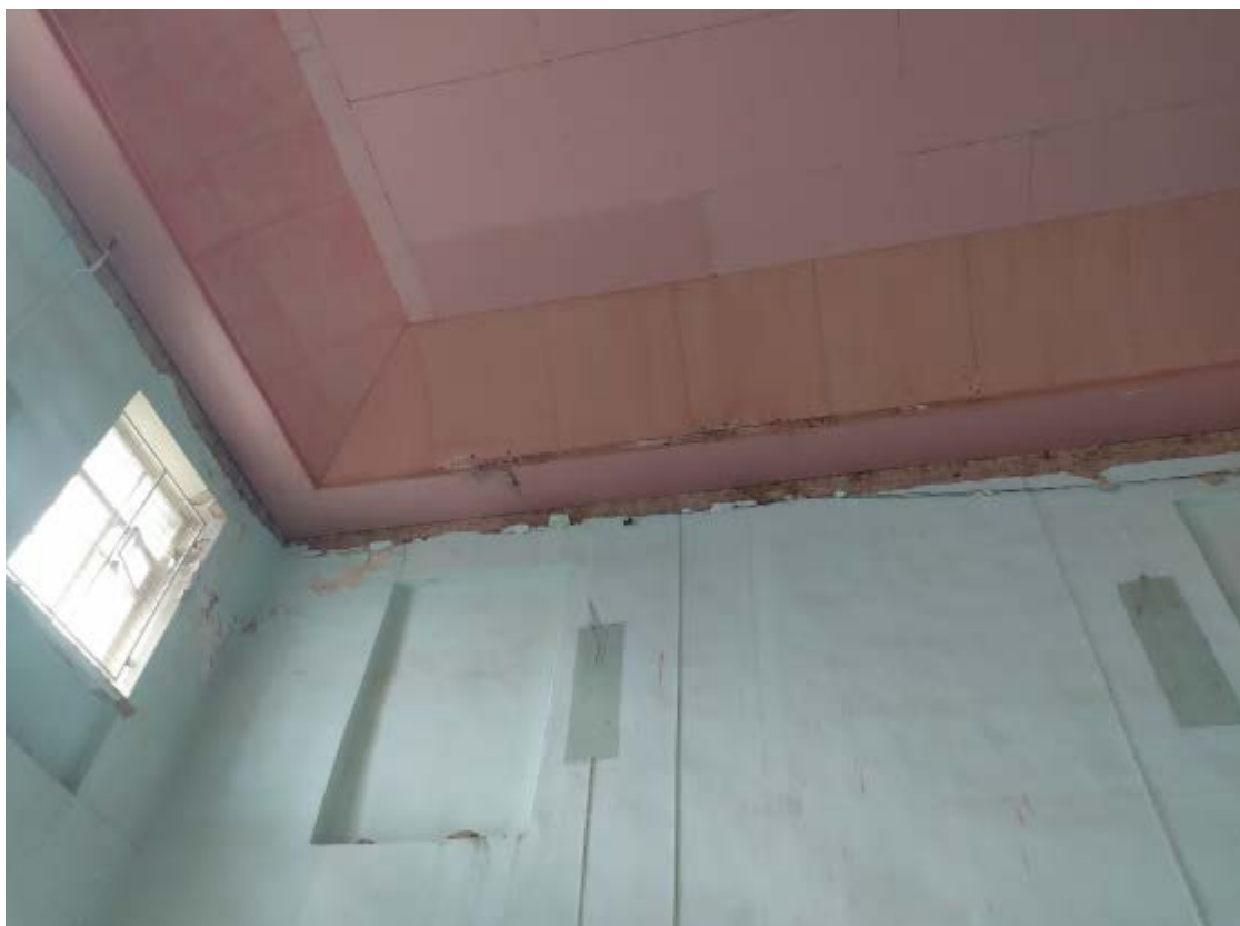
25. Чердачное перекрытие в осях 12-16/Б-Г объекта культурного наследия регионального значения «Главное здание», расположенного по адресу: г. Санкт-Петербург, наб. Обводного канала, д. 7, лит. Г, входящего в состав объекта культурного наследия регионального значения «Духовная академия». 23.11.2020.
