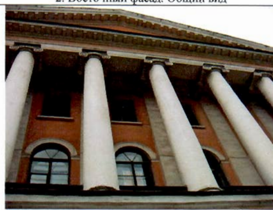
4. Фрагмент восточного фасада. Портик с колоннадой ионического ордера и треугольным фронтоном.
