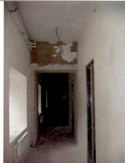
10. Коридор 2-го этажа. Общий вид.
