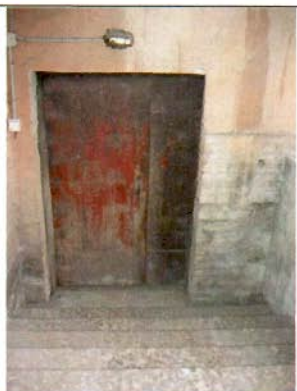
7. Входной проем восточного фасада. Общий вид.
