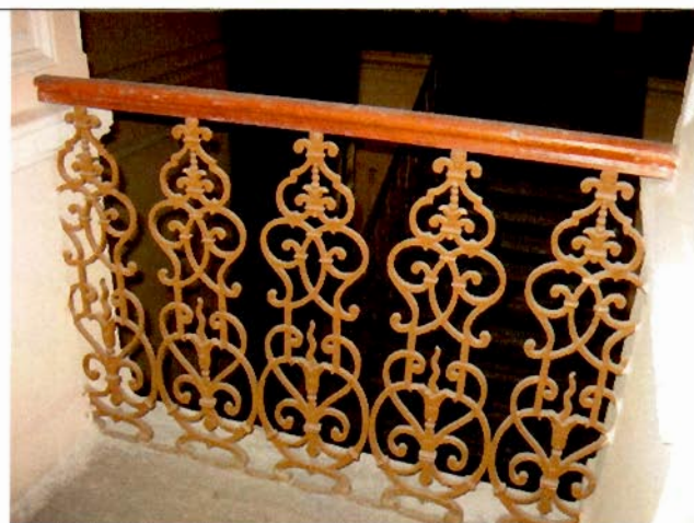
16. Ограждение лестницы северной части здания. Фрагмент.
