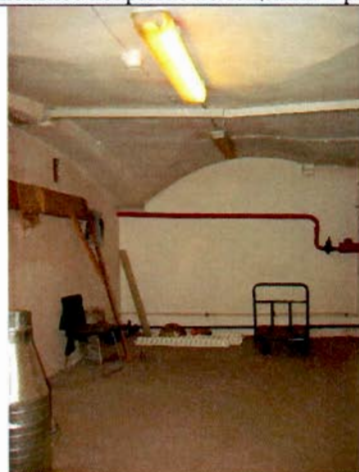
25. Помещение подвала. Общий вид.
