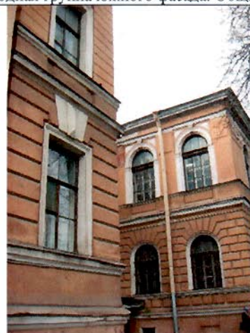
4. Восточный фасад. Фрагмент.
