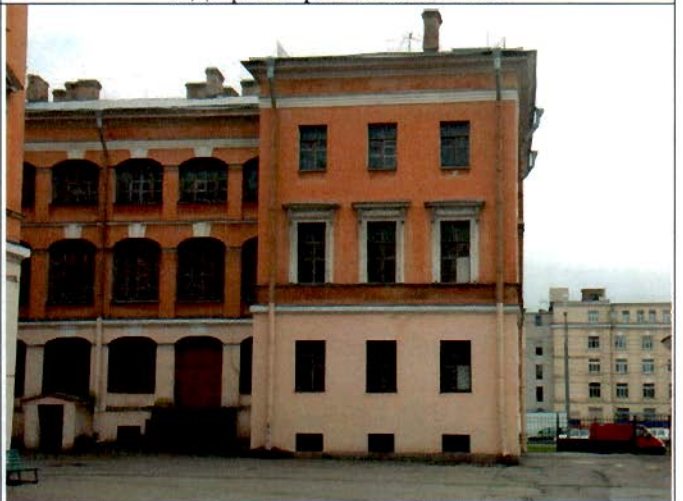
11. Дворовые фасады южного флигеля. Общий вид.
