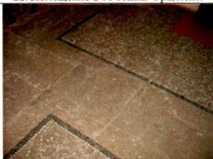
23. Напольное покрытие помещений. Фрагмент.
