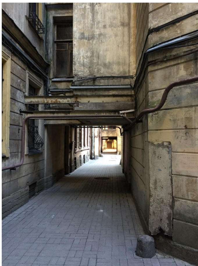
Фото 8. Фрагмент северо-восточного дворового фасада. Арка воротного проезда.
