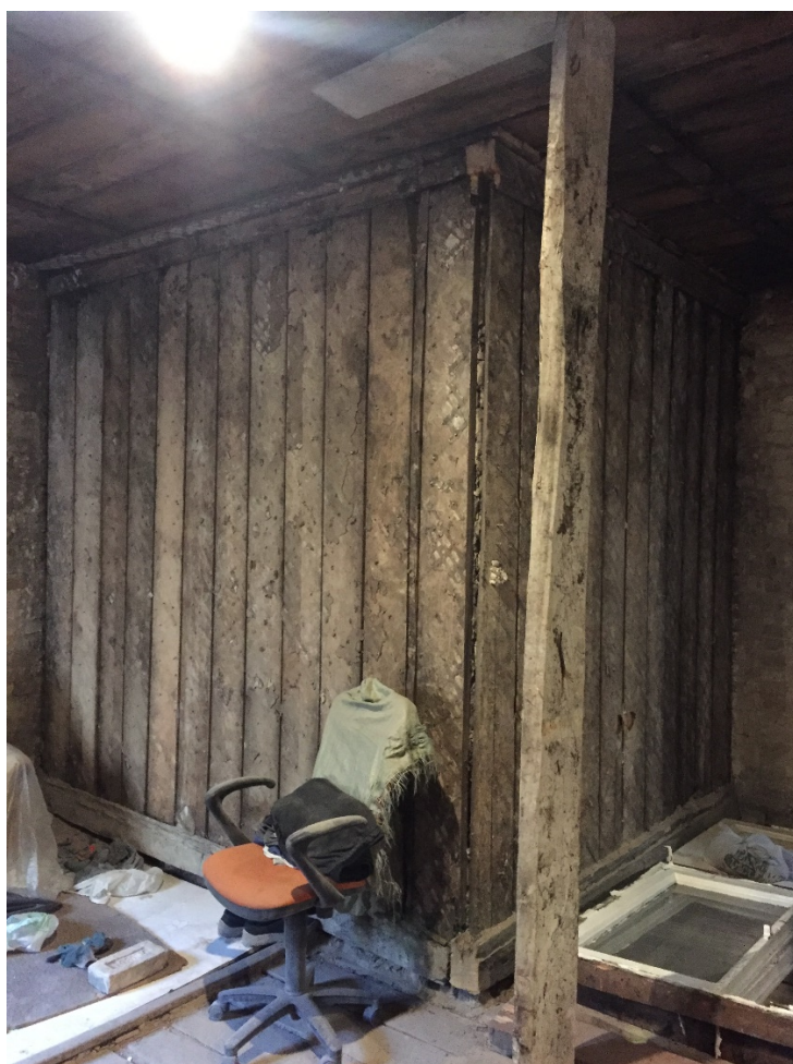
Фото 12. Существующая межквартирная деревянная перегородка.
