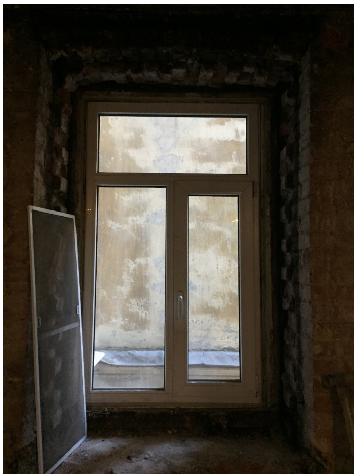
Фото 17. Существующее оконное заполнение квартиры, выходящее на северо-запад.
