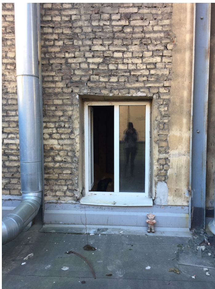
Фото 18. Оконное заполнение квартиры, выходящее на северо-запад.
