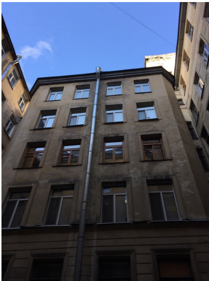
Фото 7. Юго-западный дворовой фасад.
