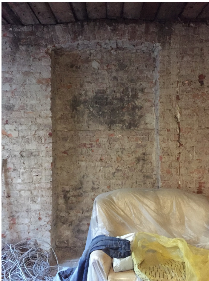
Фото 15. Существующая историческая ниша в капитальной стене.
