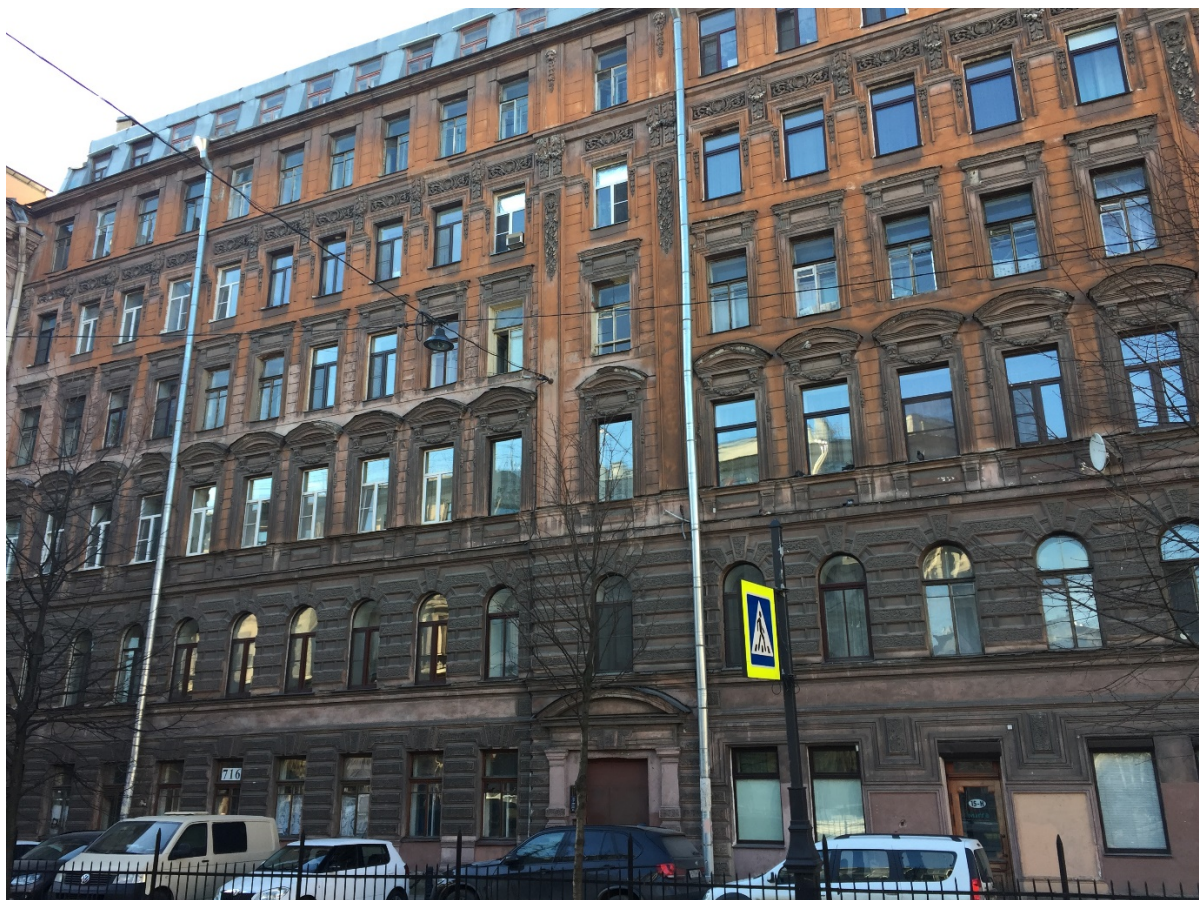
Фото 4. Южная часть лицевого фасада.
