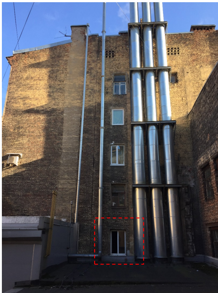
Фото 9. Северо-западный фасад дворового корпуса.
