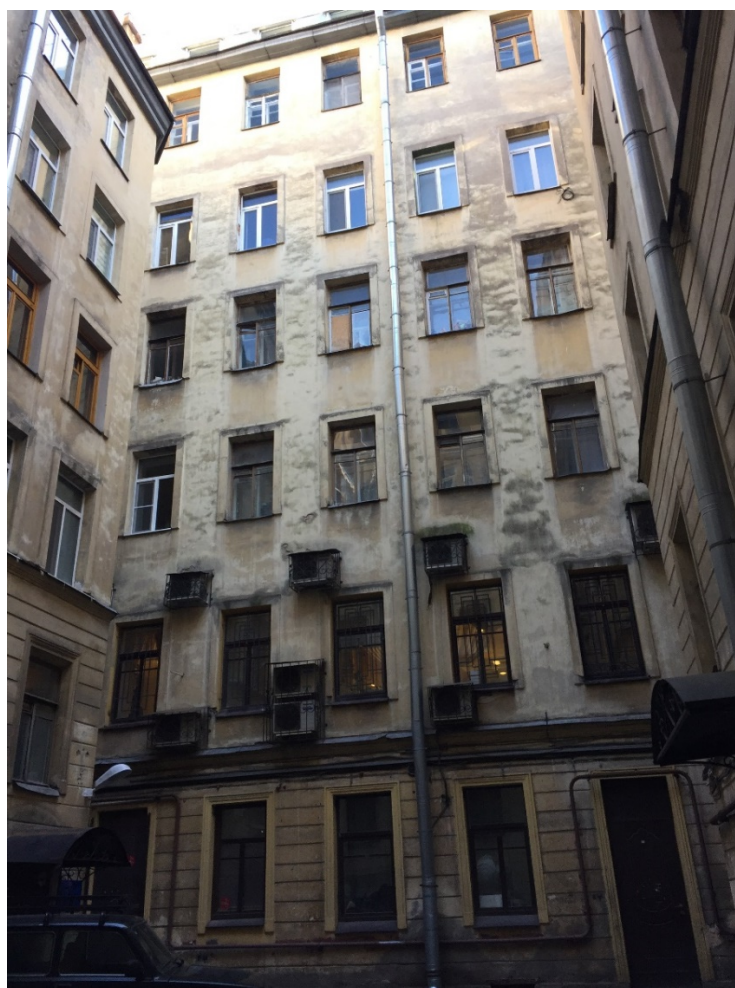
Фото 6. Северо-западный фасад лицевого корпуса.
