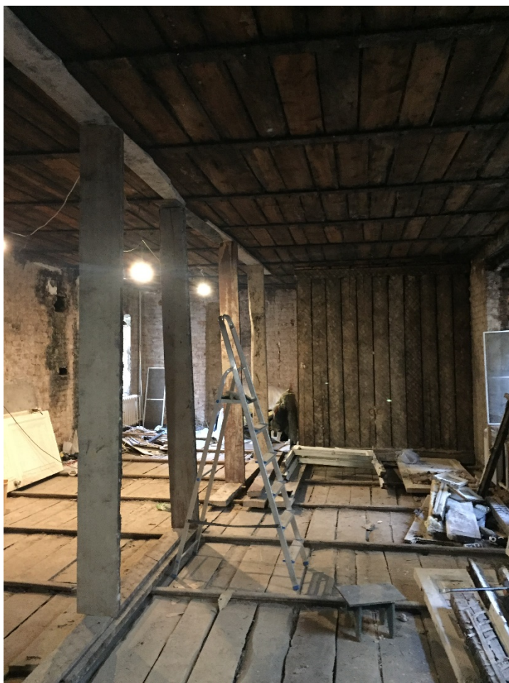
Фото 11. Общий вид помещений квартиры № 78.
