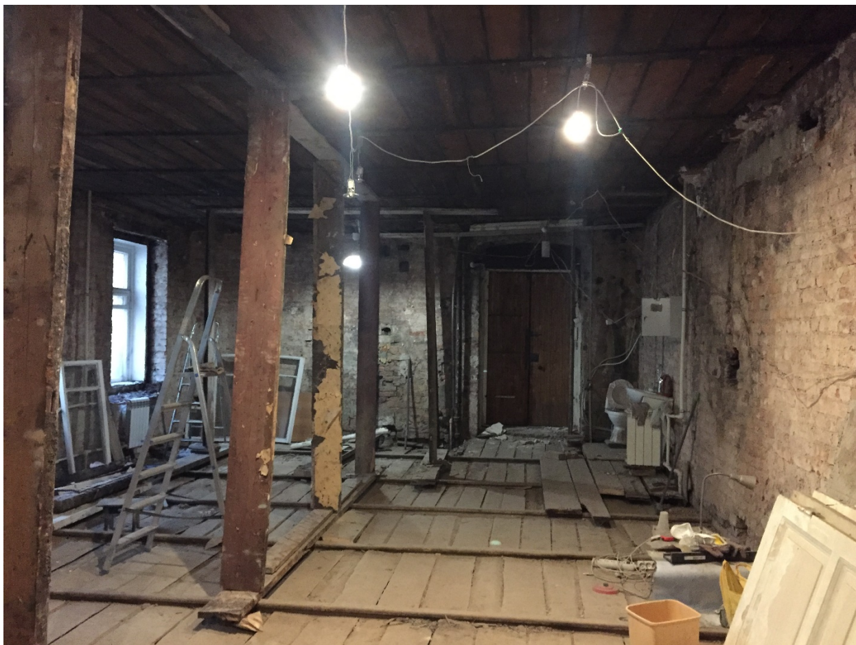
Фото 13. Общий вид существующего состояния помещений квартиры № 78.
