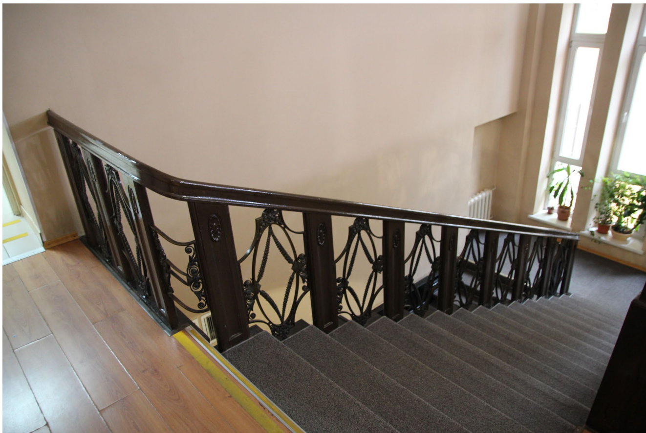
Фото 13. Помещение №68. Общий вид лестничной клетки
