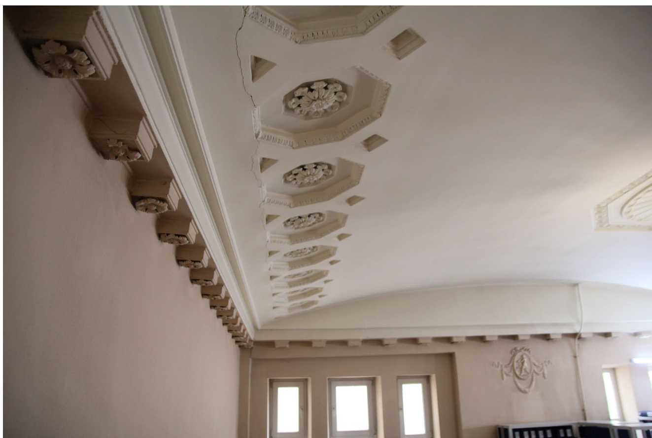
Фото 18. Помещение №68. Карниз с модульонами. Кессоны, декорированные розетками
