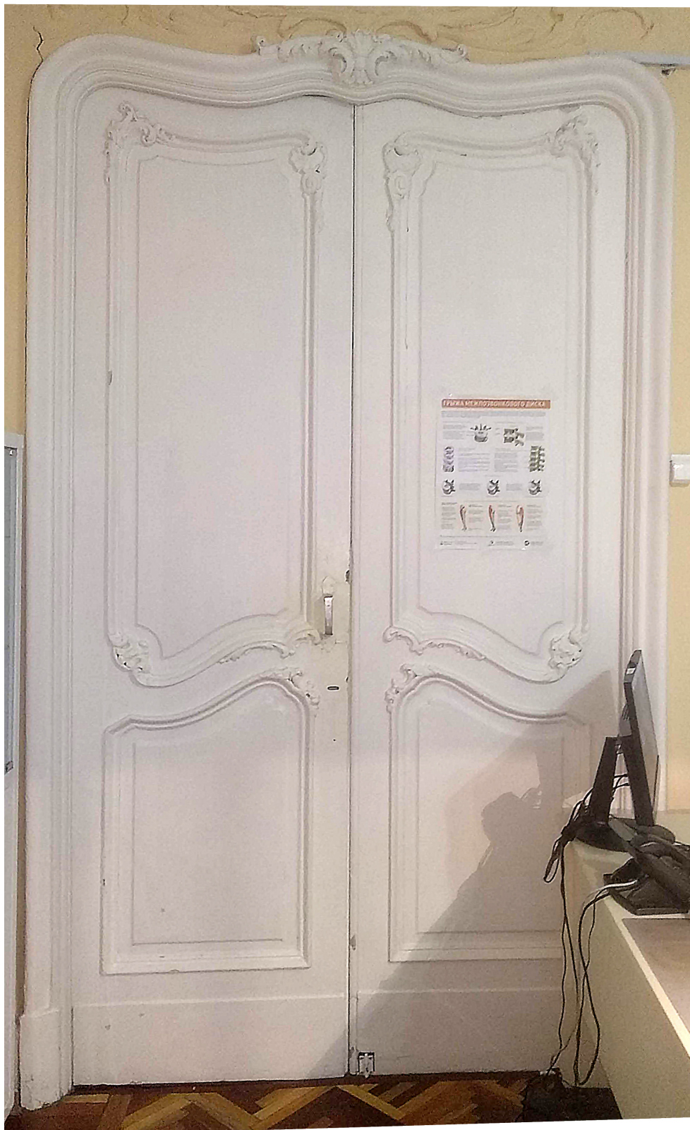
Фото 52. Дверное заполнение ДВ-6б. Общий вид из помещения №77
