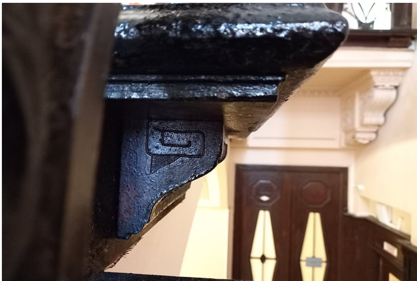
Фото 41. Фрагмент лестничной клетки. Кронштейн ступени. Вид сбоку
