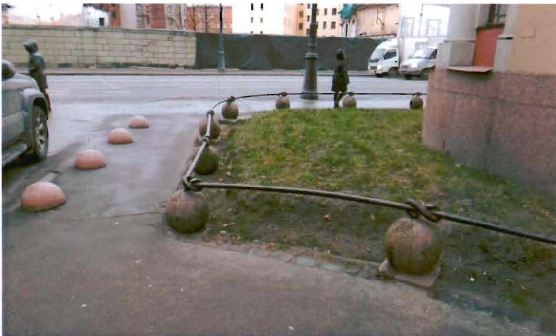
Фото №18. Вид со стороны Карповского переулка.
