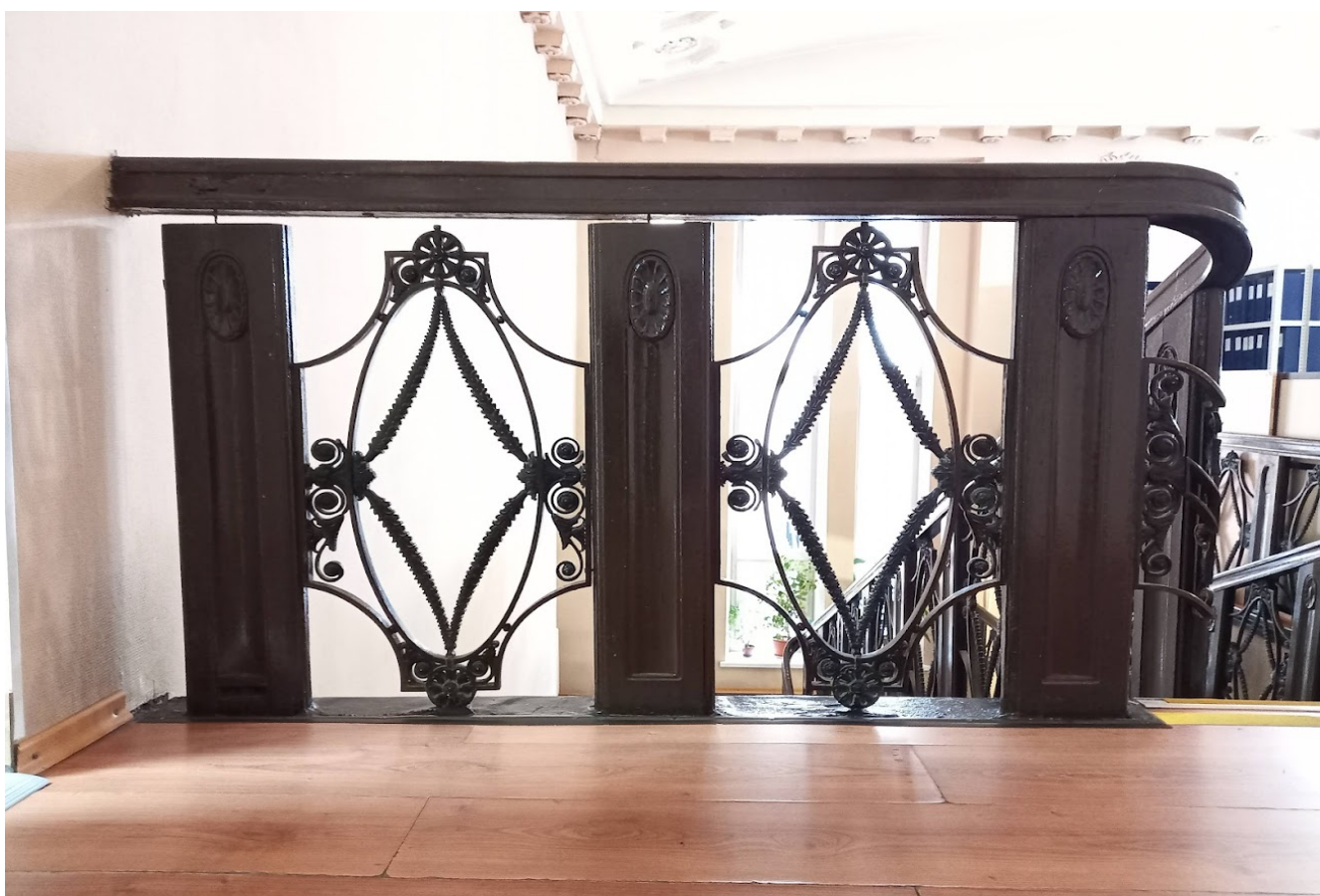
Фото 37. Помещение №68. Фрагмент ограждения лестницы
