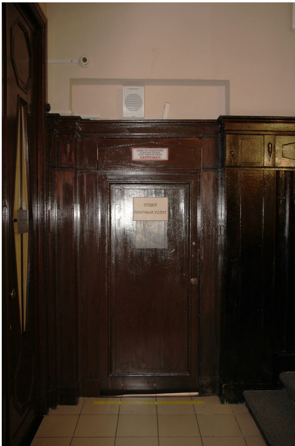
Фото 30. Помещение №43. Общий вид дверного заполнения ДВ-3, проход в помещение №56.
