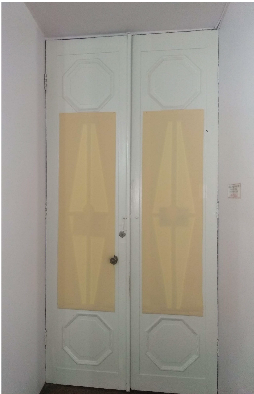
Фото 23. Помещение №51. Общий вид дверного заполнения ДВ-2а
