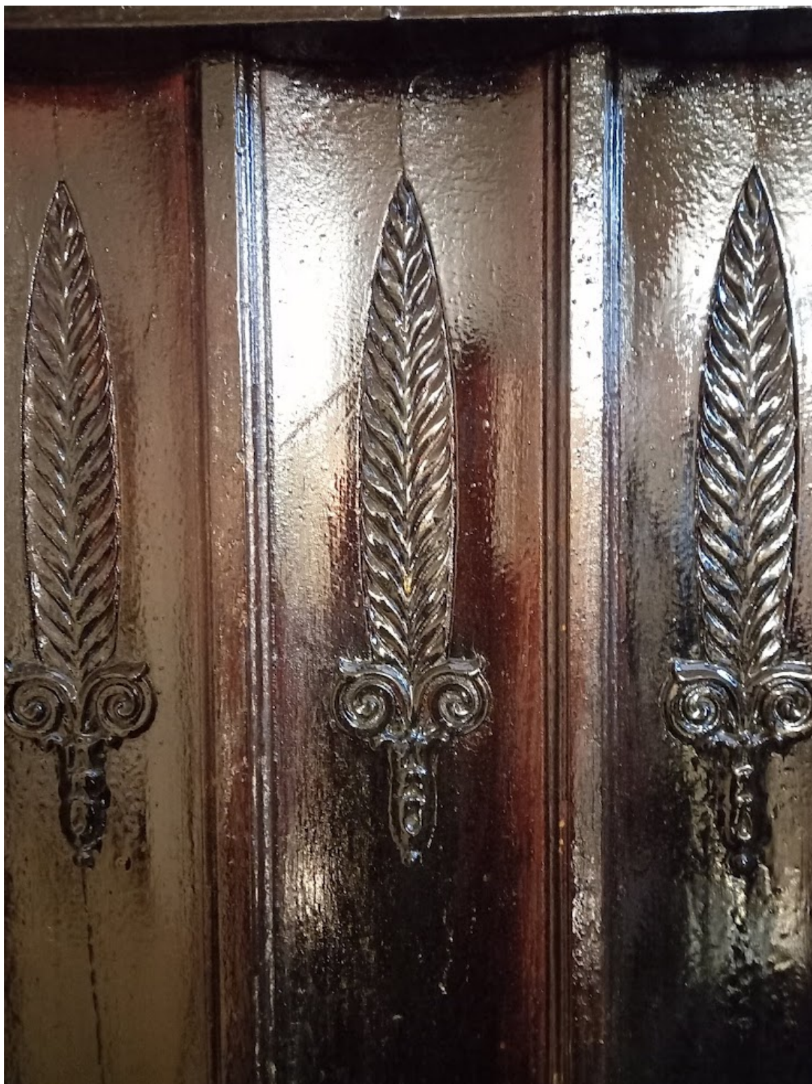
Фото 43. Помещение №43. Фрагмент стеновых панелей лестницы
