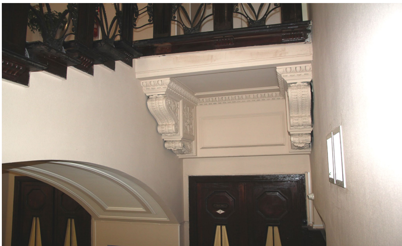
Фото 11. Помещение №43. Вид на кронштейны
