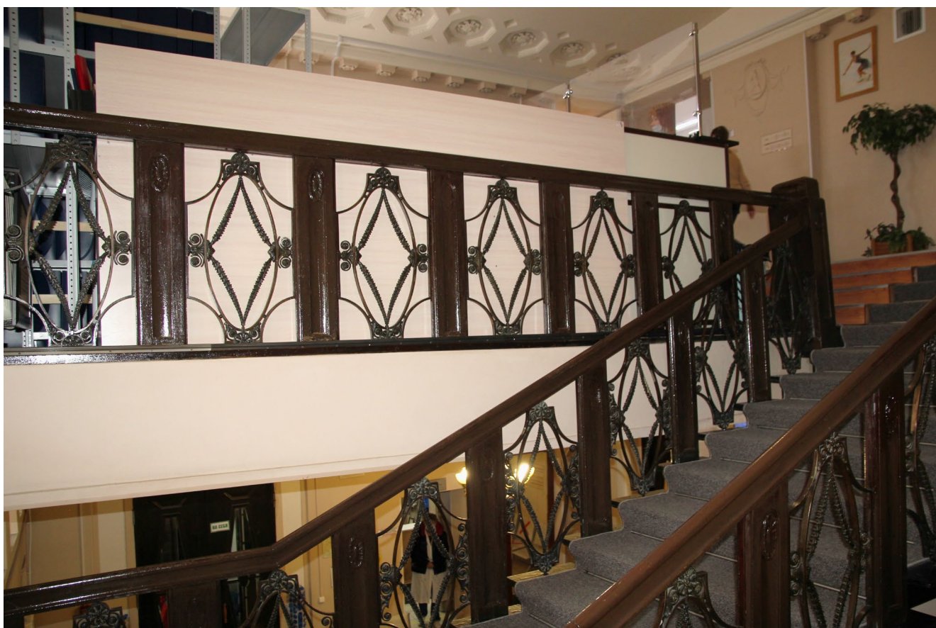
Фото 7. Фрагмент лестничной клетки, выход в помещение №68
