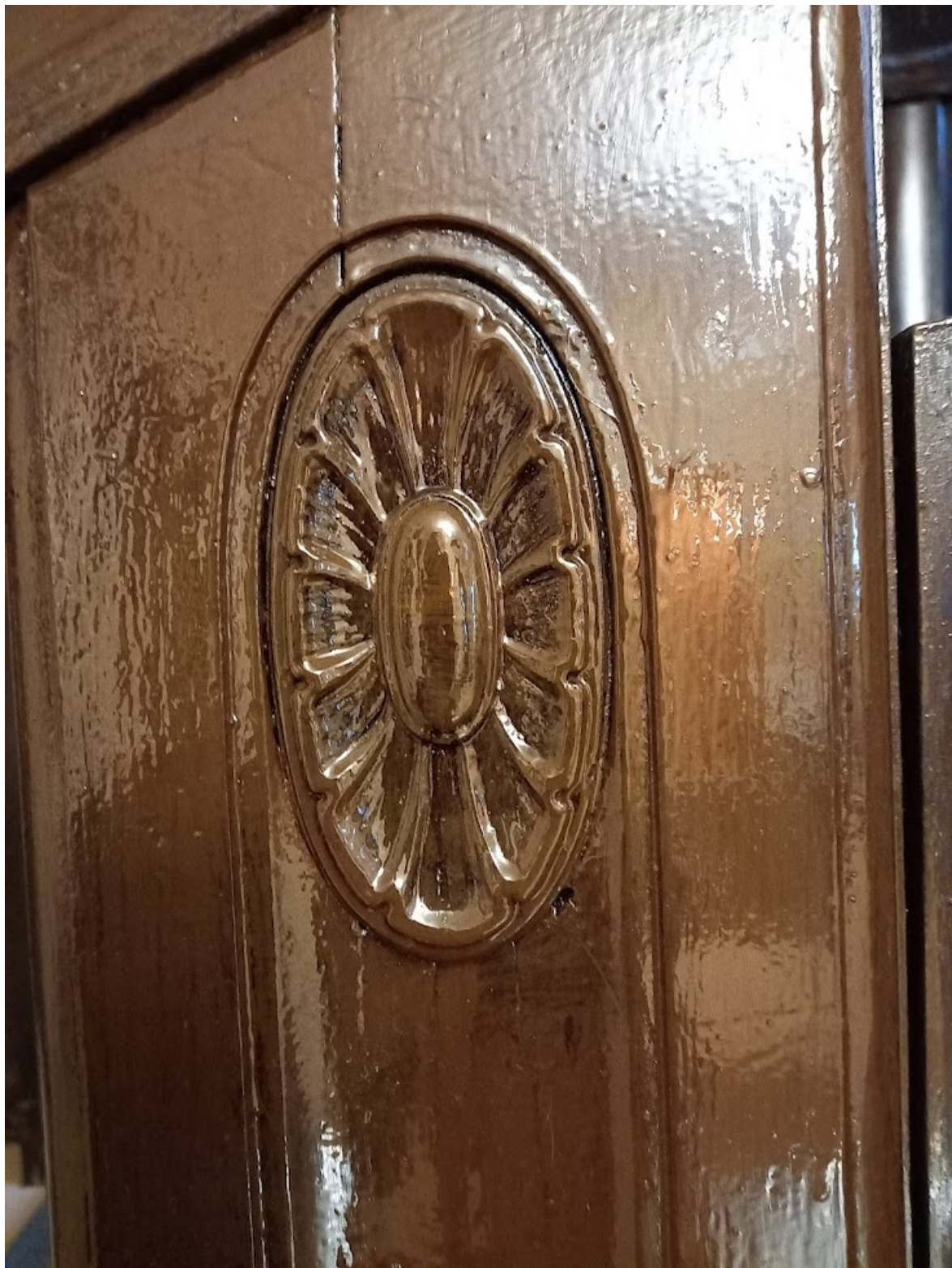
Фото 40. Декоративная розетка деревянных стоек ограждения
