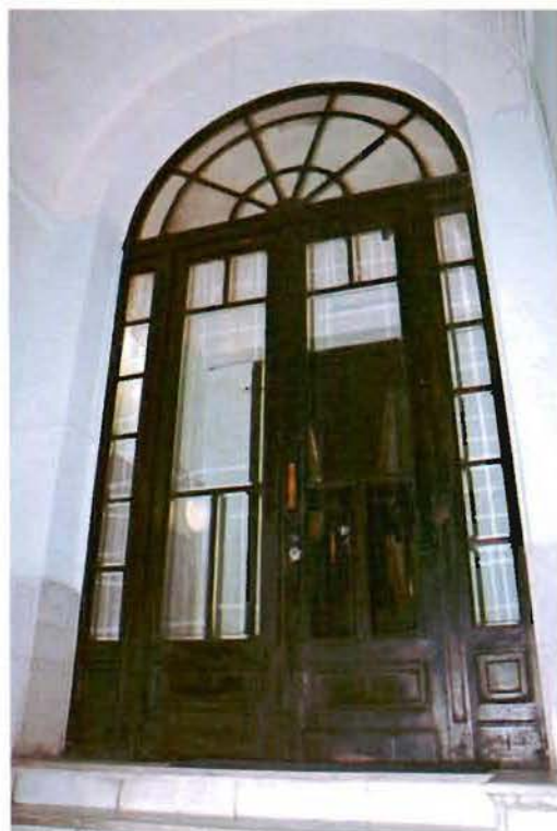
Фото №6. Вестибюль главного входа, пом. 1-Н (45).
