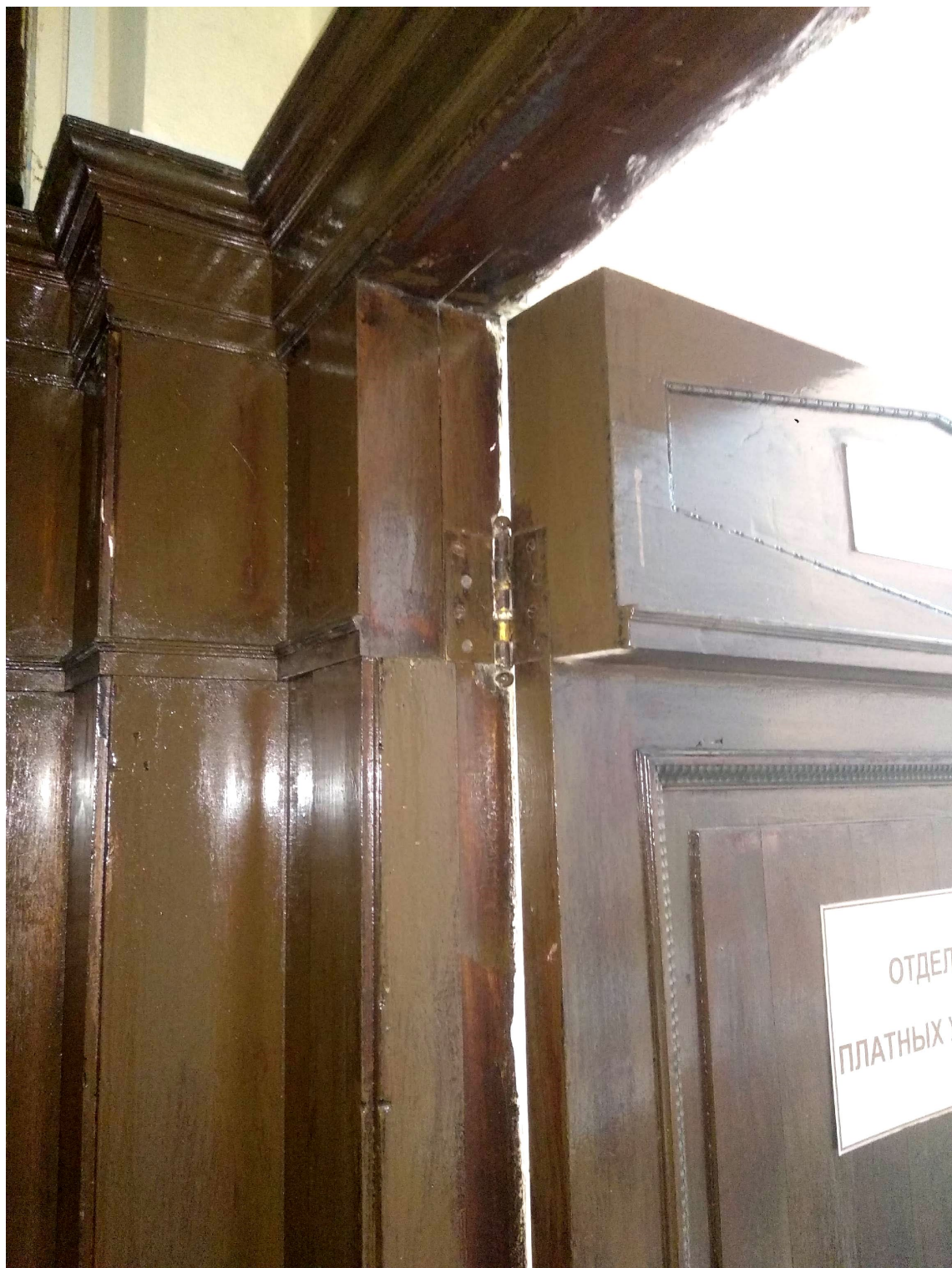
Фото 34. Фрагмент дверного заполнения ДВ-3 со стороны помещения №56
