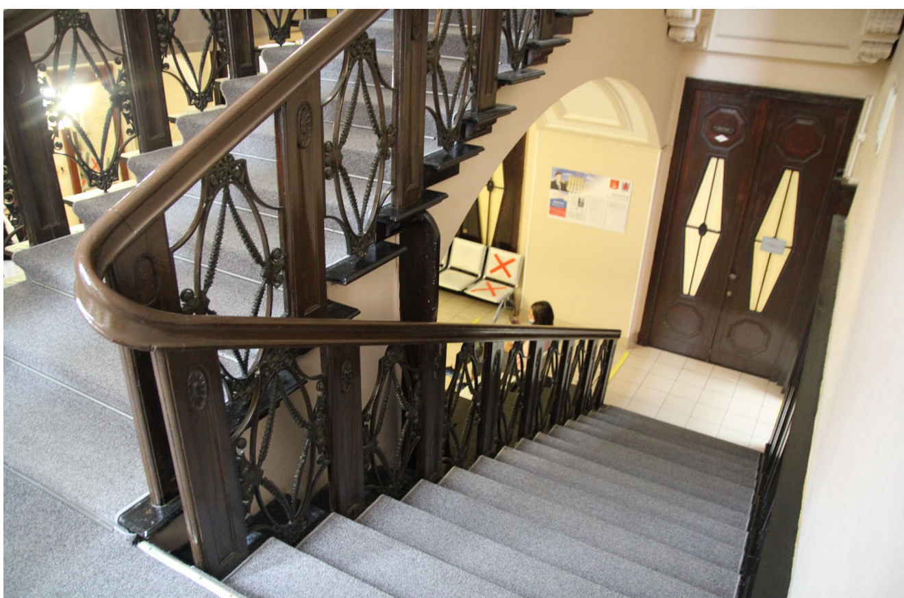
Фото 8. Фрагмент лестничной клетки, вид с междуэтажной площадки
