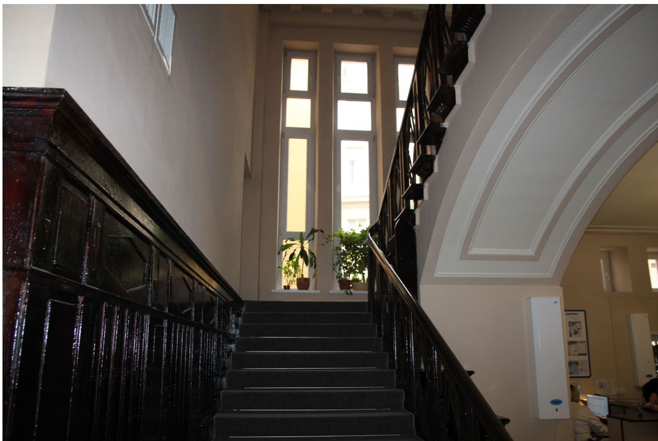
Фото 10. Фрагмент лестничной клетки, вид с уровня 1 этажа
