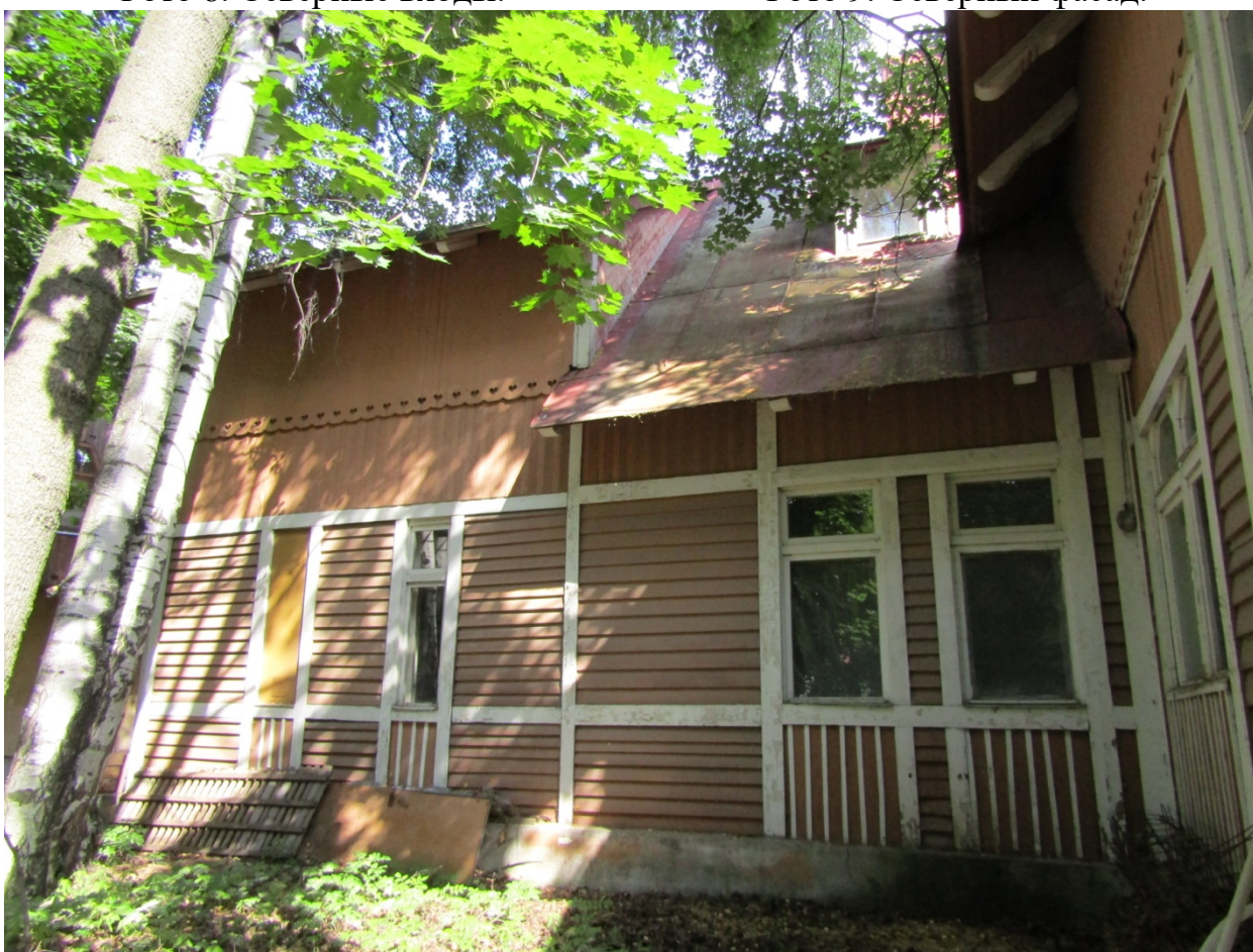
Фото 10. Фрагмент западного фасада.
