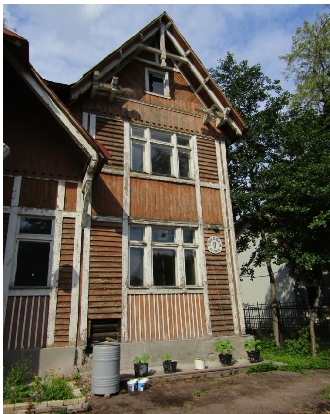
Фото 12. Фрагмент южного фасада.
