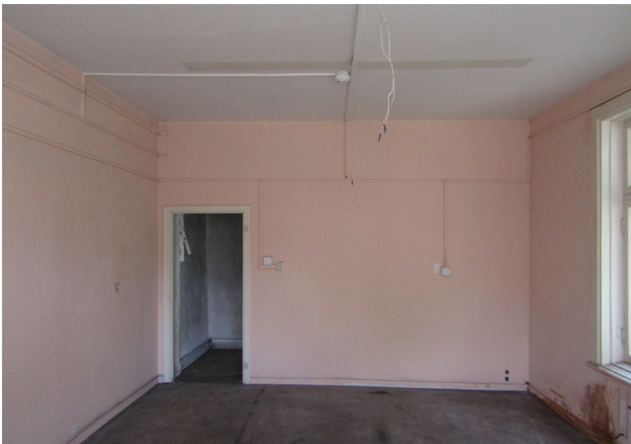
Фото 22. Помещение 12, вид на север.
