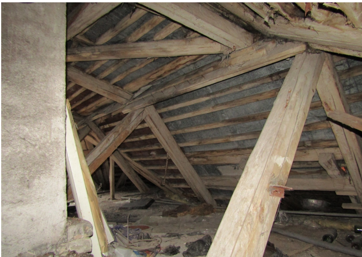
Фото 46ч. Помещение чердака, вид на запад.
