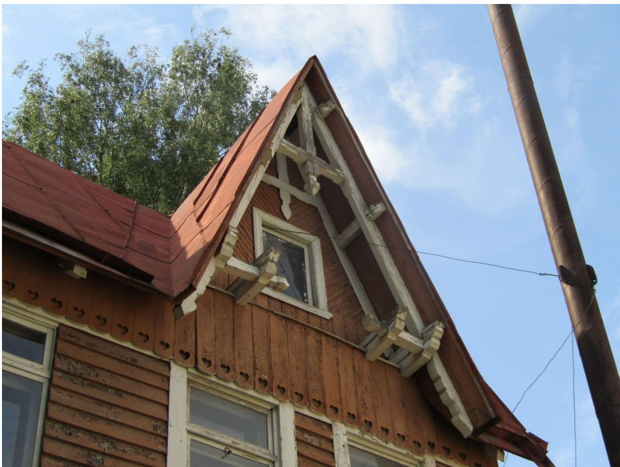
Фото 15. Северная часть восточного фасада.
