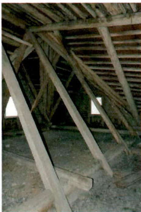
Фото 10, 11. Стропильные конструкции крыши.
