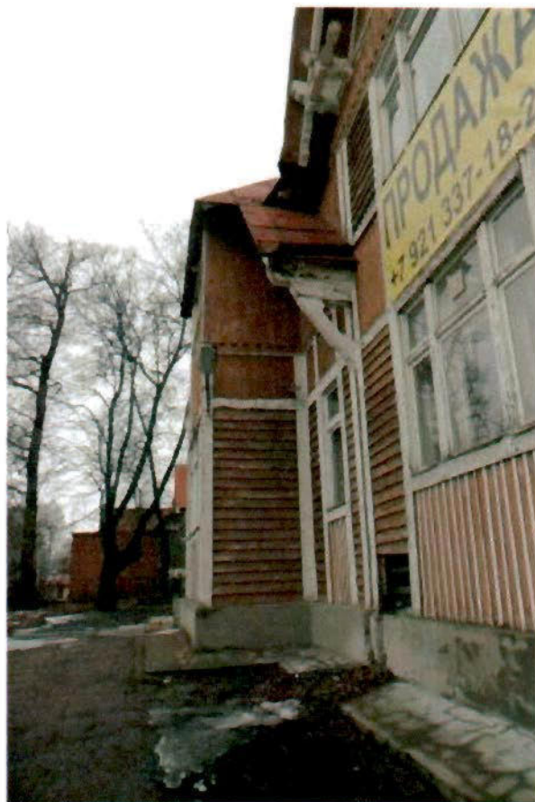
Фото 6. Фрагмент южного фасада.
