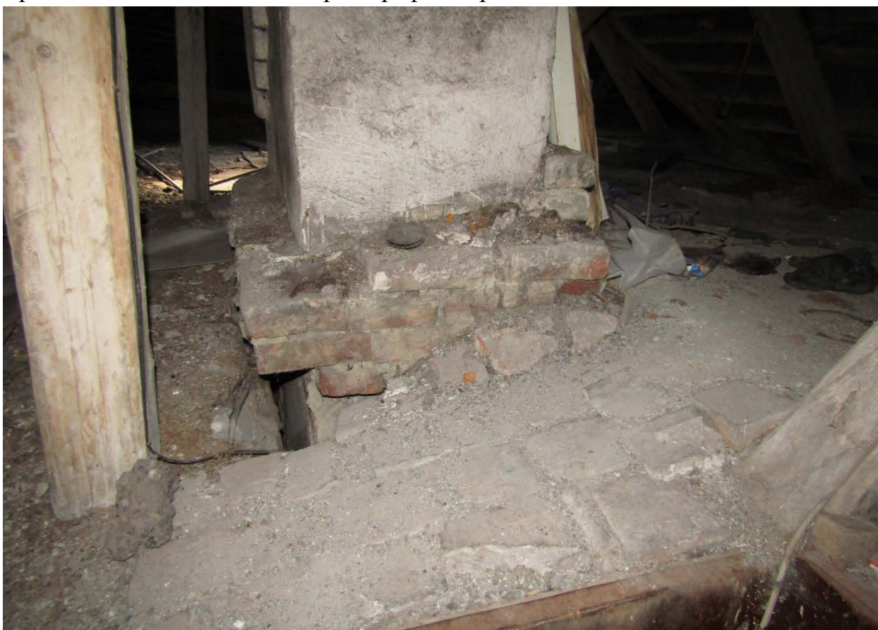
Фото 45ч. Колонна на чердаке, основание.
