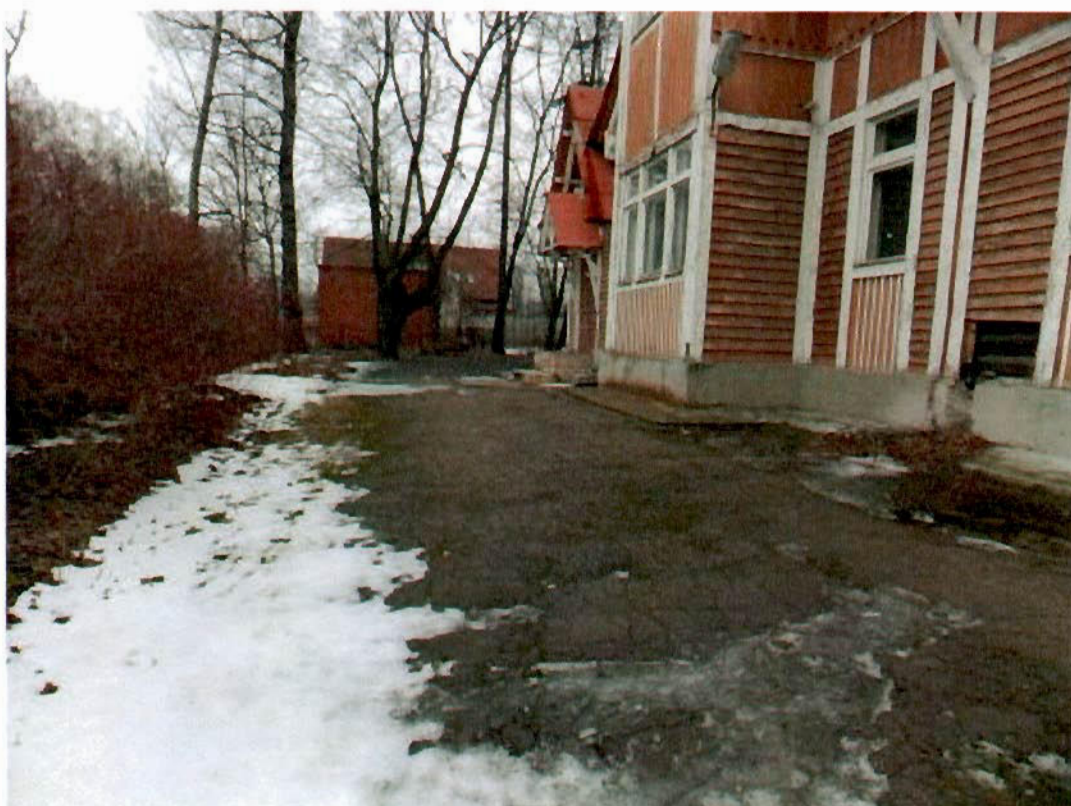
Фото 21. Вид территории объекта культурного наследия с юго-востока.
