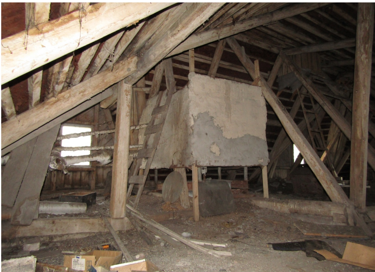
Фото 44ч. Вид на восточную и юго-восточную часть чердака.
