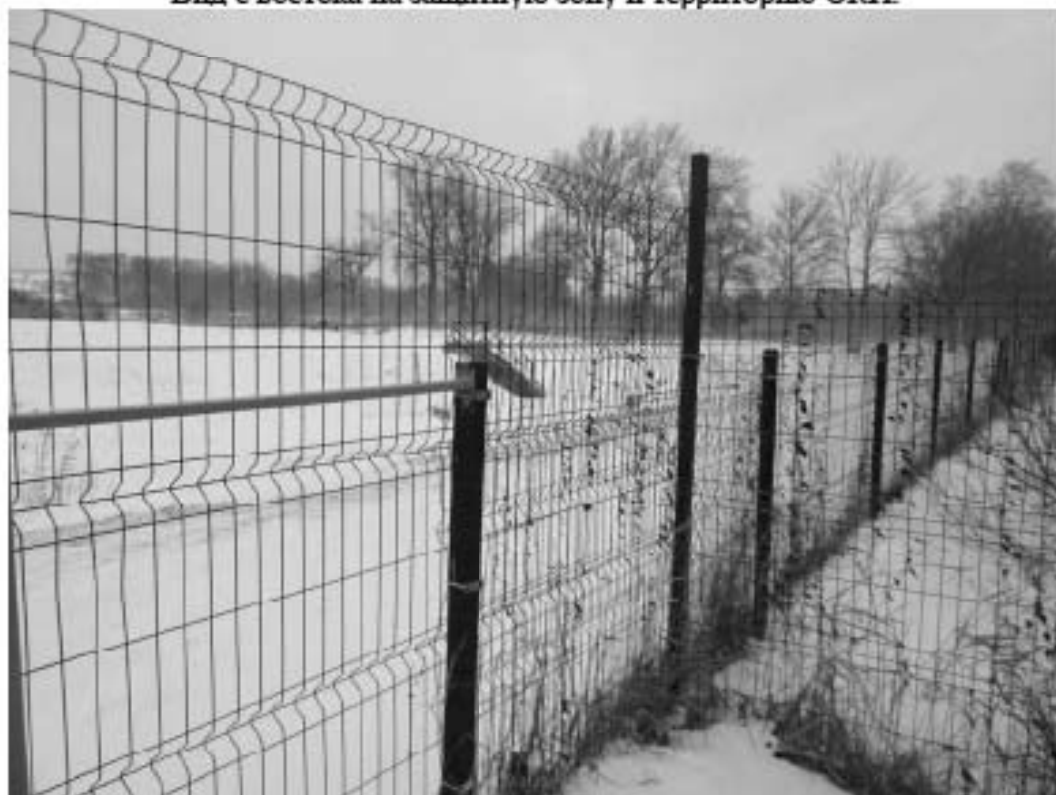
Илл. 32. Г. Санкт-Петербург, Петергоф (граница Лен. обл. и СПб у п. Санино). Точка фотофиксации Ф4. Вид с юга на территорию ОКН – Старопетергофский канал, ограда Лугового парка.
