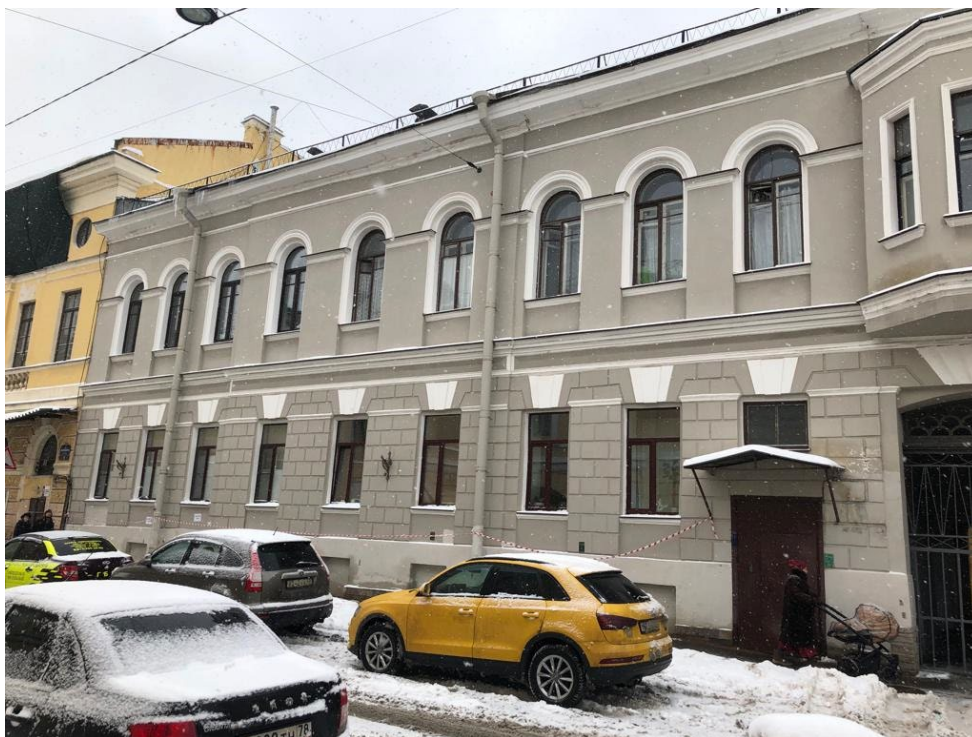
Фото № 1. Вид на лицевой фасад
