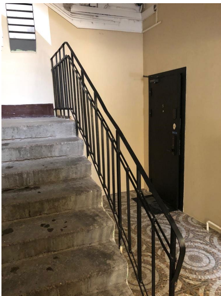
Фото № 4. Вид на входную дверь квартиры № 5
