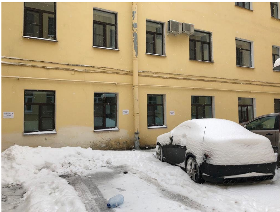
Фото № 3. Вид на оконные заполнения квартиры № 5
