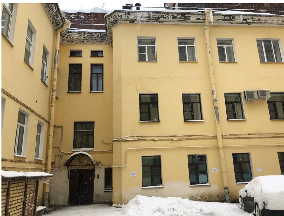
Фото № 2. Вид на лицевой фасад
