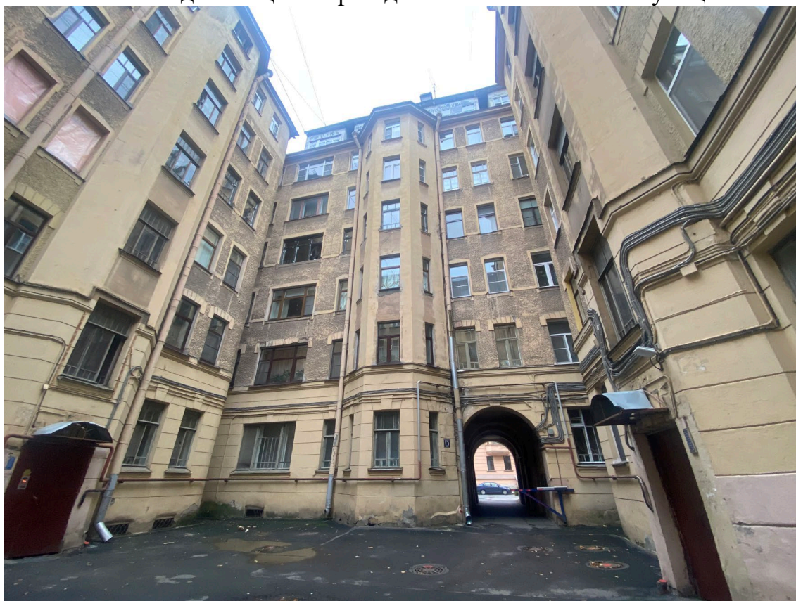
2. Вид на дворовые фасады
