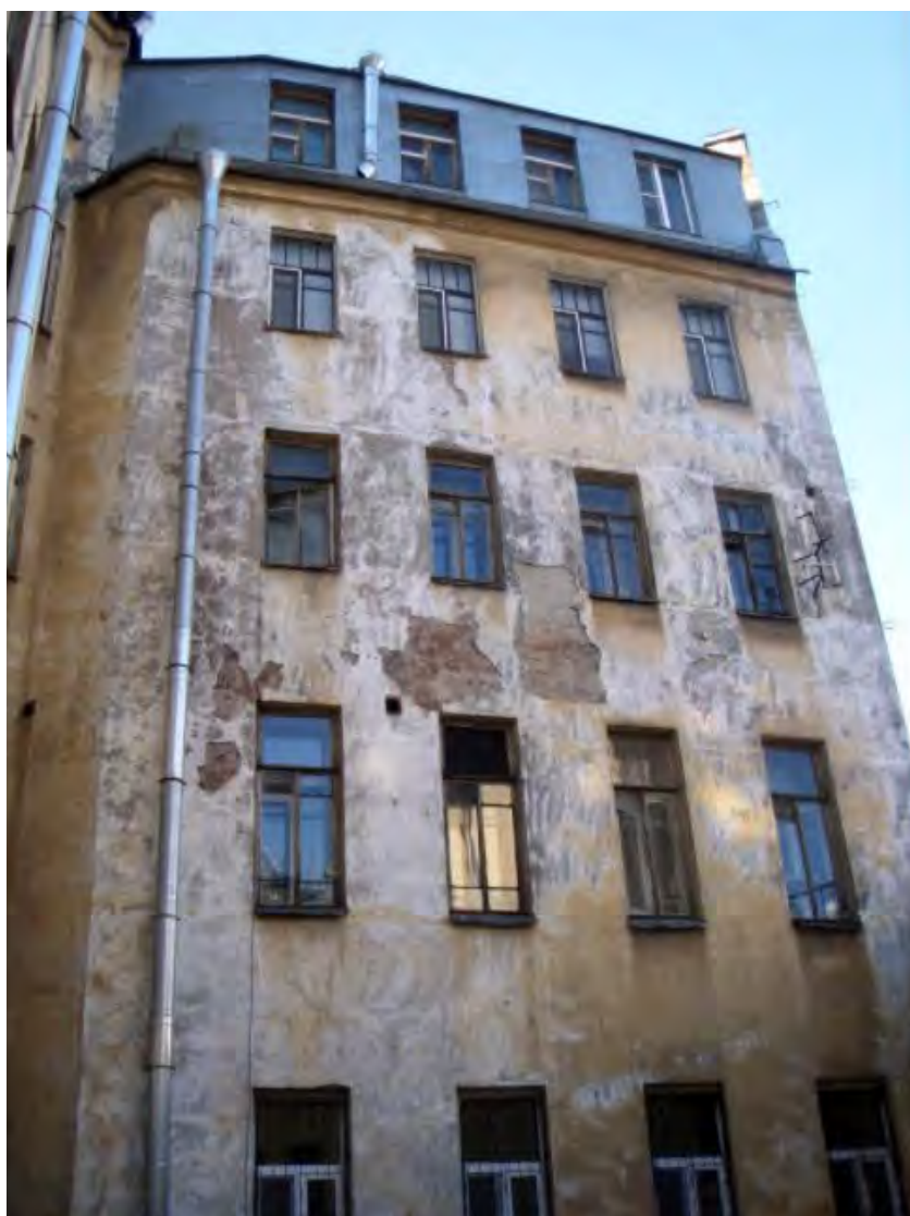
Фото 19. Объект культурного наследия регионального значения "Доходный дом И.Ф.Хреновой" по адресу: ул. Таврическая 7.
