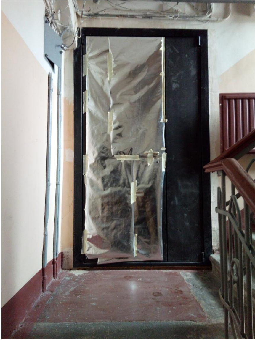
15. Входная дверь в квартиру № 34 с площадки лестничной клетки.
