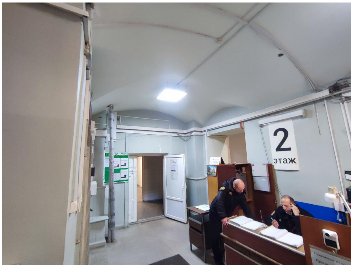
25. Общий вид пом. 1-Н (27) в уровне 2-го этажа.
