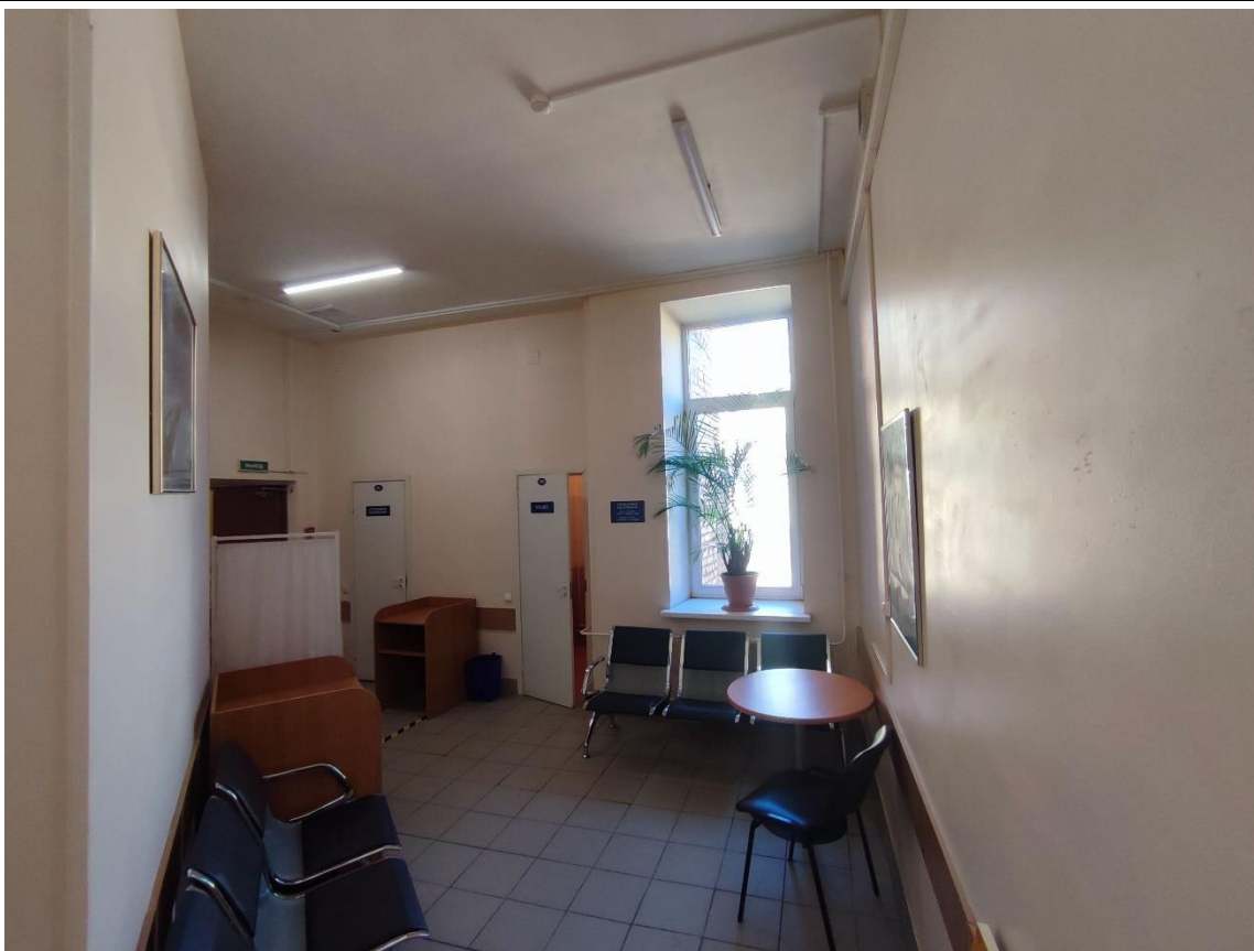
70. Общий вид пом. 29-Н (7) в уровне 3-го этажа.
