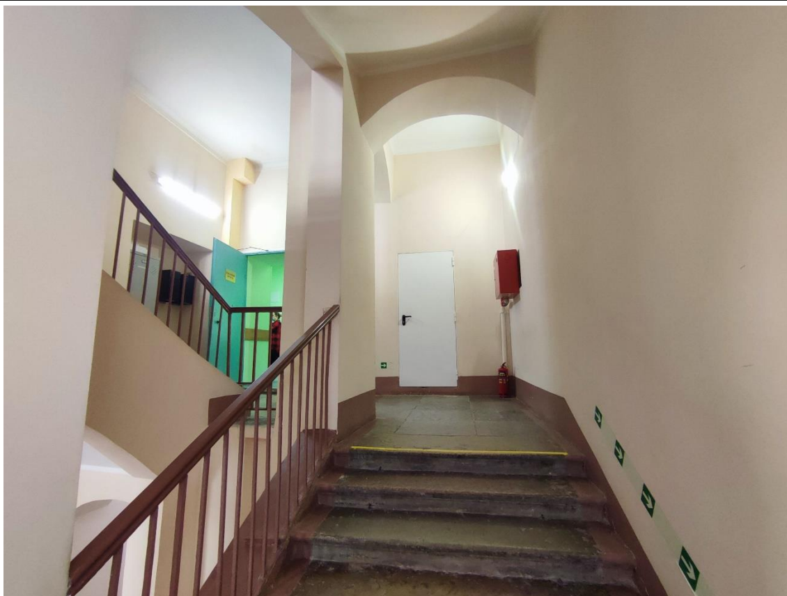
60. Общий вид площадки трехмаршевой лестницы Л-1 в уровне 4-го этажа.
