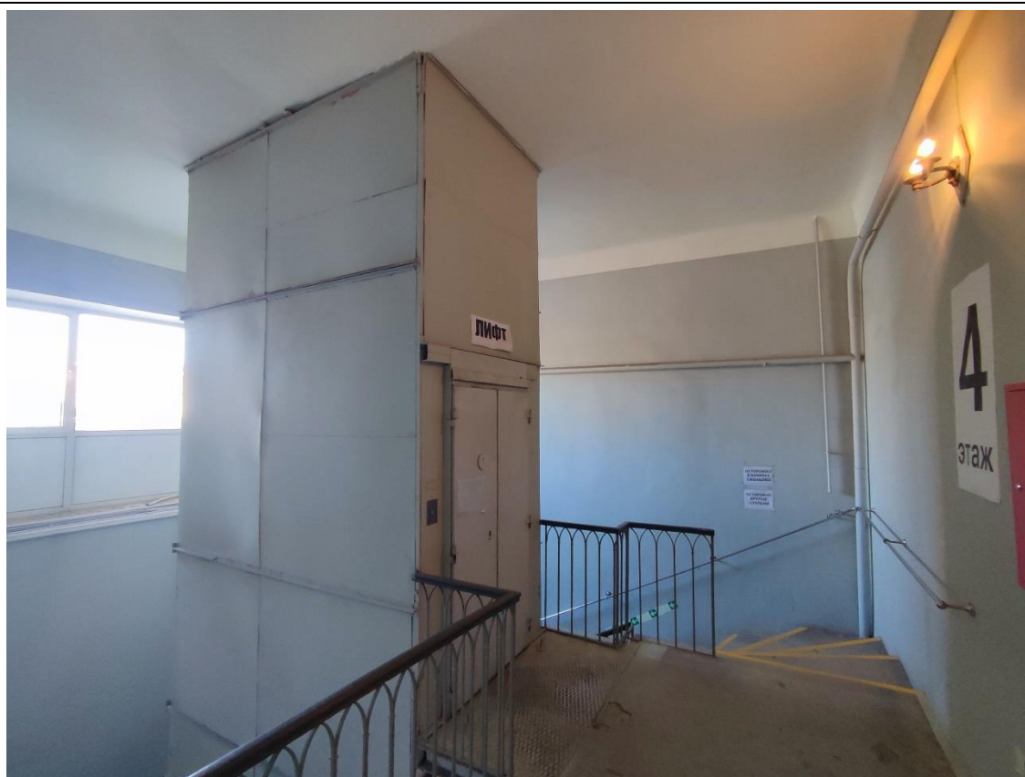
65. Фрагмент площадки трехмаршевой лестницы Л-2 в уровне 4-го этажа.
