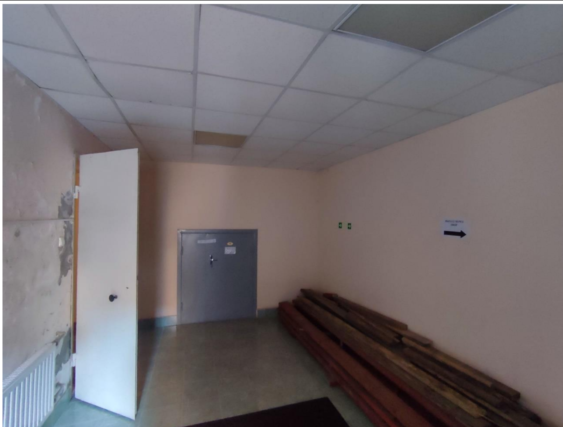
20. Общий вид пом. Л-1 (1) в уровне подвала.
