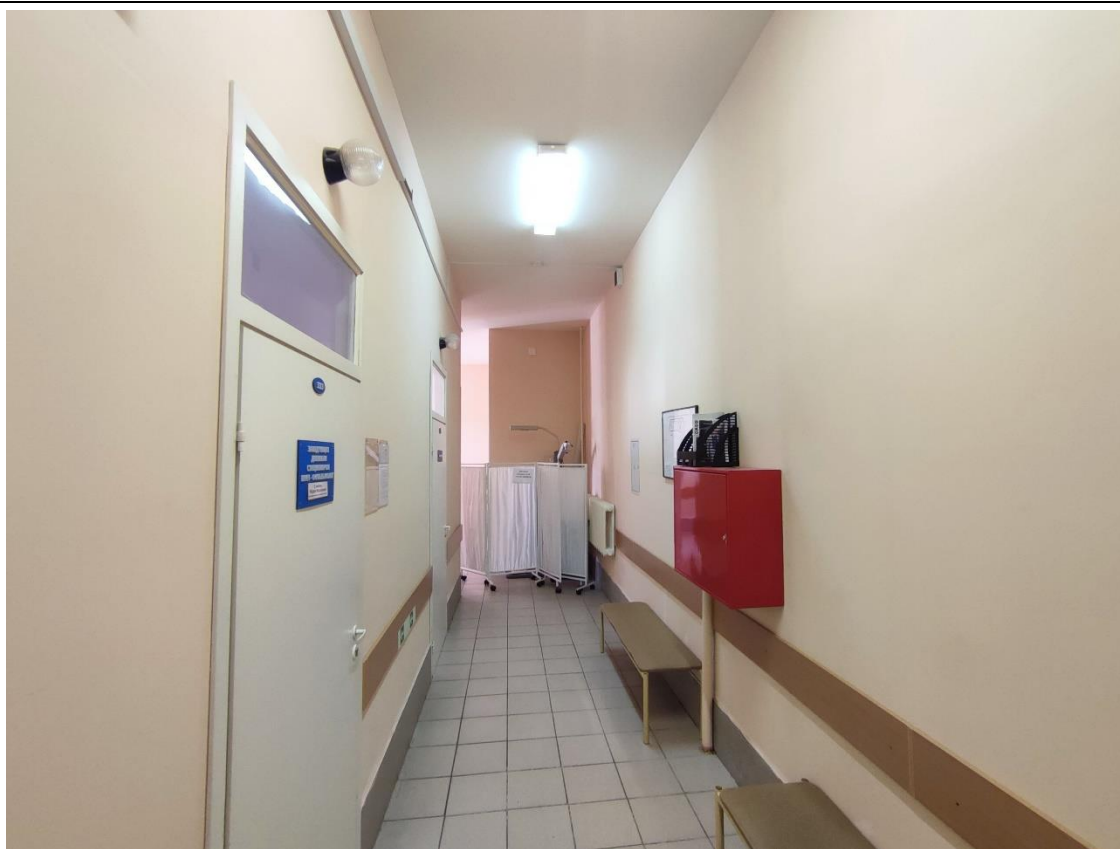
72. Общий вид пом. 30-Н (1) в уровне 3-го этажа.
