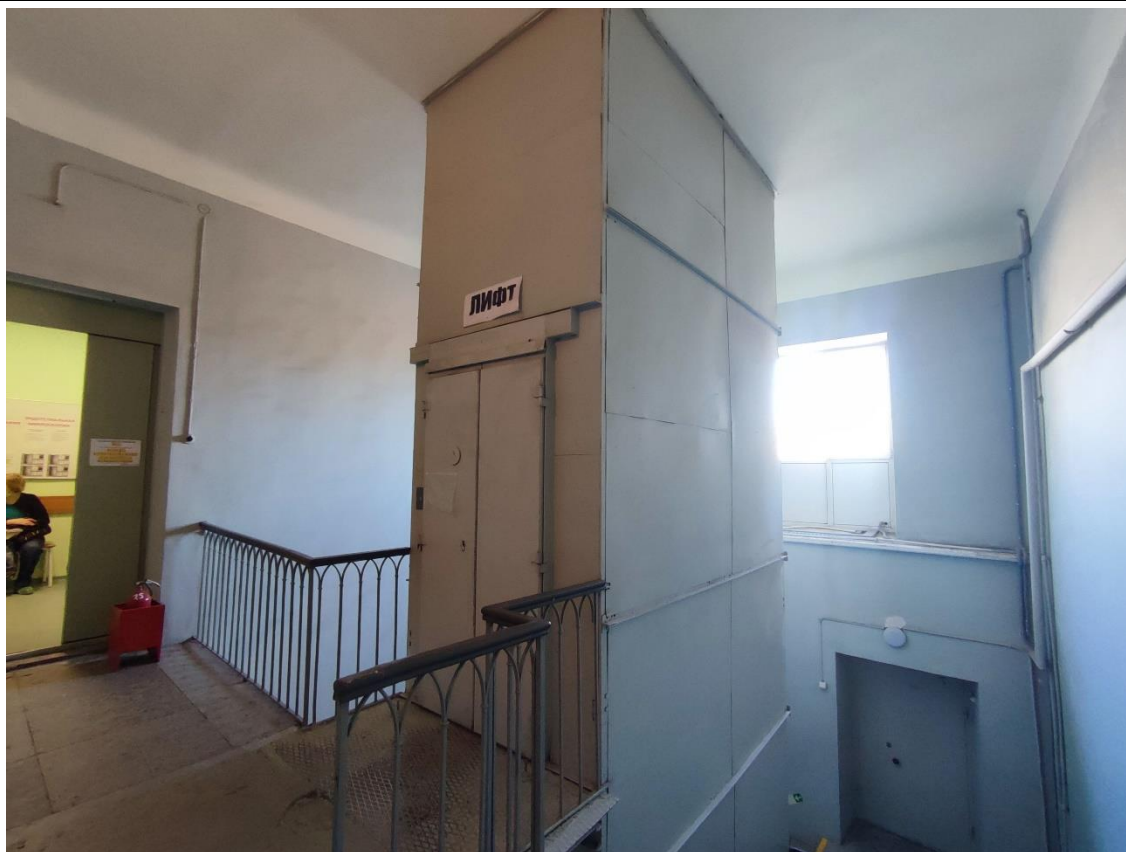
66. Фрагмент площадки трехмаршевой лестницы Л-2 в уровне 4-го этажа.
