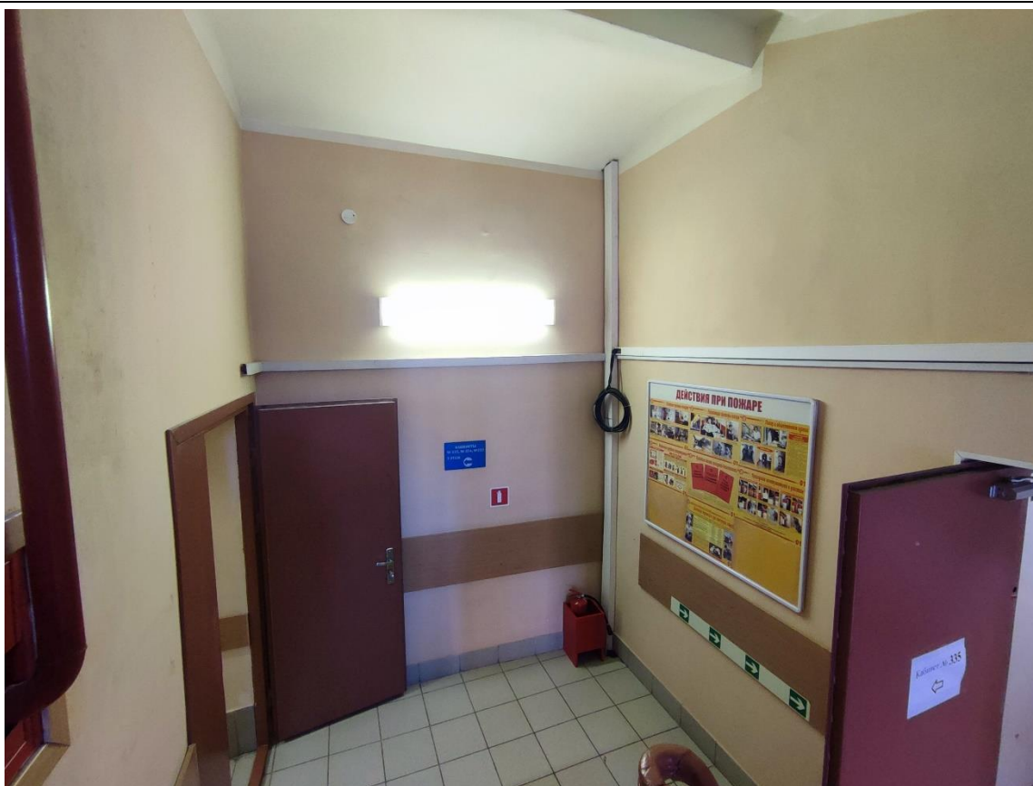
71. Общий вид площадки двухмаршевой лестницы 4ЛК (3) в уровне 3-го этажа.
