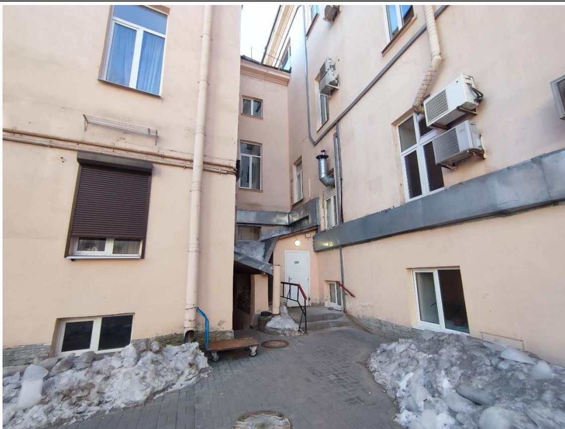
11. Фрагмент северного дворового фасада выявленного объекта культурного наследия «Здание глазной лечебницы В.В. Лерхе».
