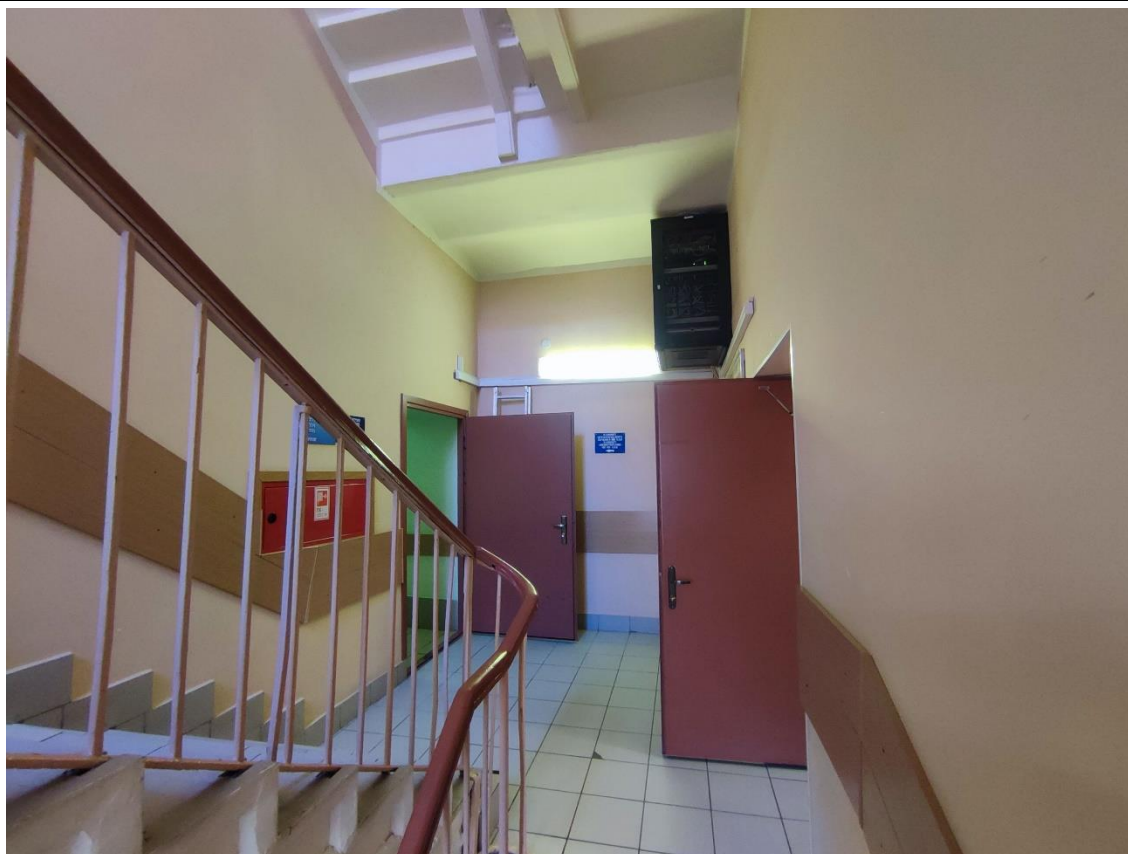
42. Общий вид площадки двухмаршевой лестницы 4ЛК (2) в уровне 2-го этажа.
