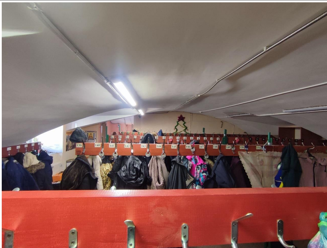
21. Общий вид пом. 7-Н (1) в уровне цокольного этажа.
