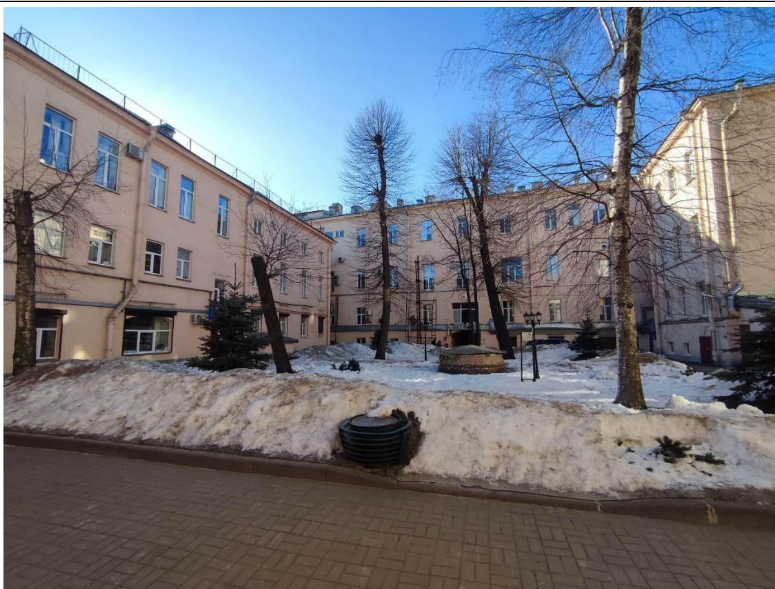
17. Общий вид восточного и южного дворовых фасадов выявленного объекта культурного наследия «Здание глазной лечебницы В.В. Лерхе».
