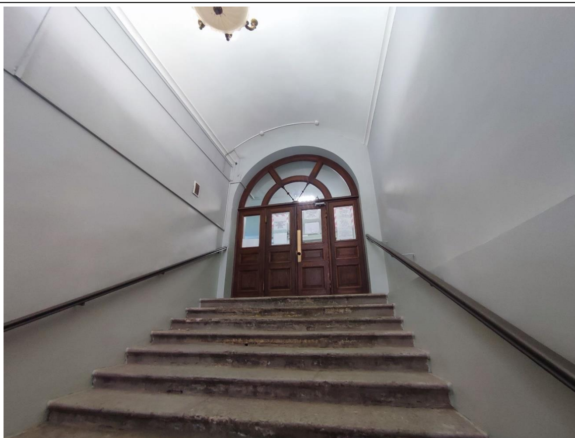
24. Общий вид пом. 1-Н (48) в уровне цокольного этажа.
