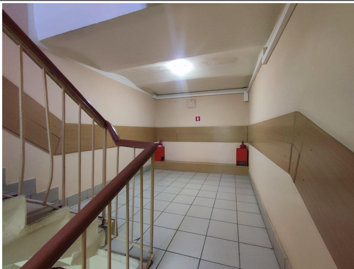
40. Общий вид площадки двухмаршевой лестницы 4ЛК (1) в уровне 1-го этажа.
