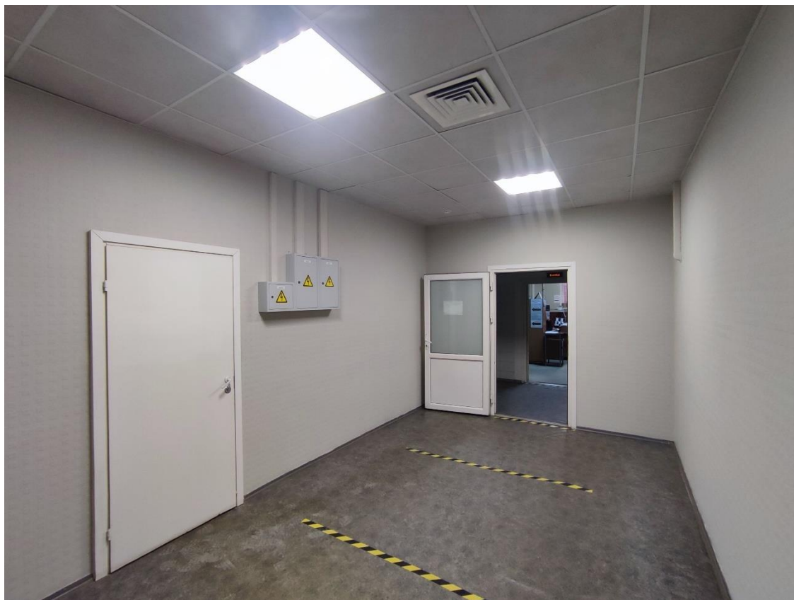
26. Общий вид пом. 1-Н (21) в уровне 2-го этажа.
