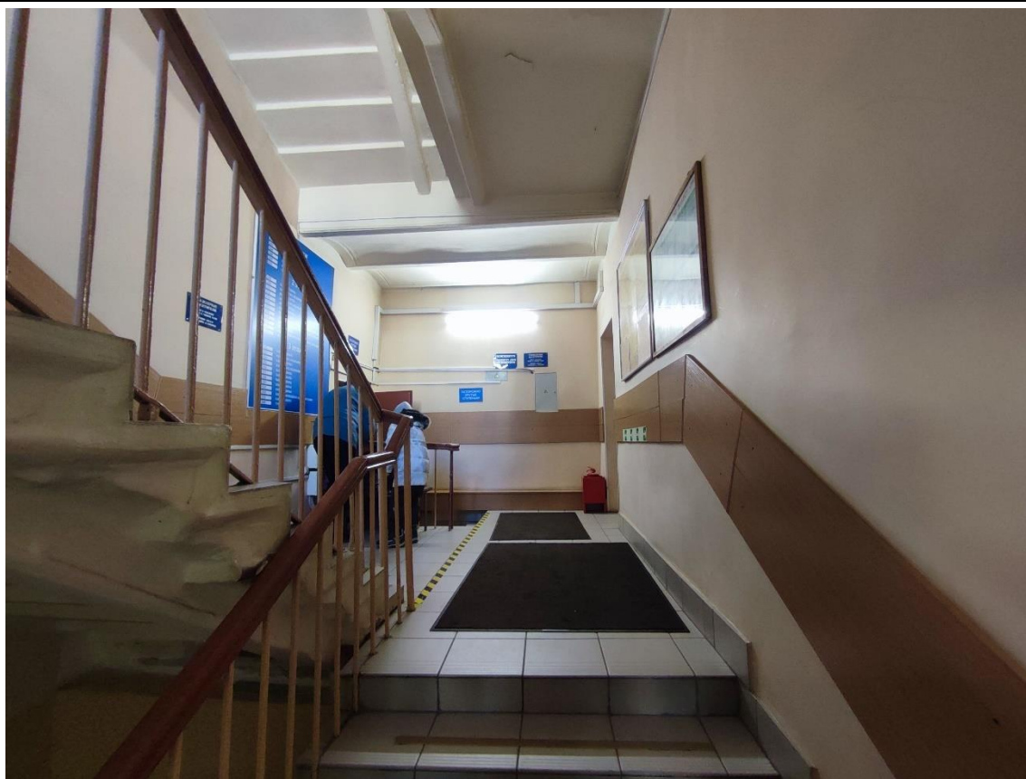
36. Общий вид площадки двухмаршевой лестницы ЗЛК (1) в уровне 1-го этажа.
