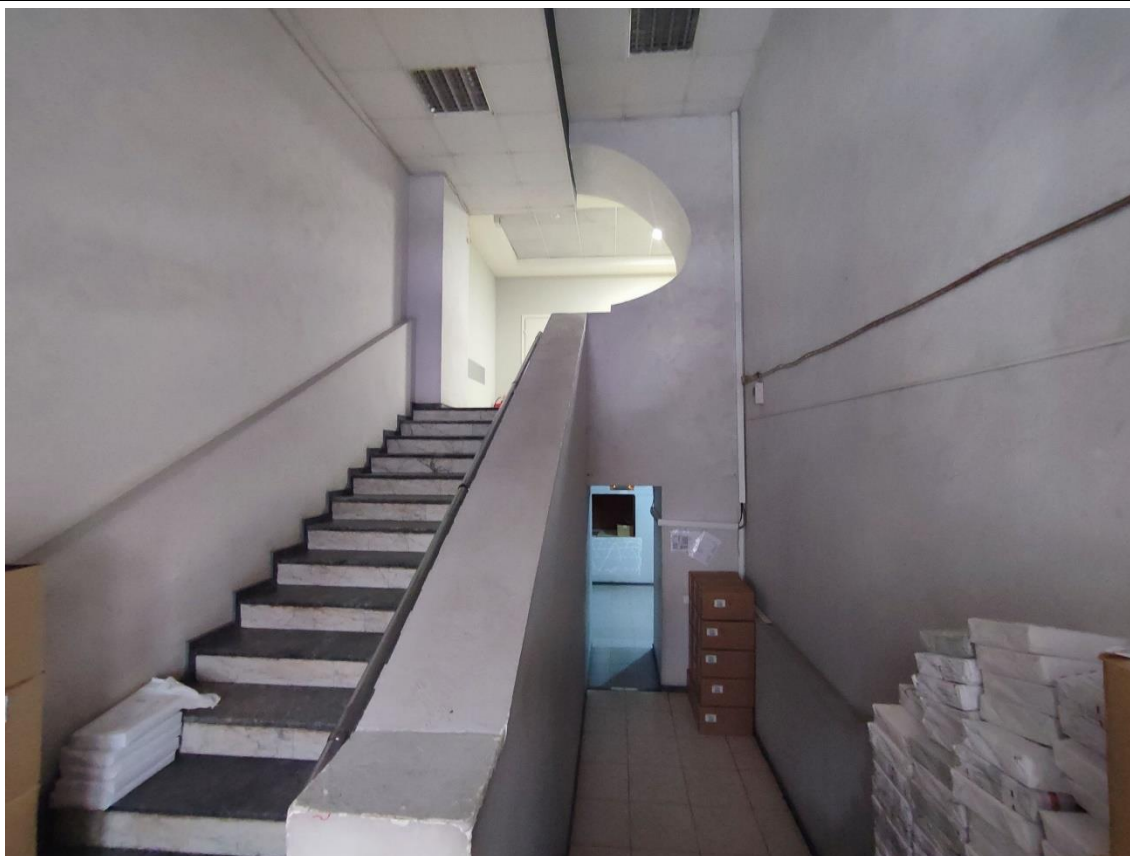
31. Общий вид пом. 1-Н (2) в уровне 2-го этажа.
