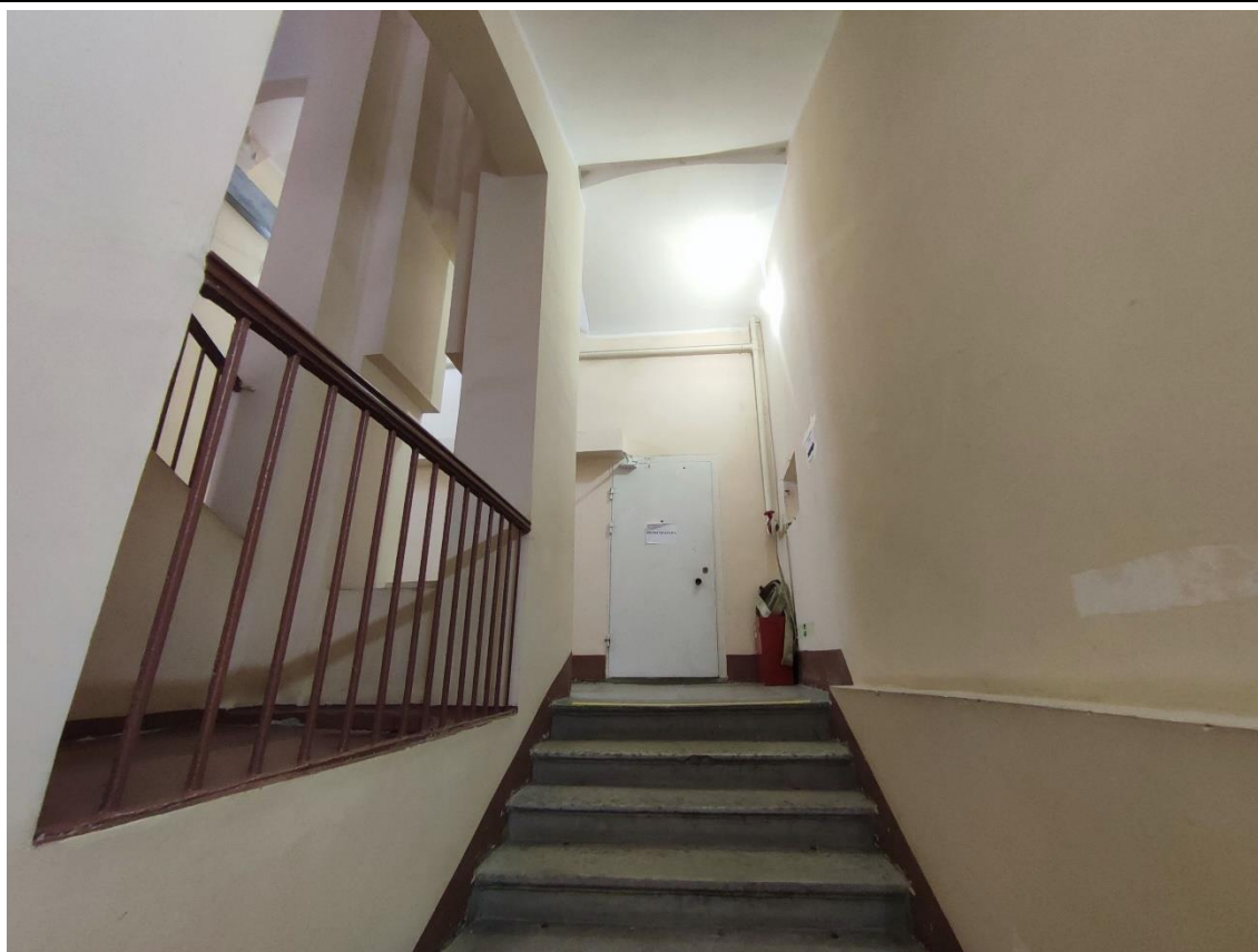
32. Общий вид площадки трехмаршевой лестницы Л-1 в уровне 2-го этажа.
