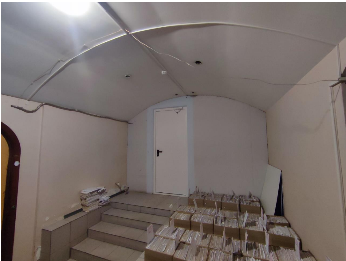
19. Общий вид пом. 3-Н (5, 6) в уровне цокольного этажа.
