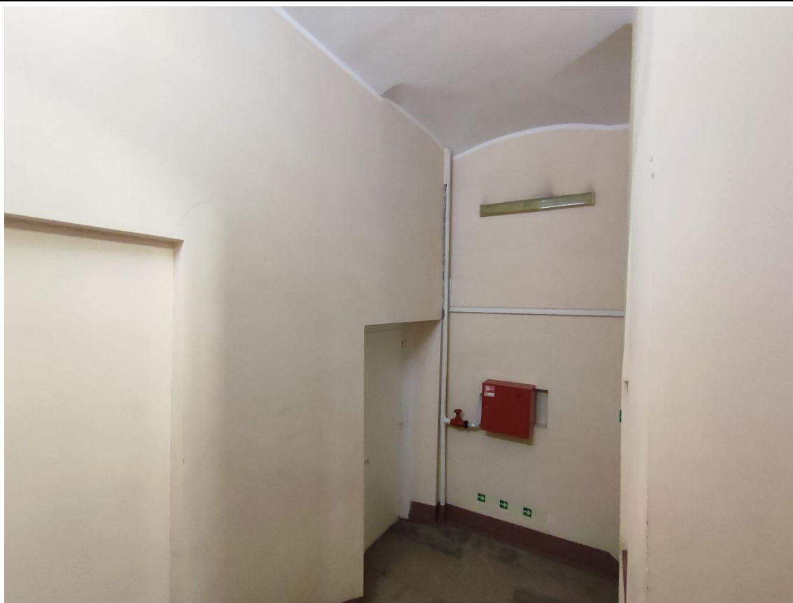
59. Фрагмент площадки трехмаршевой лестницы Л-1 в уровне 3-го этажа.
