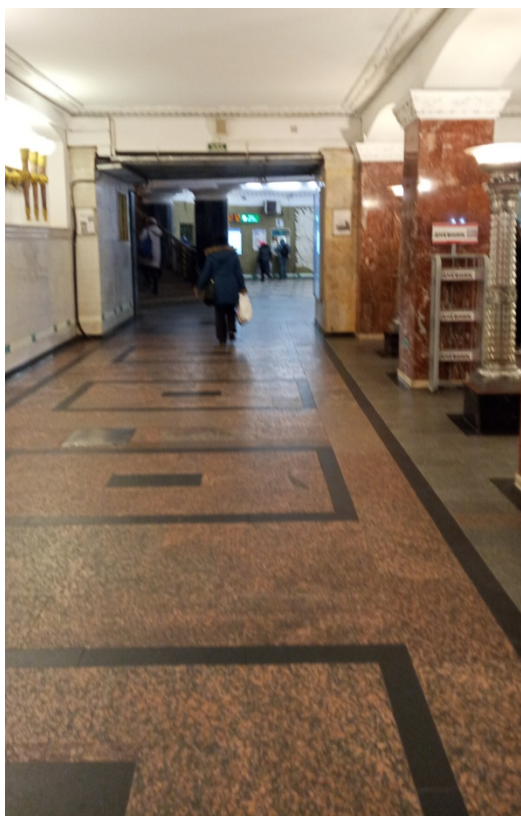
Фото 13. Объект культурного наследия регионального значения «Станция метро «Автово» (с перронным залом)». Вестибюль подземного этажа (коридор, ведущий из аванзала в нижний кассовый зал). Место проектируемого канала инженерных сетей в бетонной стяжке пола.
