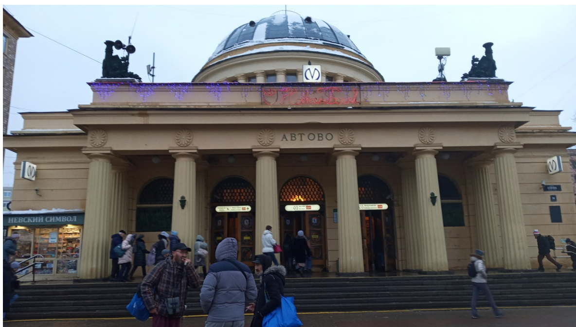
Фото 1. Объект культурного наследия регионального значения «Станция метро «Автово» (с перронным залом)». Вид на лицевой фасад вестибюля с пр. Стачек.
