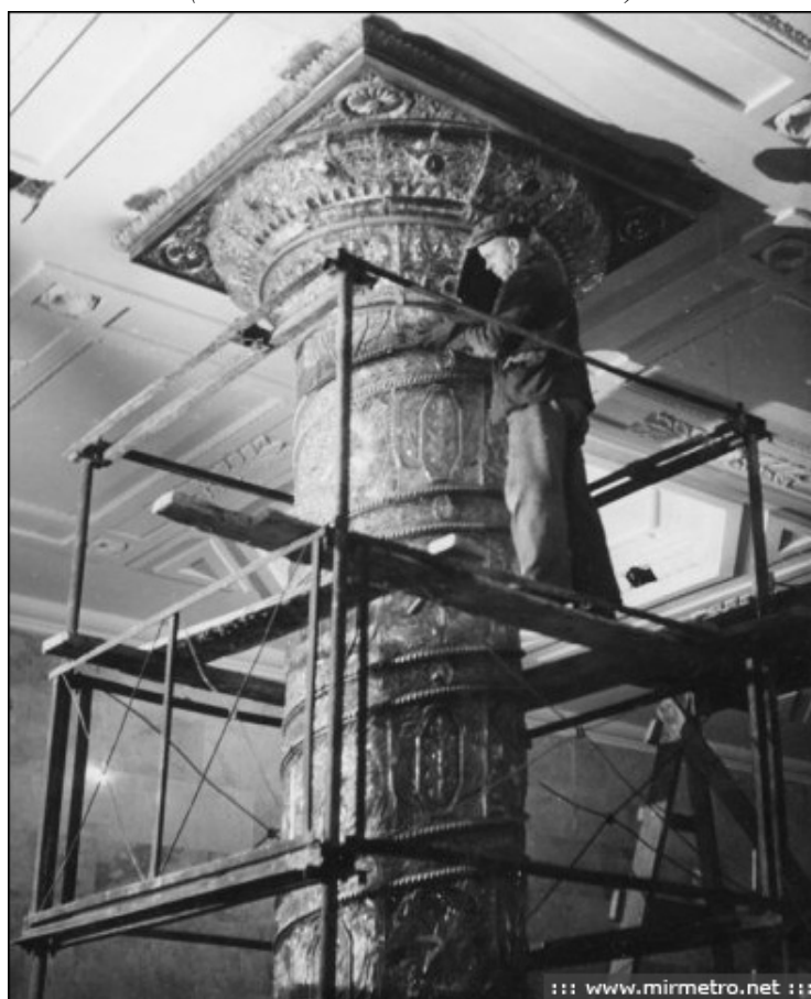
Илл. 12. Монтаж хрустального стекла на капитель колонны. Фото 1955 г. (источник: www.mirmetro.net )
