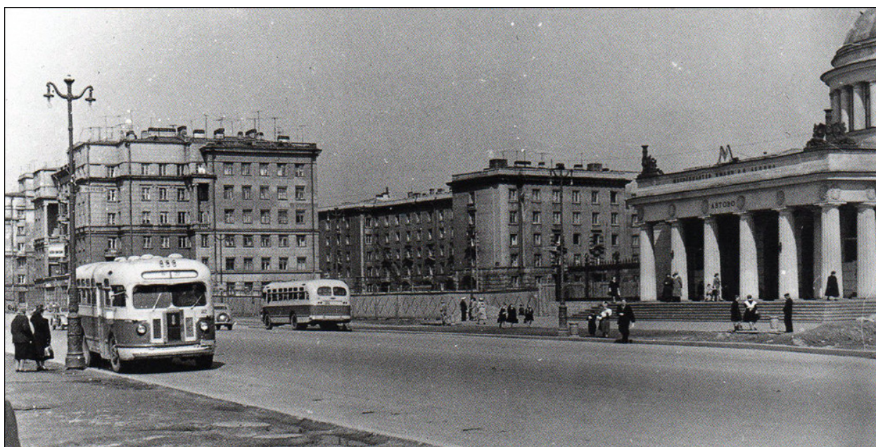
Илл. 30. Наземный павильон. Севернее вестибюля вырос забор ограждающий строительную площадку на месте будущего дома 90 по проспекту Стачек. Фото Ю Шаламова. 1957 г. (источник: www.mirmetro.net )
