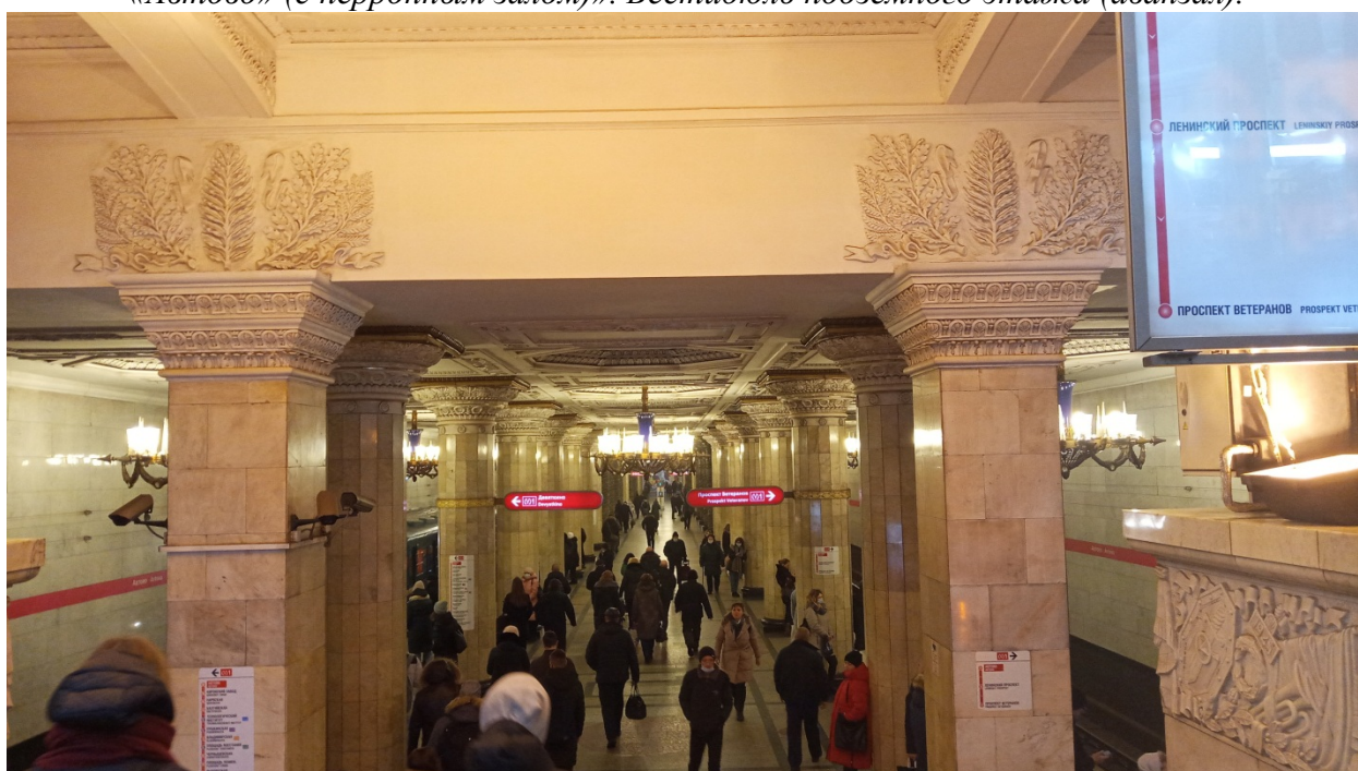
Фото 16. Объект культурного наследия регионального значения «Станция метро «Автово» (с перронным залом)». Перронный зал. Вид на подвесной потолок над перронным залом.
