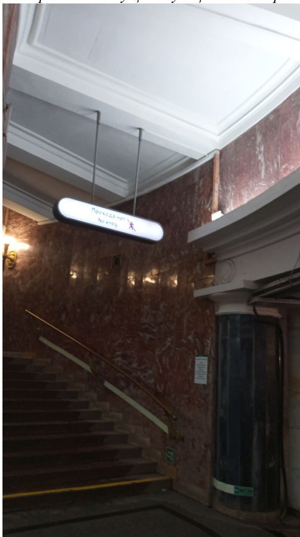
Фото 10. Объект культурного наследия регионального значения «Станция метро «Автово» (с перронным залом)». Лестница из вестибюля подземного этажа на 1 этаж. По стенам наружно проложены существующие инженерные сети в коробах.
