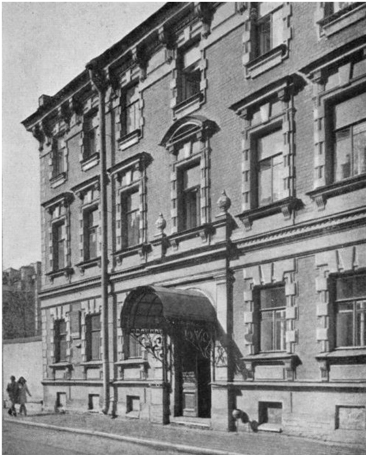
38. Дом, где в 1905-1906 гг. у Книповича Н.М. Ленин Владимир Ильич проводил совещания (кв. 6 и 16 - б. кв. 16). (Стрельнинская ул, д. 2, лит.Б). Угловой фасад дома №2на Стрельнинской улице. ЦГАКФФД СПб Гр 73811 1961 г.
