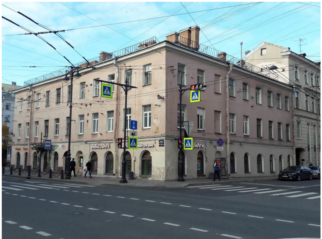
16. Дом П. Панова (Большой пр. П.С., д. 14, лит. А). Штиглиц М.С. 01.09.2020.
