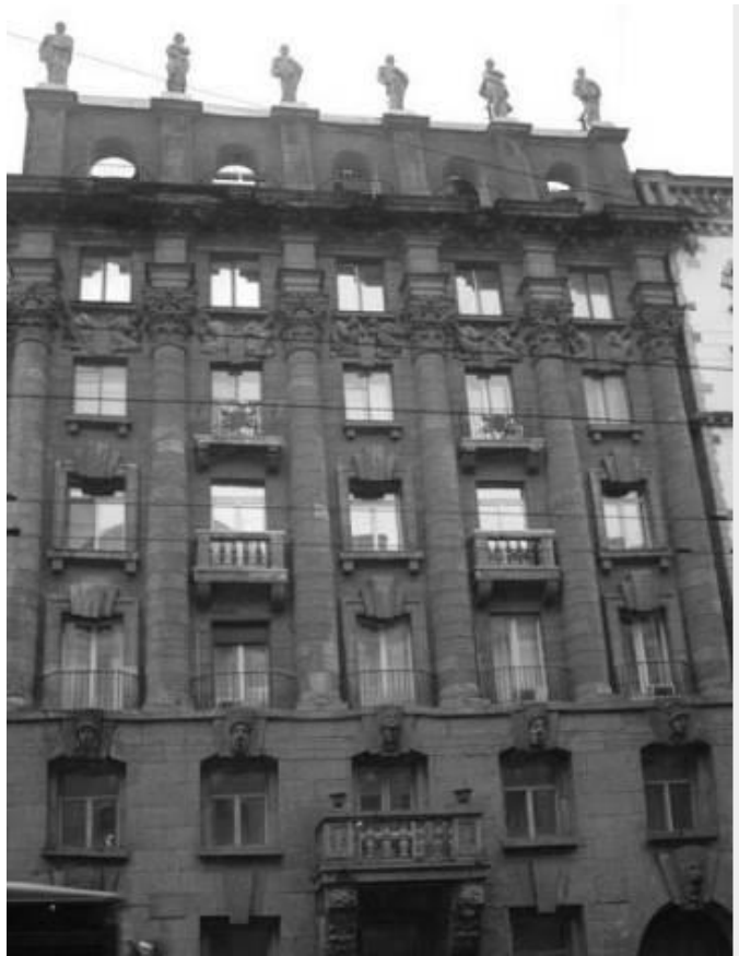
5. Бывш. дом Розенштейна. (Большой пр. П.С., д. 77, лит. А). Фото 2009 г. (19).
