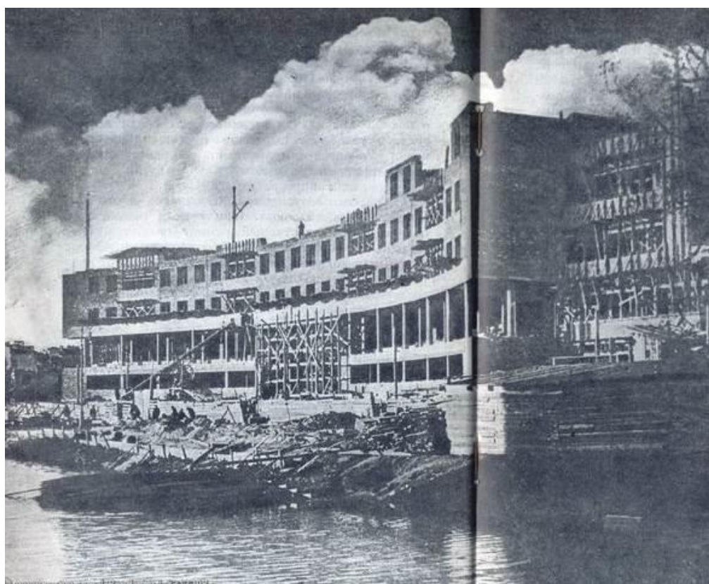
34. Дом жилой Ленсовета Первый (наб. реки Карповки, д. 13, лит. А). В процессе строительства (19).
