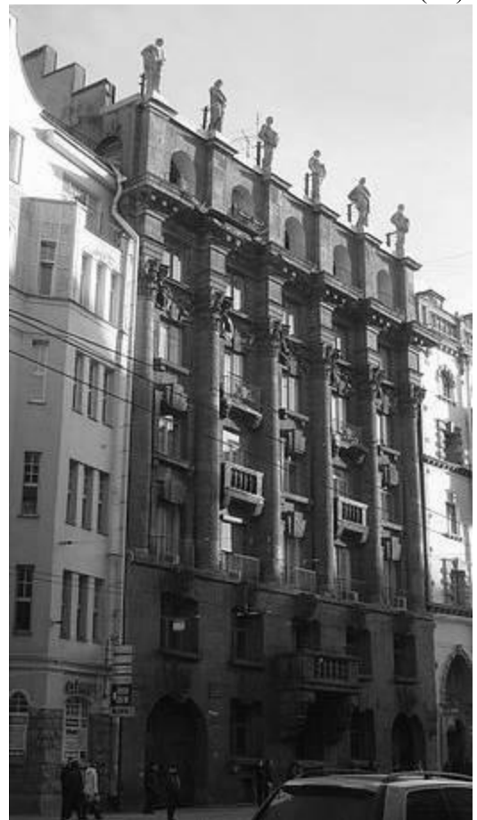
6. Бывш. дом Розенштейна. (Большой пр. П.С., д. 77, лит. А). Фото 2009 г. (19).
