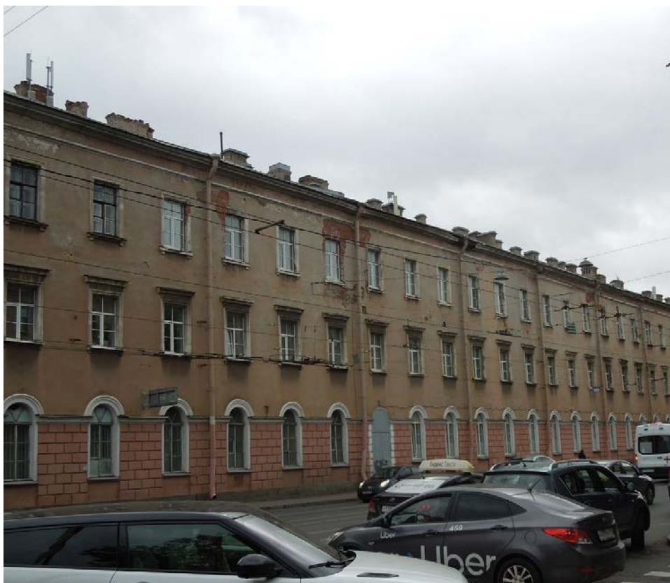
59. Выявленный объект культурного наследия «Пиротехническая школа», входящий в состав выявленного объекта культурного наследия «Комплекс зданий Михайловского военного училища и академии». Лицевой (главный) фасад (по улице Академика Лебедева). Общий вид вдоль фасада.
