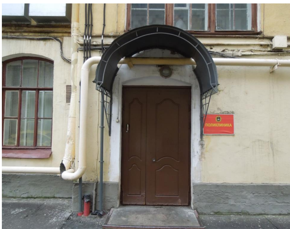
58. Выявленный объект культурного наследия «Орудийный сарай», входящий в состав выявленного объекта культурного наследия «Комплекс зданий Михайловского военного училища и академии». Дворовый фасад. Фрагмент. Современное дверное заполнение под металлическим козырьком на металлических кронштейнах.
