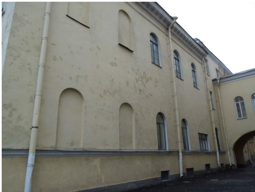
75. Выявленный объект культурного наследия «Лабораторный корпус», входящий в состав выявленного объекта культурного наследия «Комплекс зданий Михайловского военного училища и академии». Восточный фасад.
