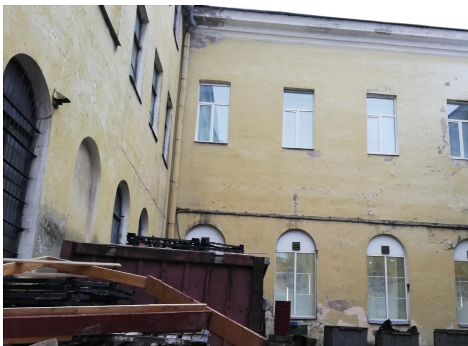
76. Выявленный объект культурного наследия «Лабораторный корпус», входящий в состав выявленного объекта культурного наследия «Комплекс зданий Михайловского военного училища и академии». Северный фасад.
