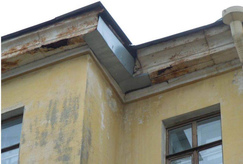
29. Выявленный объект культурного наследия «Главный корпус с 1-м солдатским корпусом, офицерским флигелем и Михайловское артиллерийское училище», входящий в состав выявленного объекта культурного наследия «Комплекс зданий Михайловского военного училища и академии». Дворовый фасад в осях 4-11 по оси Д/2 (оси по проекту). Венчающий карниз. Фрагмент.
