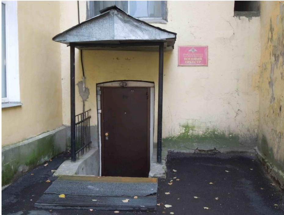
77. Выявленный объект культурного наследия «Лабораторный корпус», входящий в состав выявленного объекта культурного наследия «Комплекс зданий Михайловского военного училища и академии». Современное металлическое дверное заполнение под металлическим козырьком.
