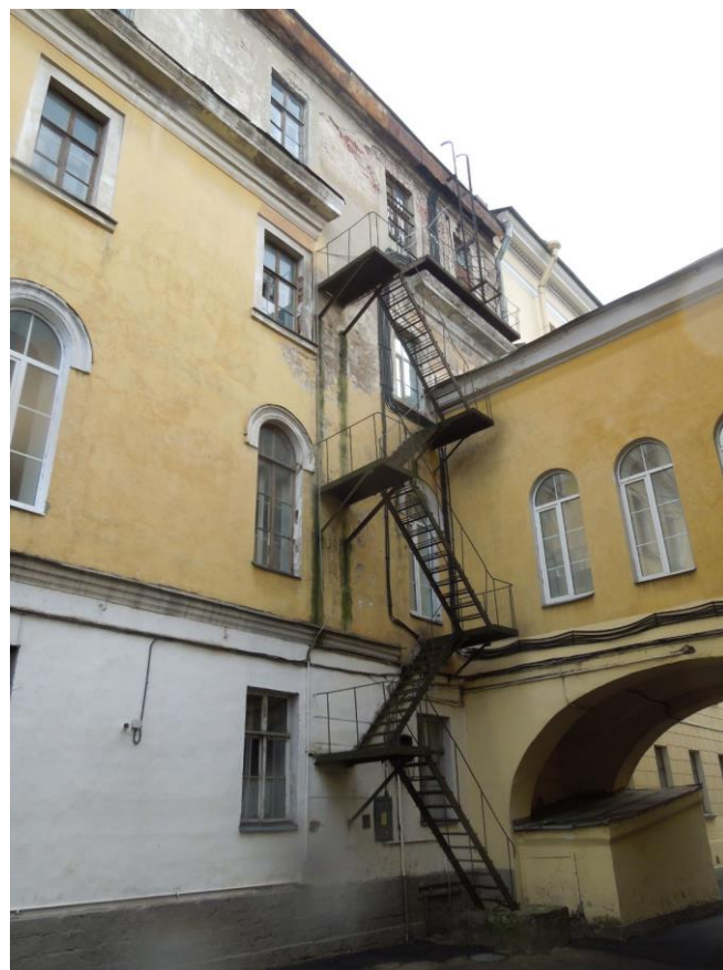
46. Выявленный объект культурного наследия «Главный корпус с 1-м солдатским корпусом, офицерским флигелем и Михайловское артиллерийское училище», входящий в состав выявленного объекта культурного наследия «Комплекс зданий Михайловского военного училища и академии». Дворовый фасад в осях Е-Г/2 по оси 3 (оси по проекту). Фрагмент. Современная металлическая пожарная лестница на фасаде.
