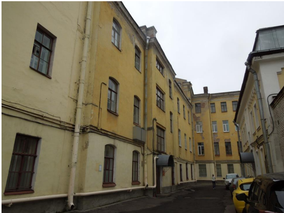
56. Выявленный объект культурного наследия «Орудийный сарай», входящий в состав выявленного объекта культурного наследия «Комплекс зданий Михайловского военного училища и академии». Дворовый фасад. Общий вид.
