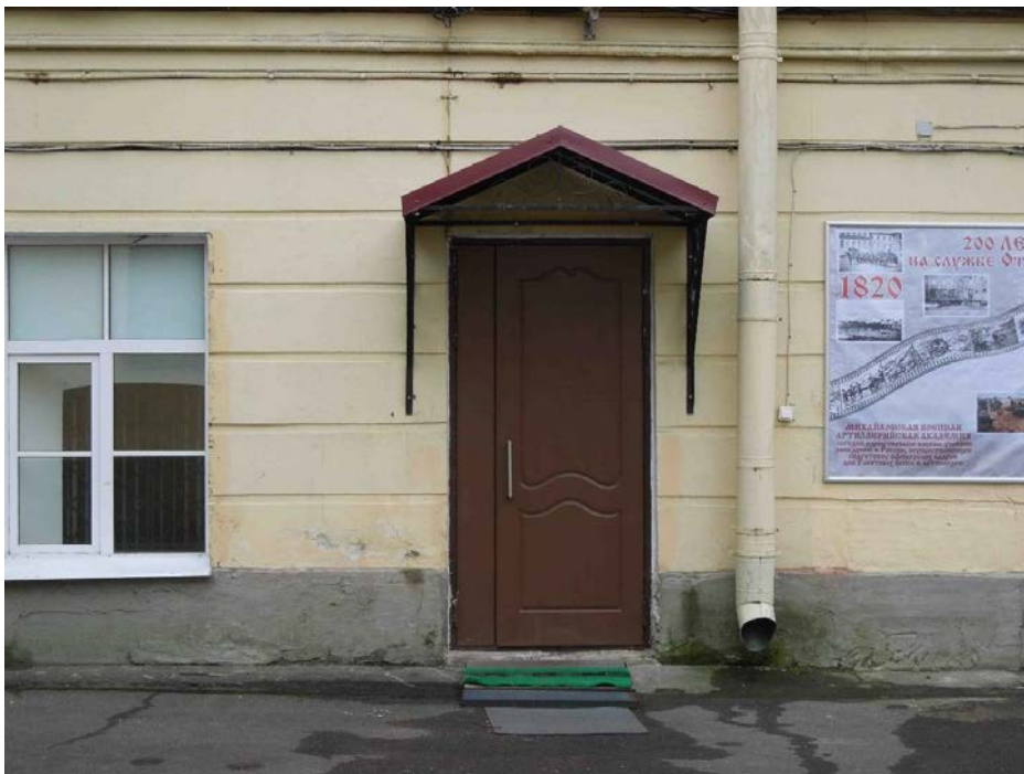
30. Выявленный объект культурного наследия «Главный корпус с 1-м солдатским корпусом, офицерским флигелем и Михайловское артиллерийское училище», входящий в состав выявленного объекта культурного наследия «Комплекс зданий Михайловского военного училища и академии». Дворовый фасад в осях 4-11 по оси Д/2 (оси по проекту). Современное металлическое дверное заполнение.
