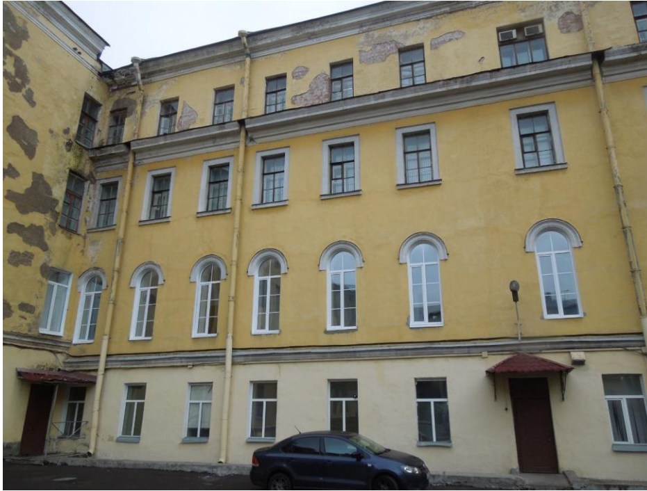
43. Выявленный объект культурного наследия «Главный корпус с 1-м солдатским корпусом, офицерским флигелем и Михайловское артиллерийское училище», входящий в состав выявленного объекта культурного наследия «Комплекс зданий Михайловского военного училища и академии». Дворовый фасад в осях Е-Г/2 по оси 3 (оси по проекту). Общий вид фасада.
