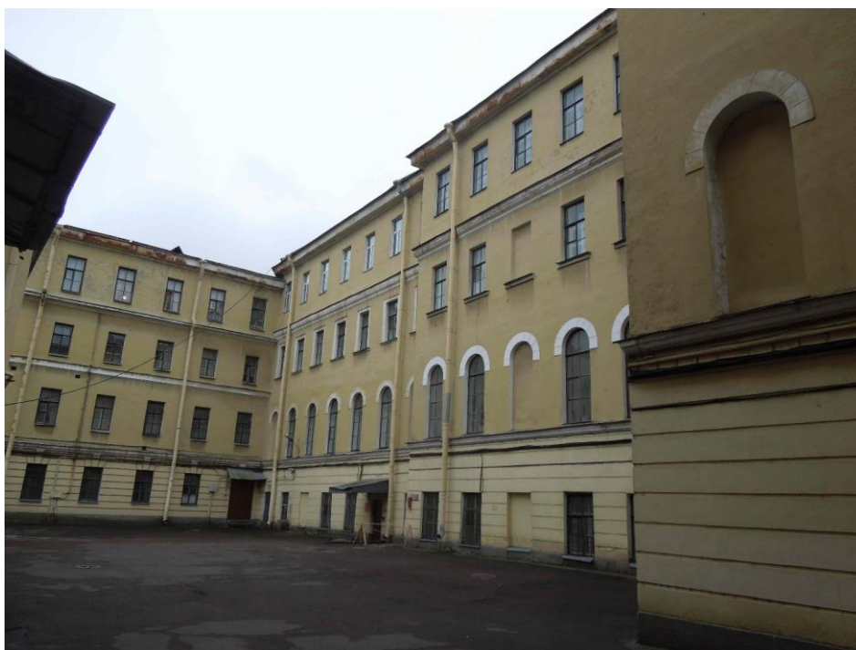
28. Выявленный объект культурного наследия «Главный корпус с 1-м солдатским корпусом, офицерским флигелем и Михайловское артиллерийское училище», входящий в состав выявленного объекта культурного наследия «Комплекс зданий Михайловского военного училища и академии». Дворовый фасад в осях 4-11 по оси Д/2 (оси по проекту). Общий вид.
