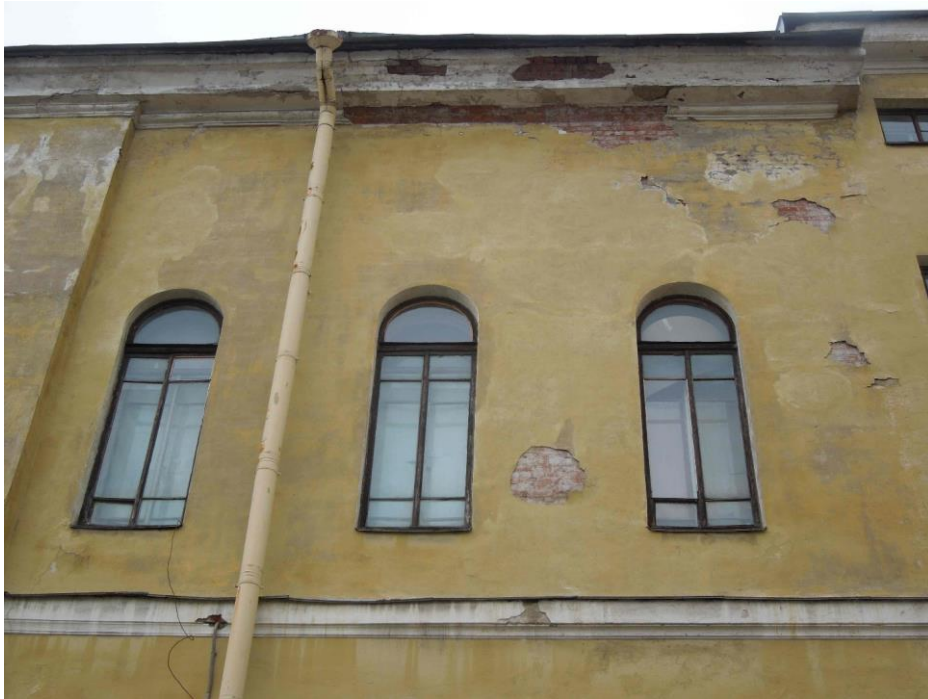
39. Выявленный объект культурного наследия «Главный корпус с 1-м солдатским корпусом, офицерским флигелем и Михайловское артиллерийское училище», входящий в состав выявленного объекта культурного наследия «Комплекс зданий Михайловского военного училища и академии». Дворовый фасад в осях 4-11 по оси Е (оси по проекту). Фрагмент. Арочные оконные проемы.
