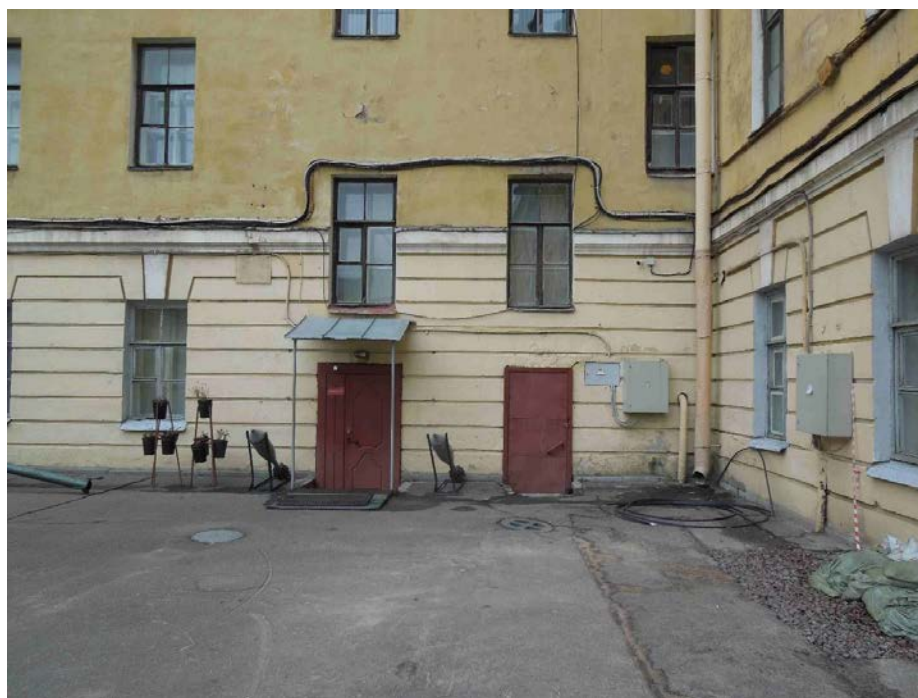
40. Выявленный объект культурного наследия «Главный корпус с 1-м солдатским корпусом, офицерским флигелем и Михайловское артиллерийское училище», входящий в состав выявленного объекта культурного наследия «Комплекс зданий Михайловского военного училища и академии». Дворовый фасад в осях 4-11 по оси Е (оси по проекту). Фрагмент. Современные металлические дверные заполнения.
