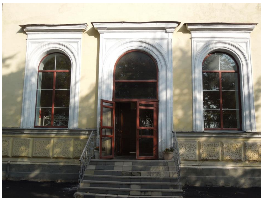
72. Выявленный объект культурного наследия «Лабораторный корпус», входящий в состав выявленного объекта культурного наследия «Комплекс зданий Михайловского военного училища и академии». Главный фасад. Арочный проем главного входа с лестницей, облицованной современной керамической плиткой. Дверное заполнение современное (металлопластиковое).
