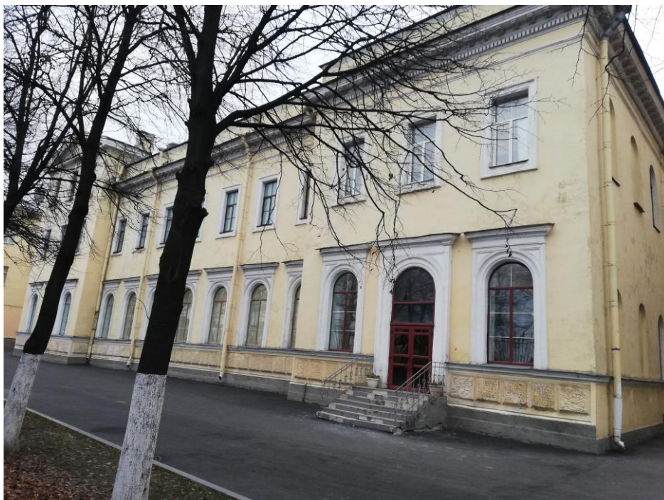
71. Выявленный объект культурного наследия «Лабораторный корпус», входящий в состав выявленного объекта культурного наследия «Комплекс зданий Михайловского военного училища и академии». Главный фасад.
