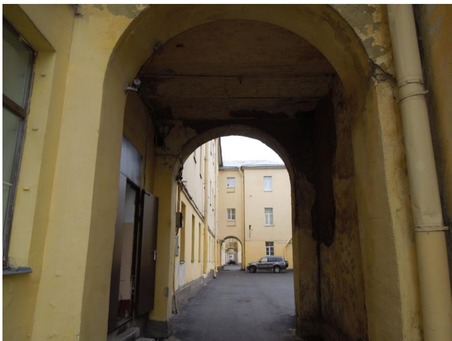
69. Выявленный объект культурного наследия «Пиротехническая школа», входящий в состав выявленного объекта культурного наследия «Комплекс зданий Михайловского военного училища и академии». Дворовый фасад. Вид вдоль фасада. Арочный проезд.
