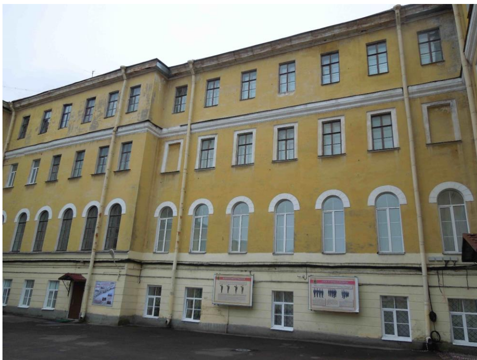
27. Выявленный объект культурного наследия «Главный корпус с 1-м солдатским корпусом, офицерским флигелем и Михайловское артиллерийское училище», входящий в состав выявленного объекта культурного наследия «Комплекс зданий Михайловского военного училища и академии». Дворовый фасад в осях 4-11 по оси Д/2 (оси по проекту). Общий вид.
