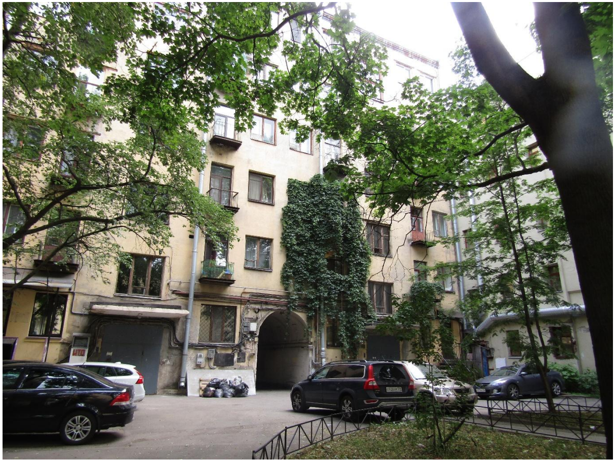
Рис. 7 Общий вид на дворовой фасад
