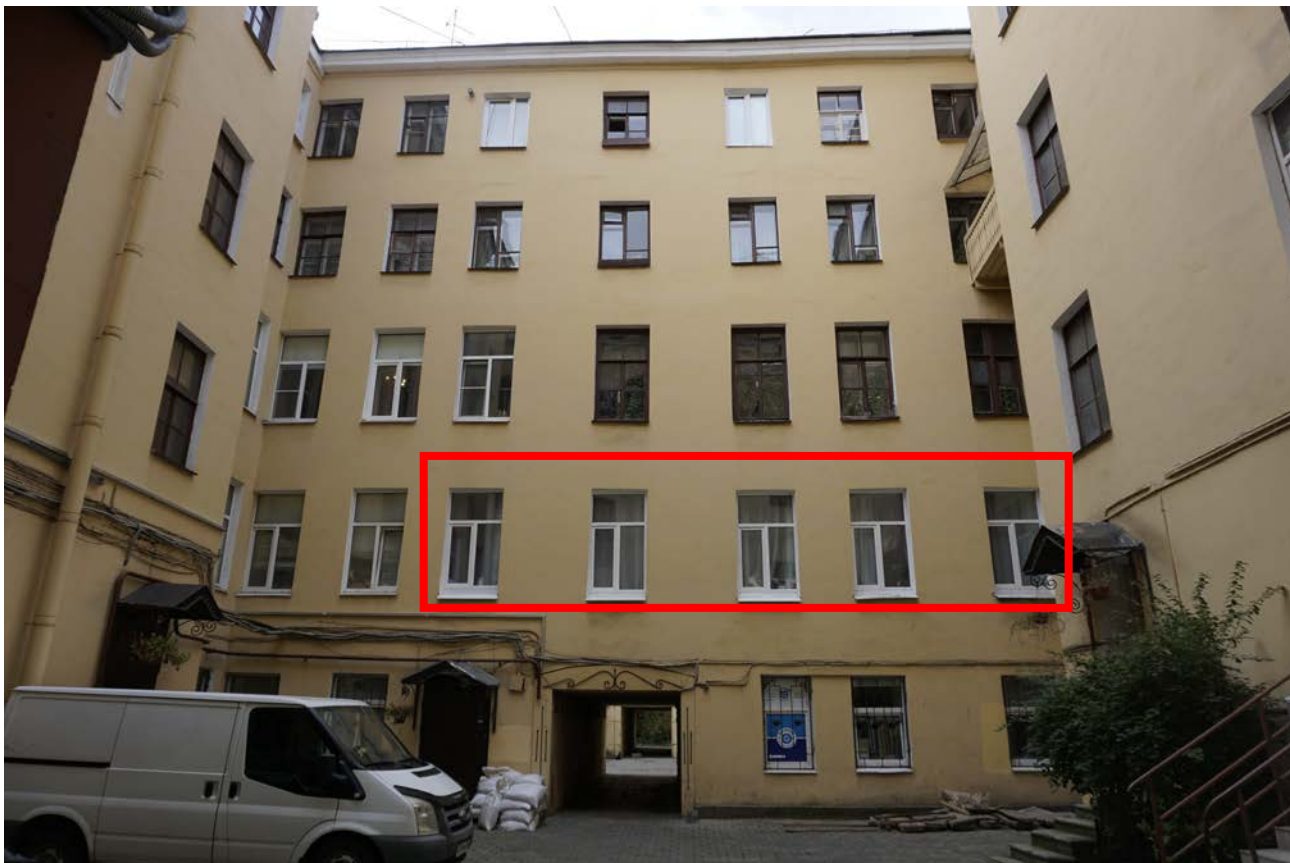
Фото 4. Оконные проемы квартиры № 34. Дворовый фасад.
