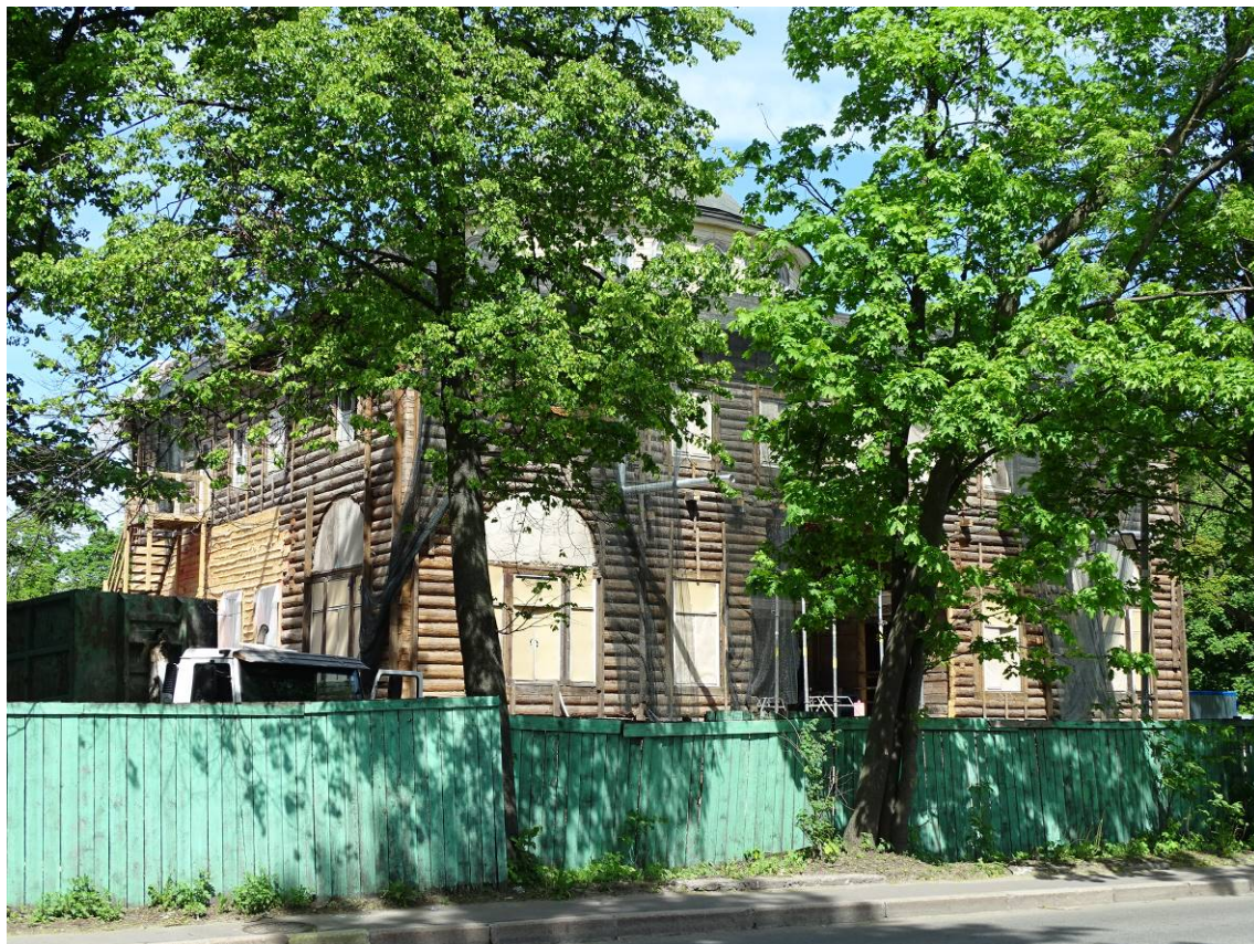
Фото 18. Объект культурного наследия федерального значения «Дача Долгорукова В.В. (принца Ольденбургского П.Г.)». Вид с наб. реки Малой Невки. Съемка Трушковский В.Э. 31.05.2021 г.
