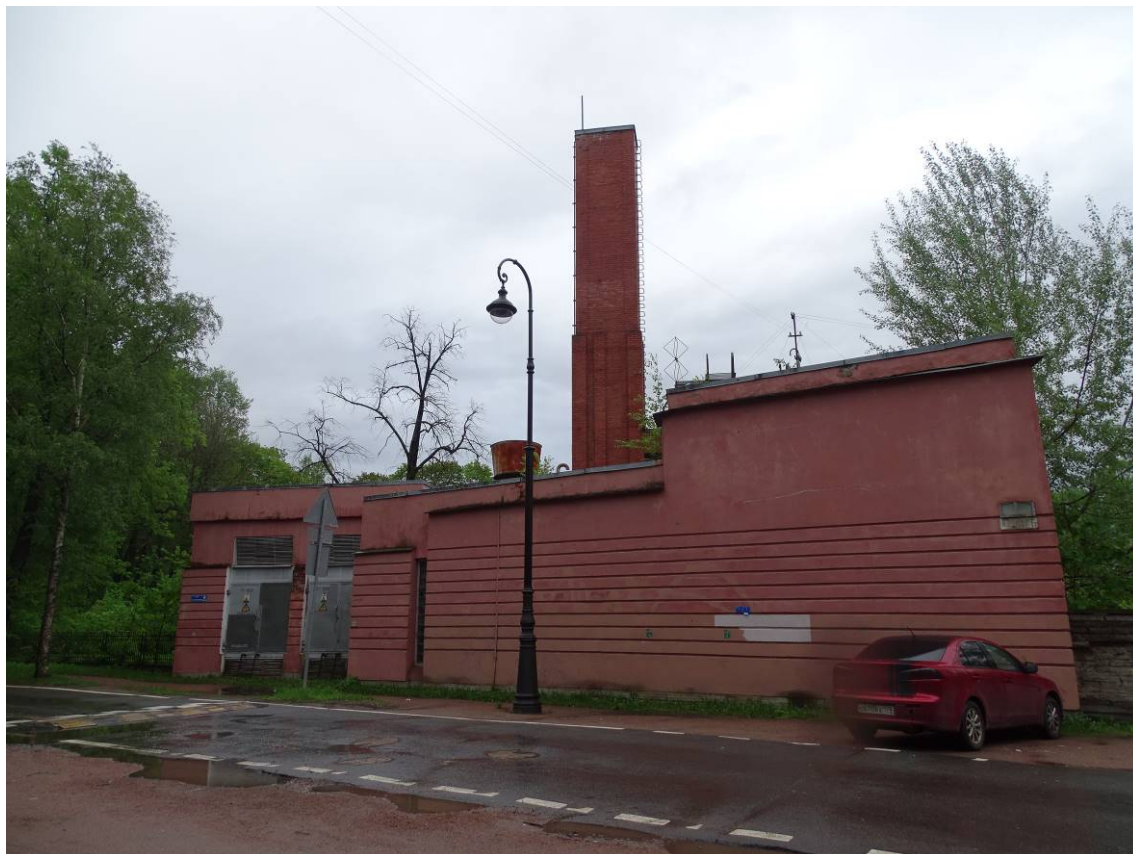
Фото 3. Здание по адресу: 1-я Березовая аллея, дом 6, литера Б. Северный фасад.
