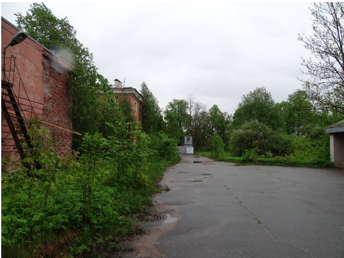
Фото 6. Вид на территорию с северной стороны. Съемка Трушковский В.Э.21.05.2021 г.
