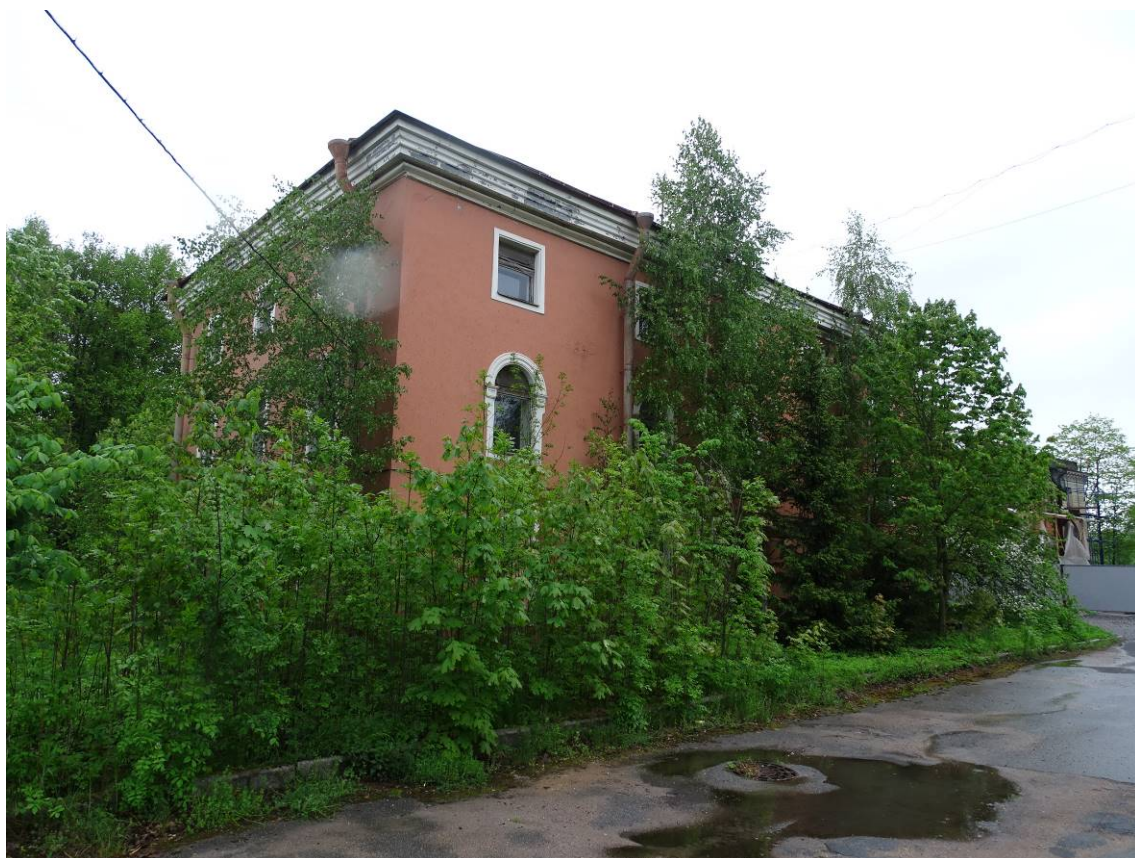
Фото 9. Здание по адресу: наб. реки Малой Невки, дом 13, литера А. Съемка Трушковский В.Э.21.05.2021 г.
