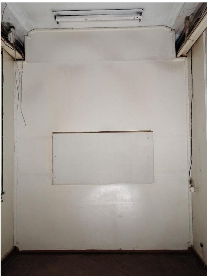
Фото 5. Помещение 5.175. Перегородка, выделяющая часть помещения в объёме коридора с сохранением тяги по периметру потолка.
