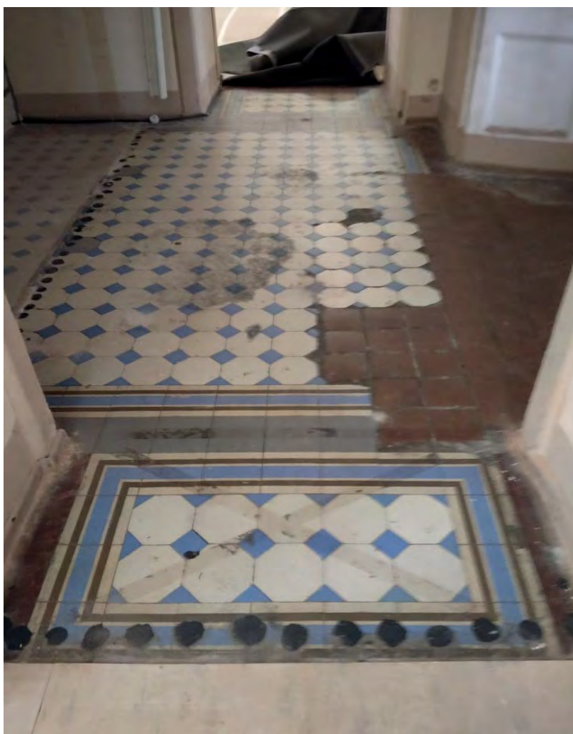
16. Объект культурного наследия «Дворец», входящий в состав объекта культурного наследия федерального значения «Дворец Воронцова М.И. (Пажеский корпус)», по адресу: Санкт-Петербург, ул. Садовая, д. 26, литеры А, Д (Садовая ул., 26; Ломоносова ул., 6, 8, 10). Помещение №11. Общий вид с показом отделки пола метлахской плиткой. Дата фотофиксации: 21 мая 2021 г.
