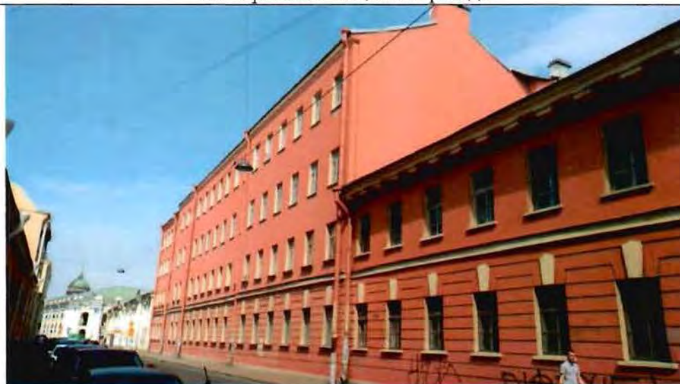
20. Фрагмент лицевого фасада
