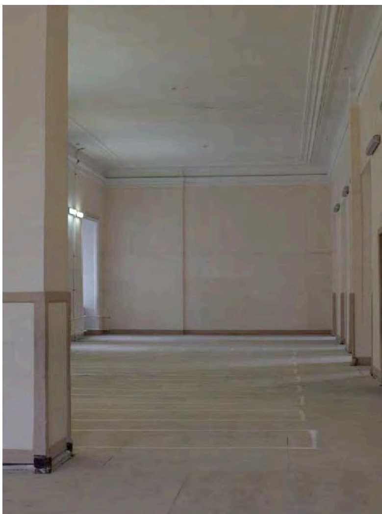
10. Объект культурного наследия «Дворец», входящий в состав объекта культурного наследия федерального значения «Дворец Воронцова М.И. (Пажеский корпус)», по адресу: Санкт-Петербург, ул. Садовая, д. 26, литеры А, Д (Садовая ул., 26; Ломоносова ул., 6, 8, 10). Помещение №7. Общий вид помещения. Дата фотофиксации: 21 мая 2021 г.
