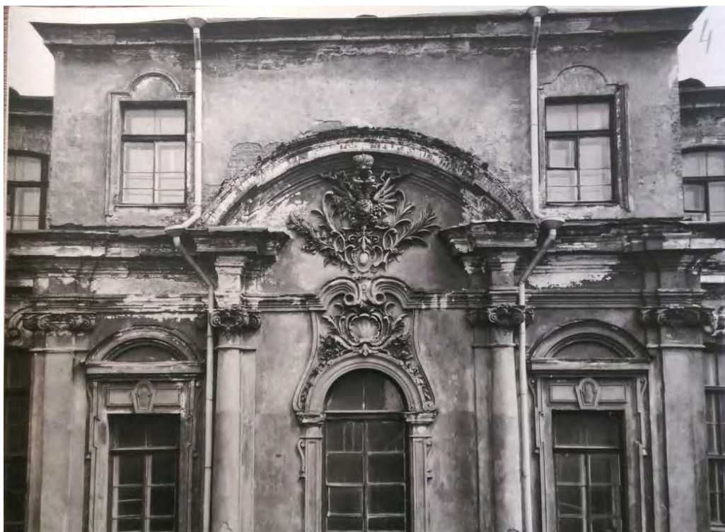
42. Воронцовский дворец. Фрагмент бокового фасада. 1950-е гг. (Архив КГИОП).
