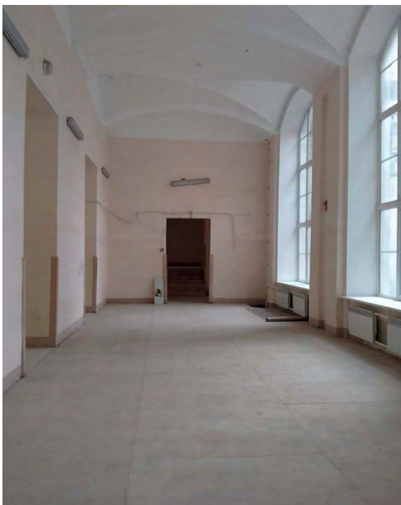
11. Объект культурного наследия «Дворец», входящий в состав объекта культурного наследия федерального значения «Дворец Воронцова М.И. (Пажеский корпус)», по адресу: Санкт-Петербург, ул. Садовая, д. 26, литеры А, Д (Садовая ул., 26; Ломоносова ул., 6, 8, 10). Помещение №8. Общий вид помещения. Дата фотофиксации: 21 мая 2021 г.
