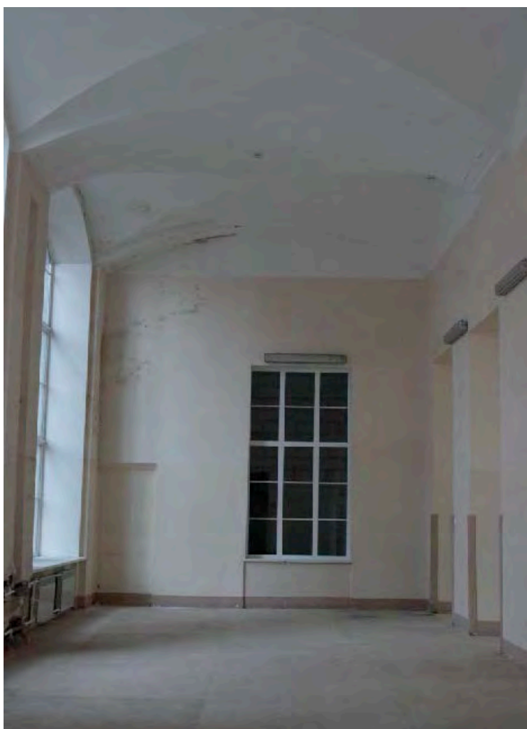
12. Объект культурного наследия «Дворец», входящий в состав объекта культурного наследия федерального значения «Дворец Воронцова М.И. (Пажеский корпус)», по адресу: Санкт-Петербург, ул. Садовая, д. 26, литеры А, Д (Садовая ул., 26; Ломоносова ул., 6, 8, 10). Помещение №8. Общий вид помещения. Дата фотофиксации: 21 мая 2021 г.
