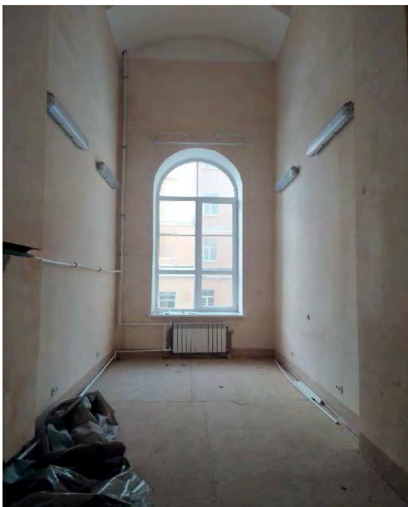
13. Объект культурного наследия «Дворец», входящий в состав объекта культурного наследия федерального значения «Дворец Воронцова М.И. (Пажеский корпус)», по адресу: Санкт-Петербург, ул. Садовая, д. 26, литеры А, Д (Садовая ул., 26; Ломоносова ул., 6, 8, 10). Помещение №9. Общий вид помещения. Дата фотофиксации: 21 мая 2021 г.
