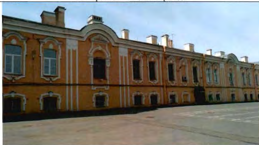
23. Фрагмент лицевого фасада
