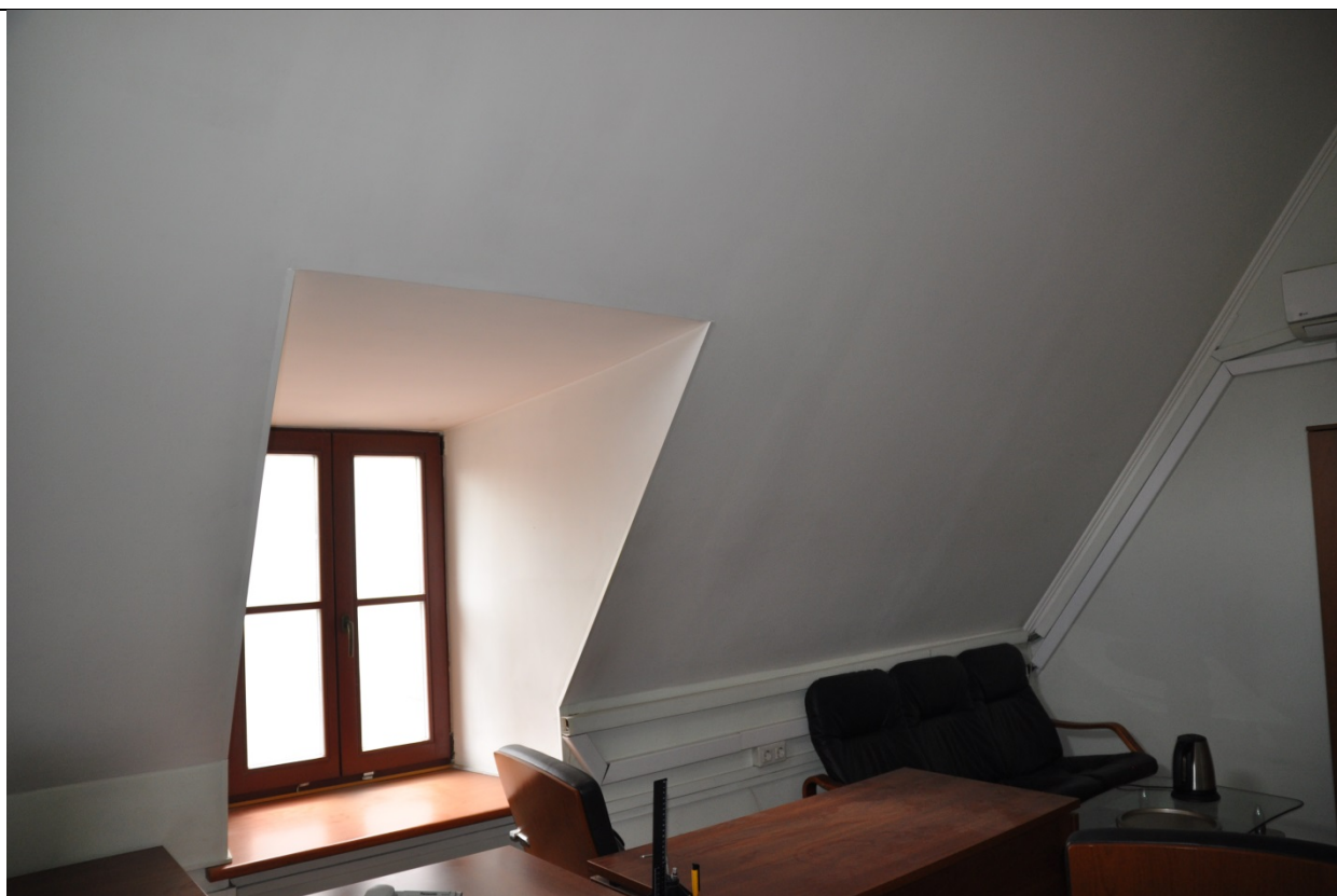
Фото 78. Помещение №24 в осях 3-5. (23.09.2020 г.)
