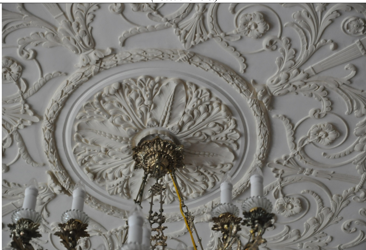
Фото 48. Помещение №8 в осях 2-3. Лепная розетка плафона. (23.09.2020 г.)
