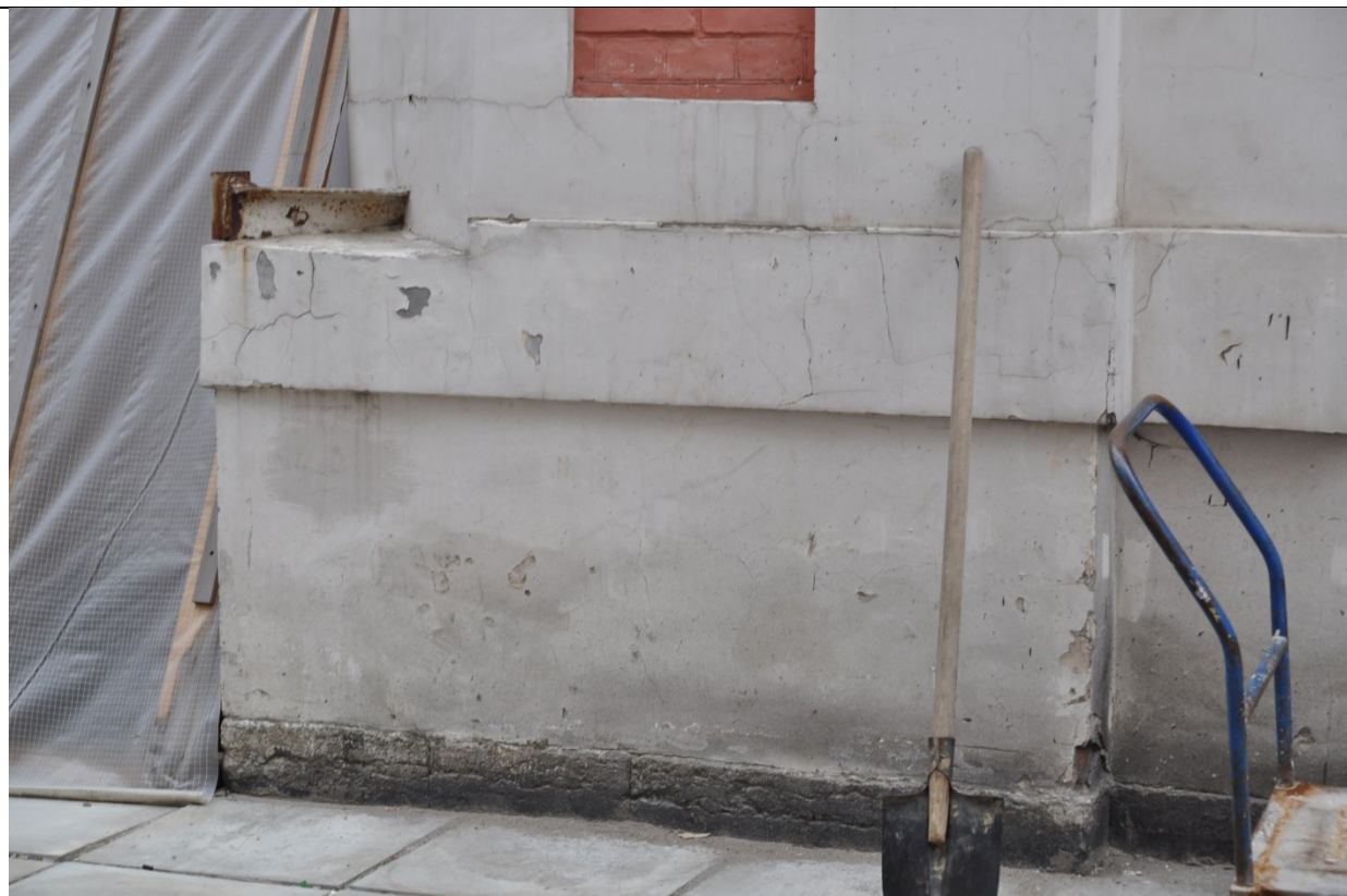
Фото 27. Фрагмент Юго-Западного фасада на уровне цокольного этажа в осях В-А. (23.09.2020 г.)
