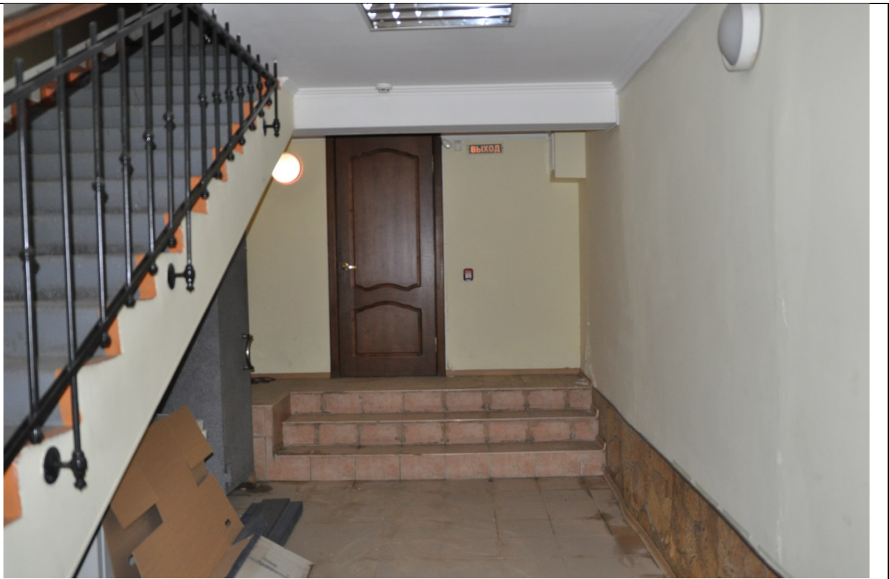
Фото 97. Подлестничное пространство в осях 4-5 – эвакуационный выход. (23.09.2020 г.)
