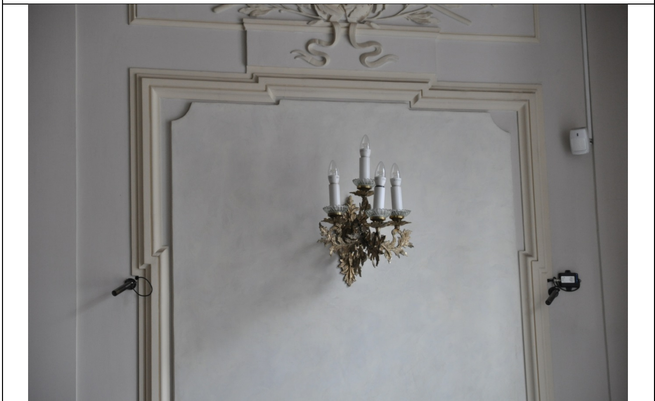
Фото 44. Помещение №8 в осях 2-3. (23.09.2020 г.)
