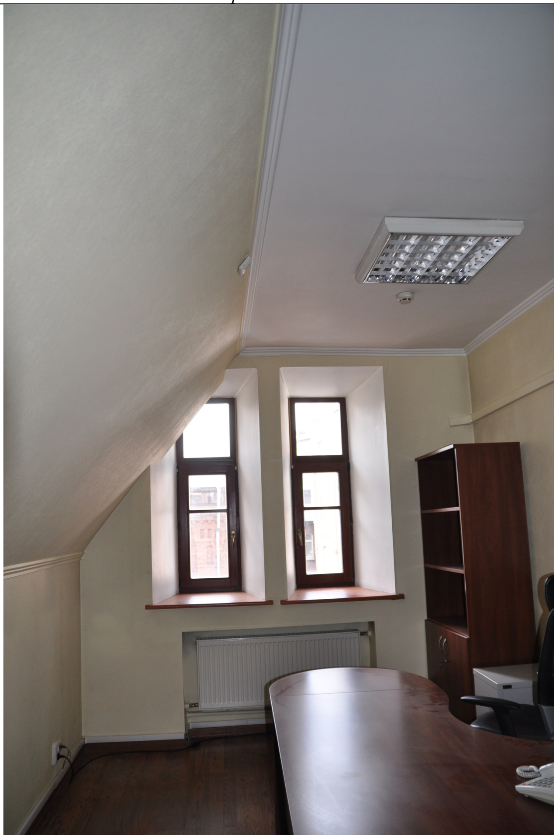
Фото 76. Помещение № 16 в осях 4-5. (23.09.2020 г.)
