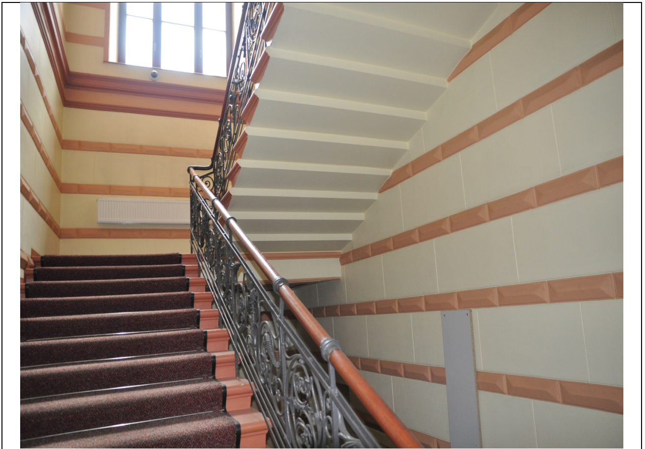
Фото 61. Вид на парадную лестницу в осях 4-5. (23.09.2020 г.)
