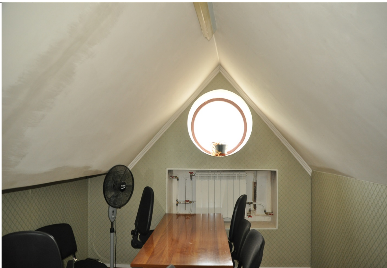
Фото 83. Помещение №22 в осях 1-3. (23.09.2020 г.)
