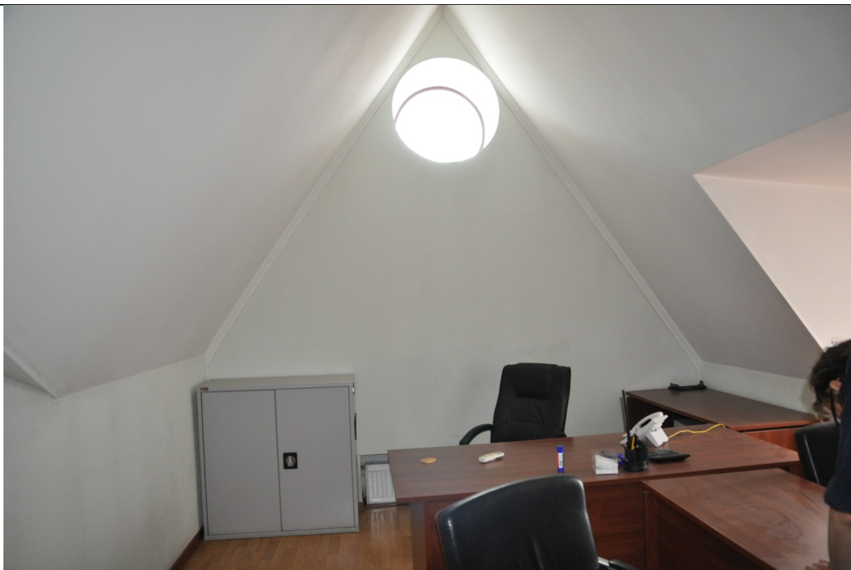
Фото 77. Помещение №24 в осях 3-5. (23.09.2020 г.)
