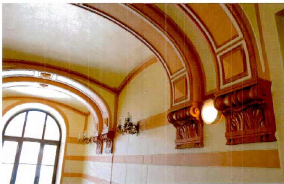
Фото №6. Перекрытие парадной лестницы.
