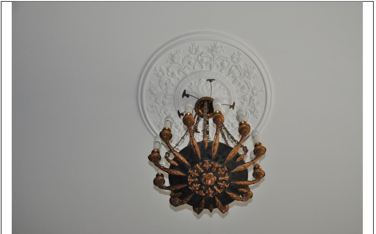
Фото 53. Помещение №7 в осях 1-2. Лепная розетка потолка(23.09.2020 г.)
