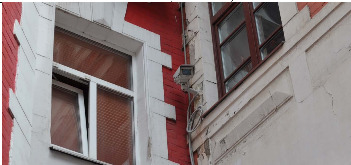
Фото 22. Фрагмент Северо-Западного дворового фасада на уровне второго этажа в осях 1-6. (23.09.2020 г.)
