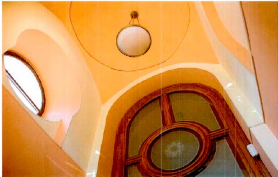
Фото №3. Тамбур главного входа.
