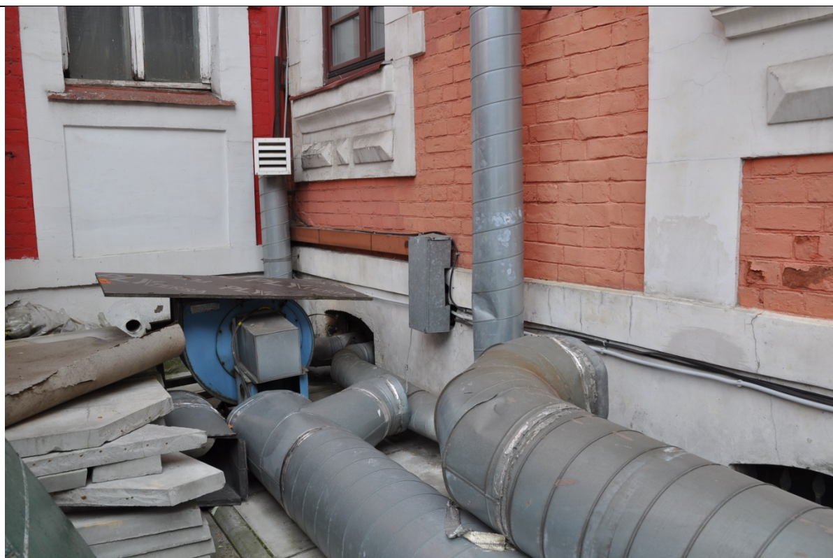
Фото 18. Фрагмент Северо-Западного фасада в осях 1-6 на уровне цокольного этажа. (23.09.2020 г.)
