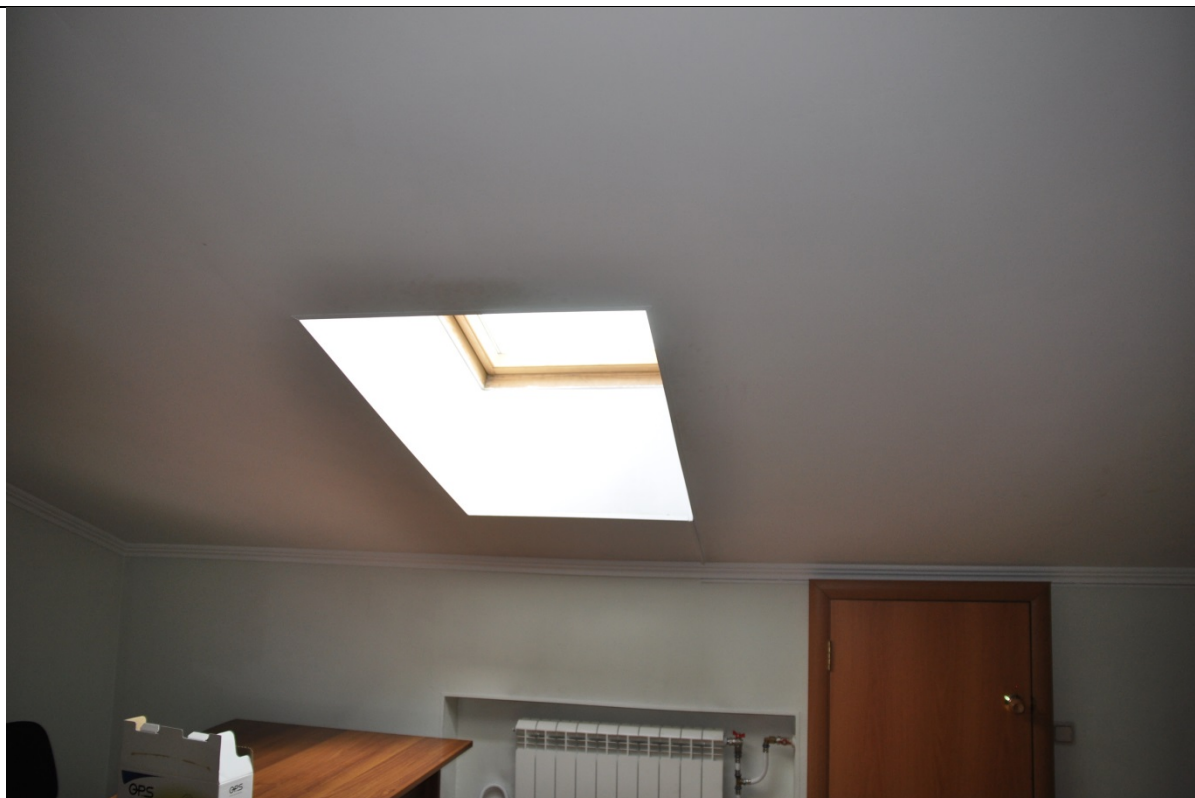
Фото 79. Помещение №23 в осях 2-3. (23.09.2020 г.)
