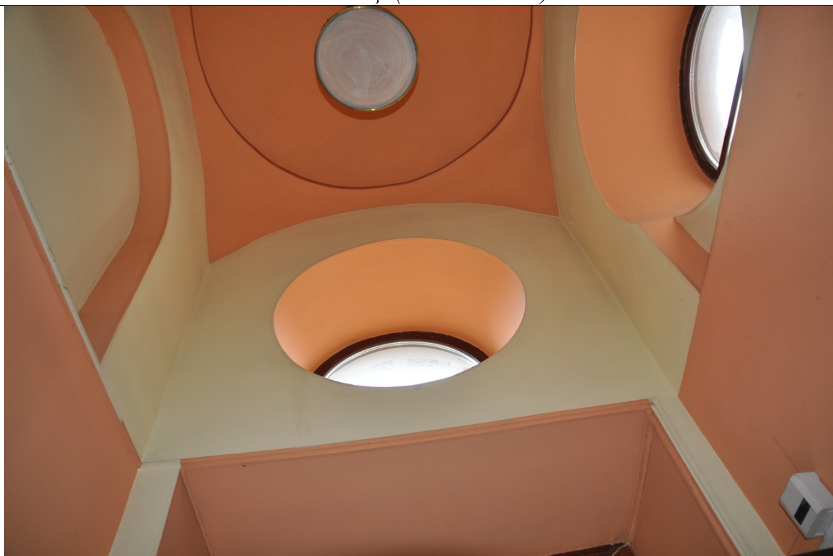
Фото 59. Помещение №1 – тамбур в осях 4-5. Парусный свод тамбура. (23.09.2020 г.)
