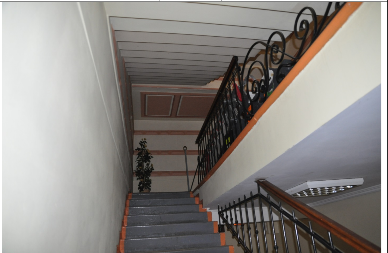
Фото 98. Лестничный марш в подвал в осях 4-5. (23.09.2020 г.)
