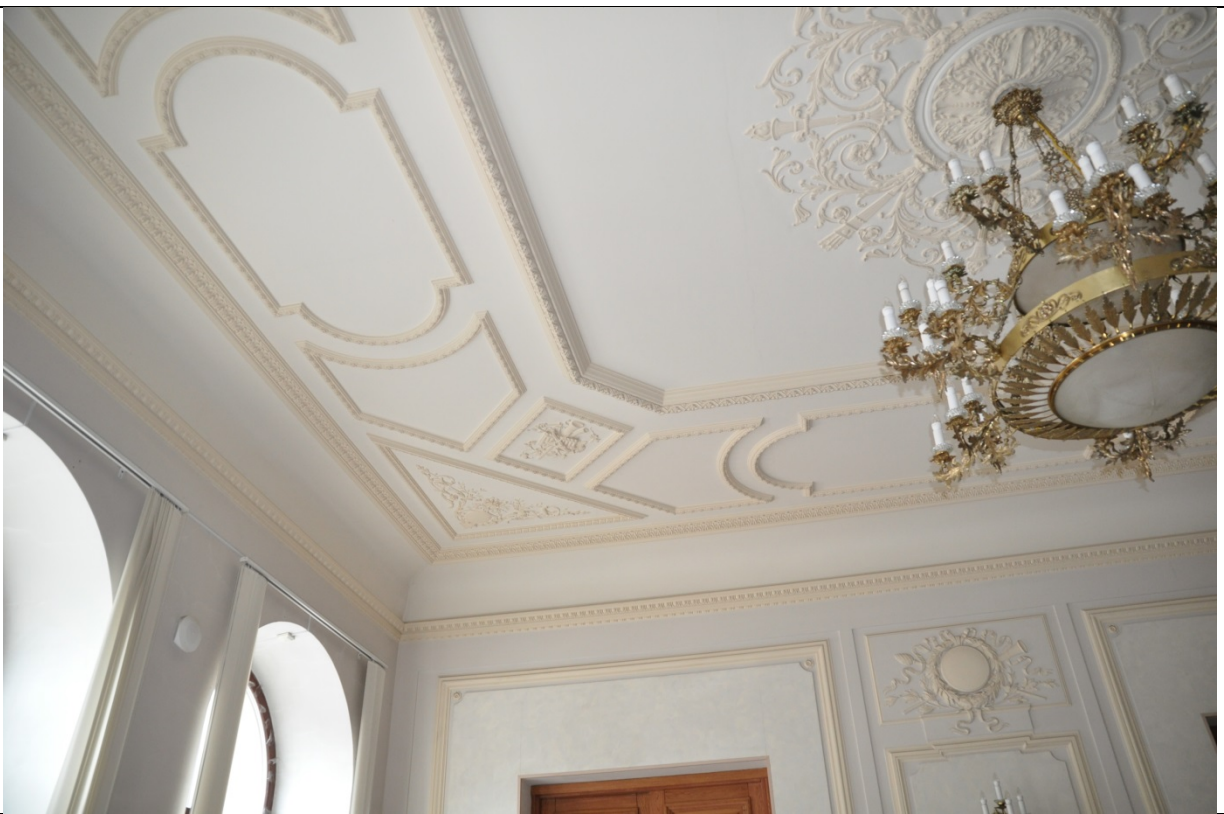
Фото 45. Помещение №8 в осях 2-3. (23.09.2020 г.)
