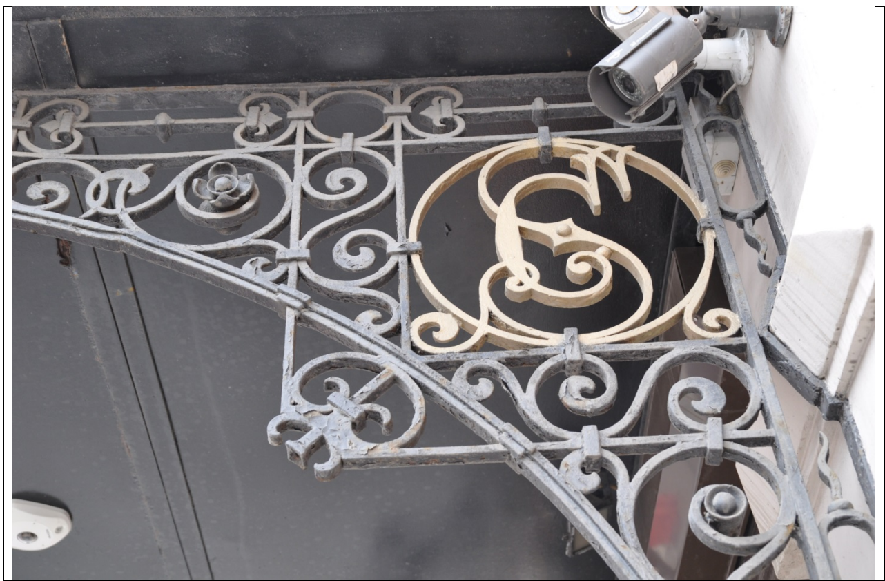
Фото 9. Фрагмент Юго-Восточного фасада на уровне первого этажа в осях 6-1 по улице Марата. Фрагмент кованого козырька(23.09.2020 г.)
