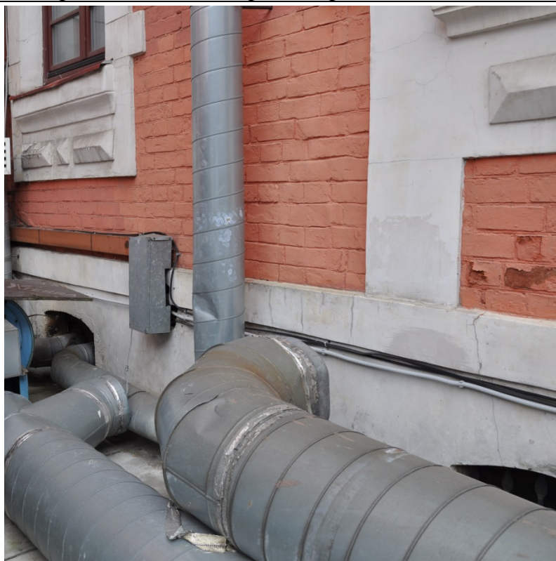
Северо-Западный дворовый фасад в осях 1-6
