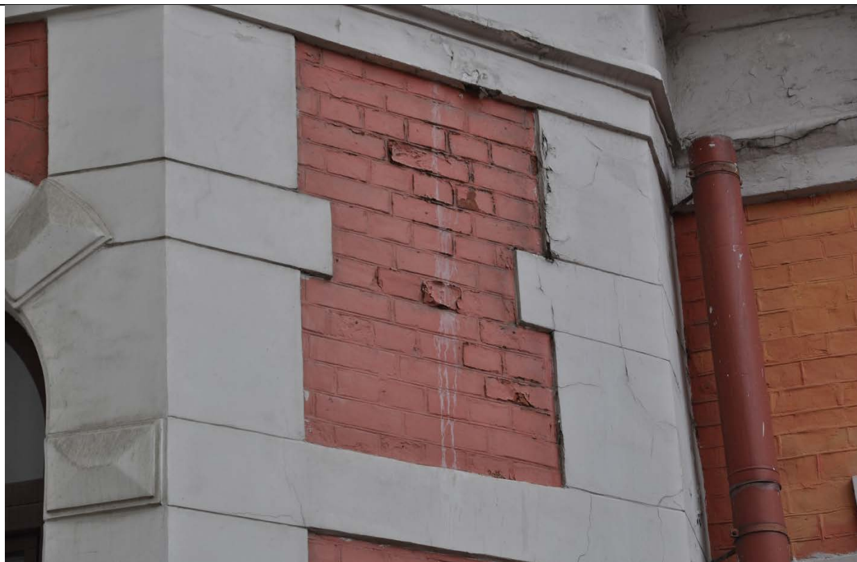
Фото 30. Фрагмент Юго-Западного фасада на уровне второго этажа в осях В-А. (23.09.2020 г.)
