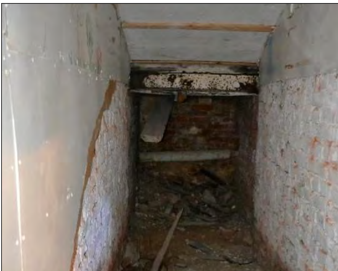
10. Корпус по Замятину переулку. Подвал. Пом. 3-Н (3). Дата съёмки: 20 апреля 2021 г. Фотограф: Тимошенко Д.В
