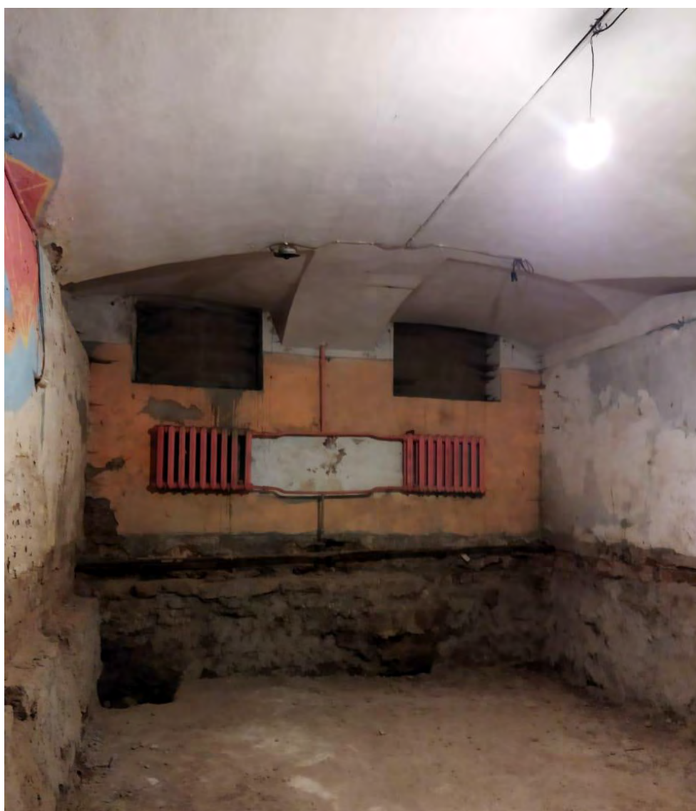
16. Корпус по Замятину переулку. Подвал. Пом. 3-Н (13). Дата съёмки: 20 апреля 2021 г. Фотограф: Тимошенков Д.В.
