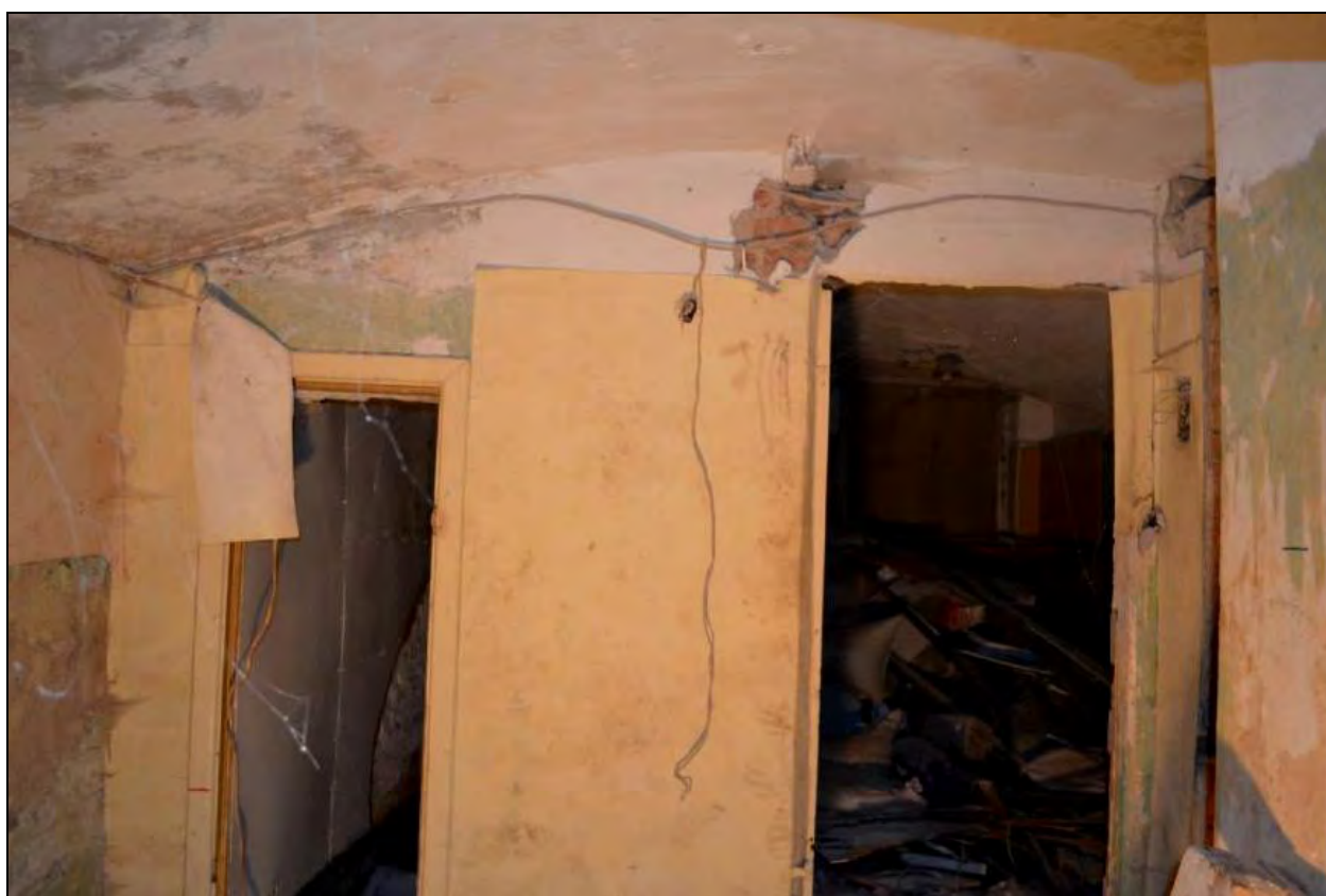
9. Корпус по Замятину переулку. Подвал. Пом. 3-Н (8). Дата съёмки: 20 апреля 2021 г. Фотограф: Тимошенко Д.В
