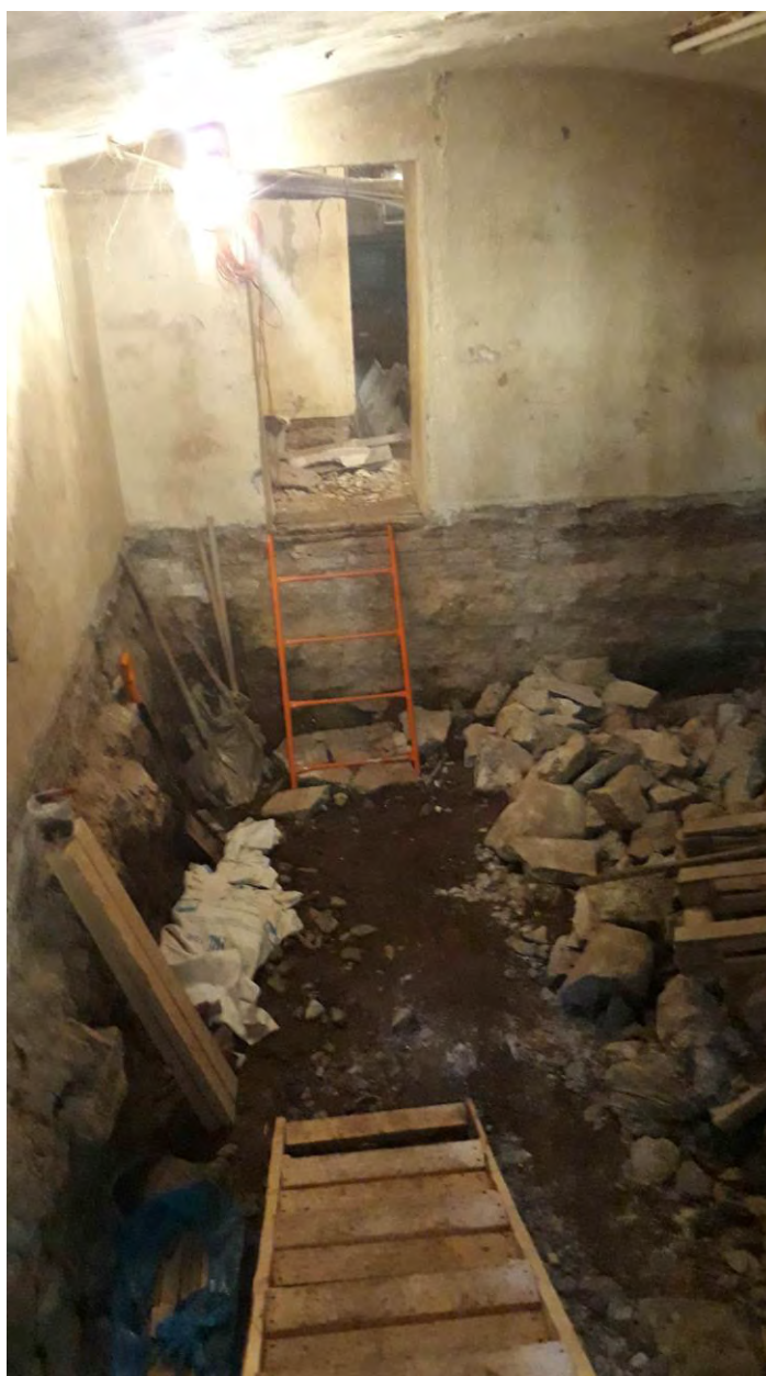
7. Корпус по Замятину переулку. Подвал. Пом. 3-Н (6). Дата съемки: 20 апреля 2021 г. Фотограф: Тимошенков Д.В.
