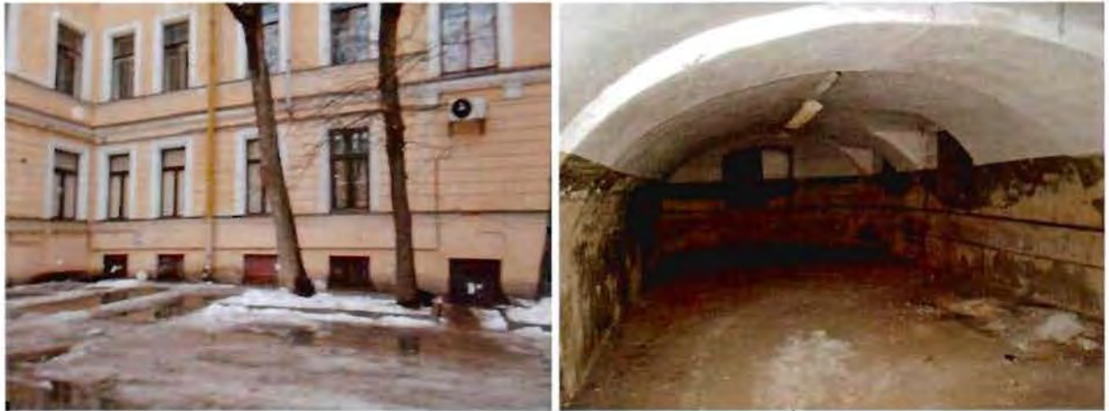
93, 94. Подвальные помещения в границах корпуса по Английской наб. (пом. 10Н)
