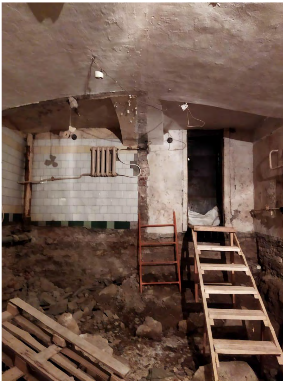
8. Корпус по Замятину переулку. Подвал. Пом. 3-Н (6). Дата съёмки: 20 апреля 2021 г. Фотограф: Тимошенков Д.В.
