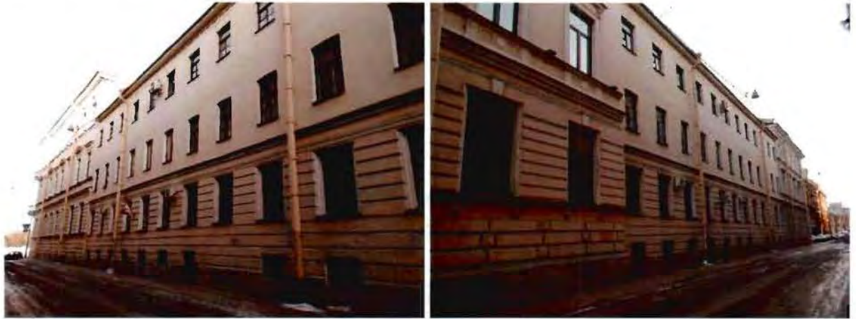
9, 10. Внутренний двор. Северный и южный фасады
