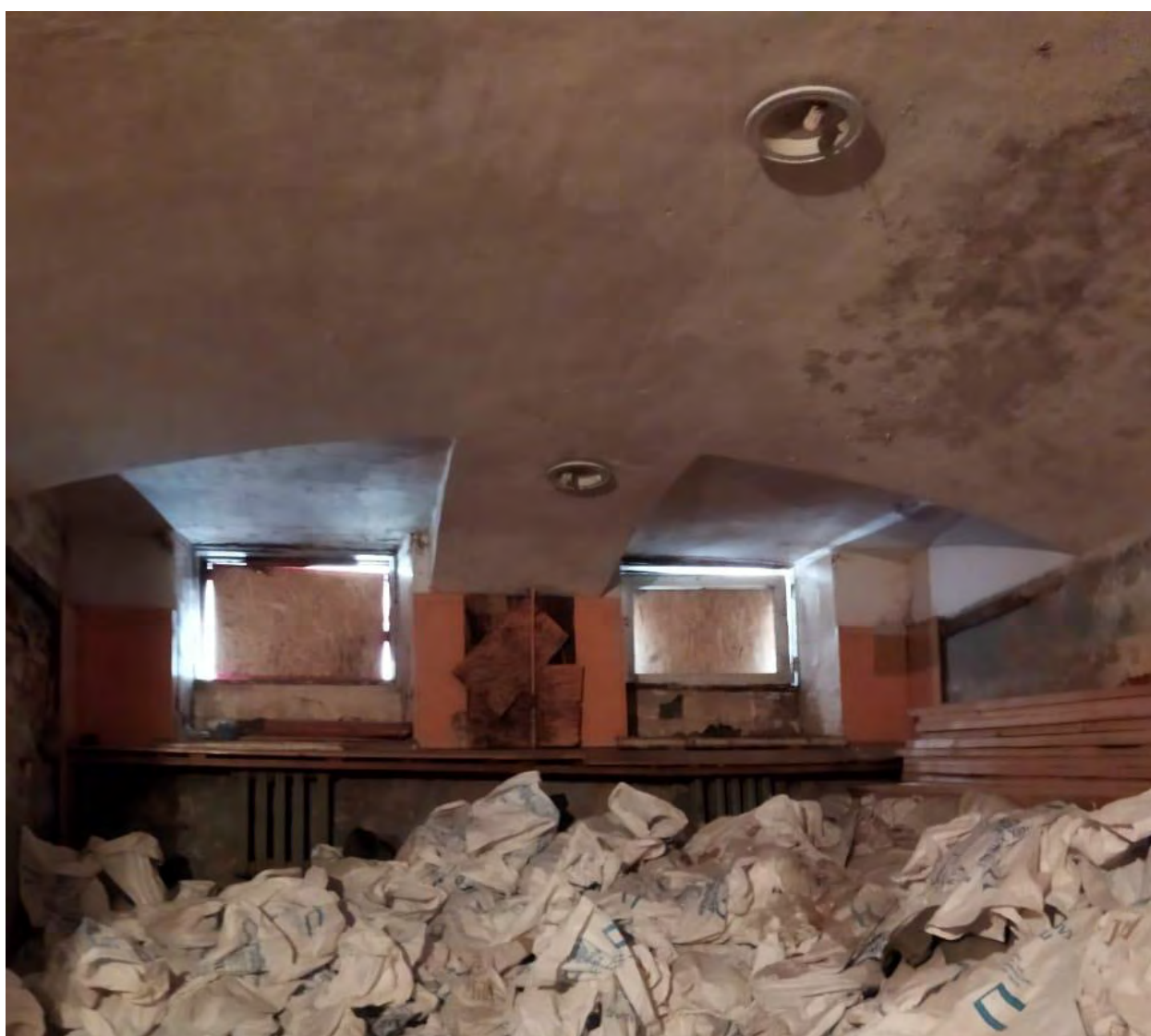
11. Корпус по Замятину переулку. Подвал. Пом. 3-Н (2). Дата съёмки: 20 апреля 2021 г. Фотограф: Тимошенко Д.В.
