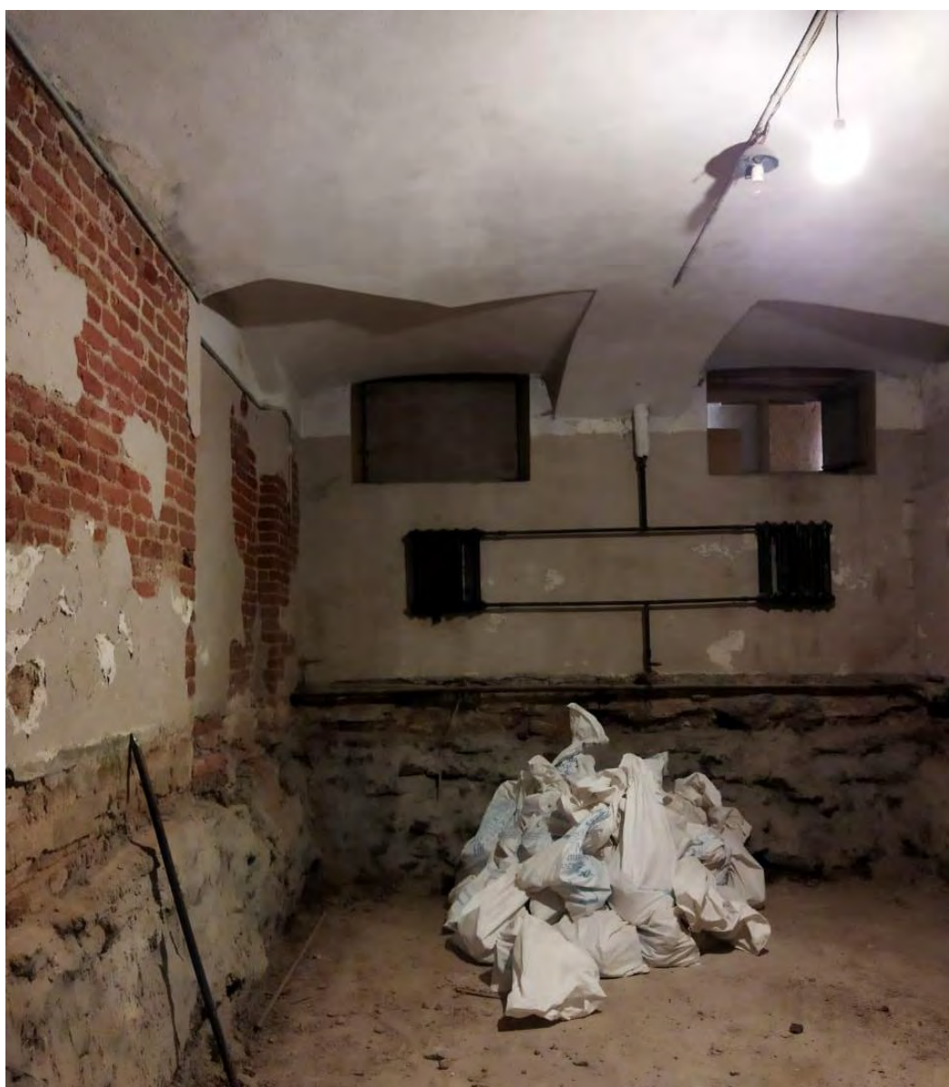
15. Корпус по Замятину переулку. Подвал. Пом. 3-Н (12). Дата съёмки: 20 апреля 2021 г. Фотограф: Тимошенко Д.В.
