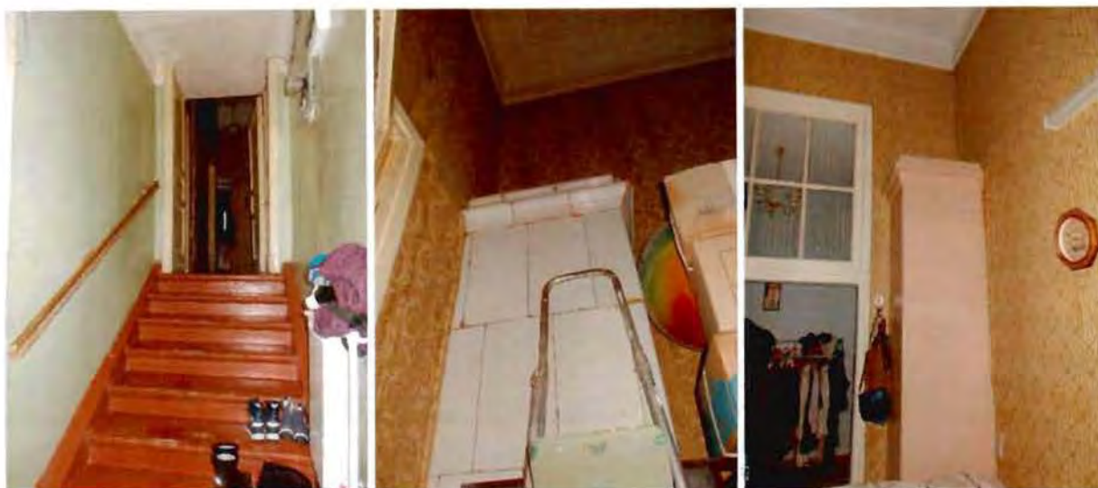
54, 55, 56. Лестница Л-5 (вход со стороны внутреннего двора)
