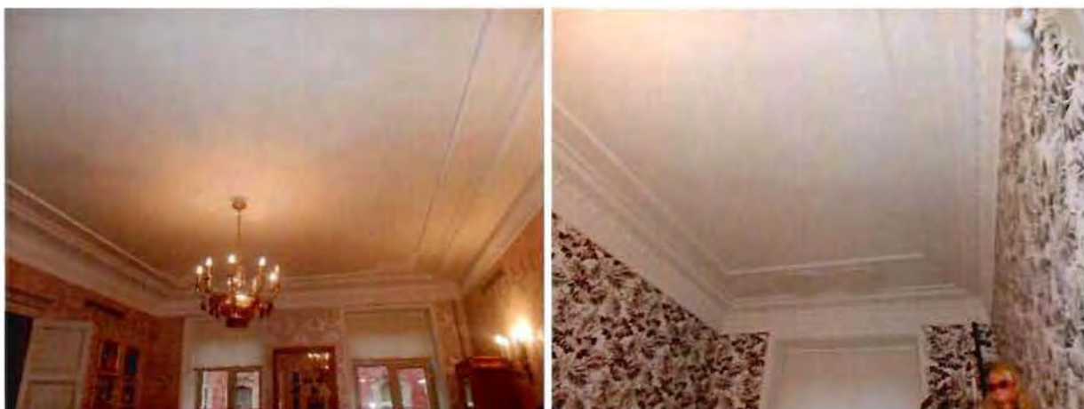
27, 28. Сводчатые потолки в уровне 1 этажа здания (кв. 24)
