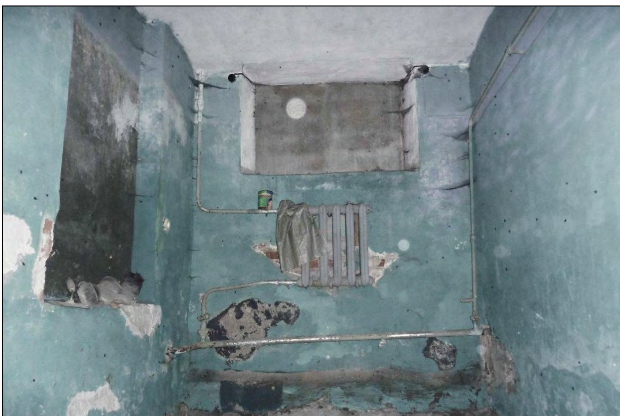
14. Корпус по Замятину переулку. Подвал. Пом. 3-Н (10). Дата съёмки: 20 апреля 2021 г. Фотограф: Тимошенков Д.В.
