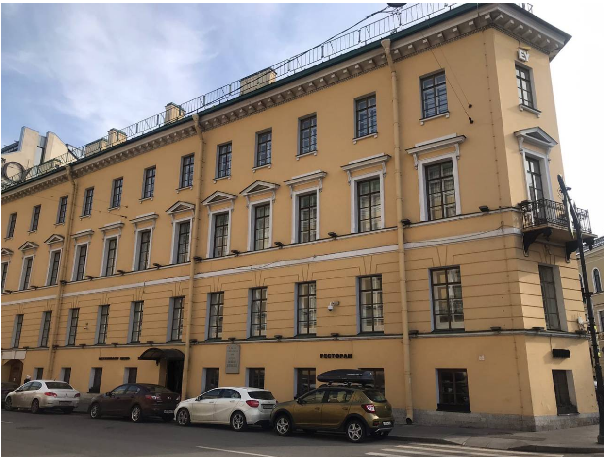
Фото 3. Лицевой фасад со стороны Вознесенского проспекта
