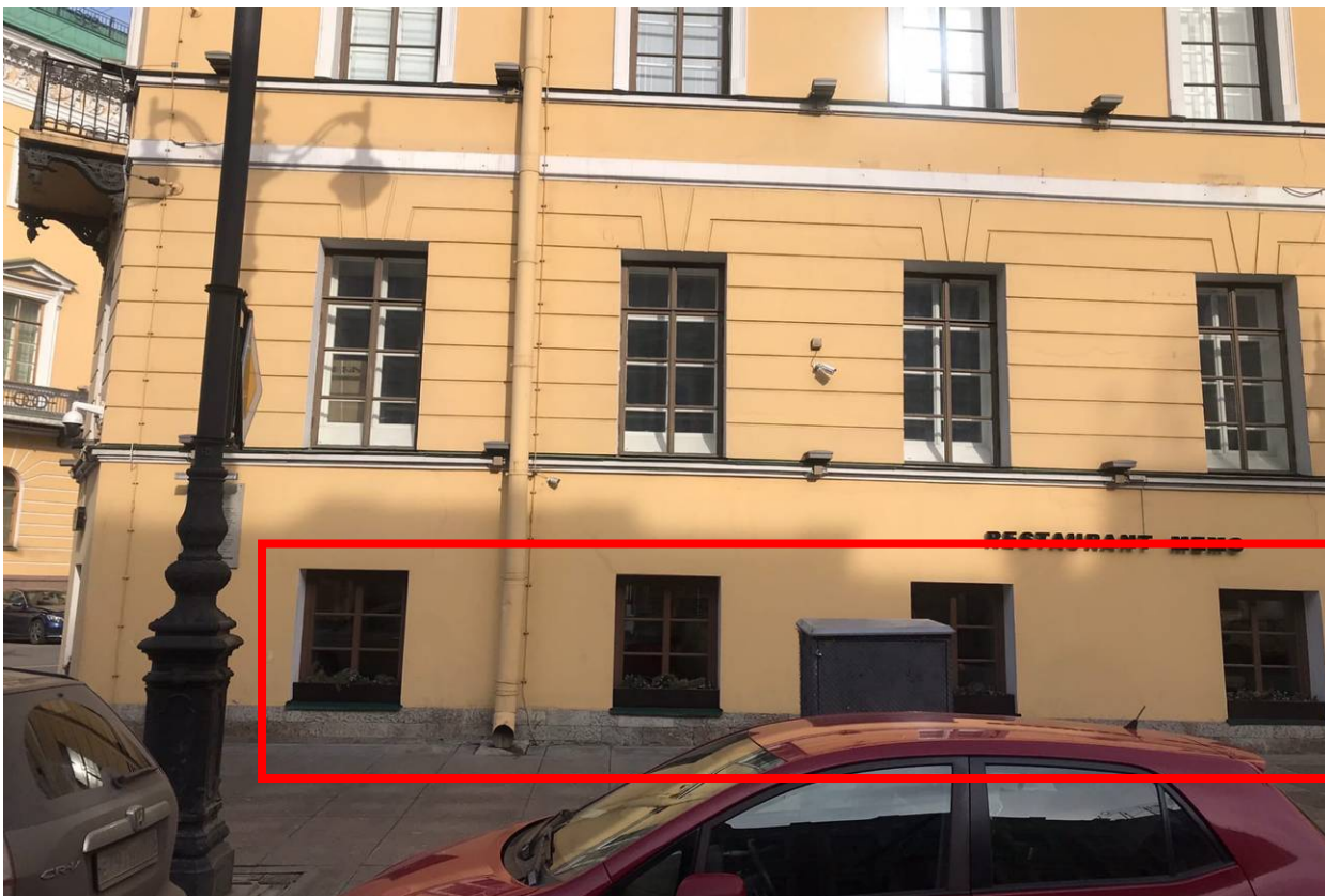
Фото 5. Фрагмент лицевого фасада с оконными проемами помещения
