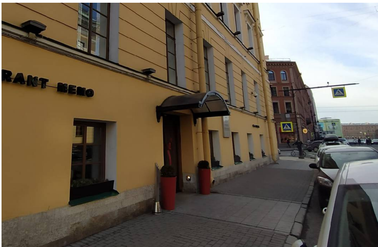
Фото 7. Входной дверной проем в помещение со стороны Вознесенского проспекта
