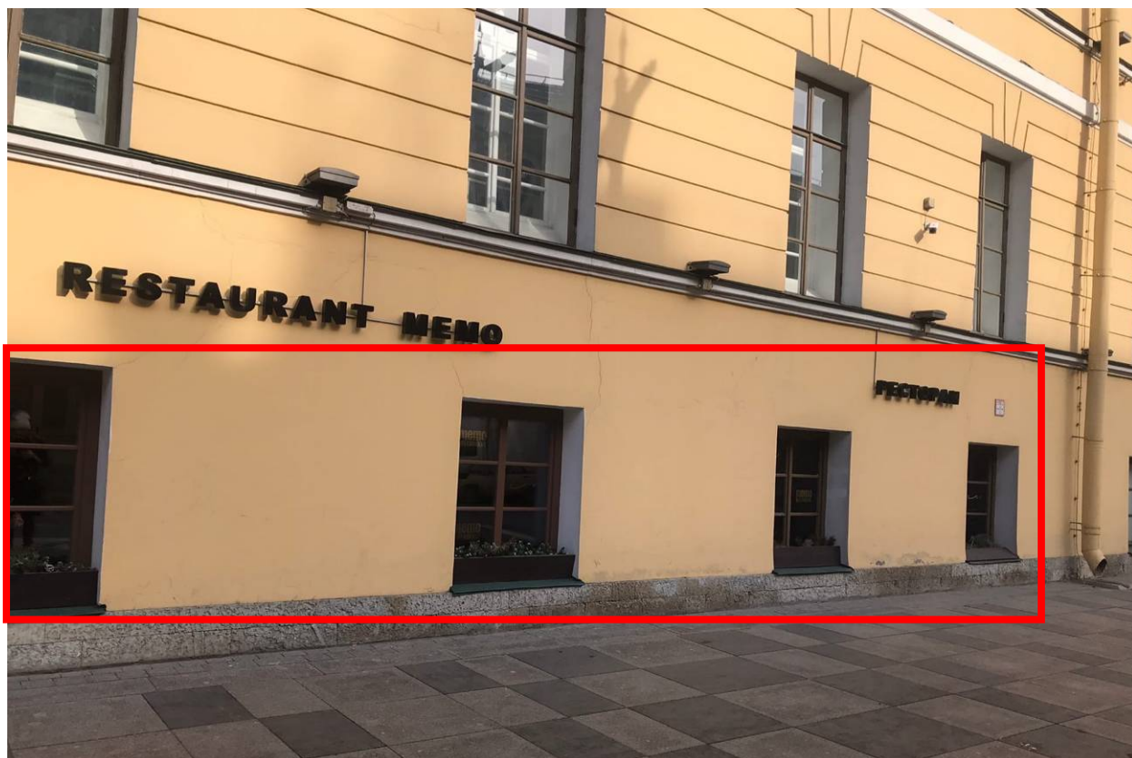
Фото 4. Фрагмент лицевого фасада с оконными проемами помещения
