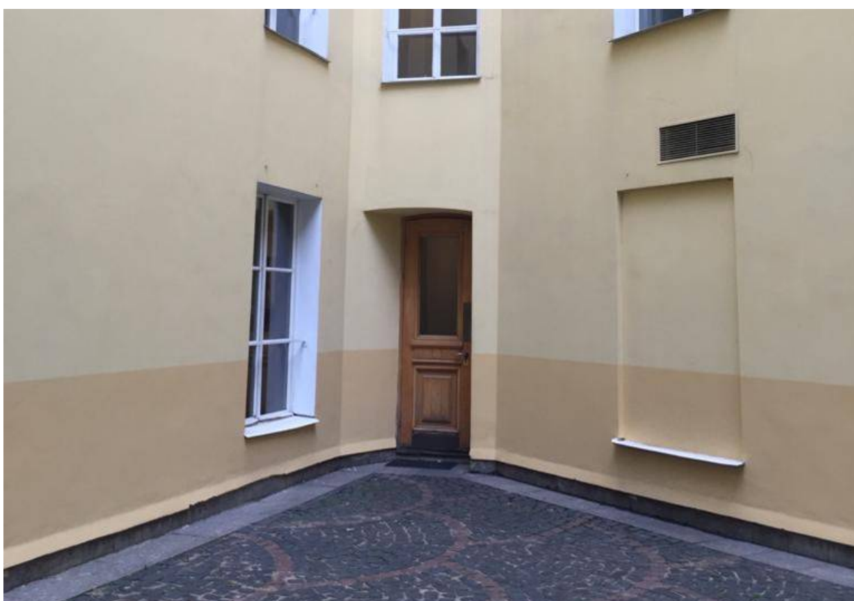
Фото 8. Заложенный оконный проем со стороны дворового фасада
