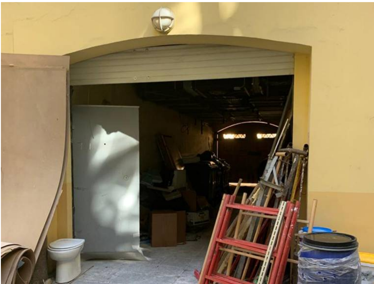
Фото 9. Арка во внутренний двор
