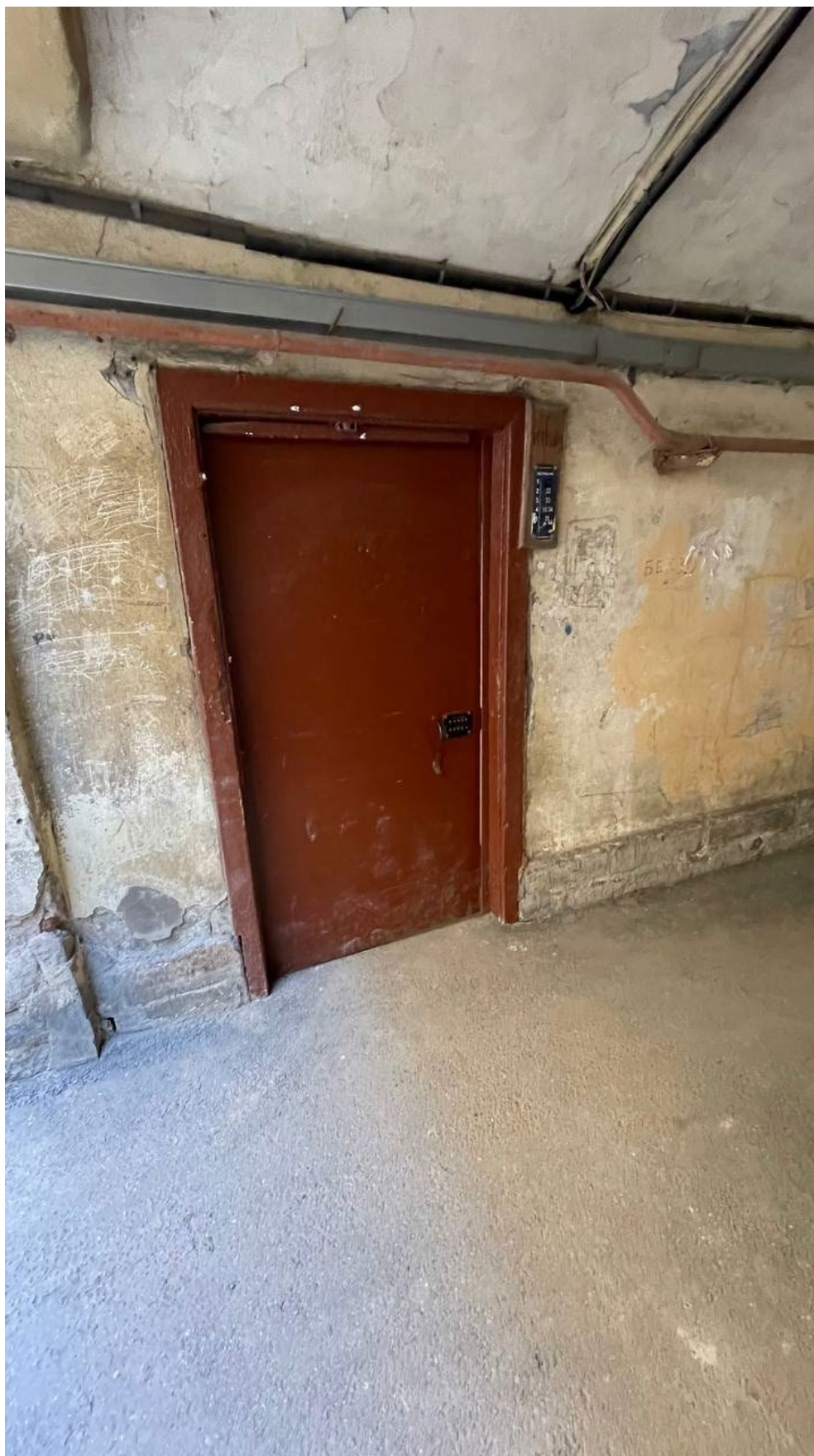
5. Вид на входную дверь в арке;
