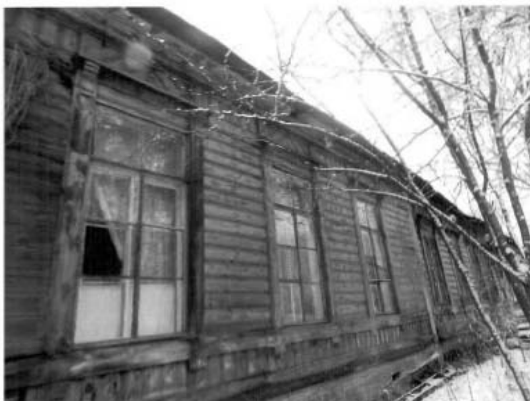
2. Часть южного фасада здания.
