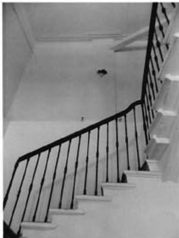
6. Лестница с металлическим ограждением.
