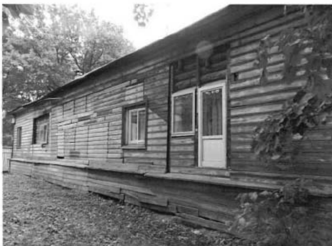
4. Северный фасад здания.
