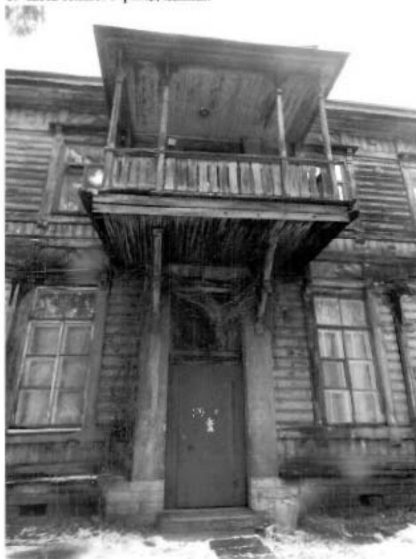
1. Часть южного фасад здания.
