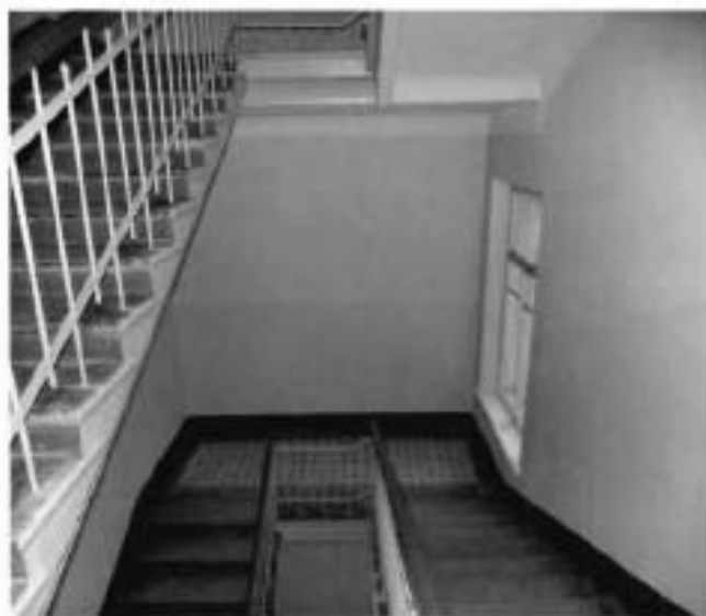
14. Напольное покрытие лестничных маршей.
