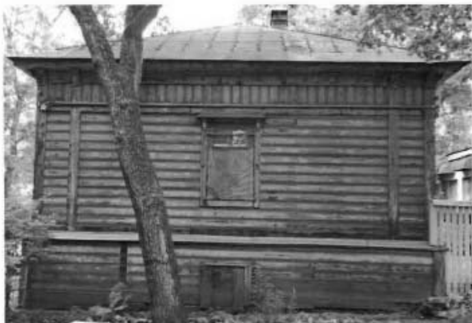
2. Восточный фасад здания.
