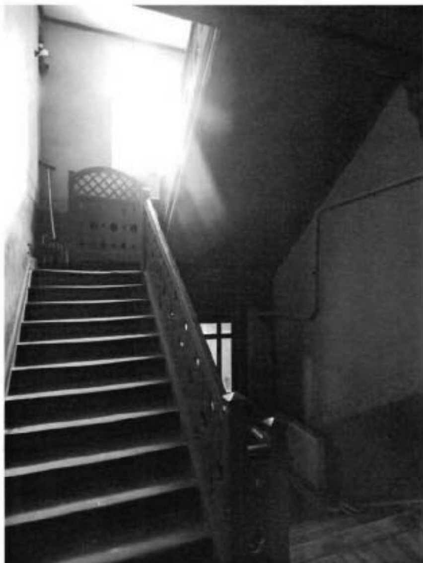
5. Фрагмент деревянной лестницы.
