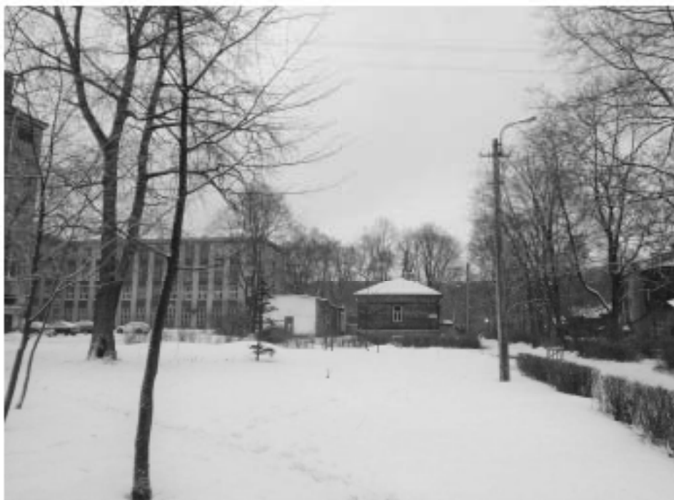
Фото 5. Вид на территорию проведения работ, ОКН федерального значения «корпус Малый» (слева) и часть «корпус Большой офицерский (квартиры профессоров и аспирантов)» (справа) входящие в состав ОКН федерального значения «Институт Лесной (Академия лесотехническая)»
