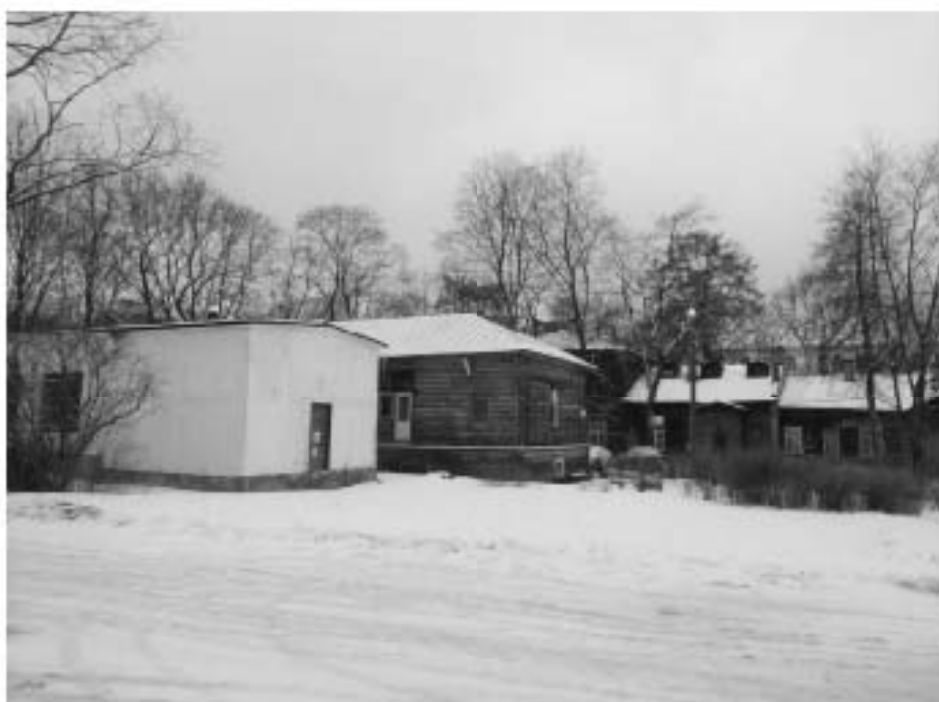
Фото 7. Вид на территорию проведения работ, ОКН федерального значения «корпус Малый», «корпус Большой офицерский (квартиры профессоров и аспирантов)» входящие в состав ОКН федерального значения «Институт Лесной (Академия лесотехническая)»
