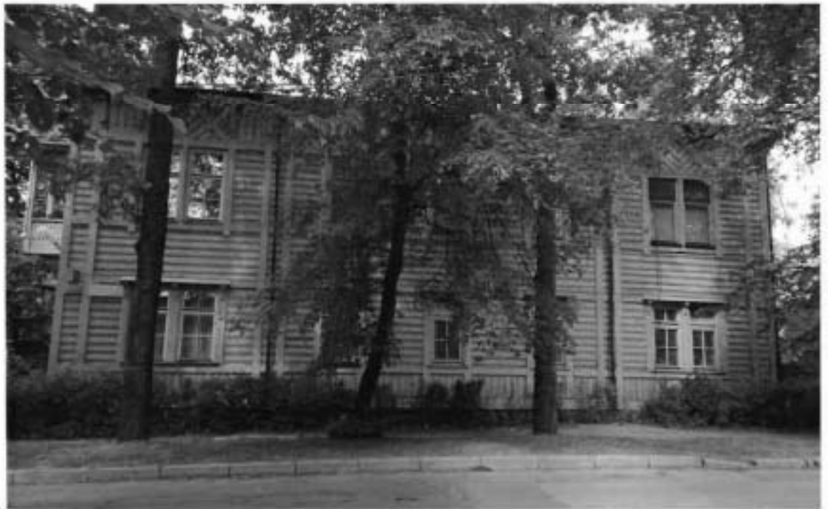
4. Восточный фасад здания.
