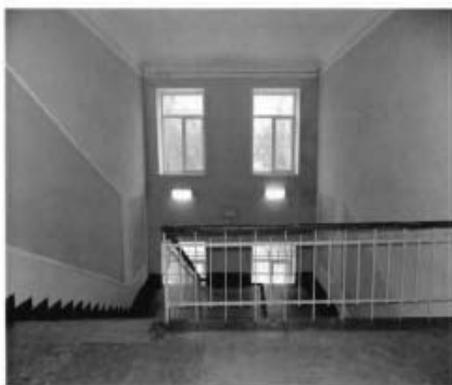
15. Напольное покрытие лестничных маршей.
