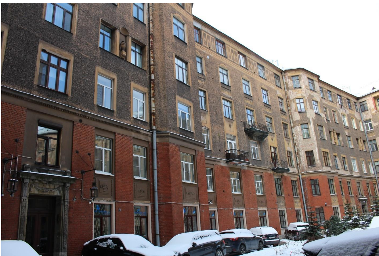
Фото 13. Вид на дворовый фасад в центральной части двора объекта культурного наследия.
