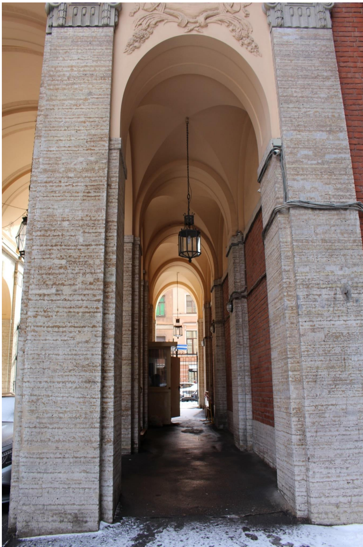
Фото 9. Вид на арку воротного проезда по ул. Рубинштейна со стороны двора.
