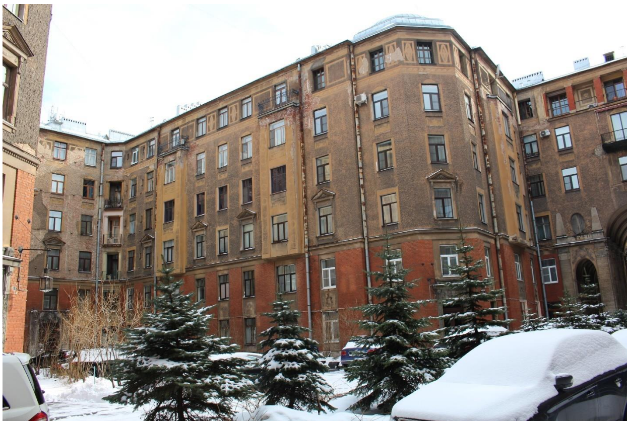
Фото 16. Вид на дворовый фасад в северной части объекта культурного наследия.
