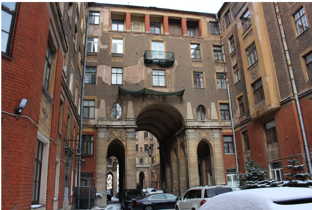
Фото 18. Вид на арку воротного проезда между центральной и северо-западной частями внутреннего двора объекта культурного наследия с юго-востока.
