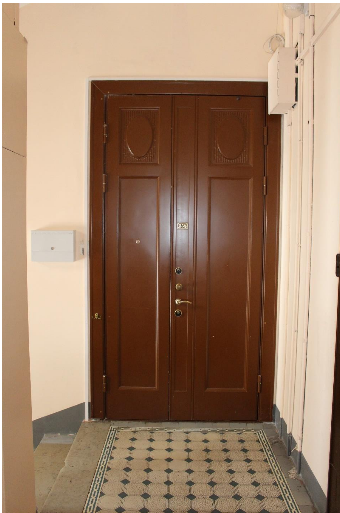
Фото 32. Вид на входные двери в квартиру № 358.
