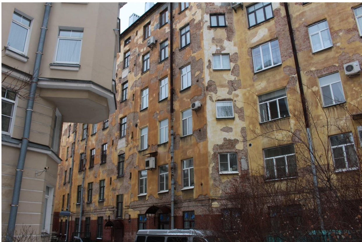
Фото 24. Вид на западную часть юго-западного дворового фасада
