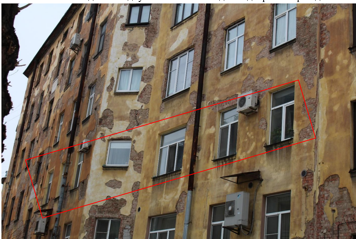
Фото 25. Вид на оконные проемы квартиры № 358 со стороны юго-западного дворового фасада.
