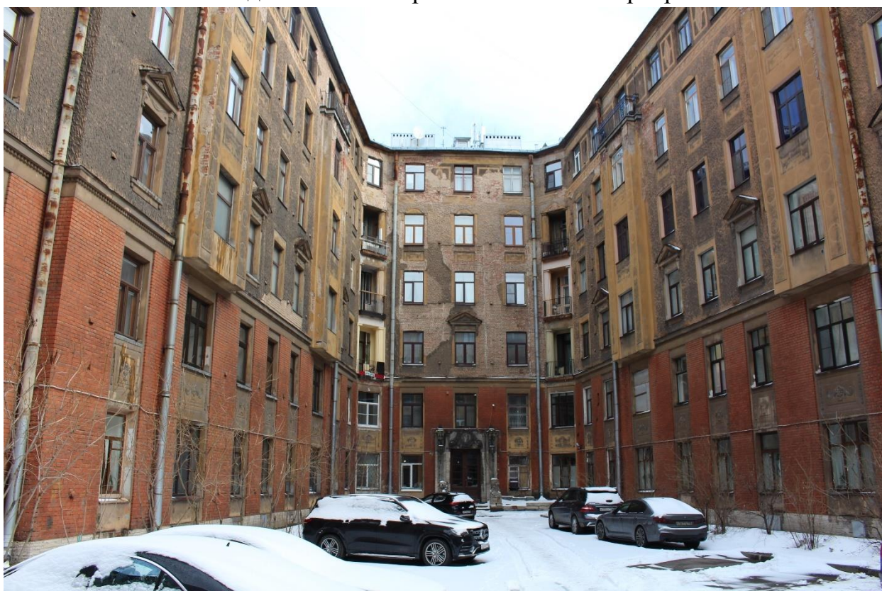
Фото 15. Вид на дворовый фасад в северной части объекта культурного наследия.
