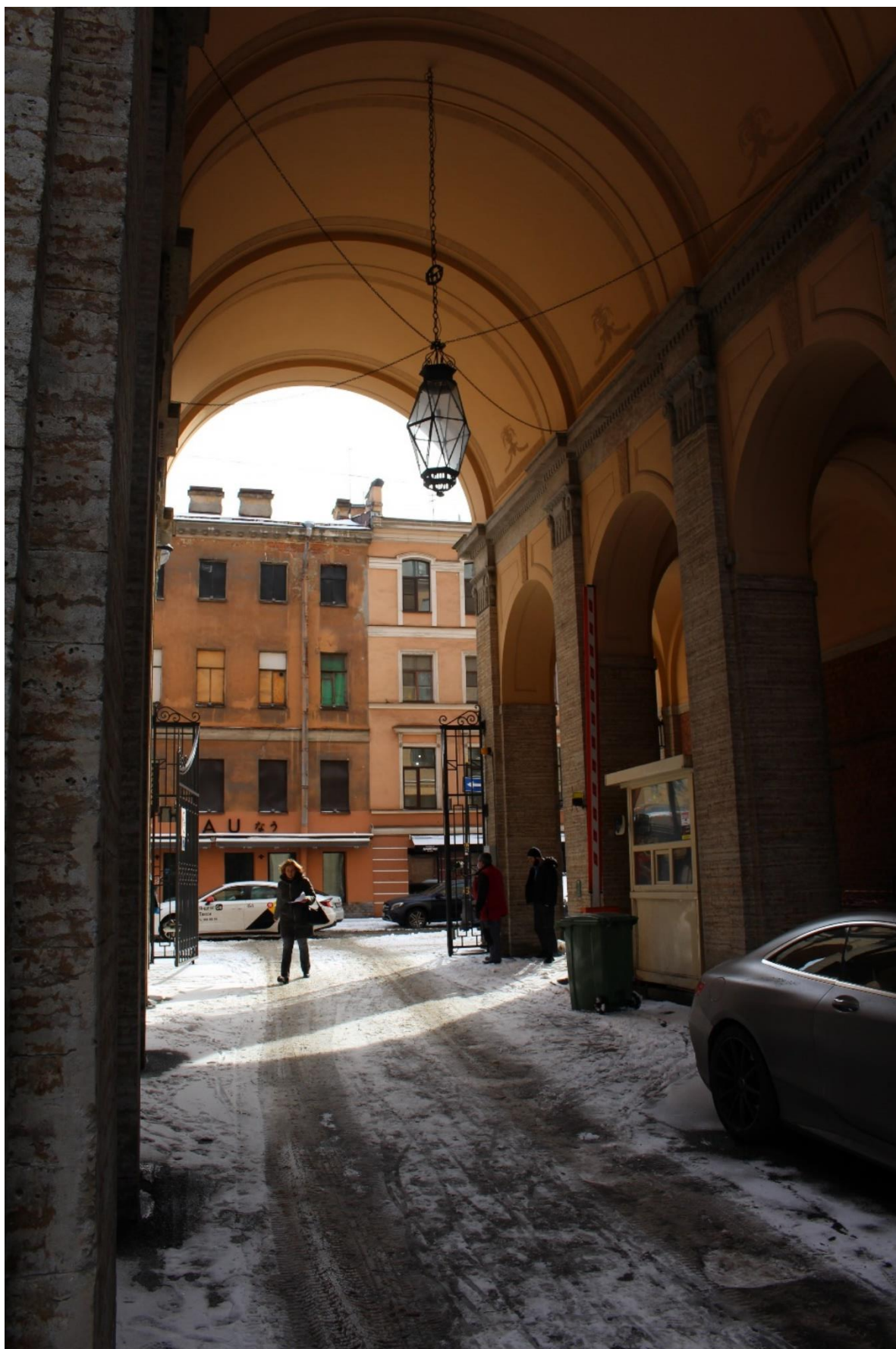
Фото 8. Вид на арку воротного проезда по ул. Рубинштейна со стороны двора.
