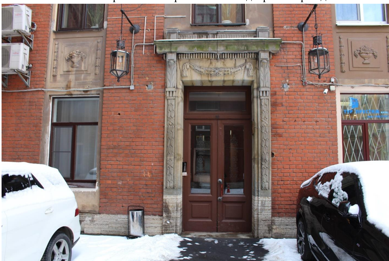
Фото 31. Вид на вход в лестничную клетку № 8.
