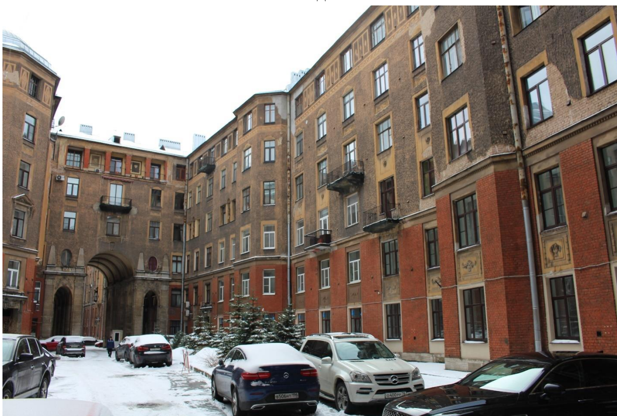
Фото 17. Вид на дворовый фасад в центральной части двора объекта культурного наследия.
