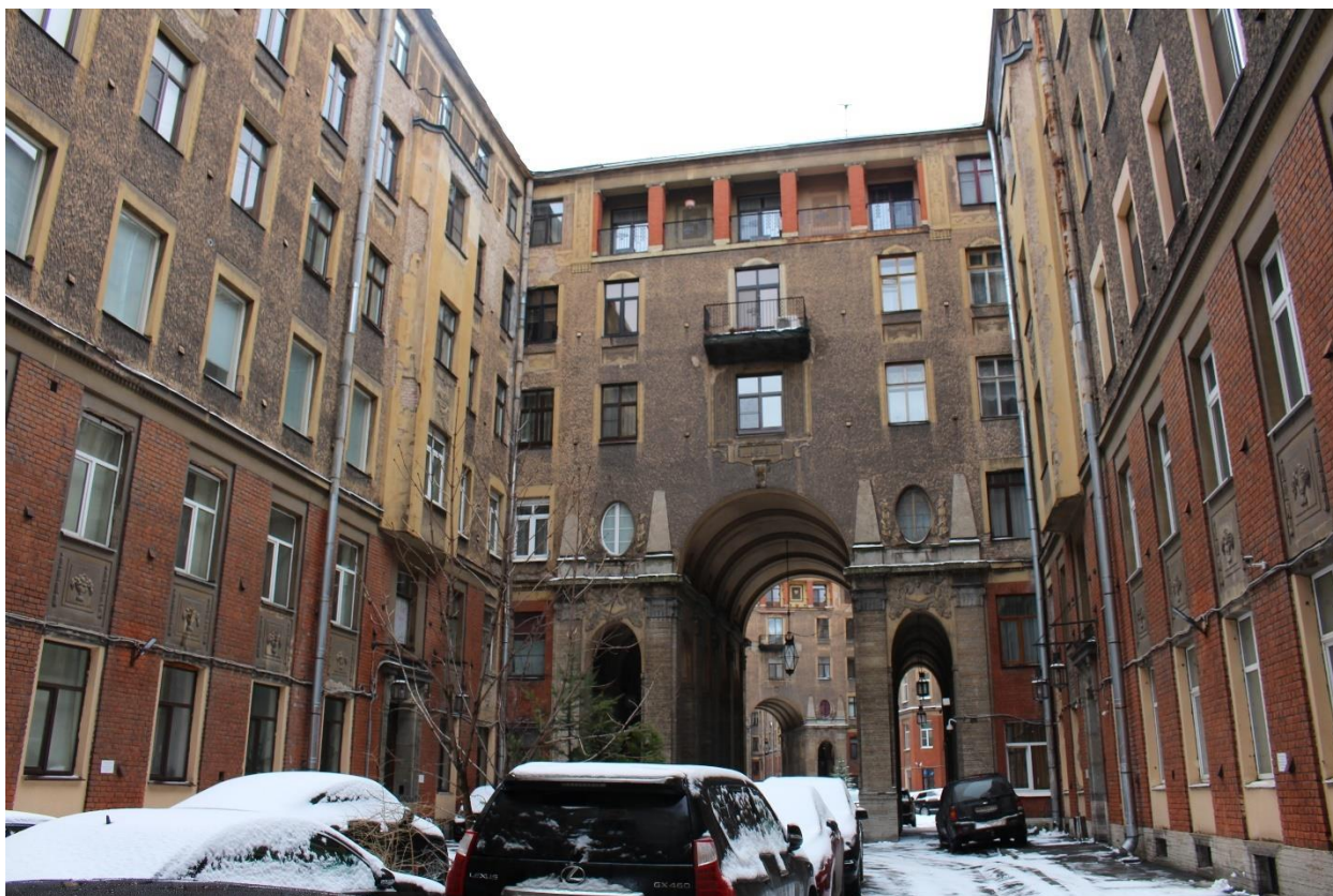
Фото 20. Вид на арку воротного проезда между центральной и северо-западной частями внутреннего двора объекта культурного наследия с северо-запада.
