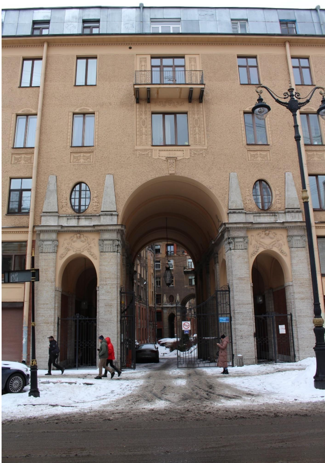
Фото 3. Вид на арку воротного проезда по ул. Рубинштейна.
