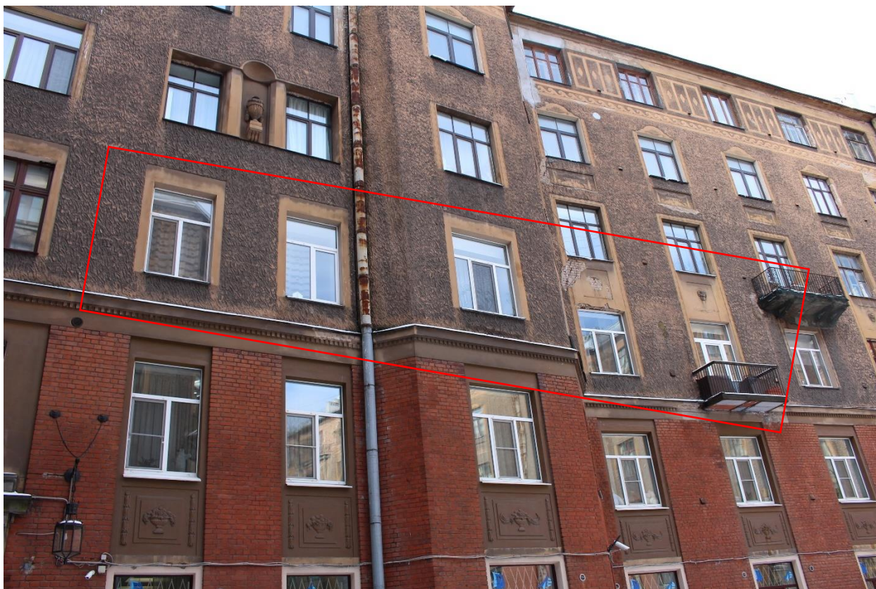
Фото 14. Вид на оконные проемы и балкон квартиры № 358.
