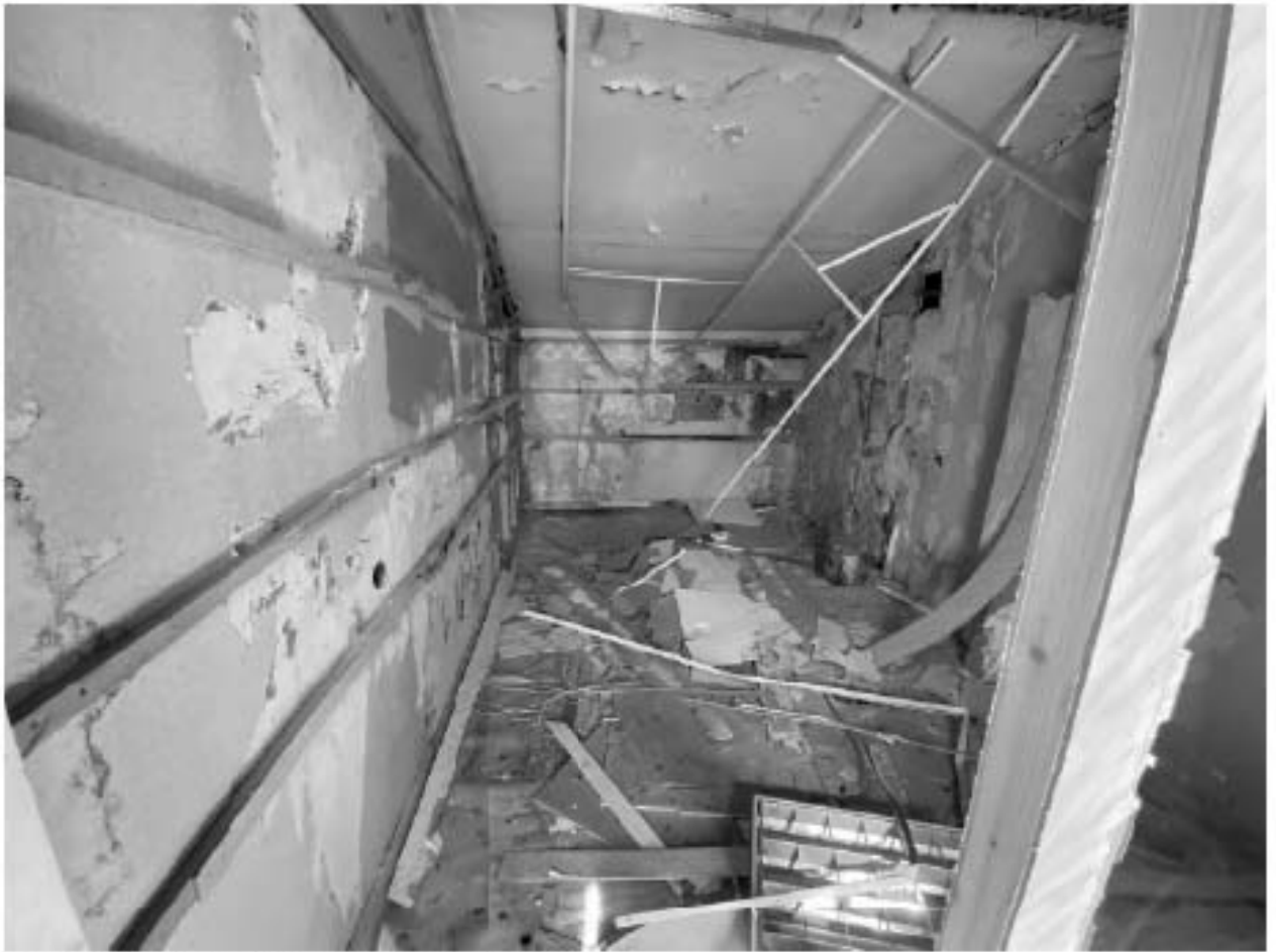
Фото 242. Мансарда. Помещение 19-Н(б).
