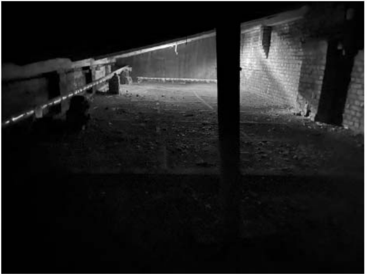
Фото 240. Чердак. Помещение б/н2(1).
