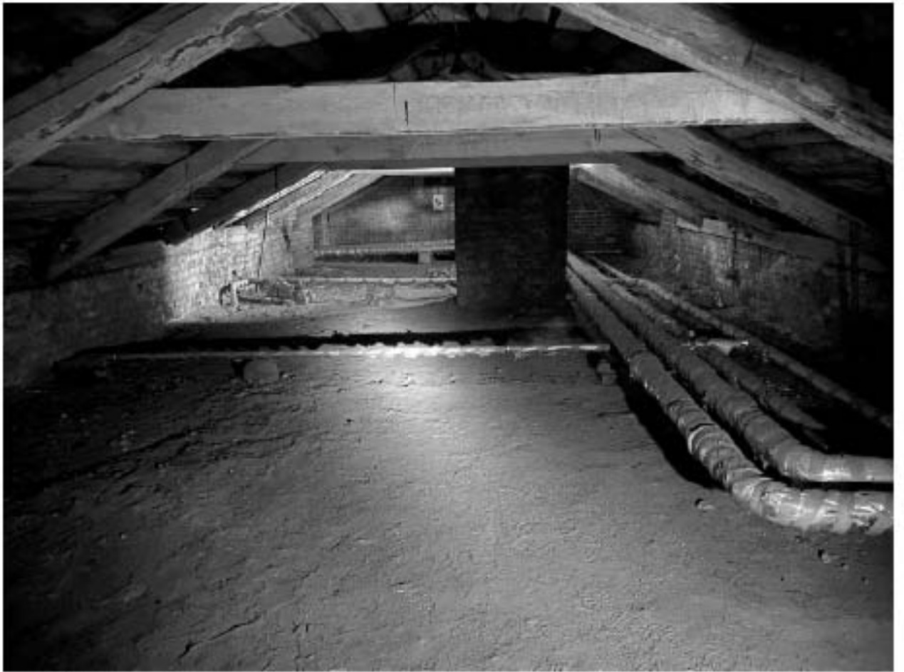
Фото 237. Чердак. Помещение б/нЗ(1).
