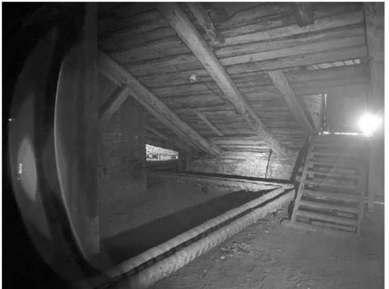
Фото 233. Чердак. Помещение б/нЗ(1).
