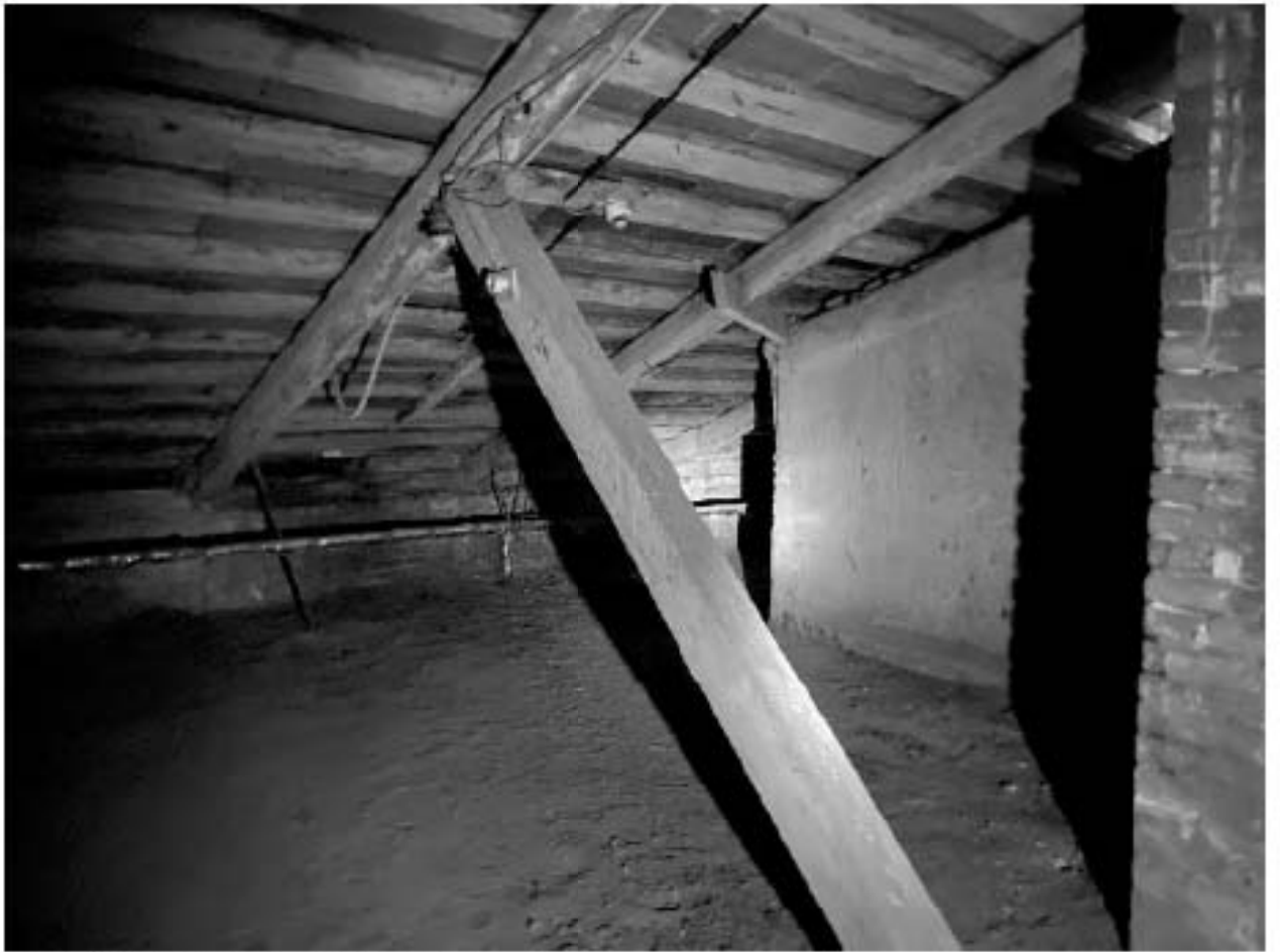
Фото 234. Чердак. Помещение б/нЗ(1).
