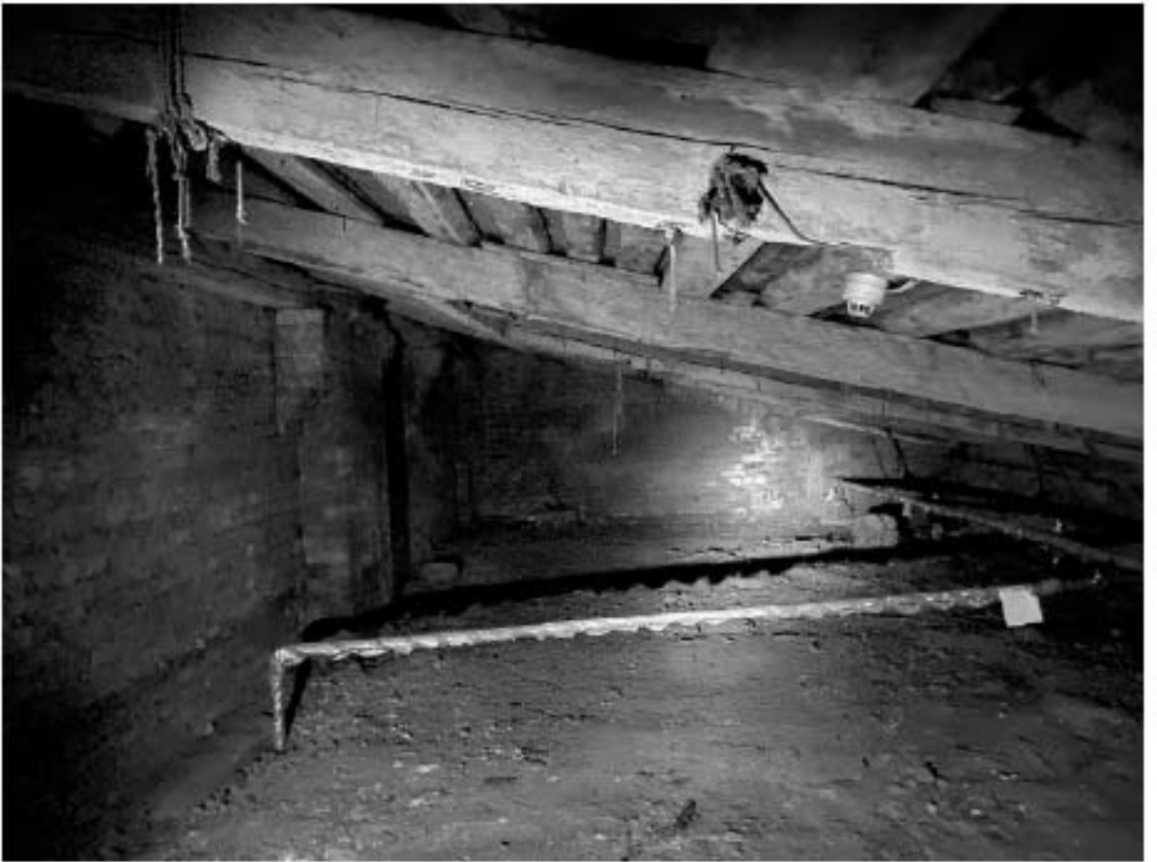
Фото 225. Чердак. Помещение б/н1(1).
