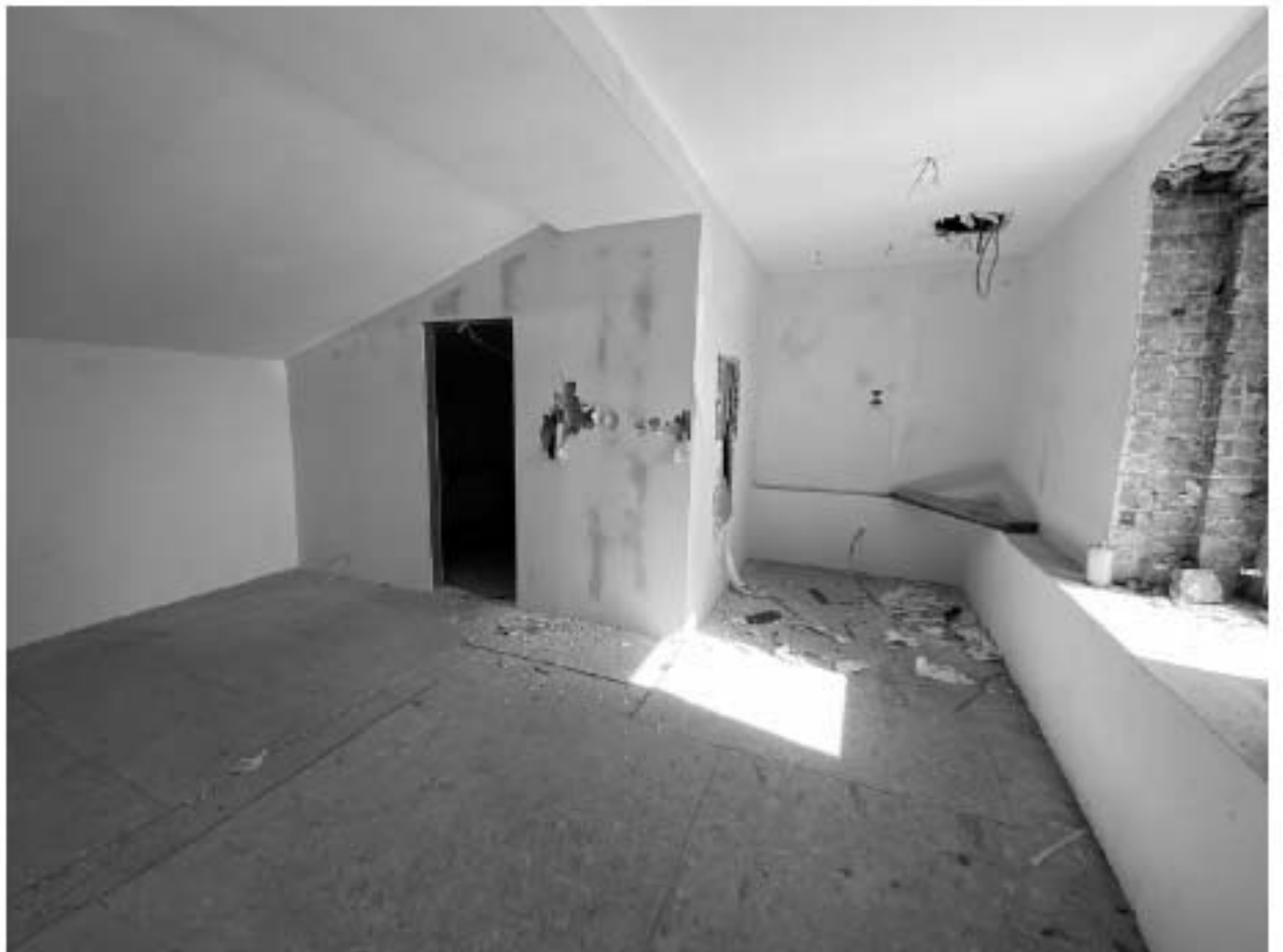
Фото 247. Мансарда. Помещение 28-Н(б).
