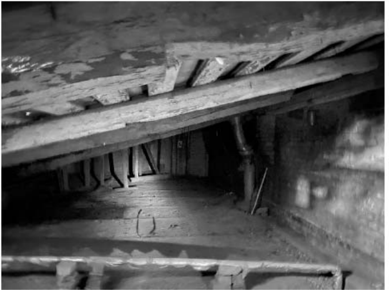
Фото 239. Чердак. Помещение б/н2(1).
