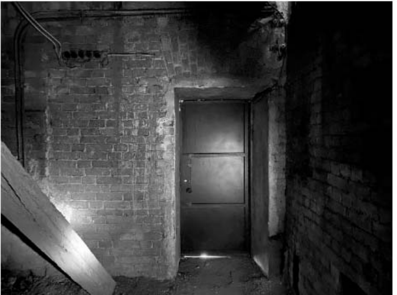
Фото 236. Чердак. Помещение б/нЗ(1).
