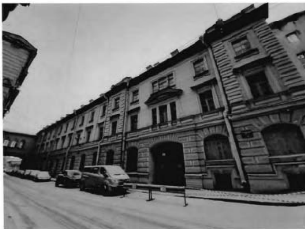
1. Вид на фасад объекта культурного наследия по Черноморскому переулку
