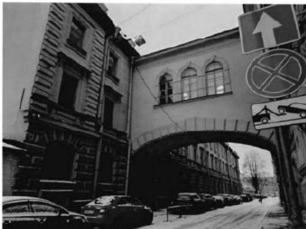
2. Вид на переход в уровне 2-го этажа в объект культурного наследия федерального значения «Дворец»
