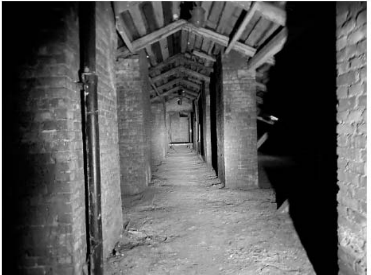
Фото 227. Чердак. Помещение б/нЗ(1).
