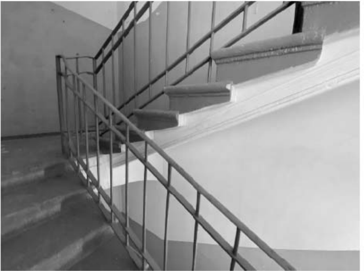
Фото 86. Лестница в юго-западном объеме здания (5ЛК).
