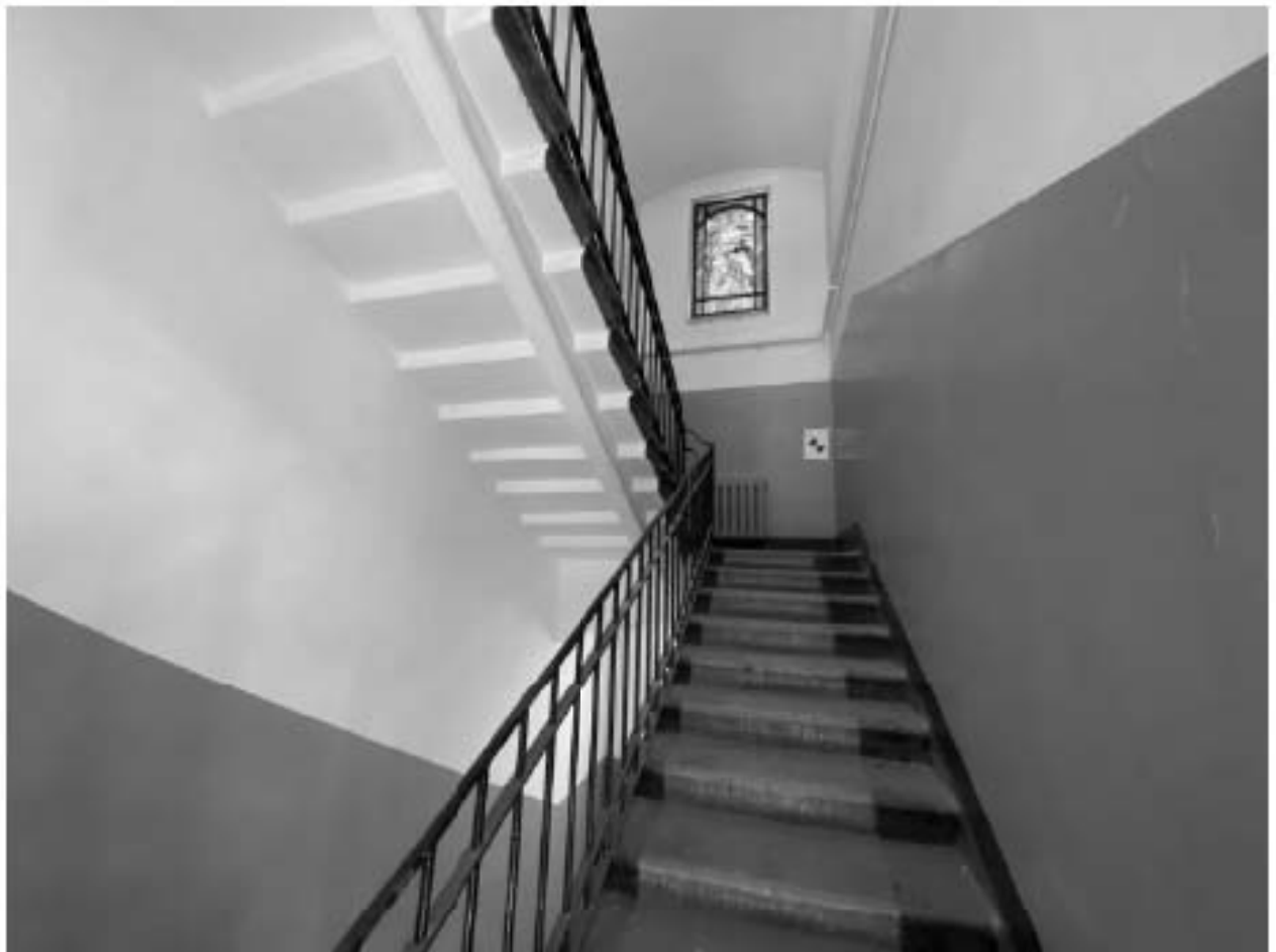
Фото 74. Лестница в северо-восточном объеме здания (2ЛК).
