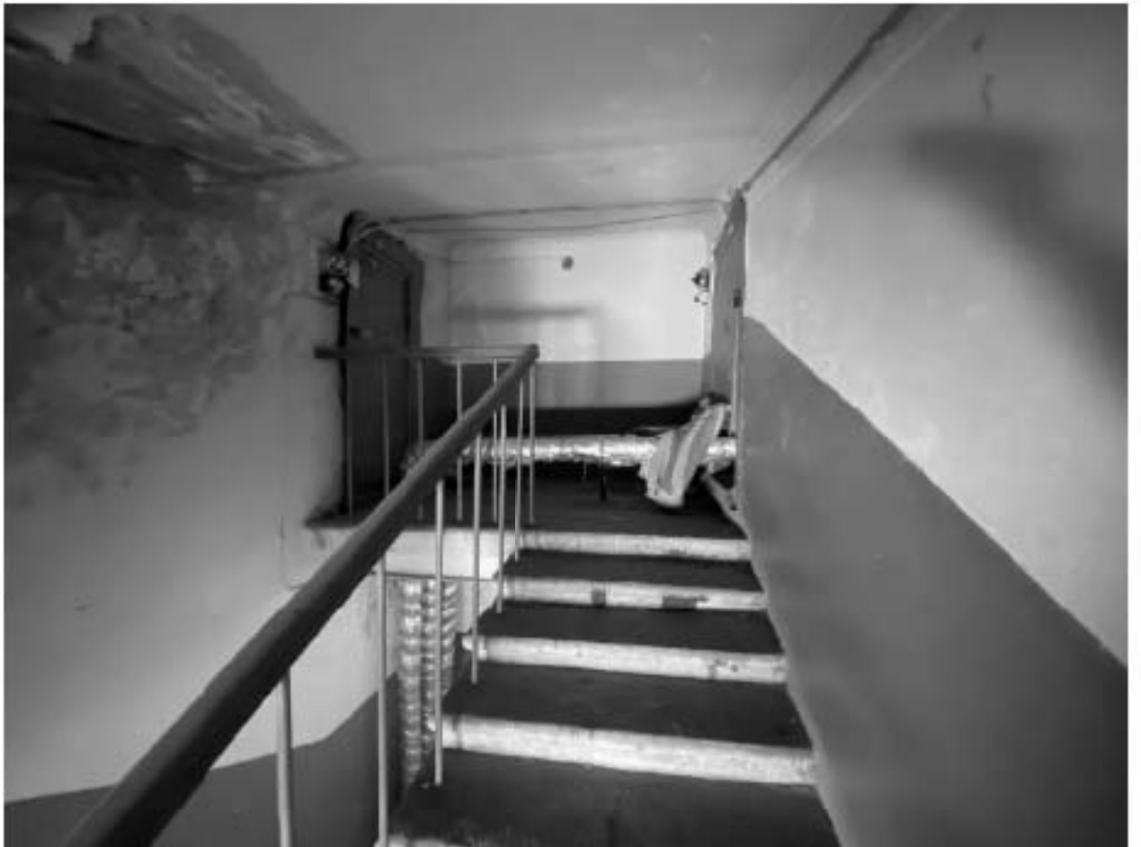
Фото 64. Лестница в северо-восточном объеме здания (ЗЛК). Вход на чердак.
