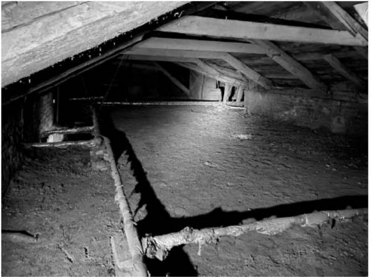
Фото 226. Чердак. Помещение б/нЗ(1).
