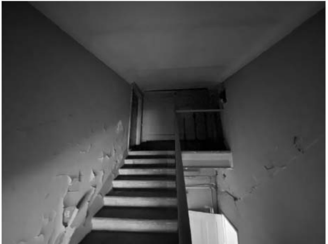
Фото 52. Лестница в юго-западном объеме здания (4ЛК). Вход на чердак.
