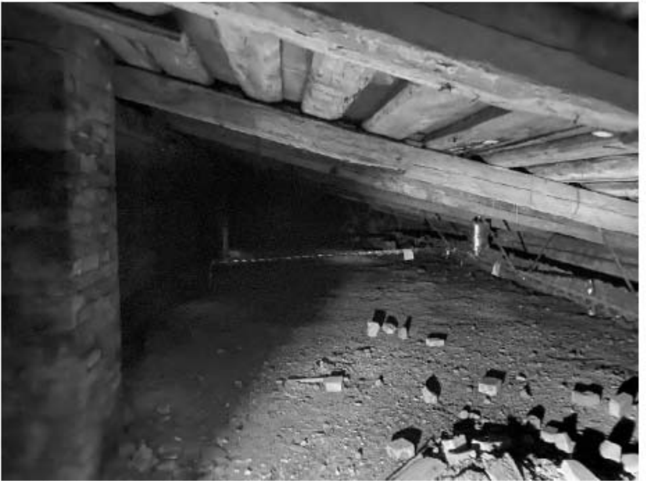
Фото 224. Чердак. Помещение б/н1(1).
