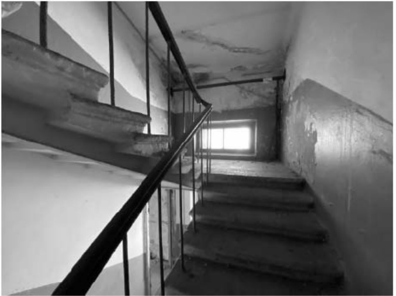
Фото 63. Лестница в северо-восточном объеме здания (ЗЛК).
