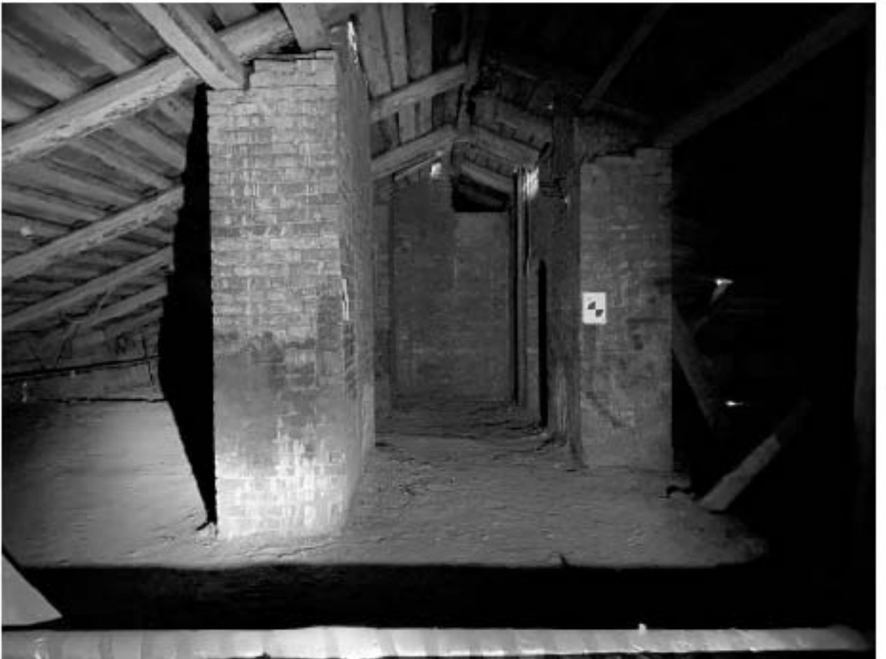
Фото 232. Чердак. Помещение б/нЗ(1).
