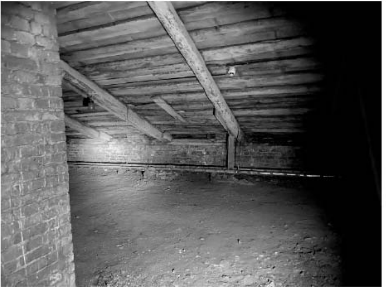
Фото 229. Чердак. Помещение б/нЗ(1).
