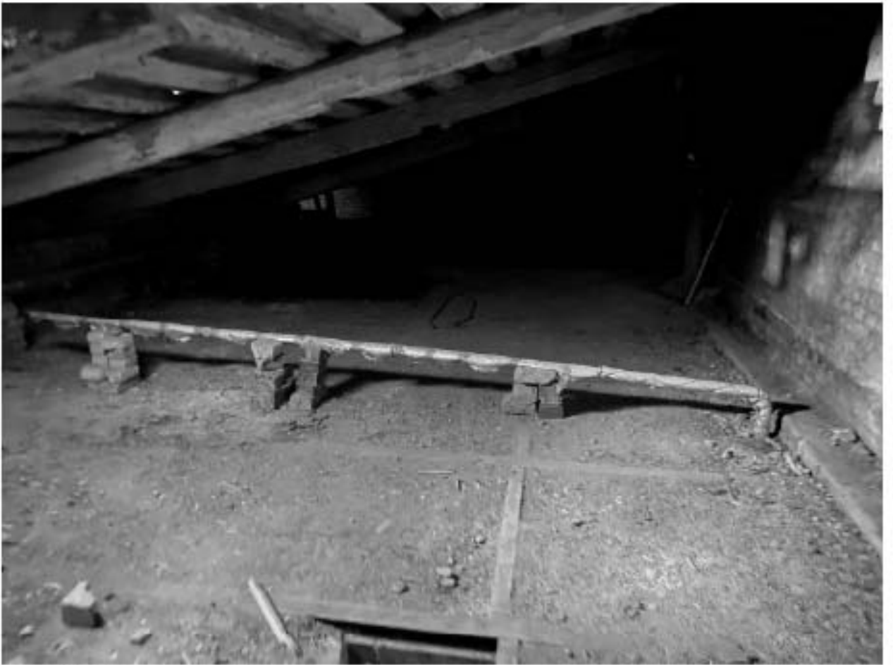
Фото 238. Чердак. Помещение б/н2(1).
