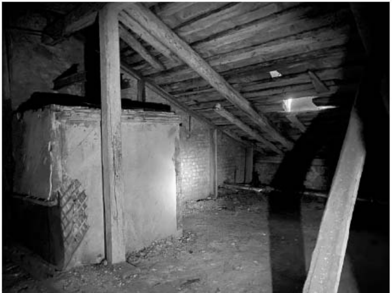
Фото 231. Чердак. Помещение б/нЗ(1).
