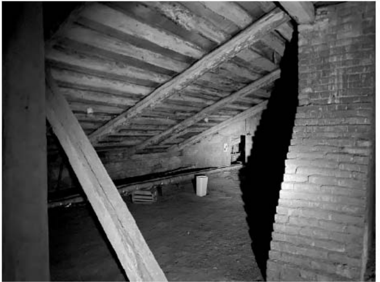
Фото 230. Чердак. Помещение б/нЗ(1).
