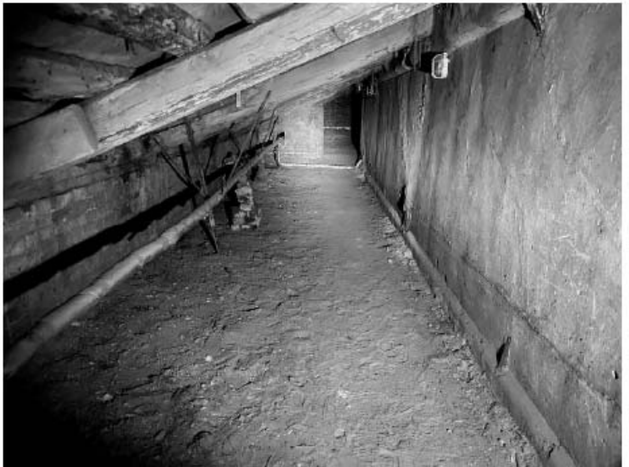
Фото 235. Чердак. Помещение б/нЗ(1).
