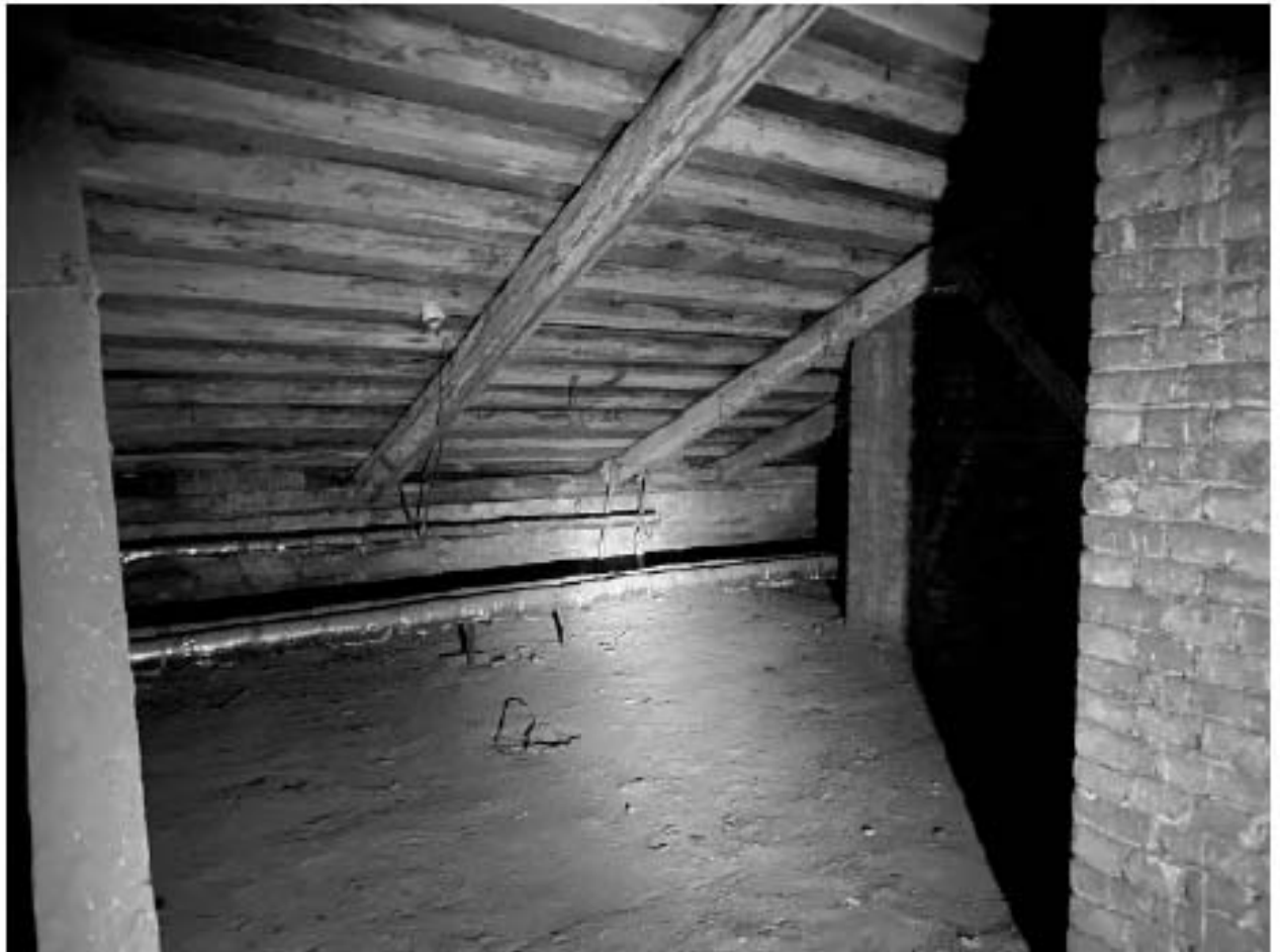
Фото 228. Чердак. Помещение б/нЗ(1).
