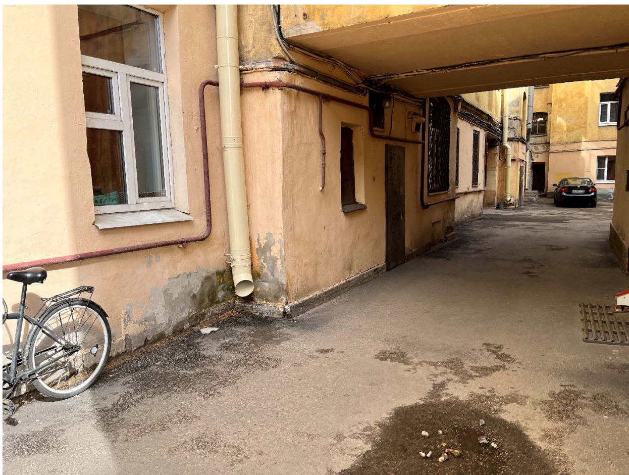
Фото №22. Дворовый (южный) фасад здания западная часть, вход в лестничную клетку Л-6.
