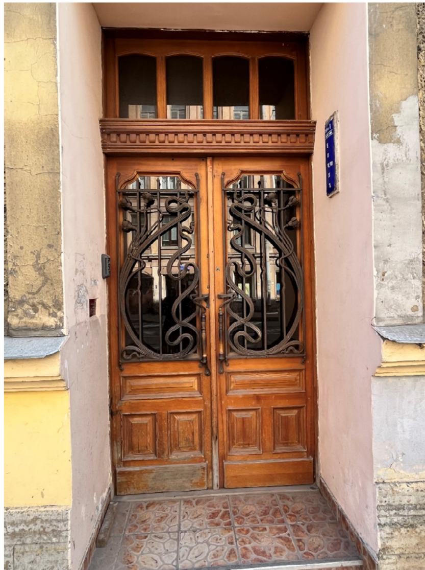
Фото №12. Вход в лестничную клетку Л-3, заполнение дверного проема, площадка входа из поздней керамической плитки.
