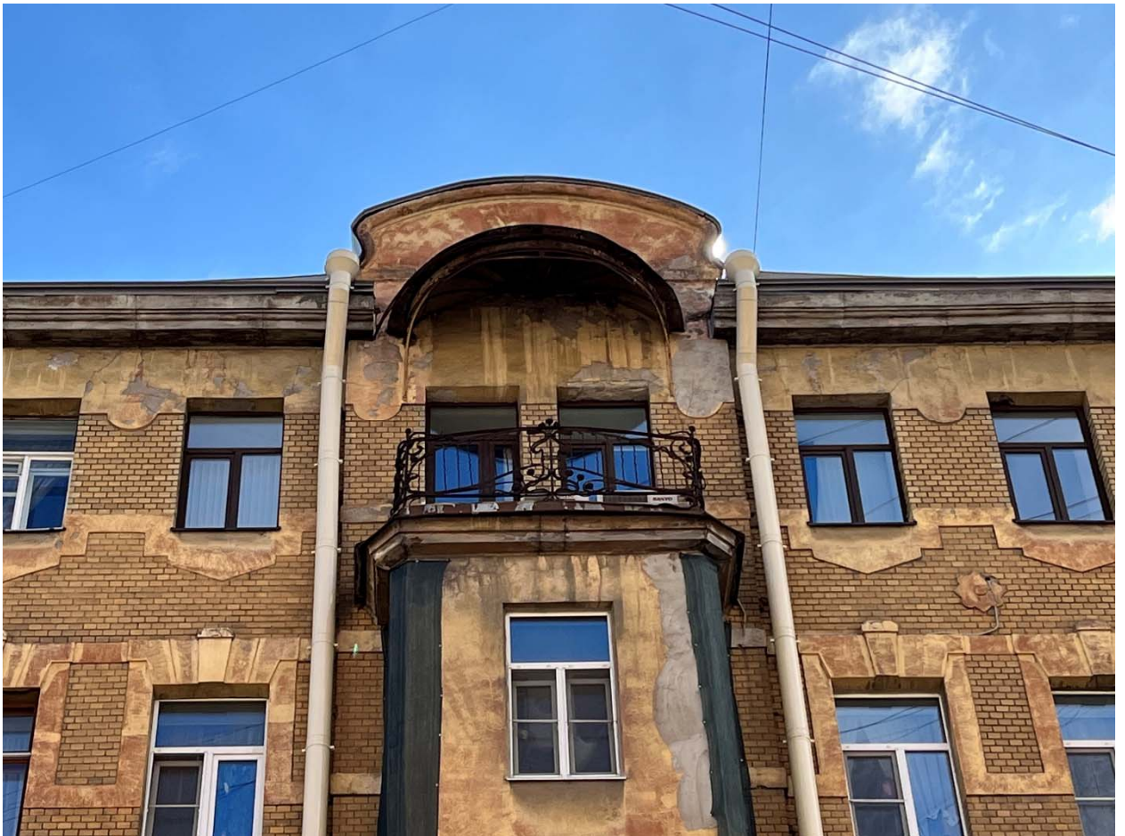
Фото №9. Балкон эркера восточной части лицевого (северного) фасада.
