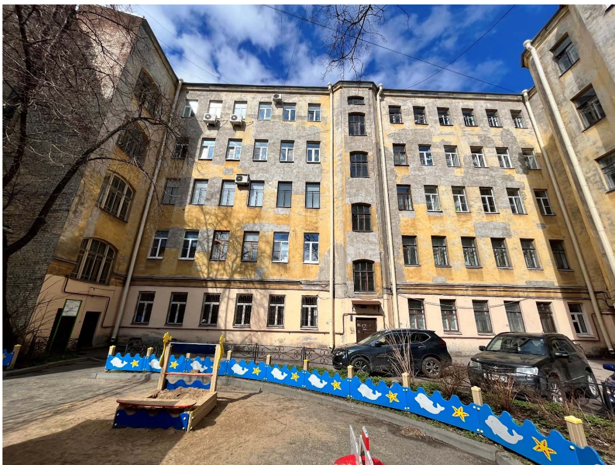
Фото №19. Дворовый (южный) фасад здания западная часть.
