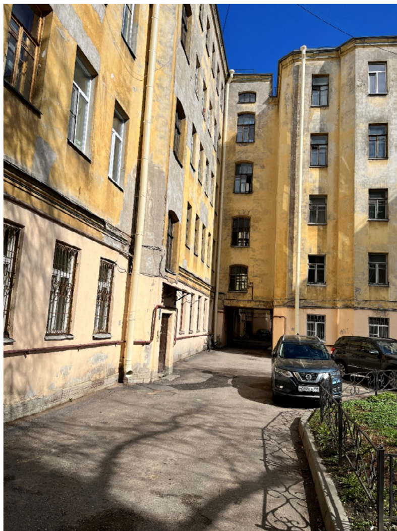
Фото №20. Дворовый (южный) фасад здания западная часть.
