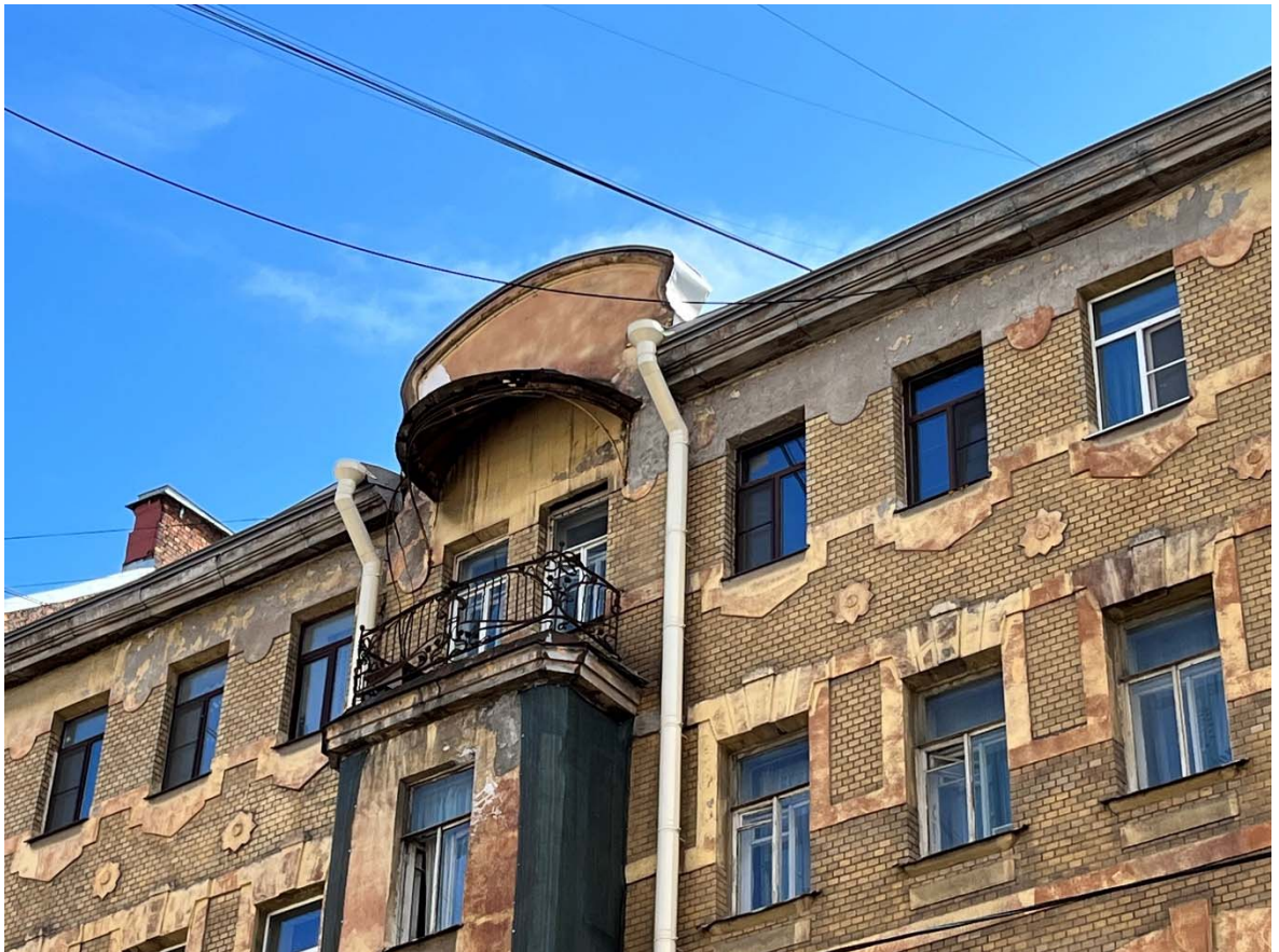
Фото №8. Балкон эркера западной части лицевого (северного) фасада.
