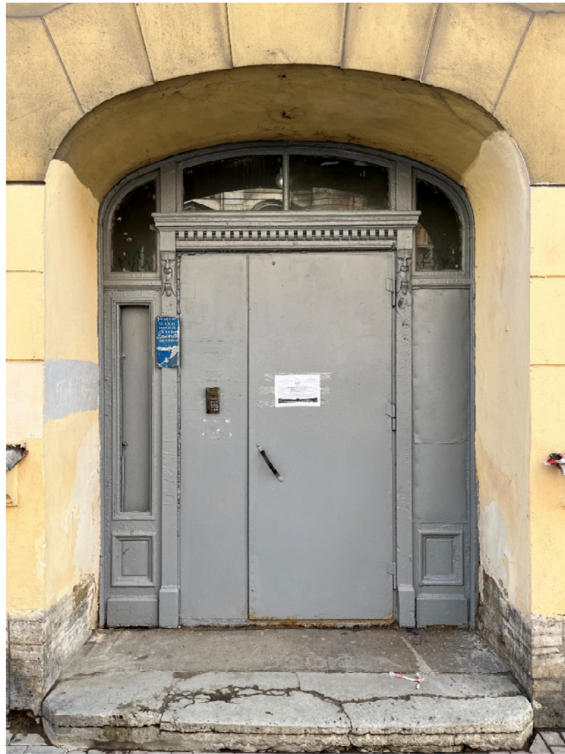
Фото №11. Вход в лестничную клетку Л-2, заполнение дверного проема, каменная площадка.
