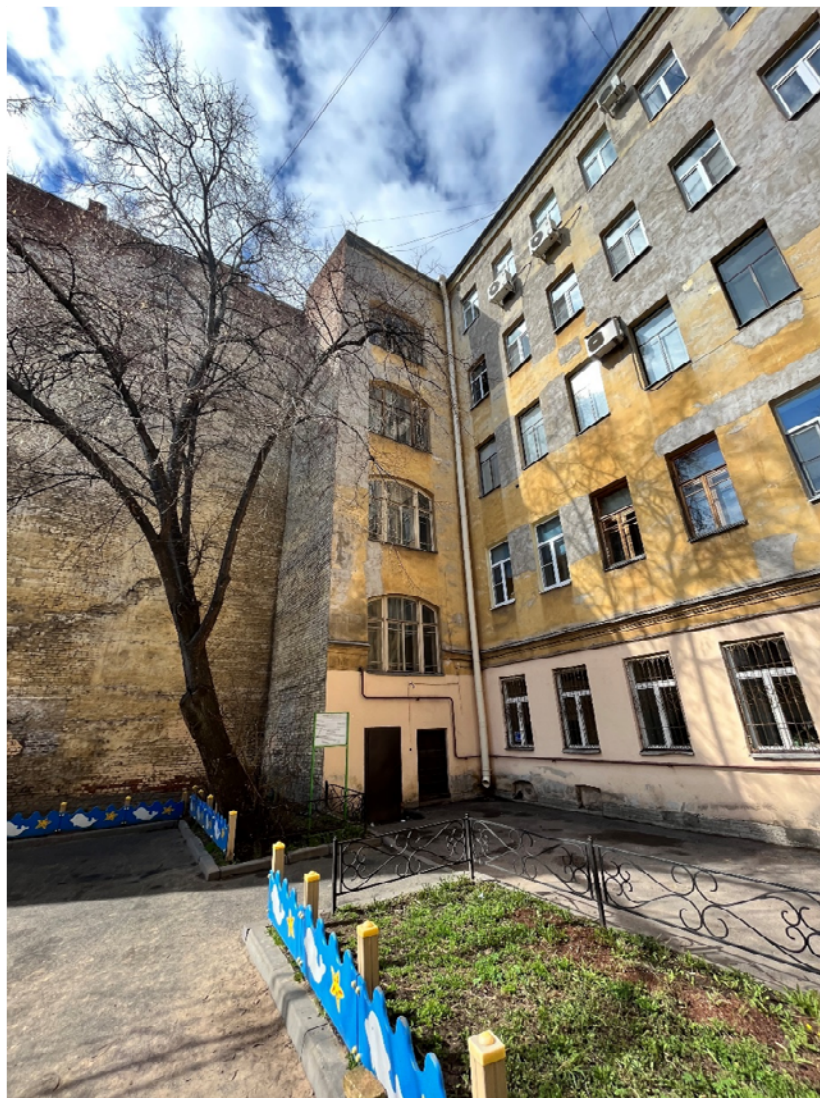
Фото №17. Дворовый (южный) фасад здания западная часть.
