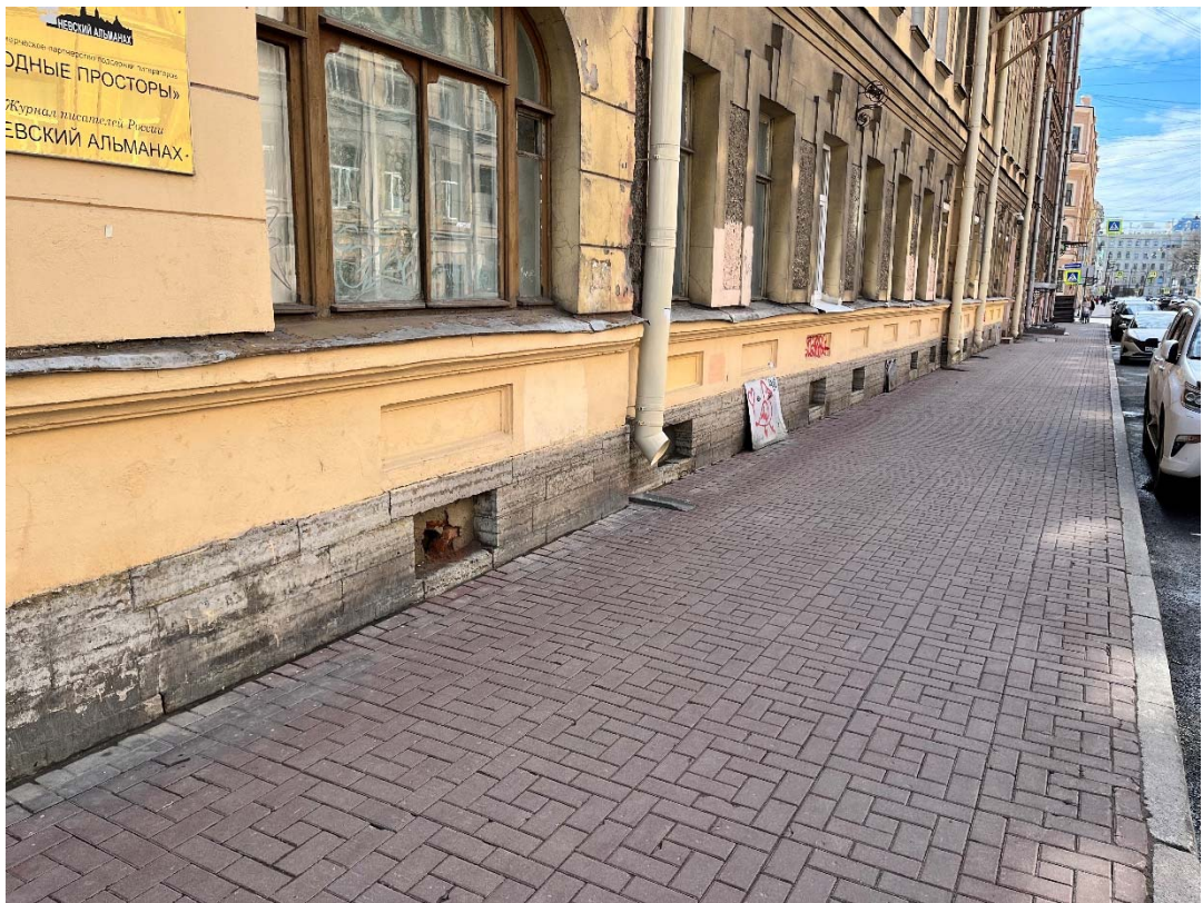
Фото №10. Цокольная часть лицевого (северного) фасада, отмостка.
