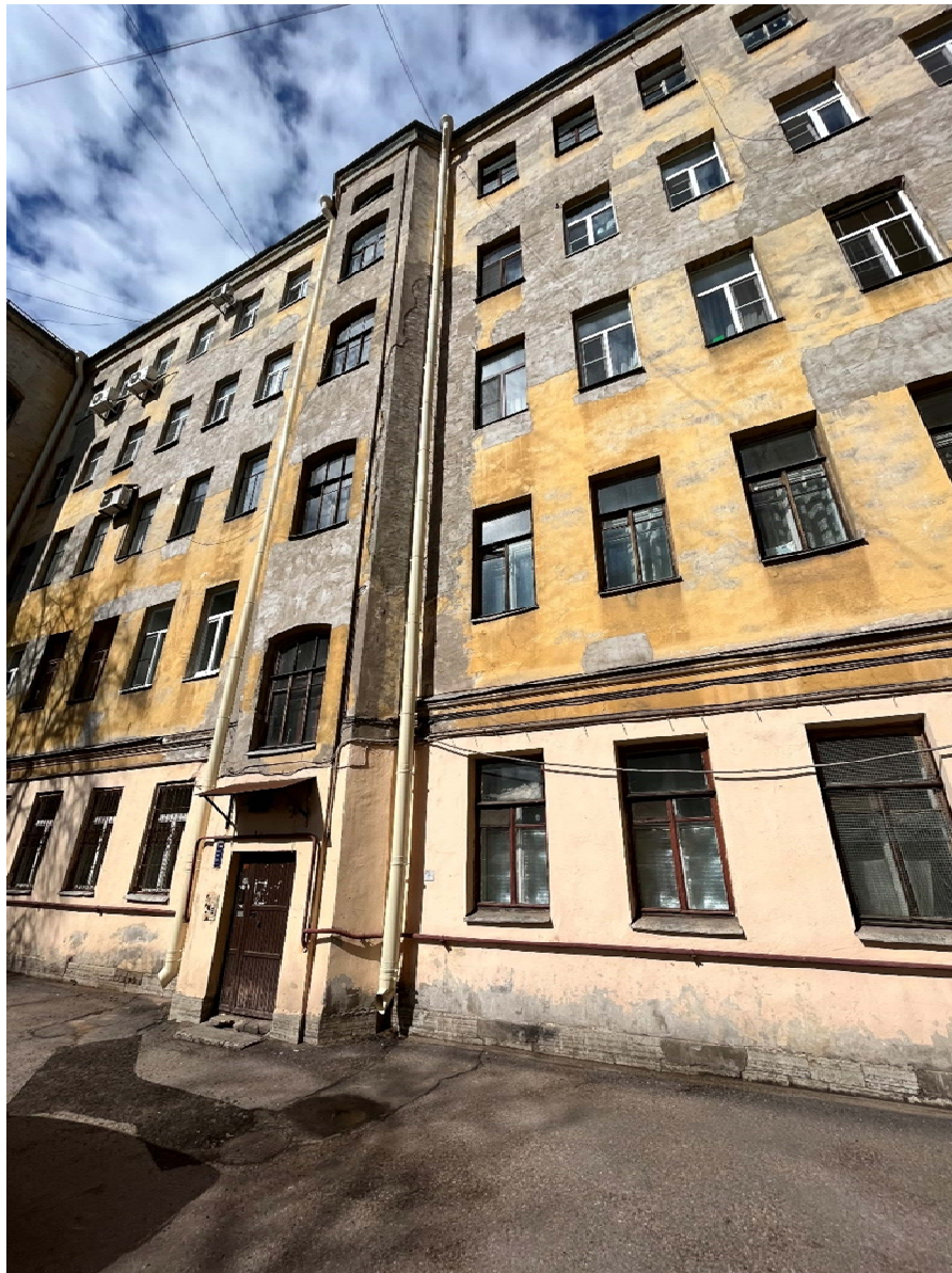
Фото №15. Дворовый (южный) фасад здания западная часть.
