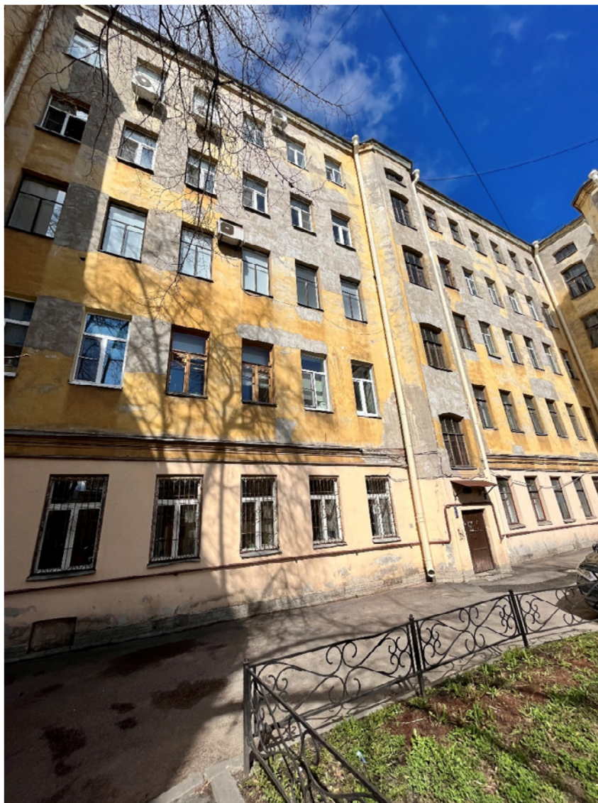
Фото №16. Дворовый (южный) фасад здания западная часть.
