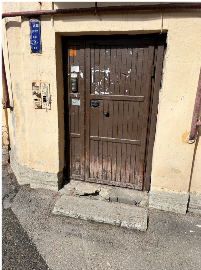
Фото №21. Дворовый (южный) фасад здания западная часть, вход в лестничную клетку Л-6.
