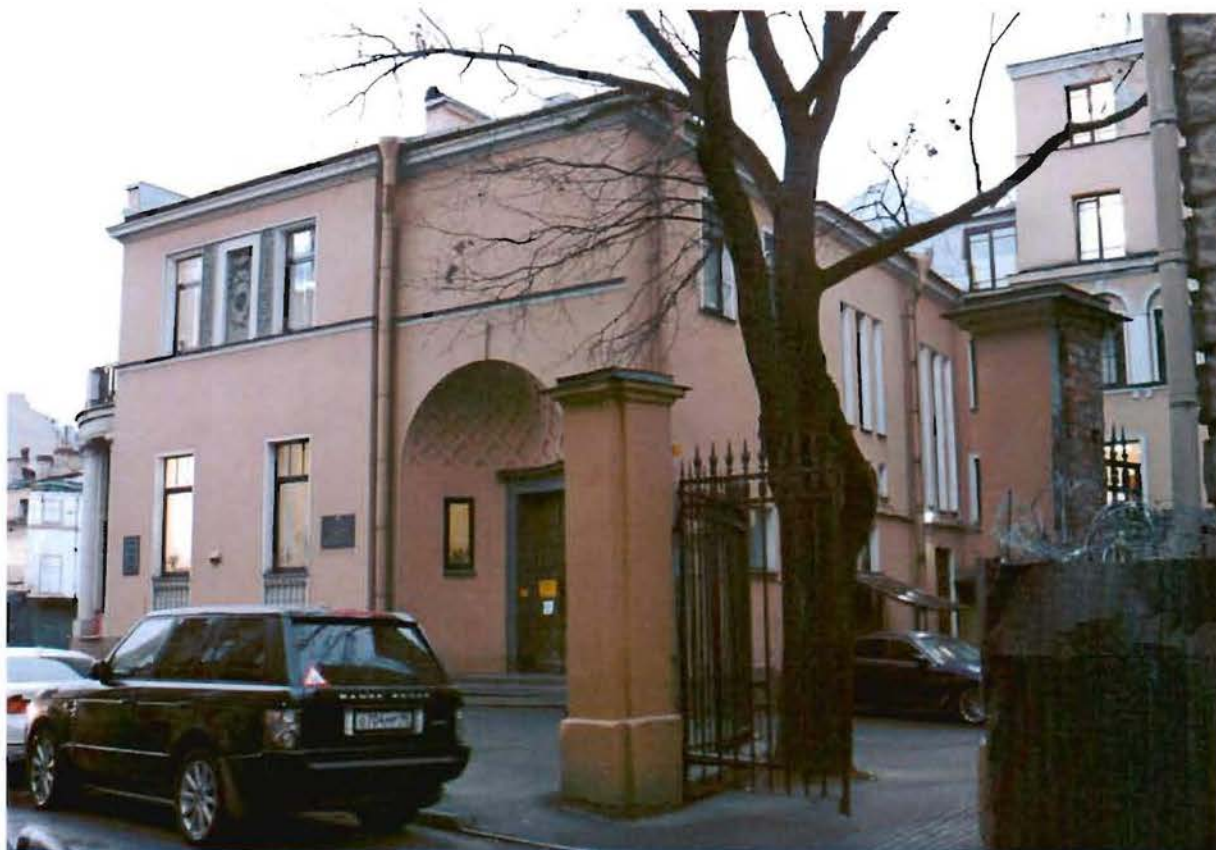
Фото №2. Вид со стороны Карповского переулка.
