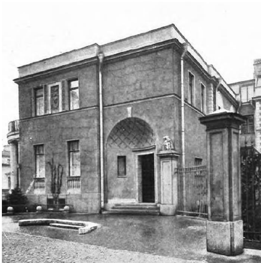
Илл. 7 Каменноостровский пр., 48. Особняк М.К. Покотиловой. Лицевой северный фасад. Фото 1910-1911 гг. Хранится: ЦГА КФФД СПб. Е 17247. Оpubл.: Привалов В.Д. Каменноостровский проспект. М., 2005. С. 479;
