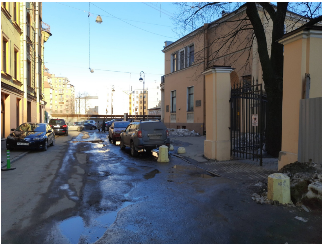
Фото 3. Дворовый фасад со стороны Карповского переулка и ограда
