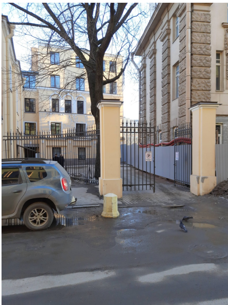
Фото 4. Дворовый фасад со стороны Карповского переулка и ограда
