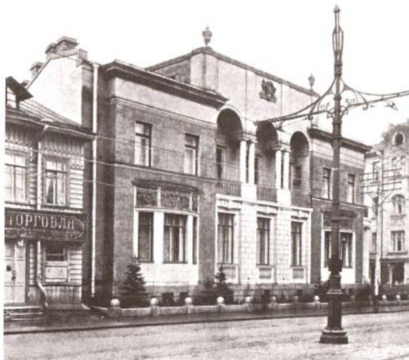
Илл. 8 Каменноостровский пр., 48. Особняк М.К. Покотиловой. Лицевой восточный фасад. Фото 1910-1911 гг. Хранится: ЦГА КФФД СПб. Е 17249. Оpubл.: Привалов В.Д. Каменноостровский проспект. М., 2005. С. 478;
