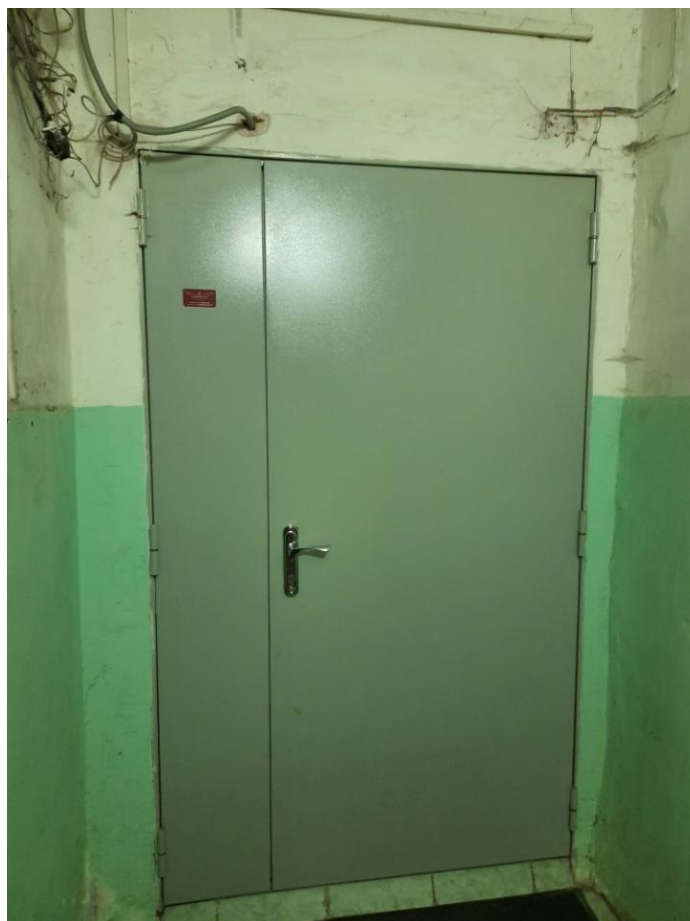
Фото 11 Интерьер помещения 1-Н выявленного объекта культурного наследия «Здание Главной конторы» в составе ансамбля «Комплекс построек Александровского чугунолитейного завода (паровозные мастерские главного механического завода Николаевской железной дороги)»
