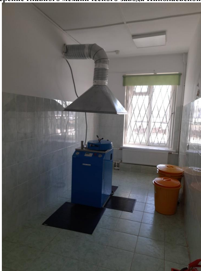
Фото 24 Интерьер помещения 1-Н выявленного объекта культурного наследия «Здание Главной конторы» в составе ансамбля «Комплекс построек Александровского чугунолитейного завода (паровозные мастерские главного механического завода Николаевской железной дороги)»
