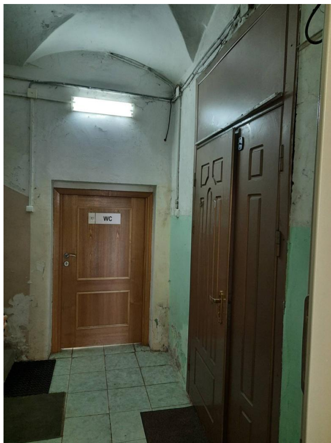
Фото 7 Интерьер помещения 2-Н выявленного объекта культурного наследия «Здание Главной конторы» в составе ансамбля «Комплекс построек Александровского чугунолитейного завода (паровозные мастерские главного механического завода Николаевской железной дороги)»
