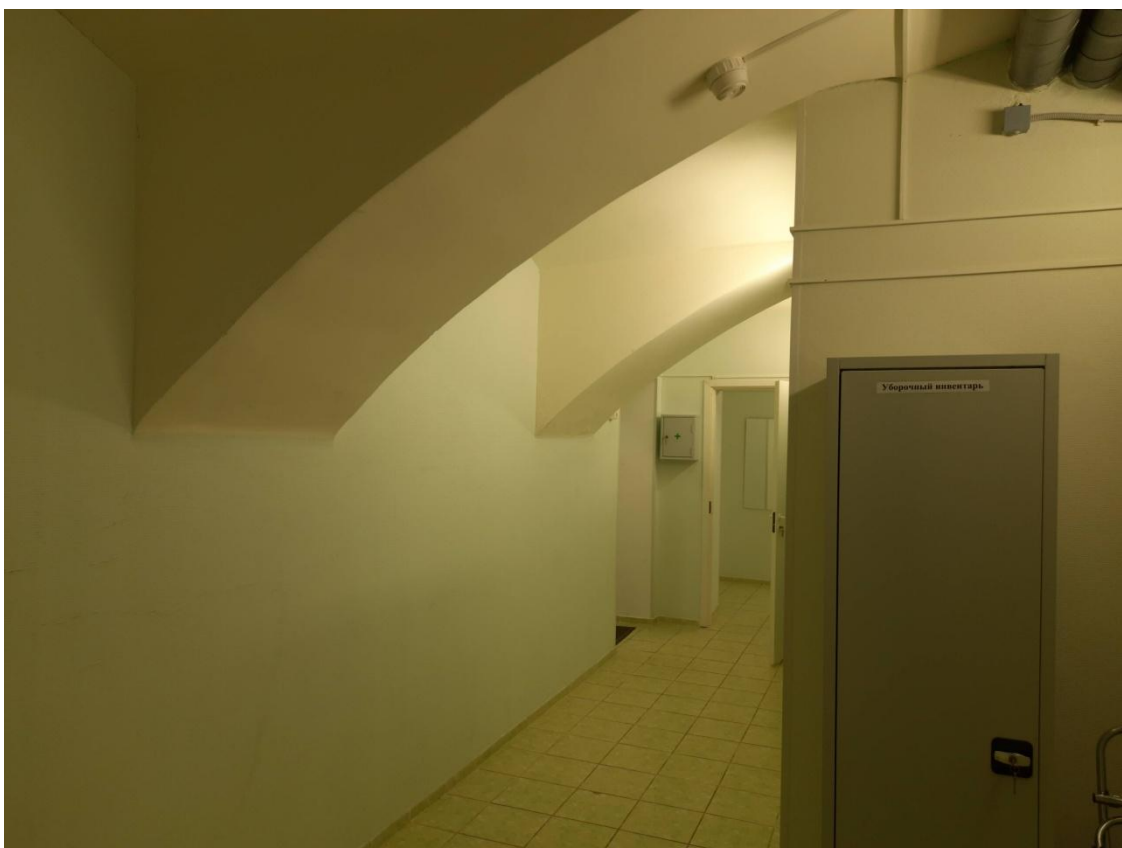
Фото 21 Интерьер помещения 1-Н выявленного объекта культурного наследия «Здание Главной конторы» в составе ансамбля «Комплекс построек Александровского чугунолитейного завода (паровозные мастерские главного механического завода Николаевской железной дороги)»
