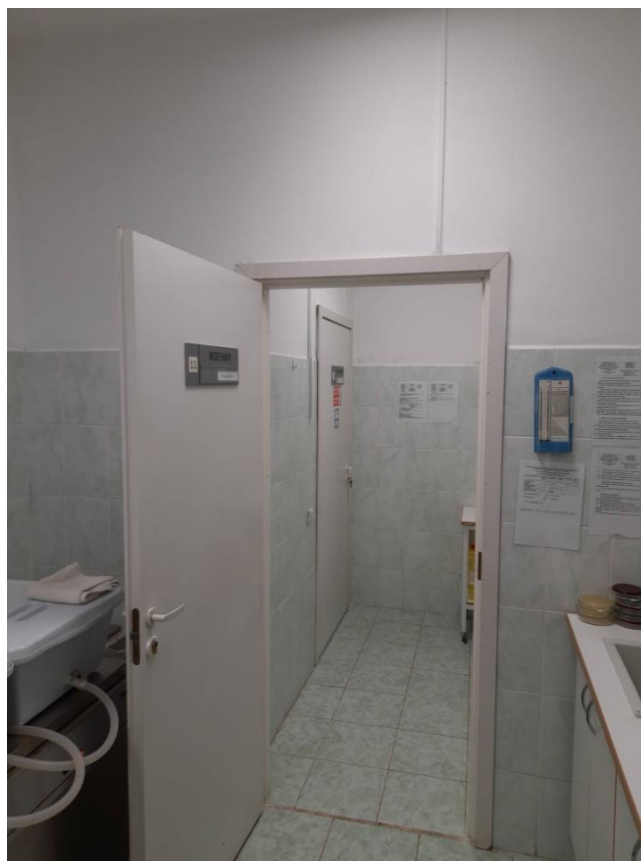
Фото 23 Интерьер помещения 1-Н выявленного объекта культурного наследия «Здание Главной конторы» в составе ансамбля «Комплекс построек Александровского чугунолитейного завода (паровозные мастерские главного механического завода Николаевской железной дороги)»
