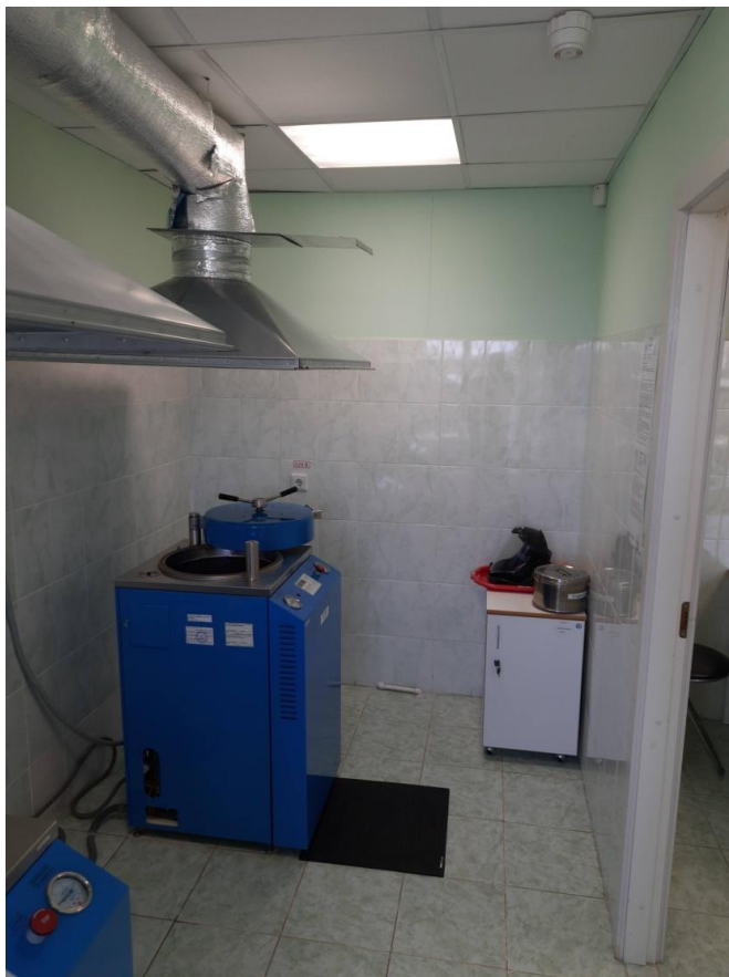
Фото 43 Интерьер помещения 1-Н выявленного объекта культурного наследия «Здание Главной конторы» в составе ансамбля «Комплекс построек Александровского чугунолитейного завода (паровозные мастерские главного механического завода Николаевской железной дороги)»
