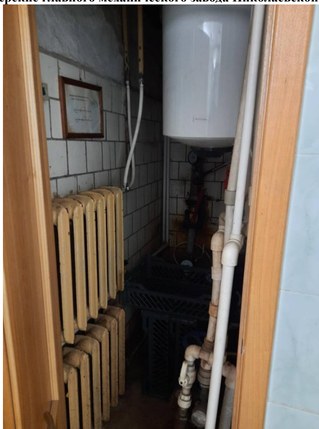
Фото 10 Интерьер помещения 2-Н выявленного объекта культурного наследия «Здание Главной конторы» в составе ансамбля «Комплекс построек Александровского чугунолитейного завода (паровозные мастерские главного механического завода Николаевской железной дороги)»
