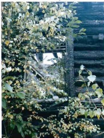
2. Оконный проем 1Н
