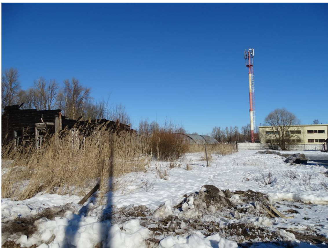
Илл. 02. Объект культурного наследия регионального значения "Жилой дом" по адресу: Санкт-Петербург, г. Ломоносов, ул. Рубакина, д. 11, лит. А. Вид на восточную часть территории. Съемка 01.03.2022 г. Трушковский В. Э.
