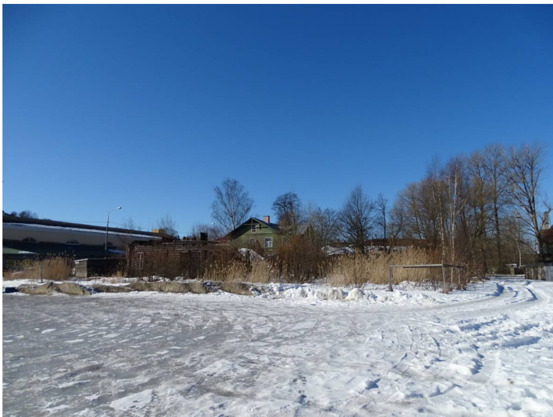
Илл. 12. Объект культурного наследия регионального значения "Жилой дом" по адресу: Санкт-Петербург, г. Ломоносов, ул. Рубакина, д. 11, лит. А. Вид с северо-восточной стороны. Съемка 01.03.2022 г. Трушковский В. Э.
