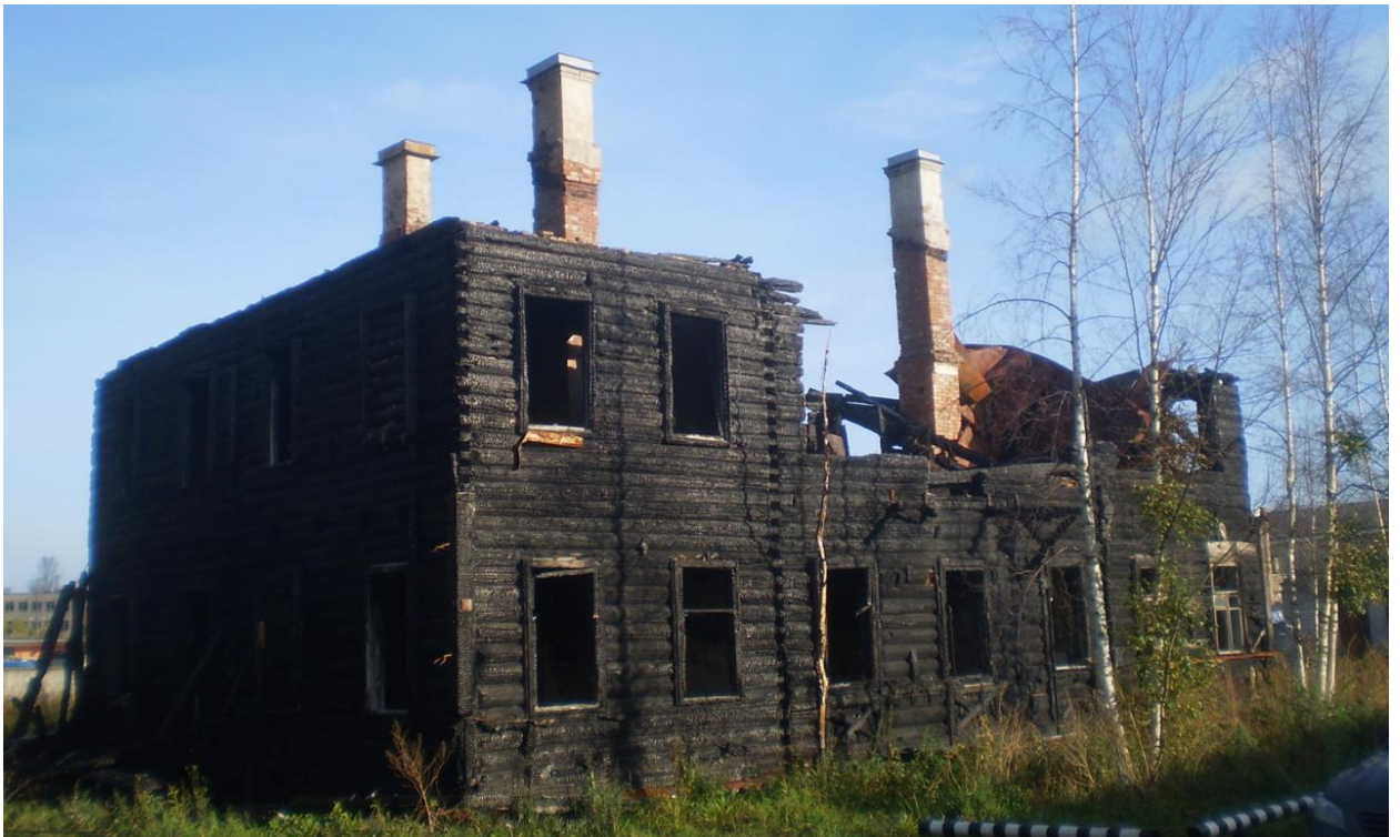
Илл. 14. Здание по адресу: ул. Рубакина, 11. Фотография после пожара 2012 г. https://www.citywalls.ru/photo381083.html
