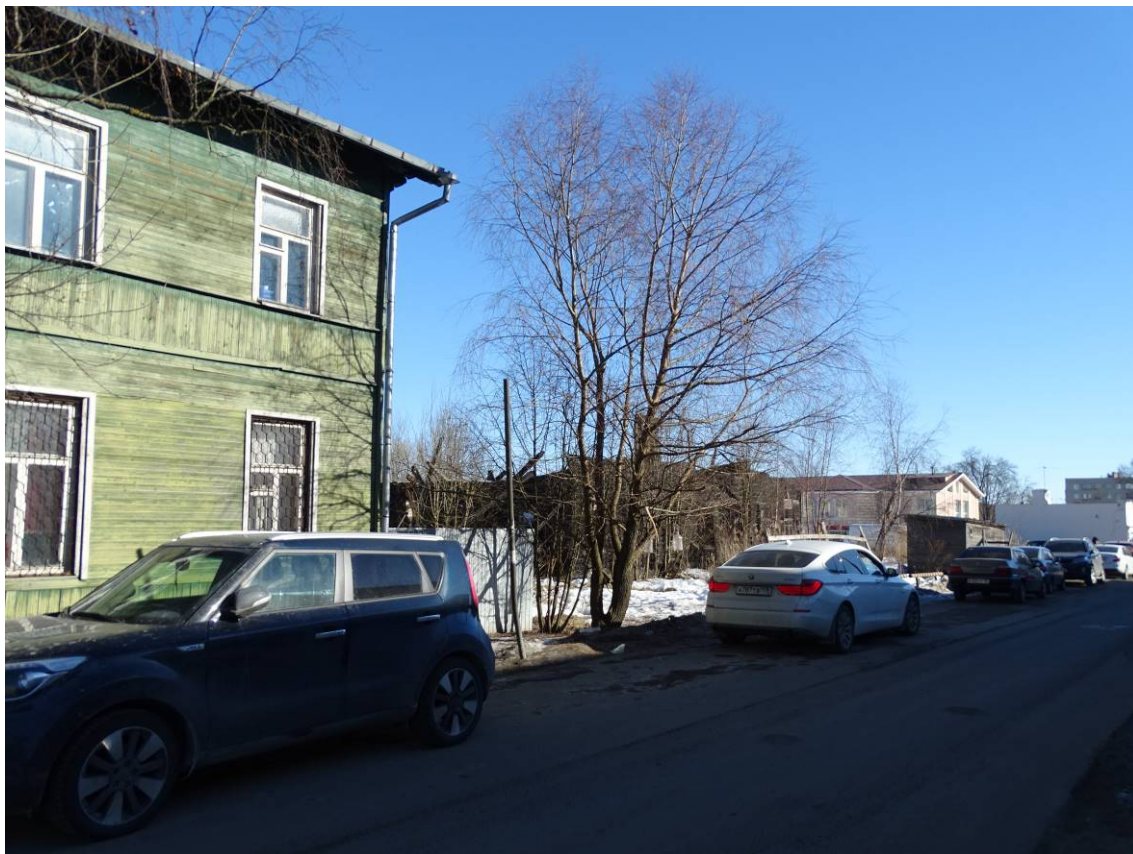
Илл. 13. Объект культурного наследия регионального значения "Жилой дом" по адресу: Санкт-Петербург, г. Ломоносов, ул. Рубакина, д. 11, лит. А. Вид с юго-западной стороны. Съемка 01.03.2022 г. Трушковский В. Э.
