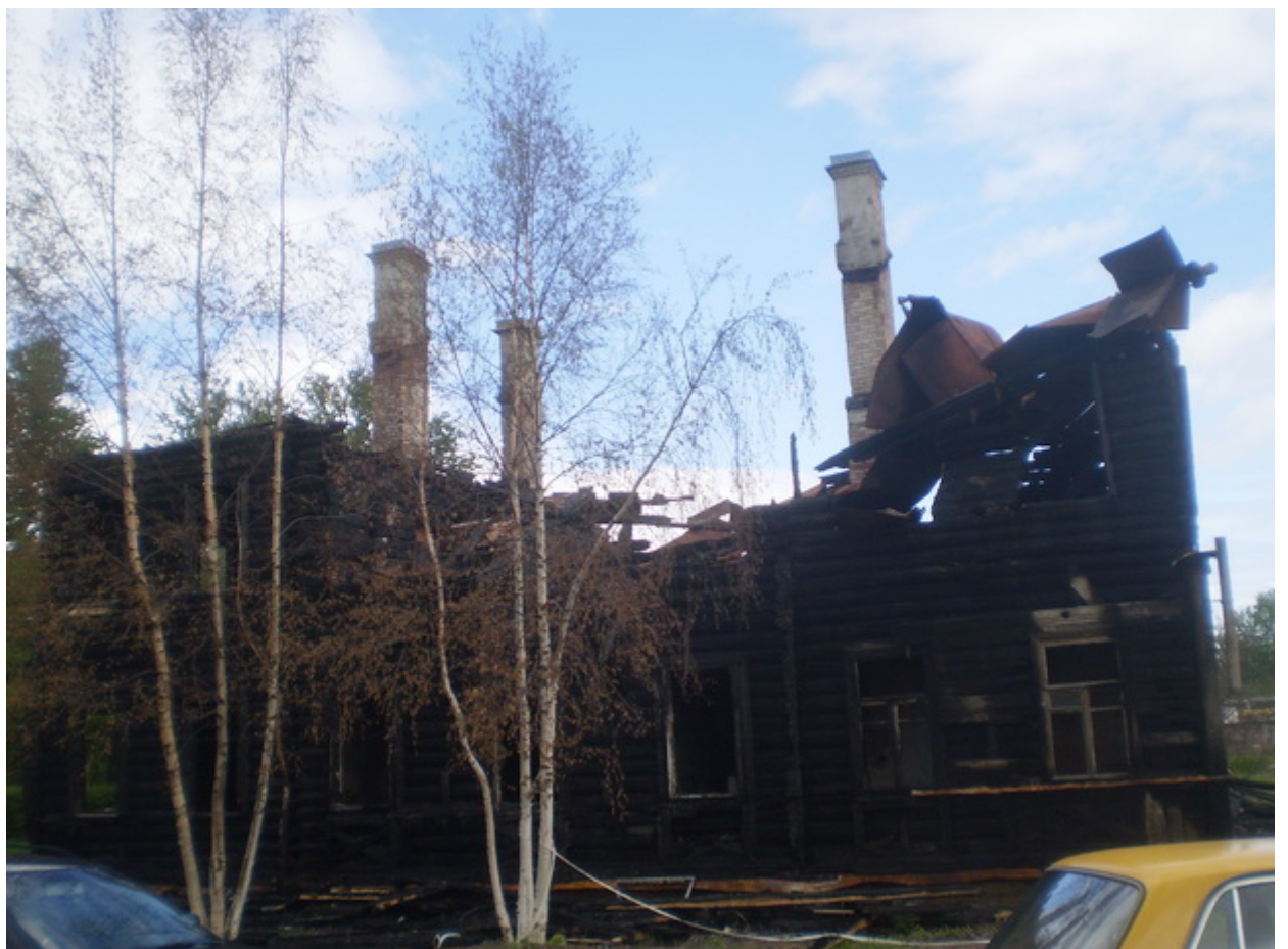
Илл. 15. Здание по адресу: ул. Рубакина, 11. Фотография после пожара 2012 г. https://www.citywalls.ru/photo126455.html
