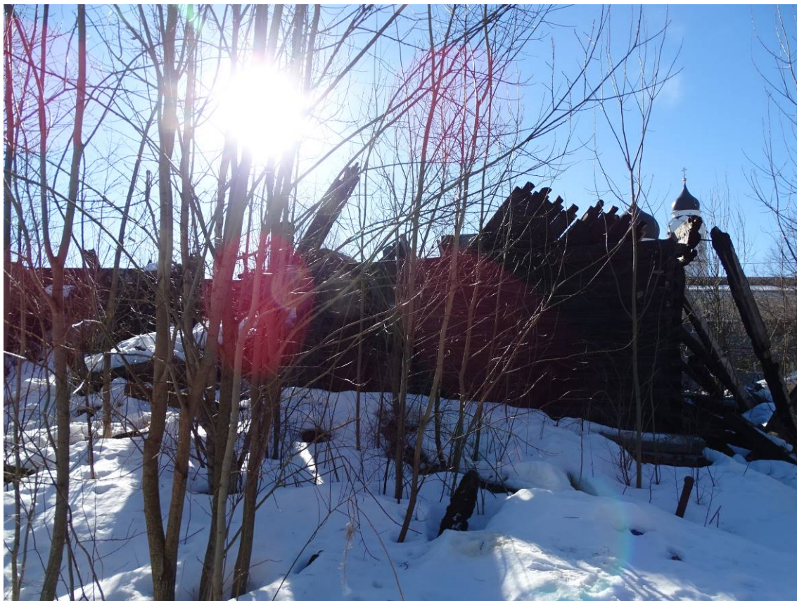
Илл. 09. Объект культурного наследия регионального значения "Жилой дом" по адресу: Санкт-Петербург, г. Ломоносов, ул. Рубакина, д. 11, лит. А. Северный фасад. Съемка 01.03.2022 г. Трушковский В. Э.
