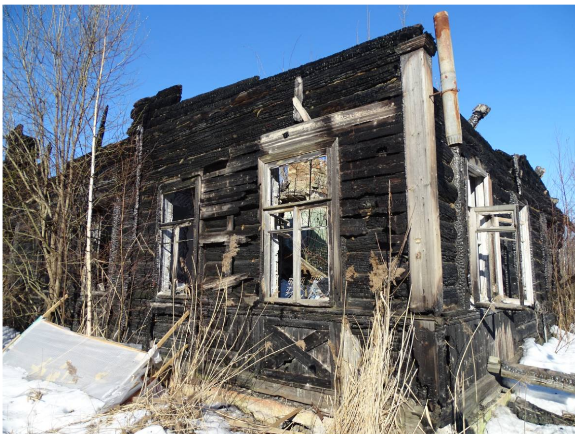
Илл. 04. Объект культурного наследия регионального значения "Жилой дом" по адресу: Санкт-Петербург, г. Ломоносов, ул. Рубакина, д. 11, лит. А. Юго-восточная часть здания. Съемка 01.03.2022 г. Трушковский В. Э.
