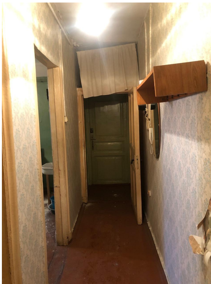
Фото 9. Коридор. Вид на входную дверь.
