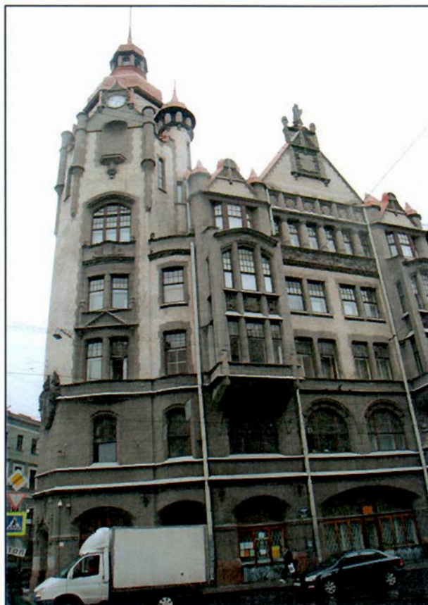
3. Фрагмент. Юго-восточный фасад.
