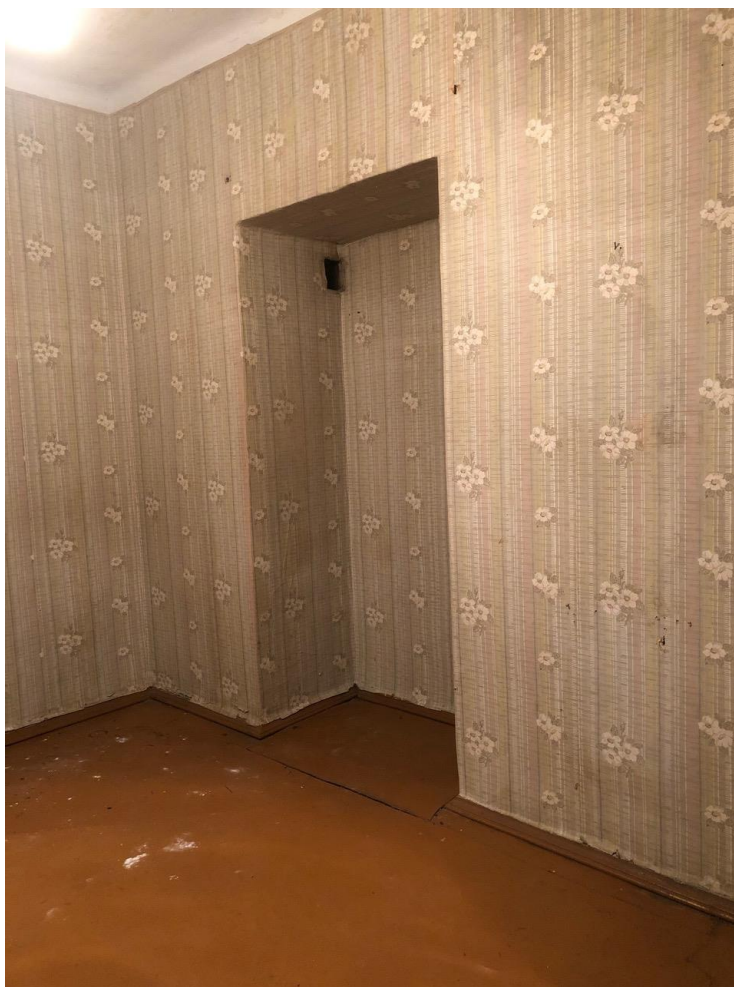
Фото 13. Помещение без окна (пом.4)
