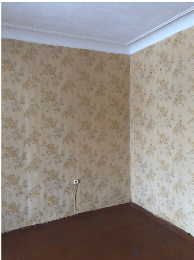
Фото 15. Жилая комната (пом. 5)
