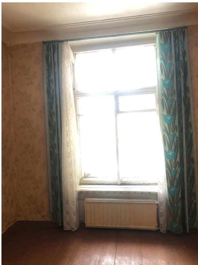
Фото 16. Окно жилой комнаты (пом.5)
