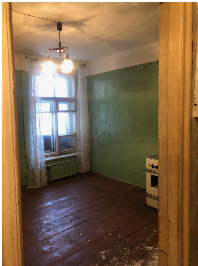
Фото 7. Кухня. Вид из коридора.
