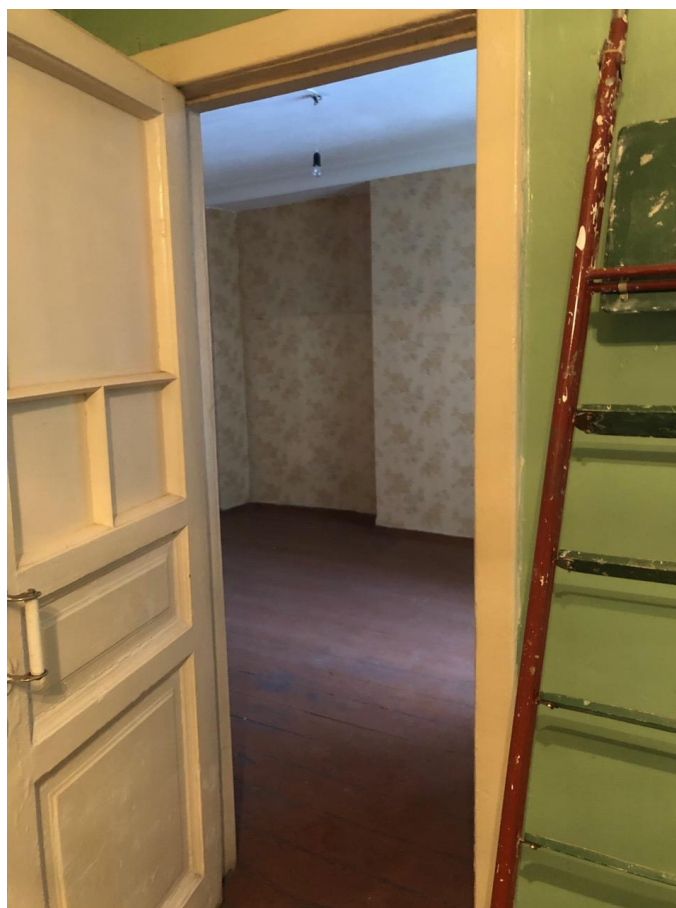
Фото 18. Кухня. Вид на проем в жилую комнату (пом.5)
