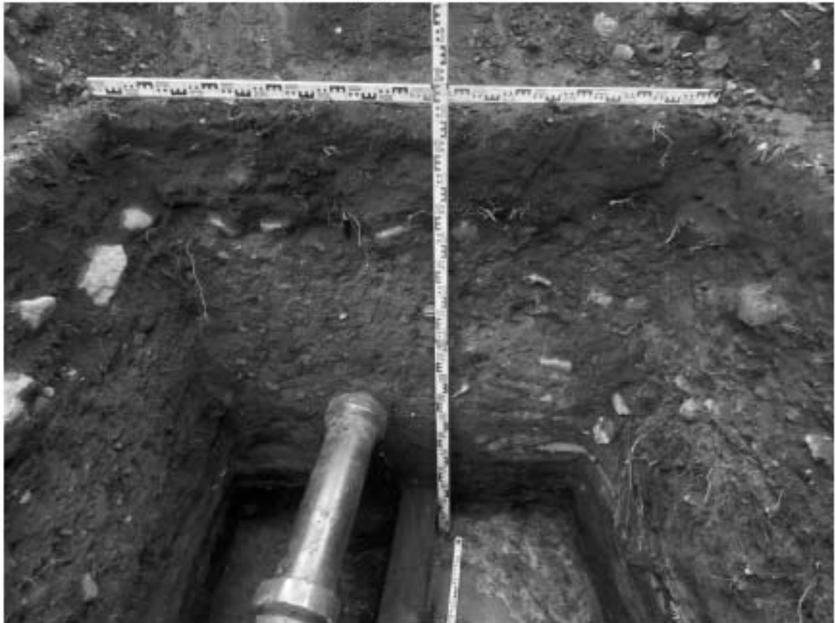
Рис. 39. г. Санкт-Петербург, г. Кронштадт, проспект Ленина, дом 39а, литера А (кадастровый номер: 78:34:1031501:3). Шурф 1. Северная стенка. Вид с юга
