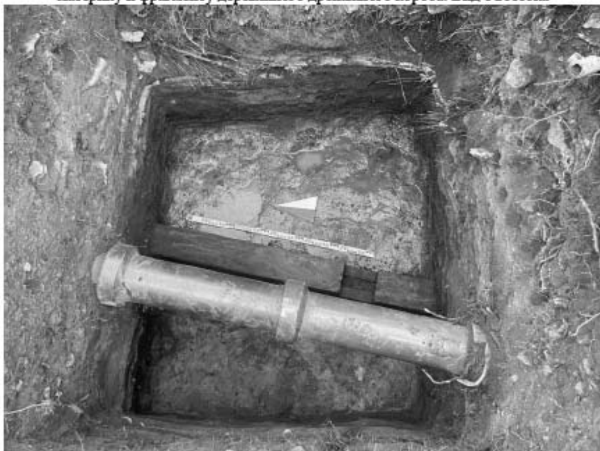
Рис. 36. г. Санкт-Петербург, г. Кронштадт, проспект Ленина, дом 39а, литера А (кадастровый номер: 78:34:1031501:3). Шурф 1. Уровень фиксации зачистки поверхности шурфа по материку и фрагменту деревянного дренажного короба. Вид с запада
