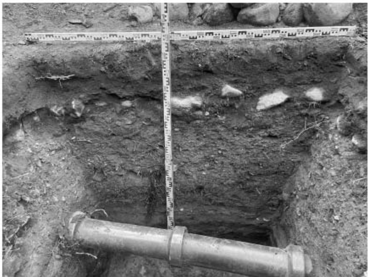
Рис. 43. г. Санкт-Петербург, г. Кронштадт, проспект Ленина, дом 39а, литера А (кадастровый номер: 78:34:1031501:3). Шурф 1. Западная стенка. Вид с востока
