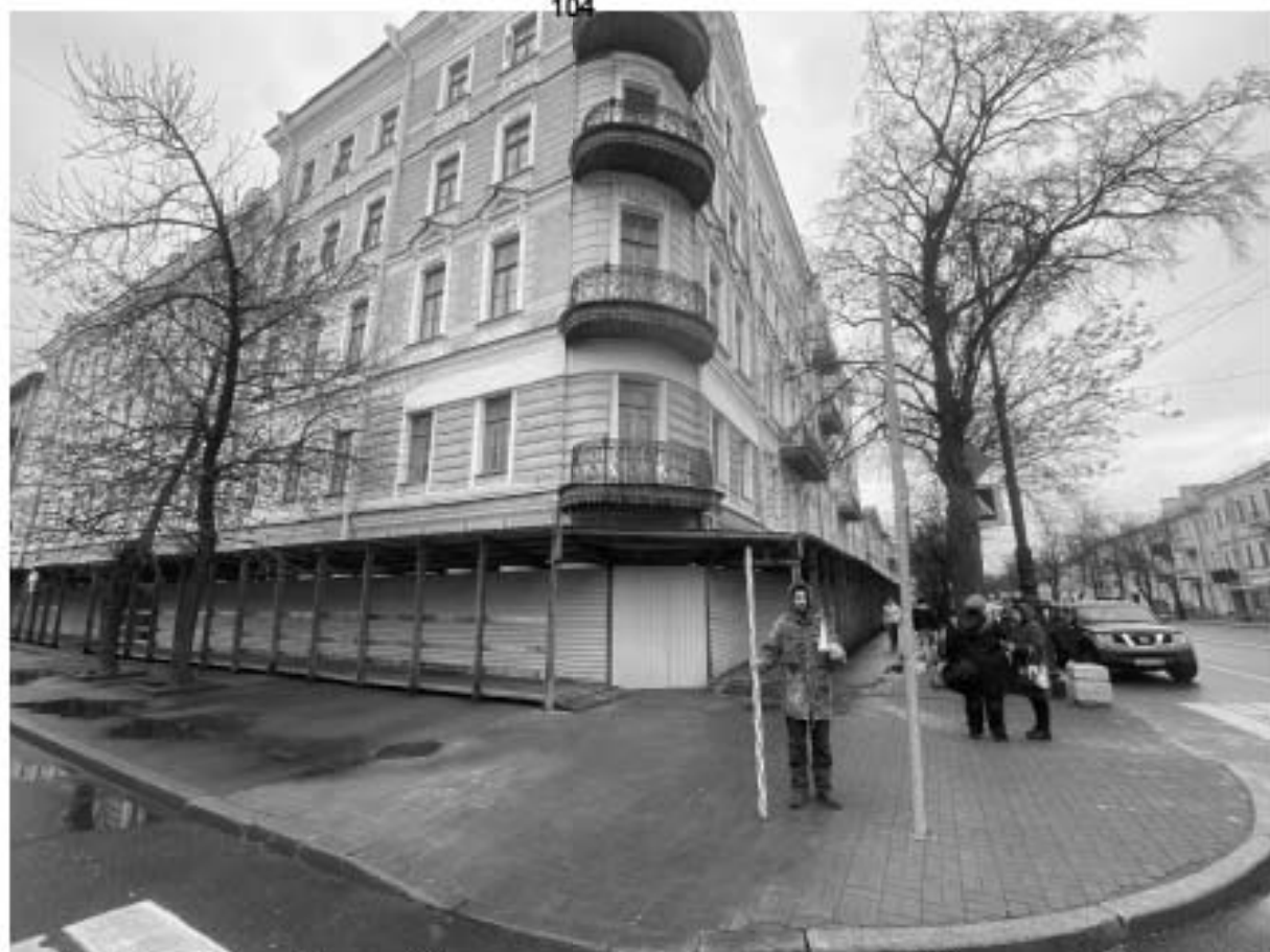
Рис. 17. г. Санкт-Петербург, г. Кронштадт, проспект Ленина, дом 39а, литера А (кадастровый номер: 78:34:1031501:3). Photo 2. Общий вид территории обследования. Вид с юга
