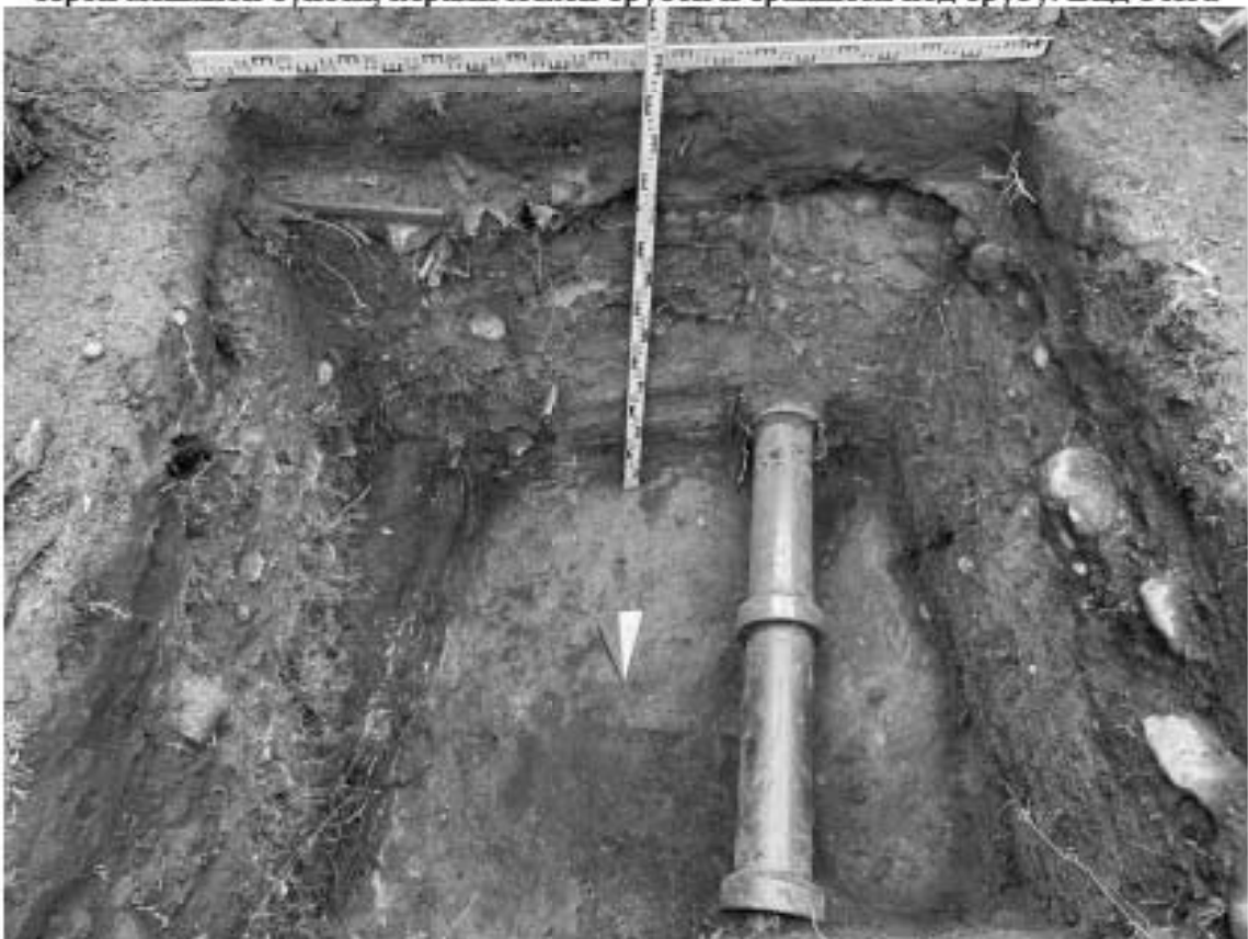
Рис. 32. г. Санкт-Петербург, г. Кронштадт, проспект Ленина, дом 39а, литера А (кадастровый номер: 78:34:1031501:3). Шурф 1. Уровень фиксации зачистки поверхности шурфа по слою серой мешаной супеси, керамической трубой и фрагментом траншеи под деревянный короб. Вид с севера
