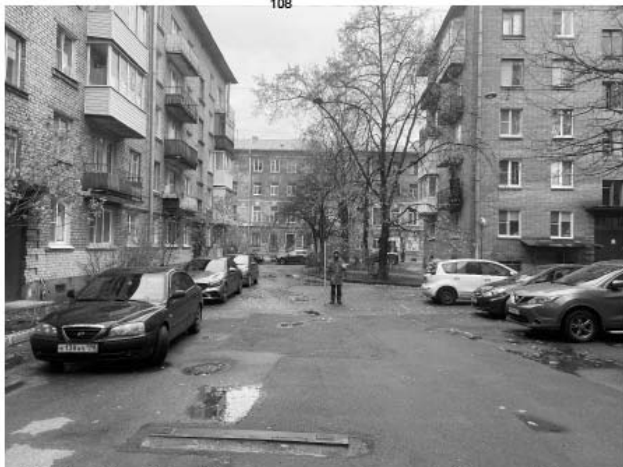
Рис. 25. г. Санкт-Петербург, г. Кронштадт, проспект Ленина, дом 39а, литера А (кадастровый номер: 78:34:1031501:3). Photo 7. Общий вид территории обследования. Вид с востока
