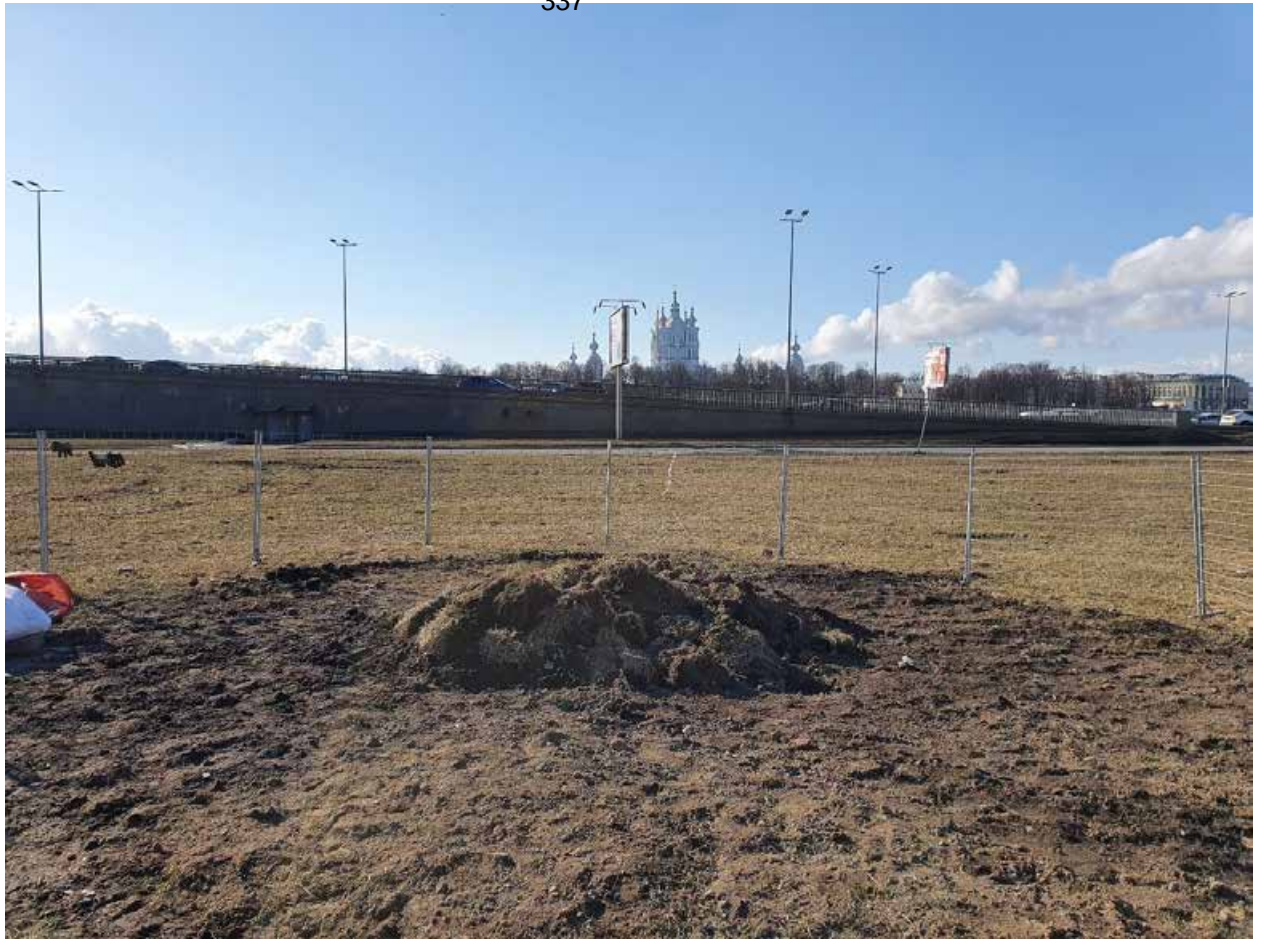
Рис. 155. СПб-2022. Красногвардейский район, Большеохтинский пр., участки 90,100. Шурф 4. Рекультивация. Вид с востока.
