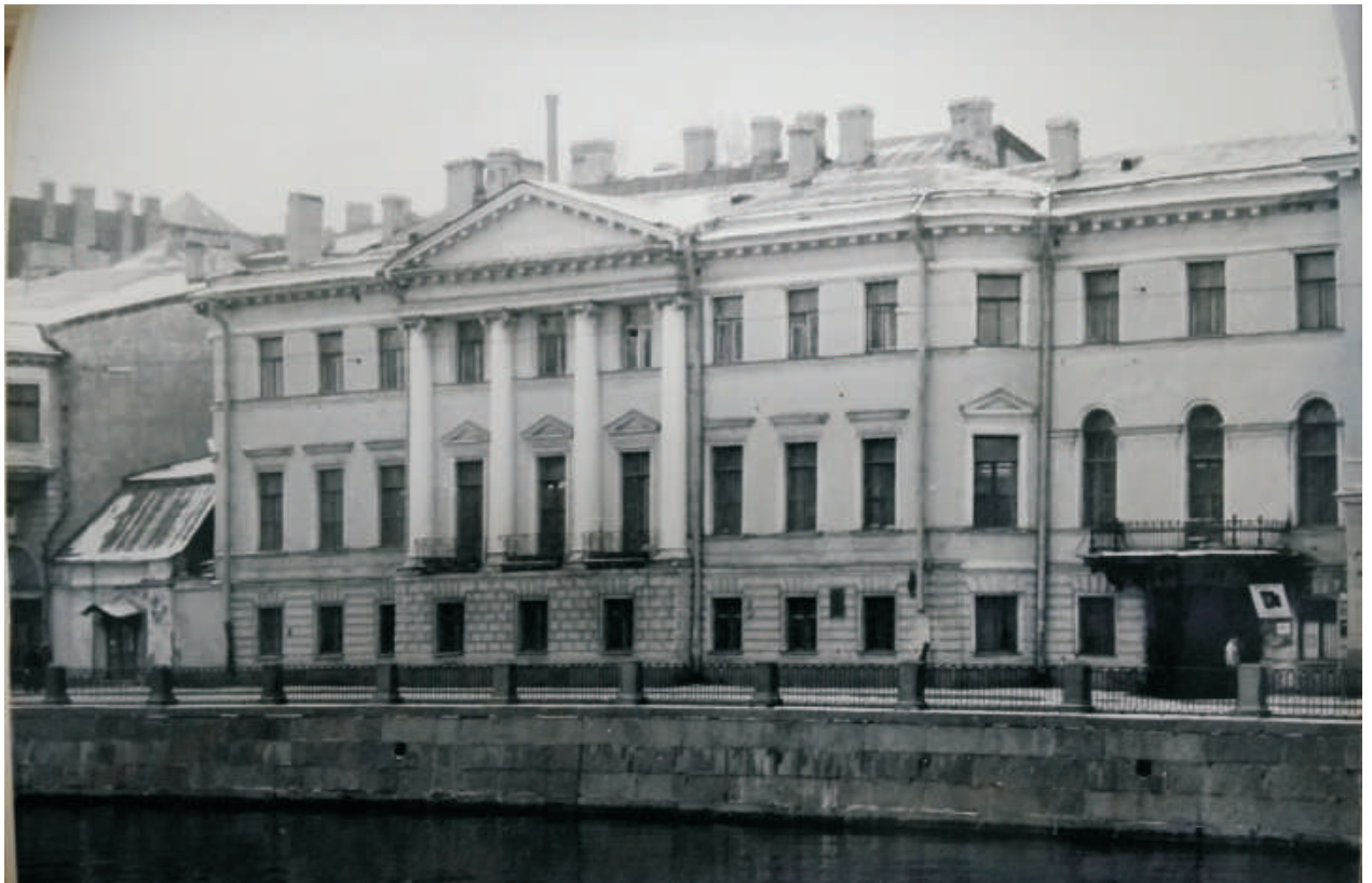
Ил. 58. Дом Голицына (Дом Министерства Императорского Двора). Общий вид фасада. Фото 1992 г. Автор снимка: В.Ф. Егоровский.
