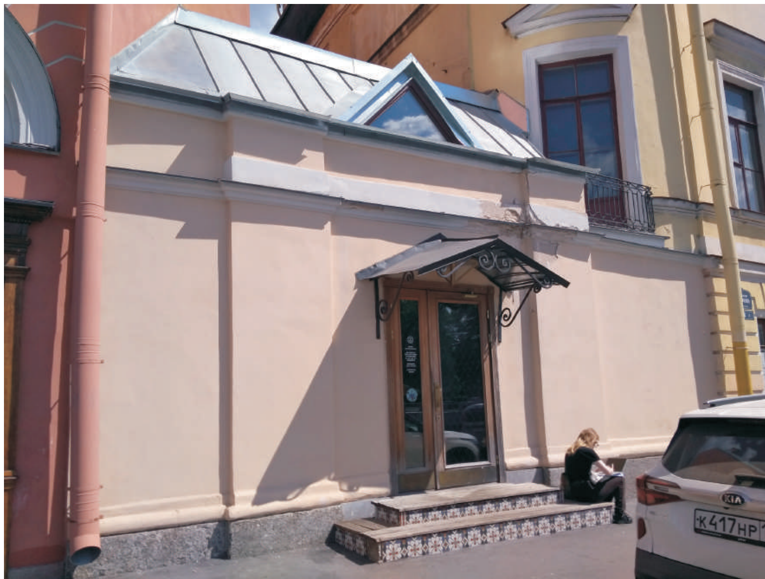
Ил. 75. Рассматриваемая пристройка между домами №20 и №18 по набережной реки Фонтанки. Фотография 10.06.2021 г.
