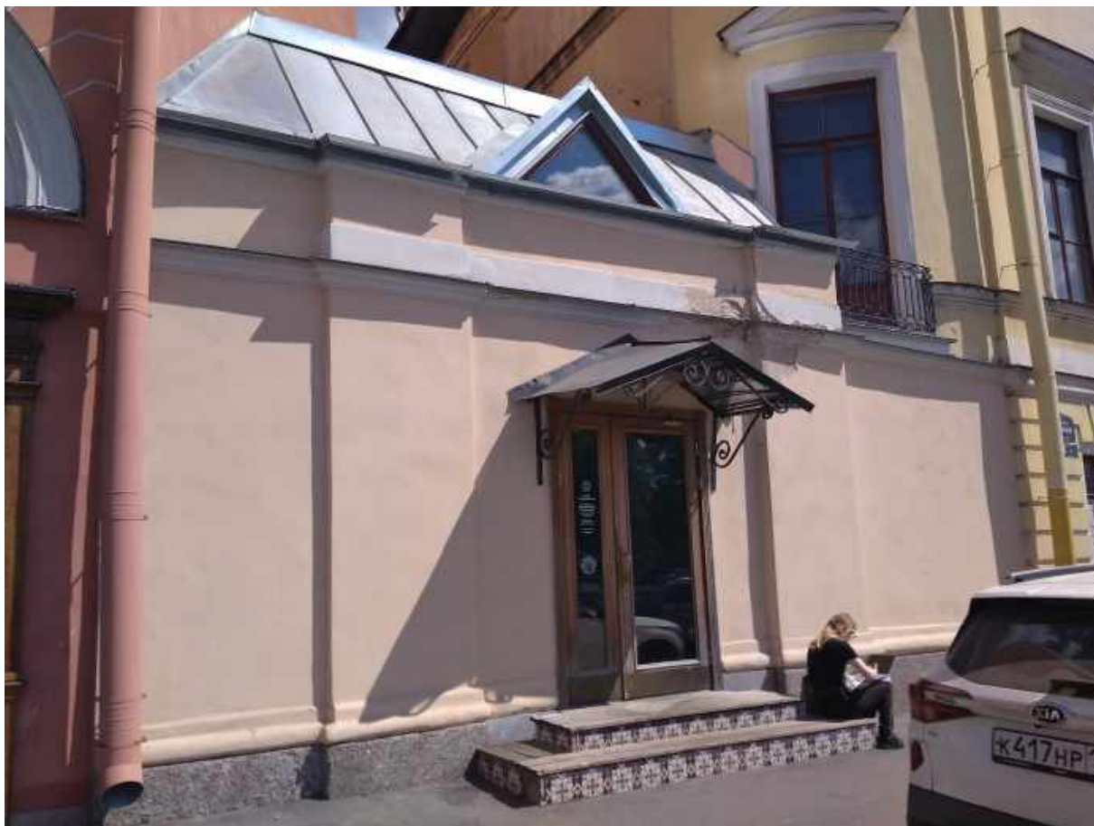
Фото№1: Общий вид рассматриваемого объекта здания со стороны набережной реки Фонтанки
