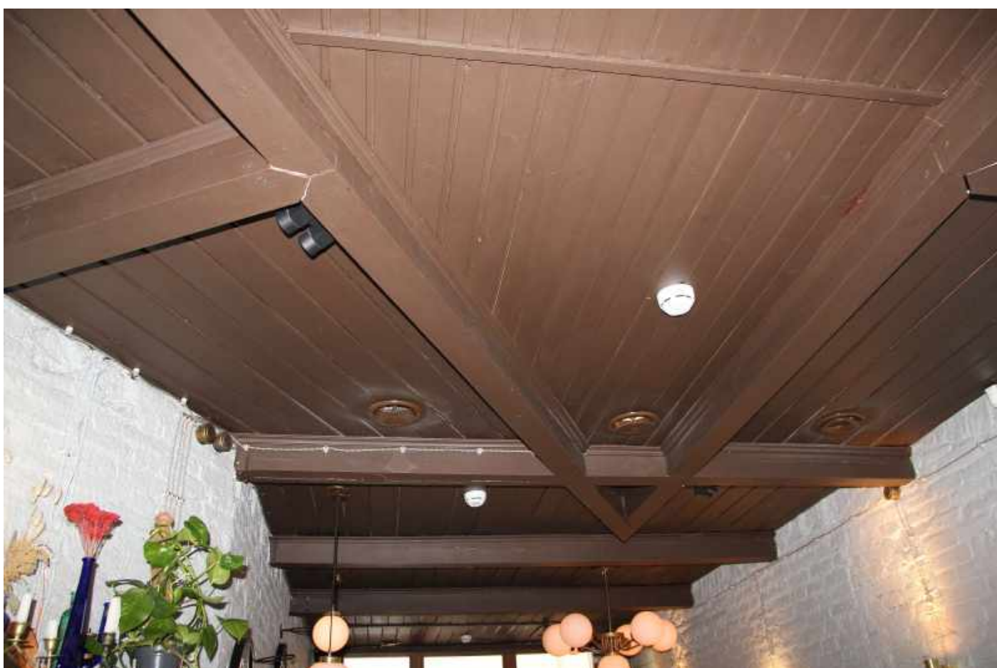
Фото№27: Вид на зашивку потолка деревянным сайдингом
