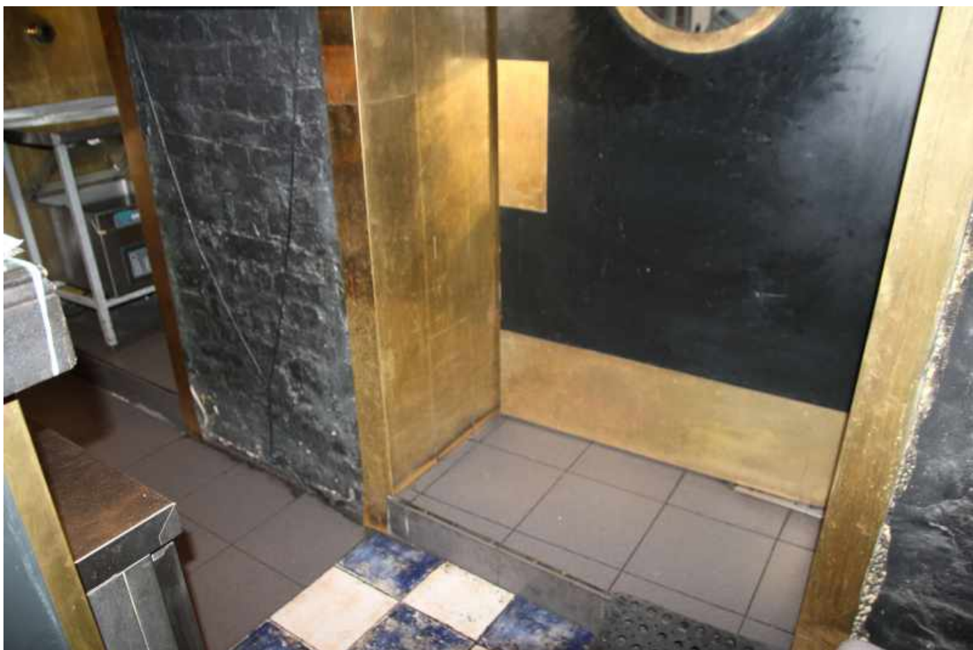
Фото№12: Фрагмент вида дверного заполнения входа на Кухню
