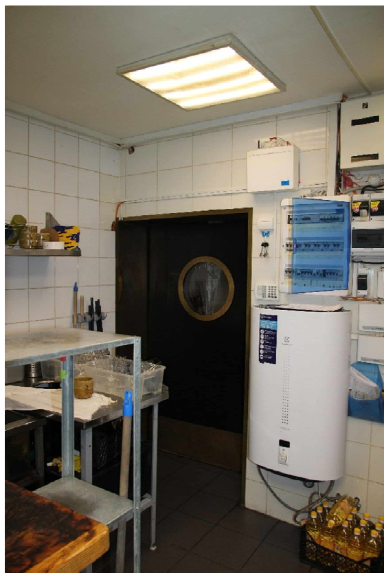
Фото№21: Вид дверного заполнения со стороны кухни
