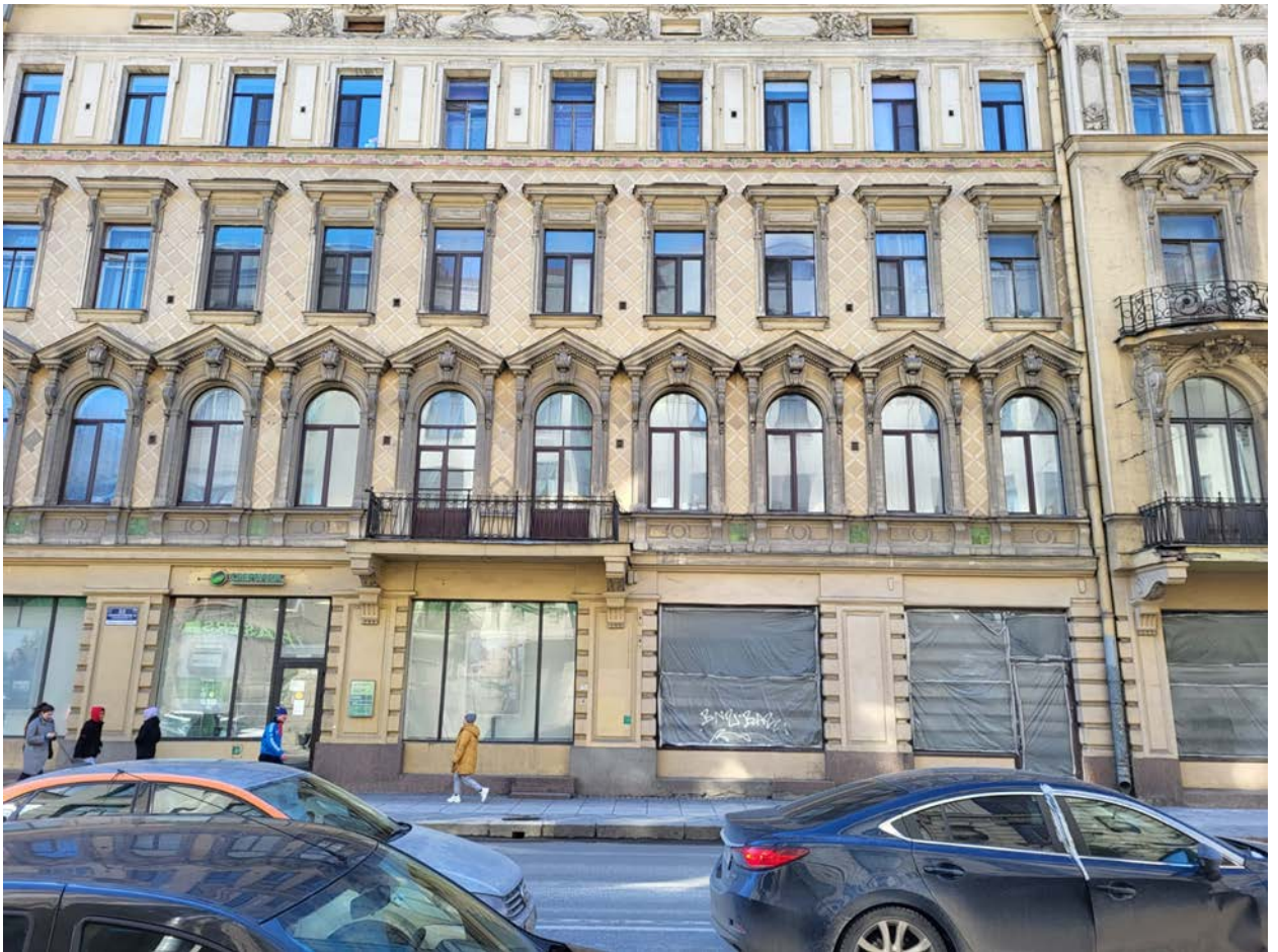
3. Северо-восточный лицевой фасад выявленного объекта культурного наследия «Дом Э.Г. Шведерского», расположенного по адресу: г. Санкт-Петербург, Большая Пушкарская ул., д. 47, литера А, по Каменноостровскому пр. Фрагмент. 04.04.2022
