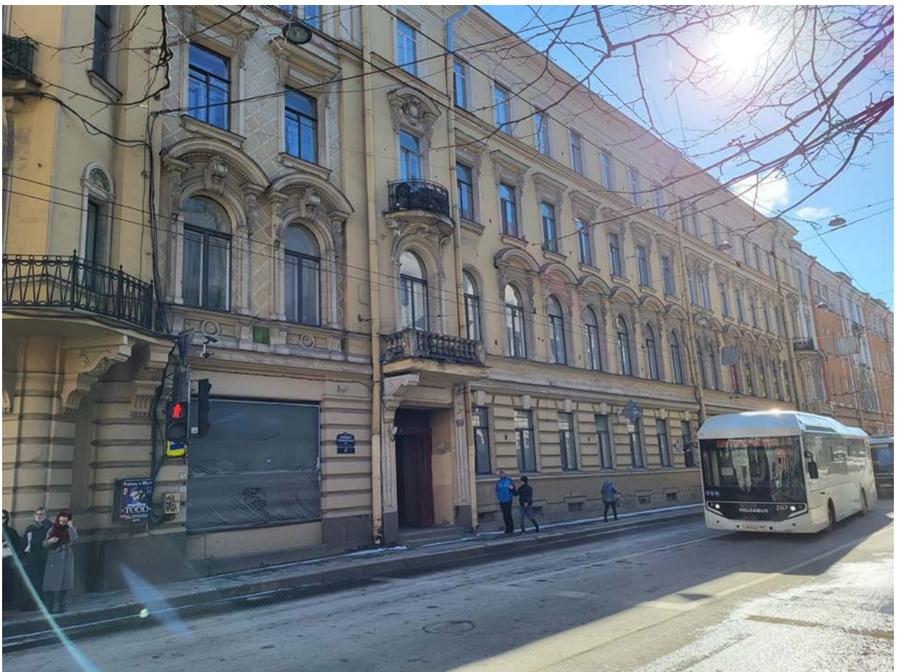
4. Северо-западный лицевой фасад выявленного объекта культурного наследия «Дом Э.Г. Шведерского», расположенного по адресу: г. Санкт-Петербург, Большая Пушкарская ул., д. 47, литера А, по Каменноостровскому пр. Фрагмент. 04.04.2022
