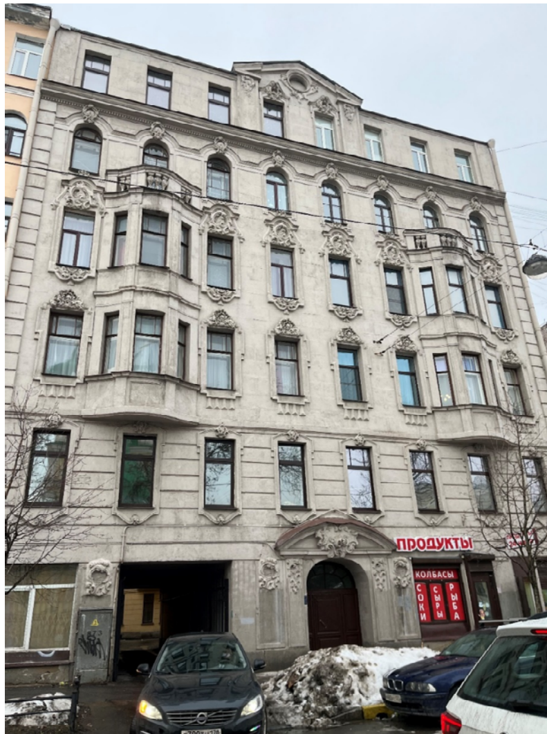
Фото №1. Лицевой (юго-западный) фасад о 6-ой линии В.О.
